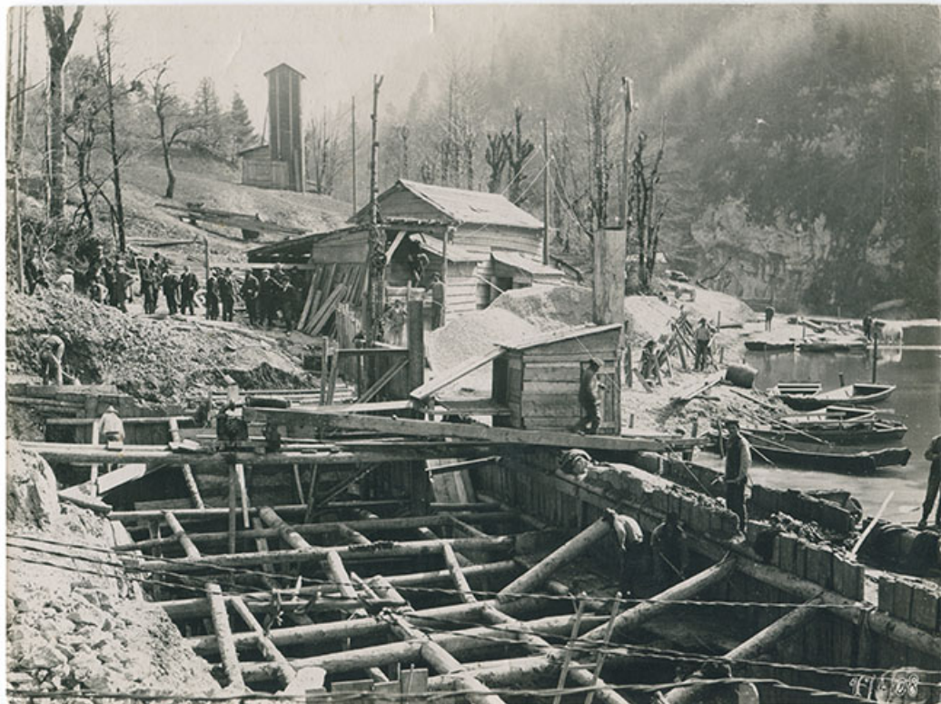
[Construction de la prise d'eau], [vers 1908].
