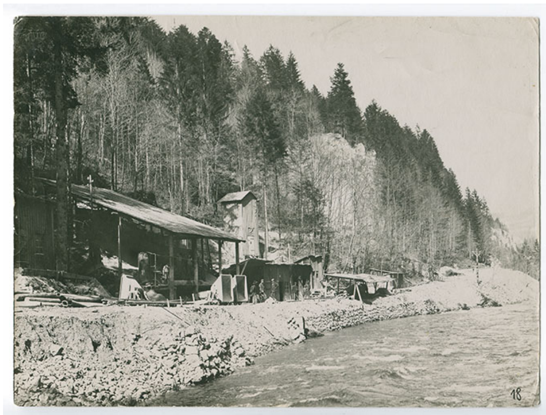
Le déversoir du tunnel, [vers 1908].
