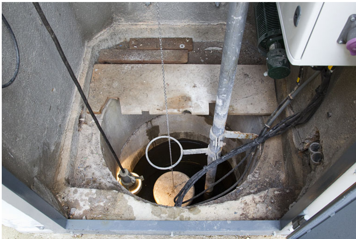
Prise d'eau : puits limnimétrique (utilisé pour mesurer le niveau de l'eau). 25, Fournet-Blancheroche, lieudit : Barrage du Refrain
