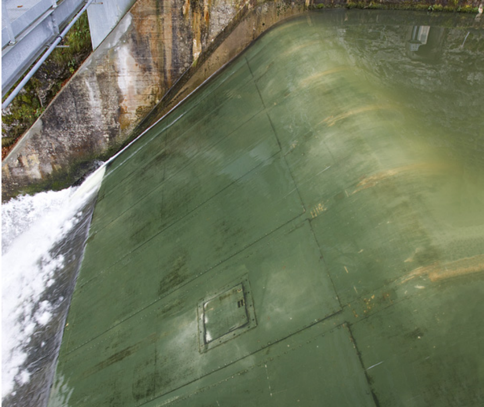
Barrage : une vanne toit.
