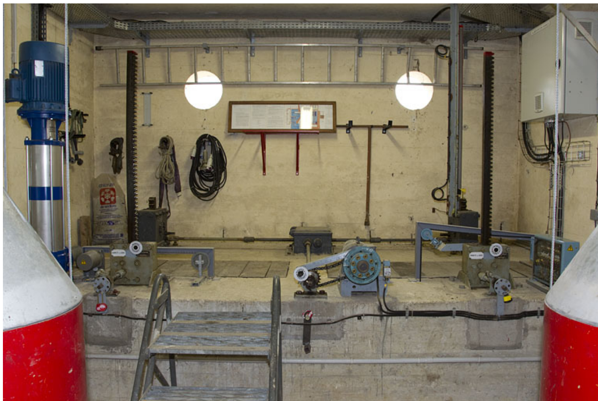
Barrage : commande des vannes de garde.
