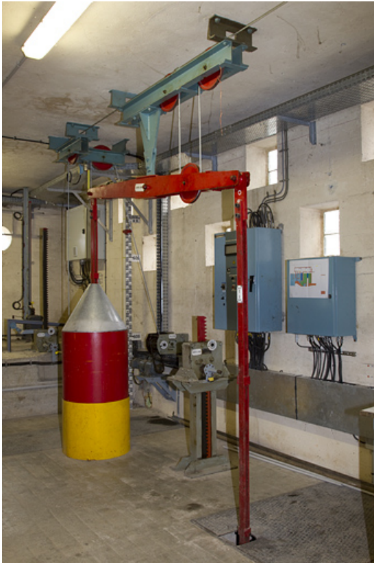
Barrage : soupape d'une vanne toit.
