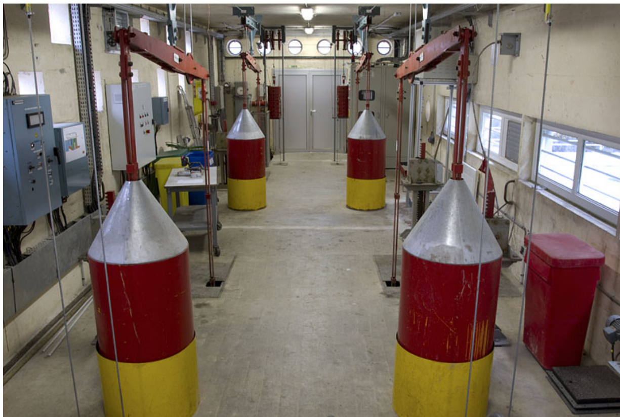
Barrage : intérieur de la salle de commande, depuis le fond.
