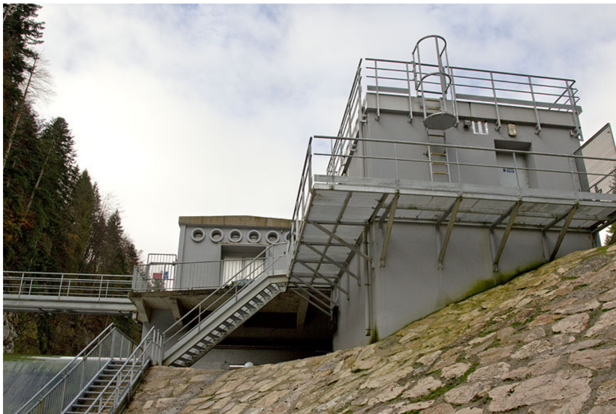
Barrage : centrale du groupe de restitution, vue en contre-plongée.
