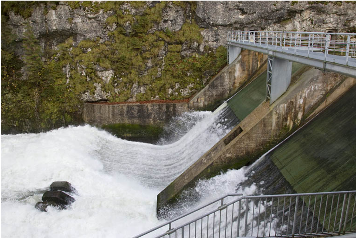
Barrage : vue plongeante sur les vannes toit.
