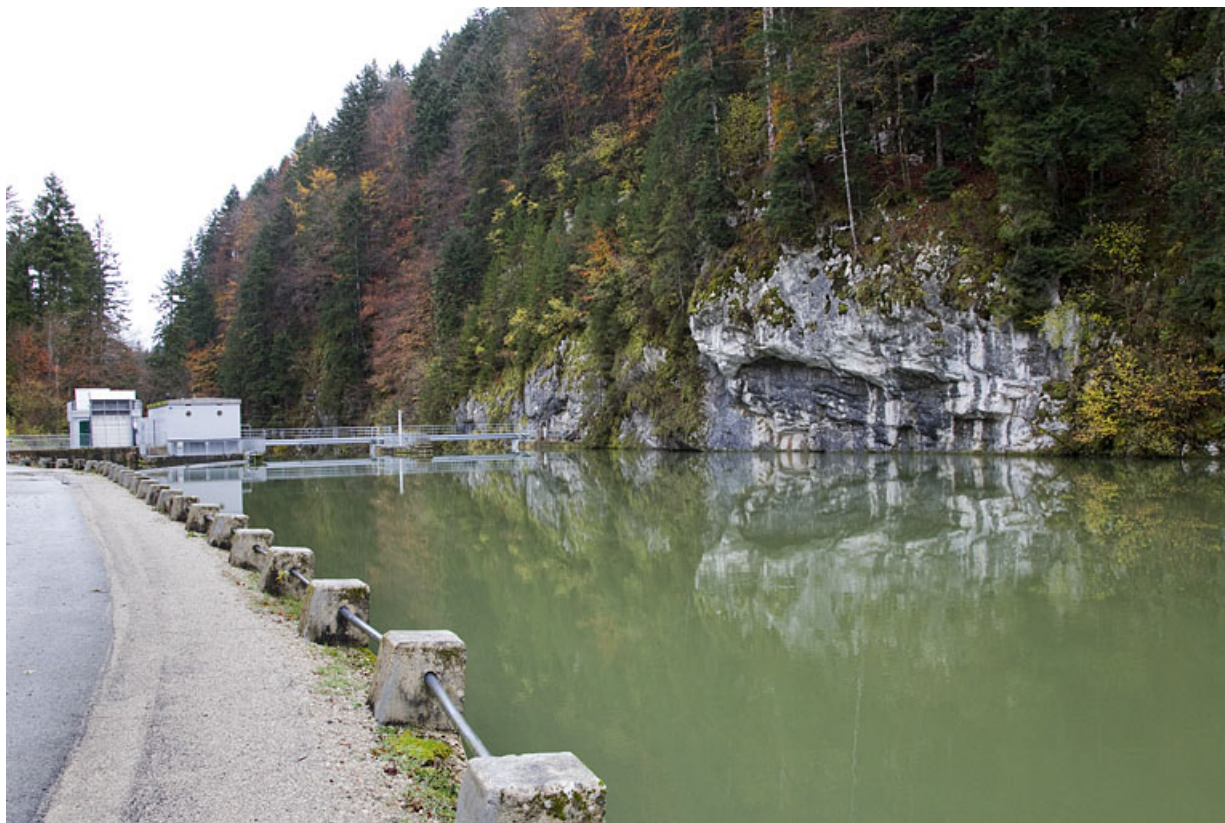
Bassin de retenue, salle de commande des vannes toit et barrage, depuis le sud-ouest (amont). 25, Fournet-Blancheroche, lieudit : Barrage du Refrain
