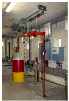
Barrage : soupape d'une vanne toit.
