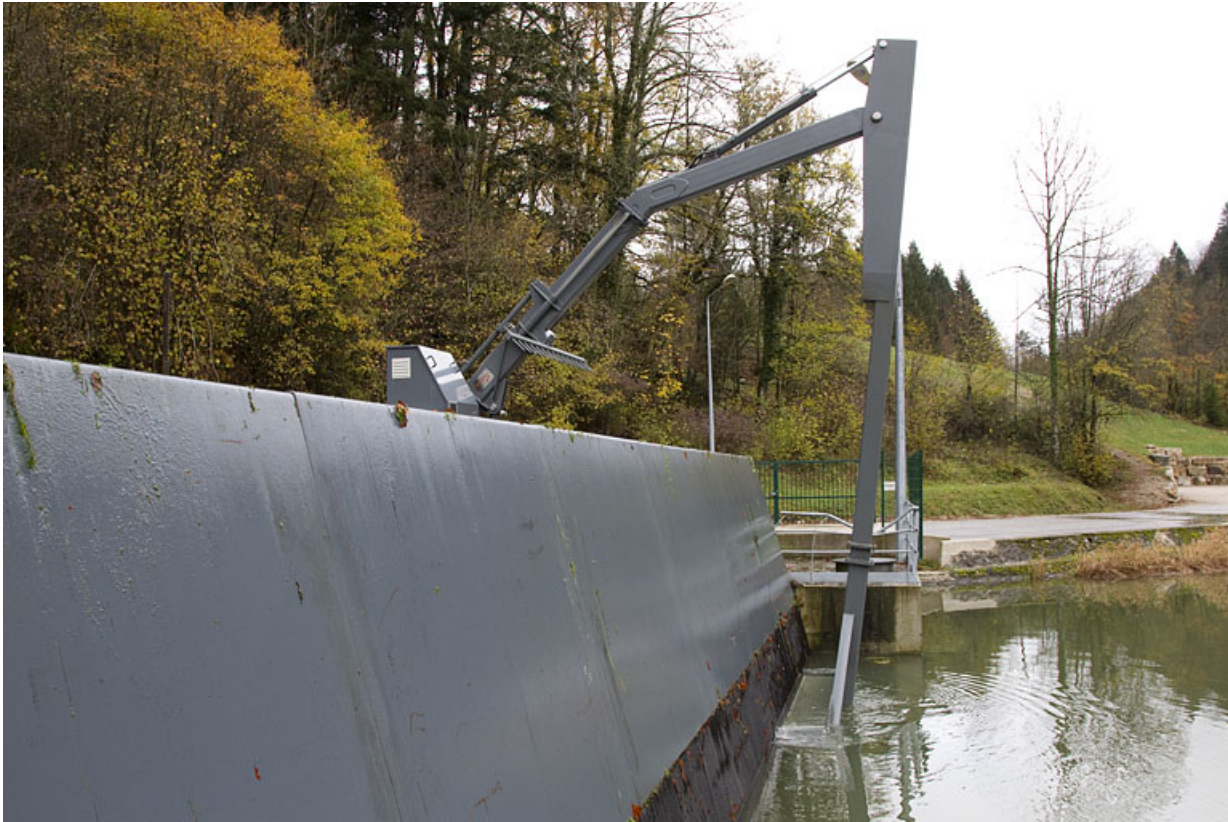
Prise d'eau : dégrilleur en fonctionnement.
