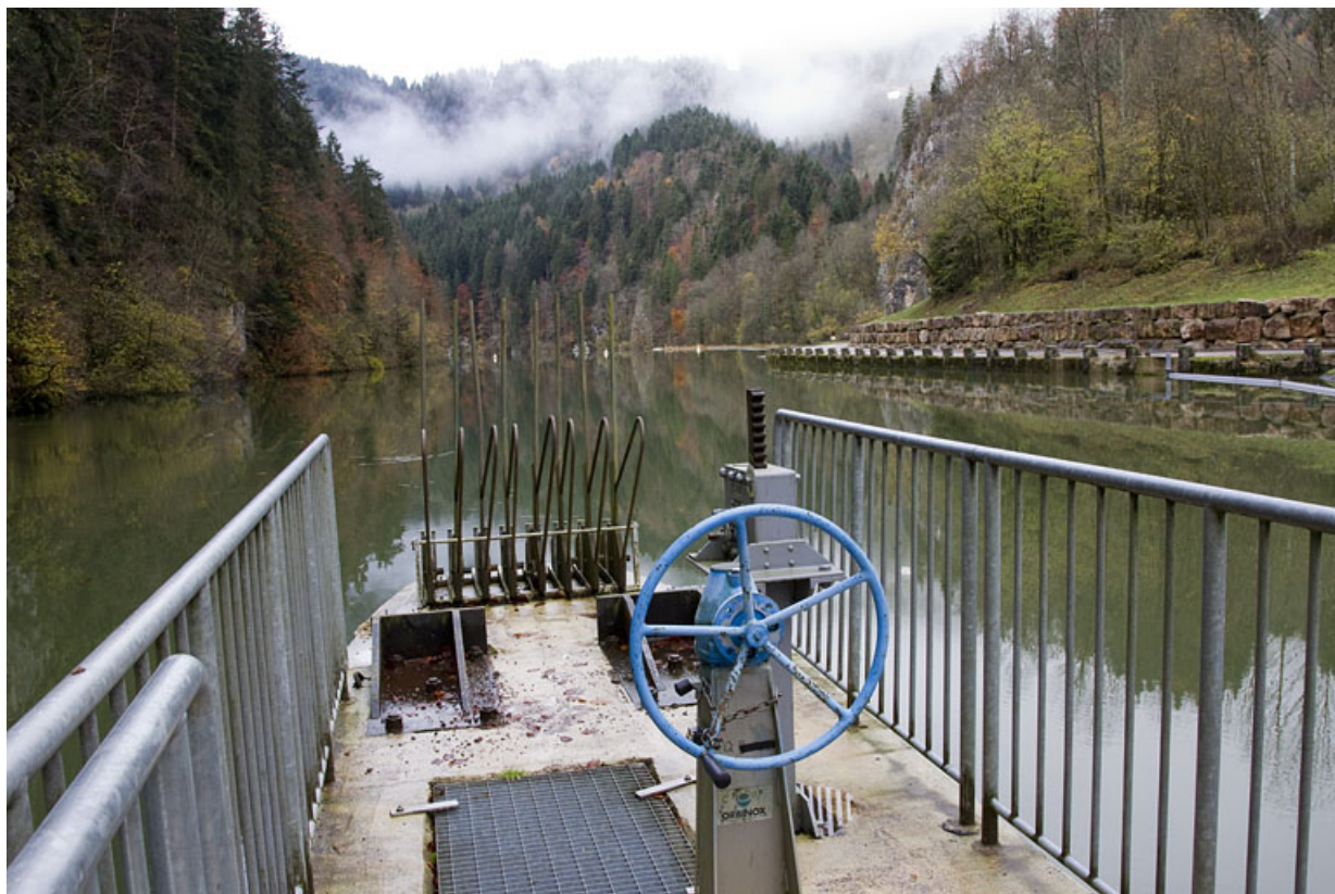
Barrage : commande de vanne de fond.
