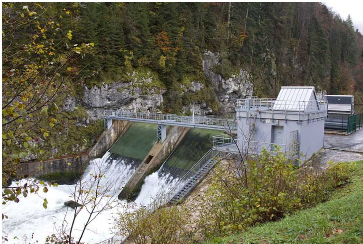
Barrage et salle des machines (centrale du groupe de restitution), depuis le nord (aval). 25, Fournet-Blancheroche, lieudit : Barrage du Refrain
