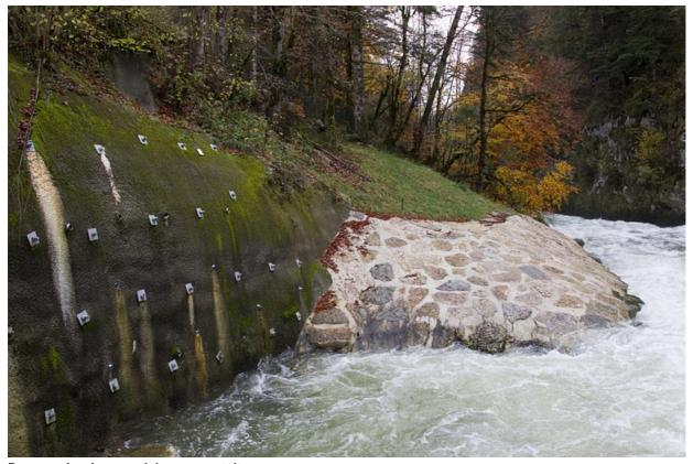
Berge renforcée en aval des vannes toit. 25, Fournet-Blancheroche, lieudit : Barrage du Refrain
