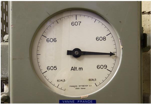
Barrage : cadran de contrôle du niveau de la retenue. 25, Fournet-Blancheroche, lieudit : Barrage du Refrain
