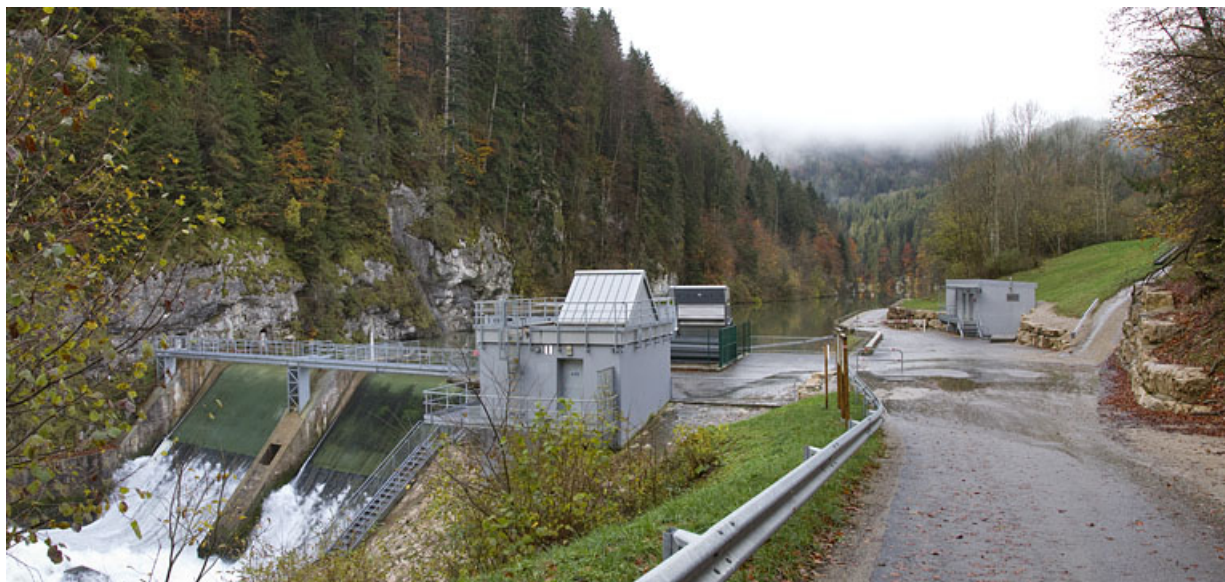
Vue d'ensemble depuis le nord-est (aval).
