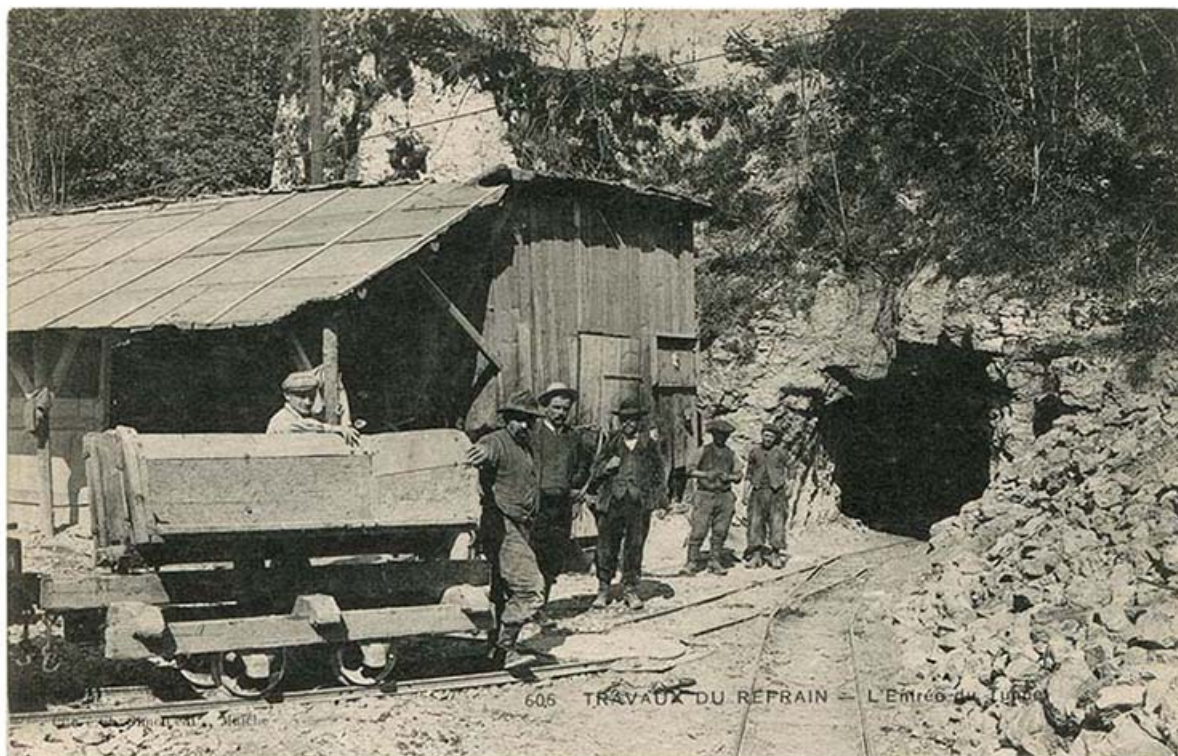
605. Travaux du Refrain - L'entrée du tunnel, carte postale, vers 1908.
