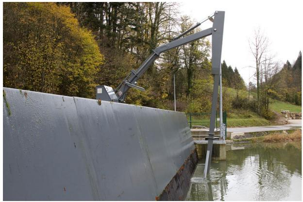
Prise d'eau : dégrilleur en fonctionnement. 25, Fournet-Blancheroche, lieudit : Barrage du Refrain
