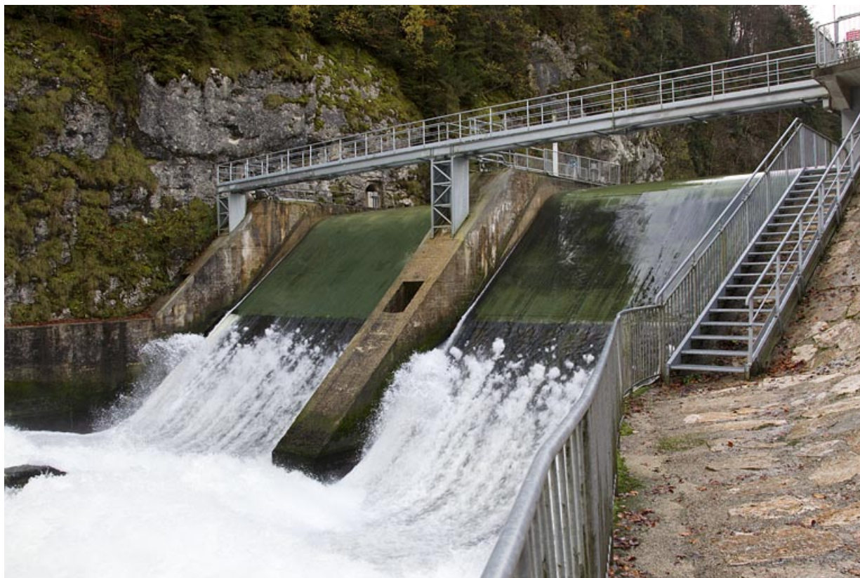
Barrage vu de trois quarts, depuis l'aval.
