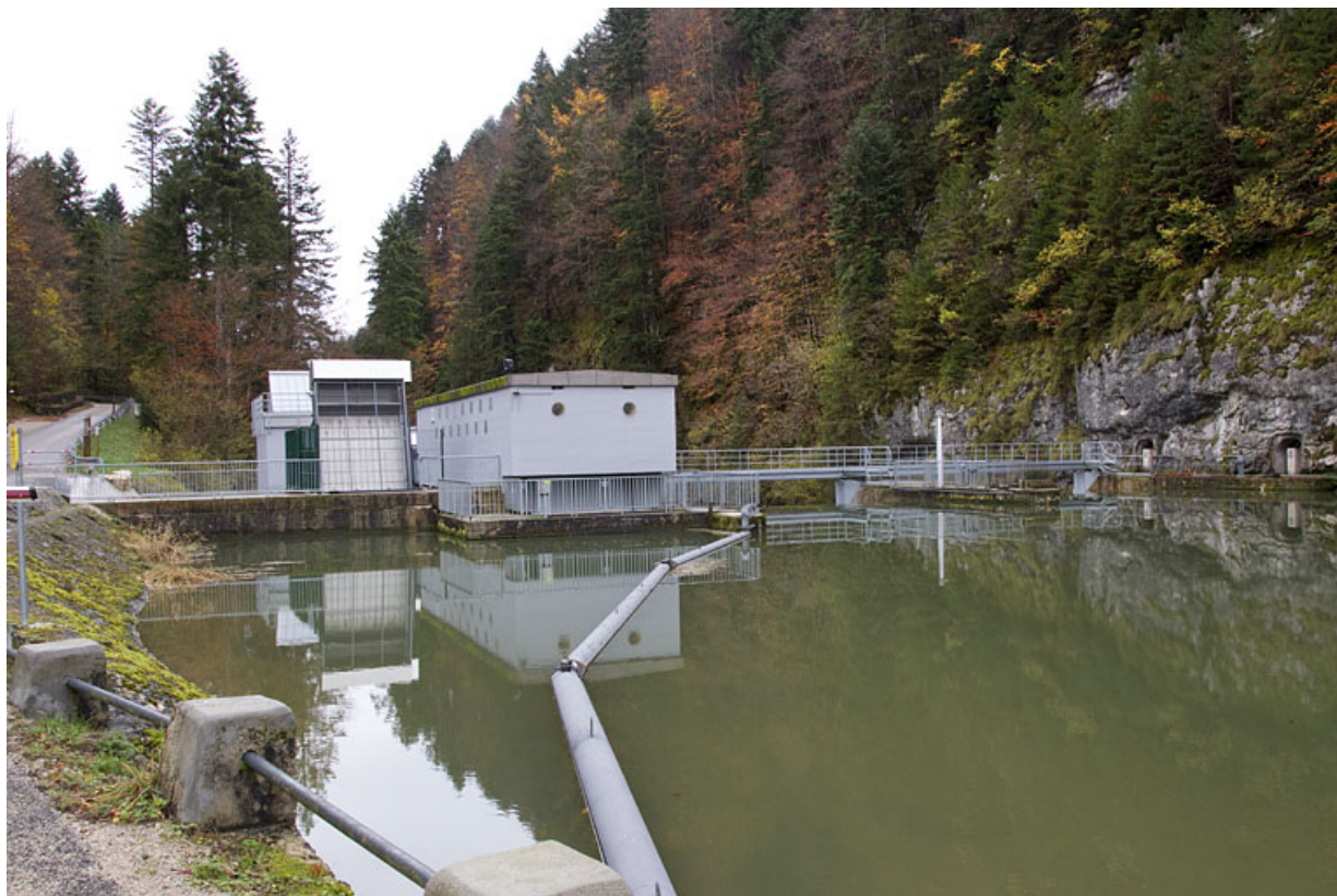
Barrage : salle de commande et vannes, depuis le sud-ouest (amont).
