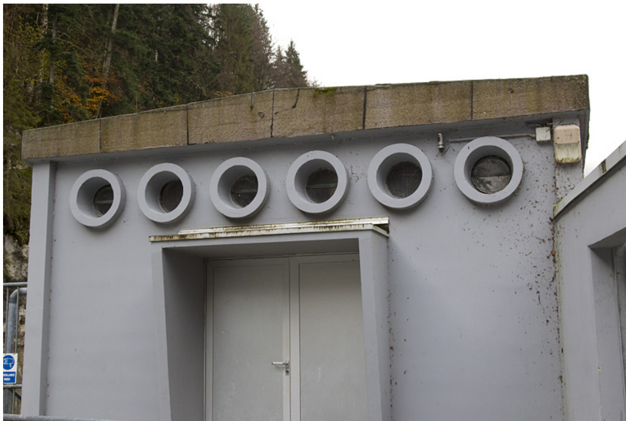
Barrage : baies sur le pignon de la salle de commande des vannes toit.
