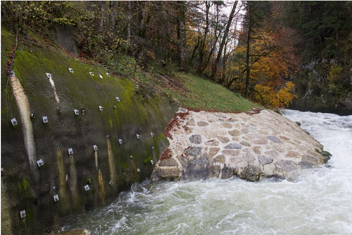
Berge renforcée en aval des vannes toit.
