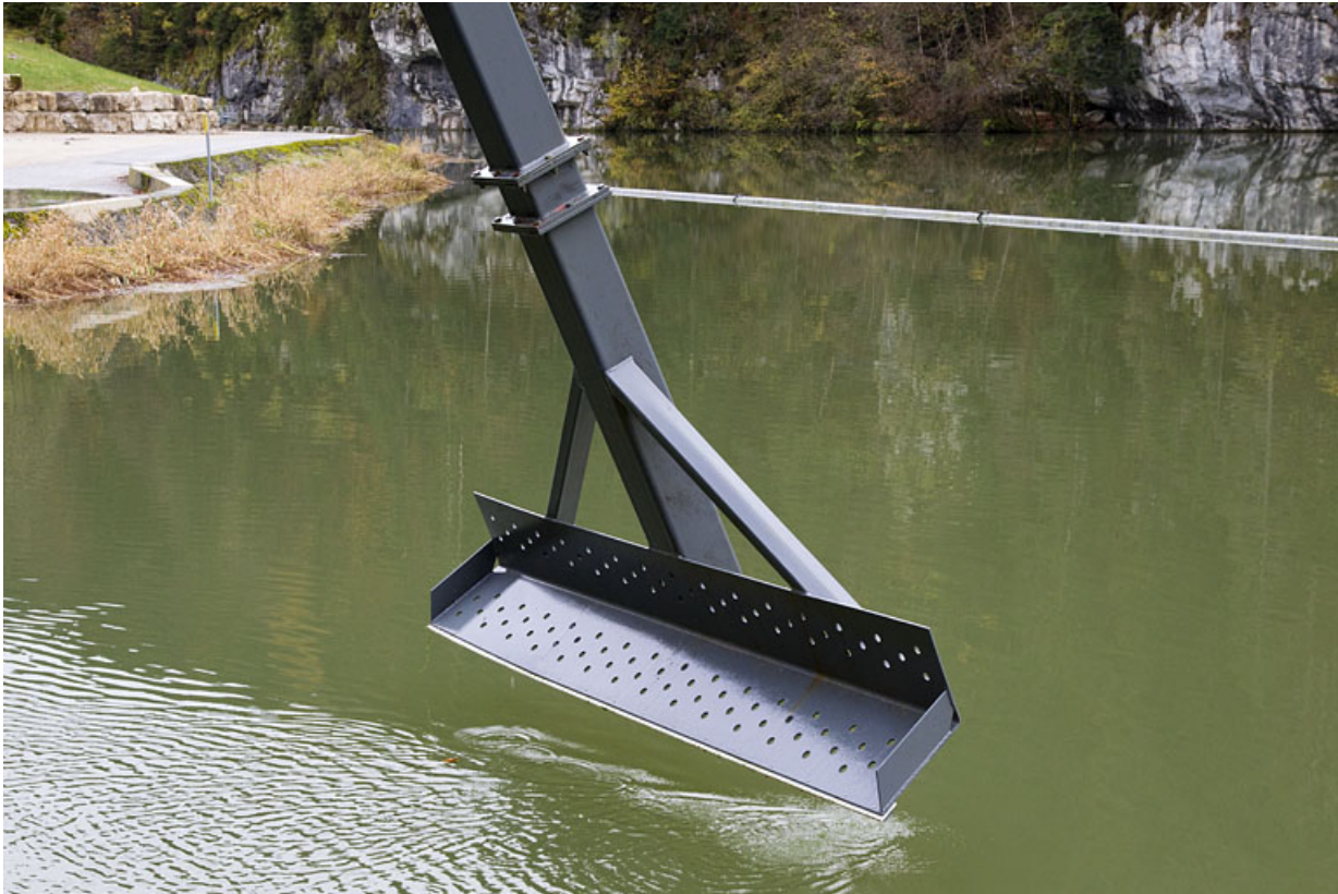
Prise d'eau : extrémité du bras du dégrilleur.
