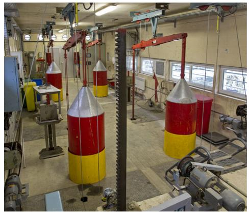
Barrage : soupapes des vannes toit. Chaque vanne toit est manoeuvrée automatiquement par un flotteur alimenté en air par deux soupapes en fonction du niveau de la retenue.
