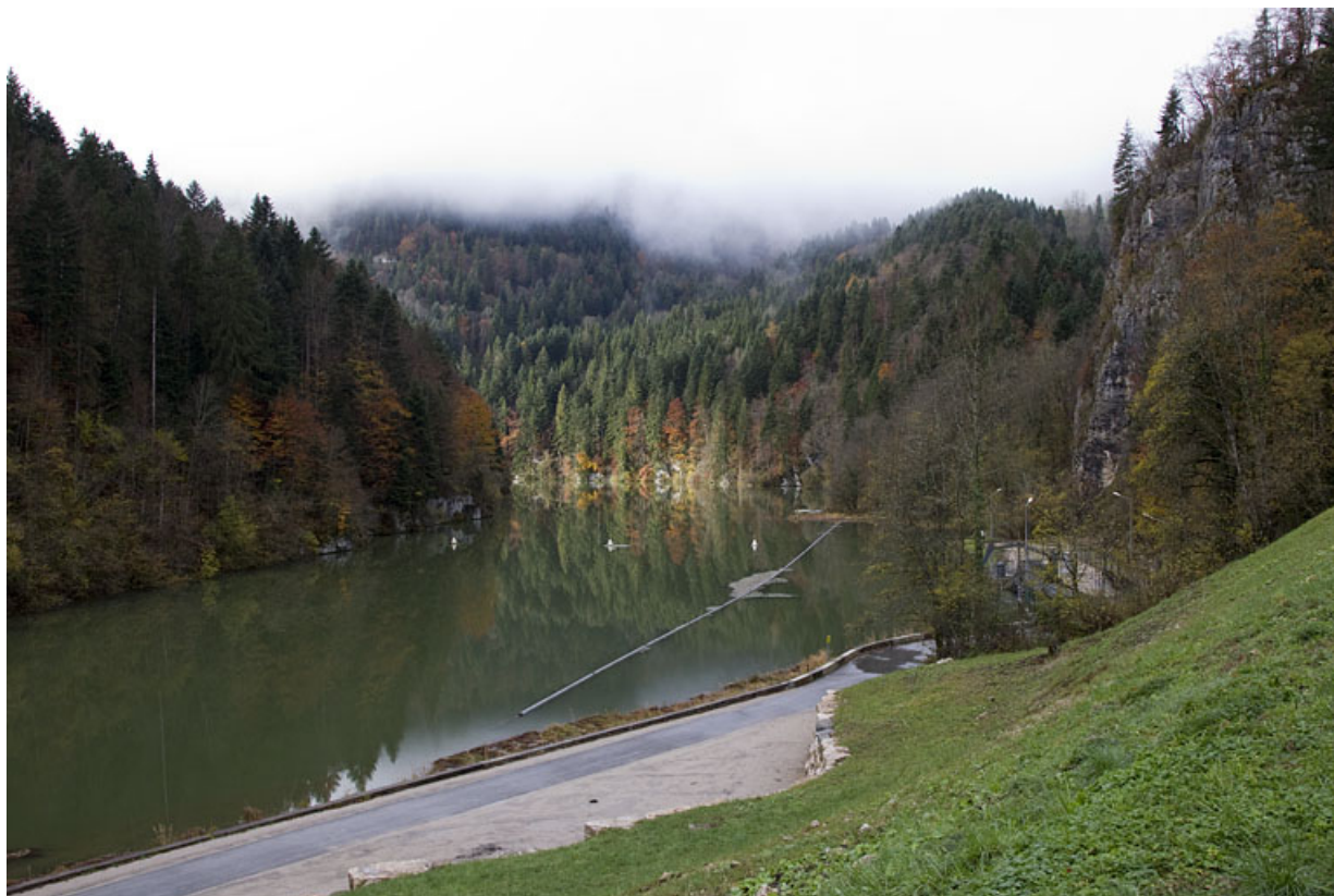
Vue d'ensemble du bassin de retenue, depuis le nord-est.
