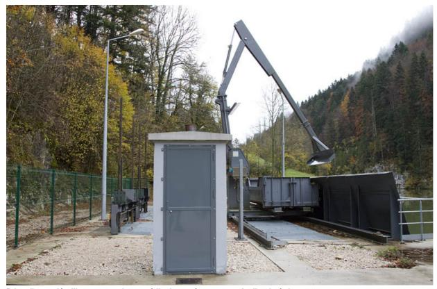
Prise d'eau : dégrilleur automatique et édicule protégeant un puits limnimétrique.
