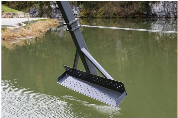
Prise d'eau : extrémité du bras du dégrilleur. 25, Fournet-Blancheroche, lieudit : Barrage du Refrain
