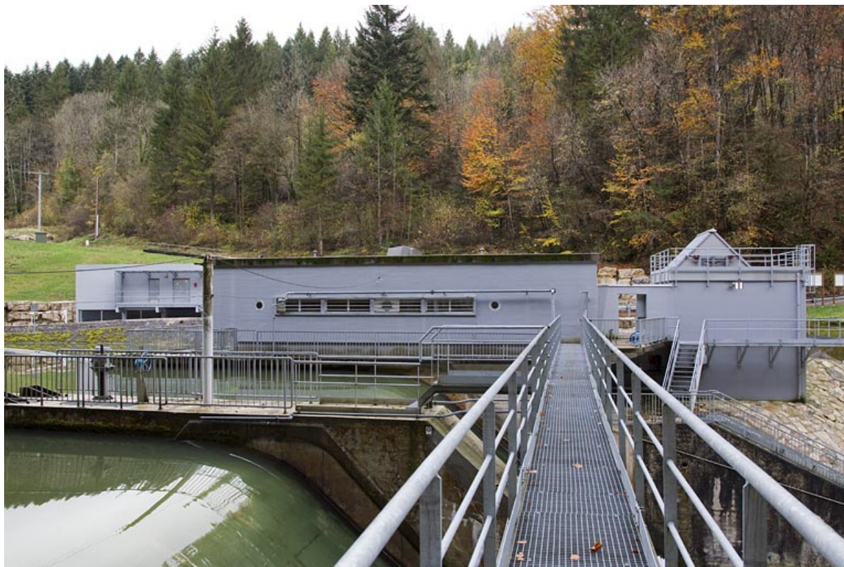
Barrage : salle de commande, depuis la passerelle enjambant les vannes toit. 25, Fournet-Blancheroche, lieudit : Barrage du Refrain
