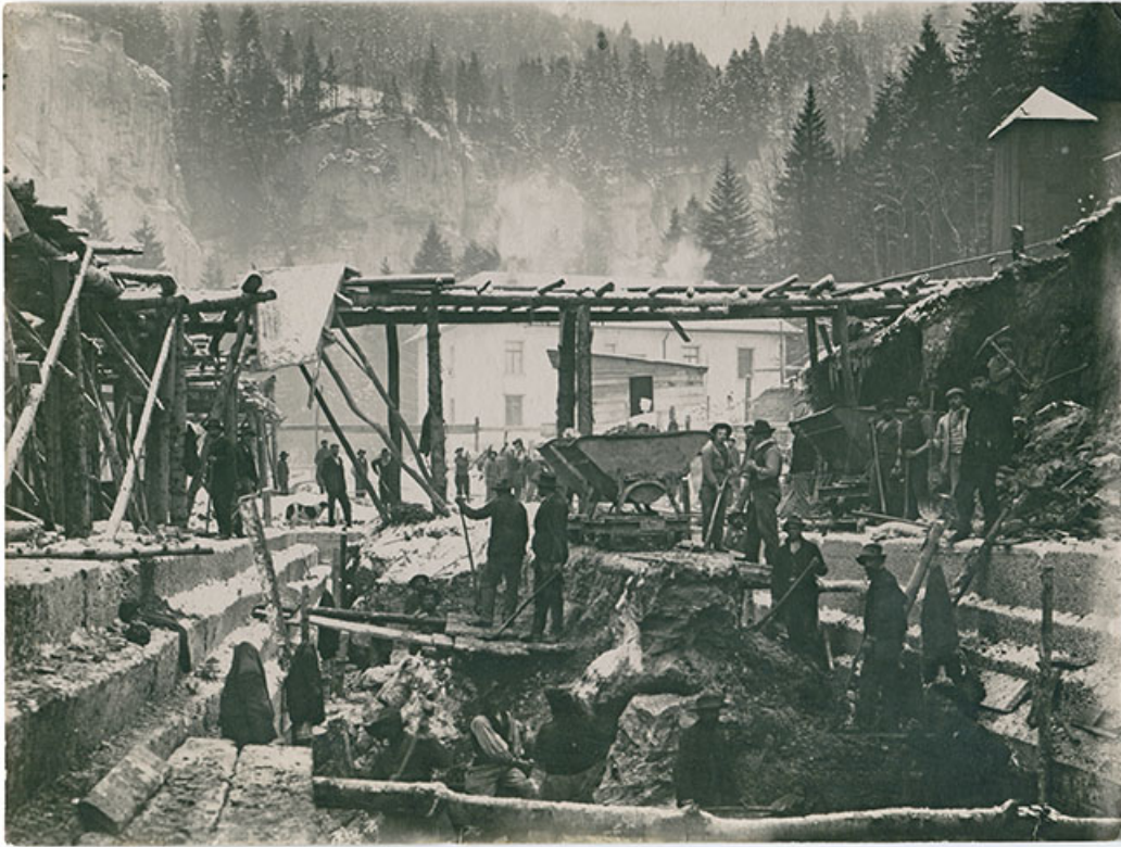
[Creusement de la chambre d'eau], [1907 ou 1908]. 25, Charquemont, lieudit : Mortier
