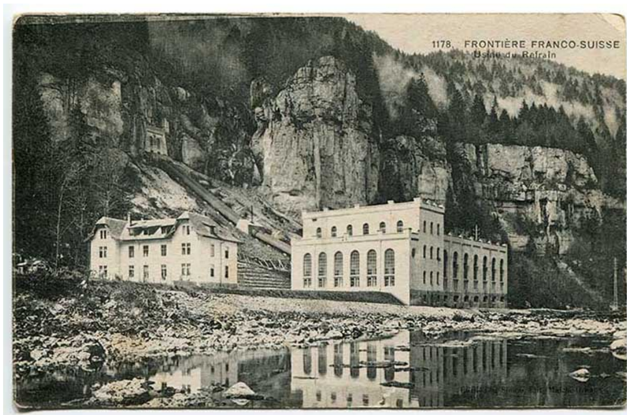
1178. Frontière Franco-Suisse. Usine du Refrain [logements et centrale depuis le sud (amont)], carte postale, décennies 1910-1920 (avant 1917).
