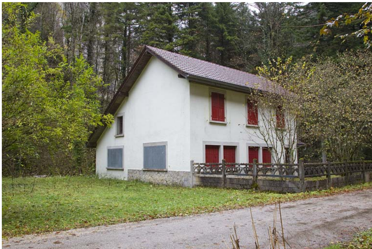
Ancienne école, vue de trois quarts gauche.
