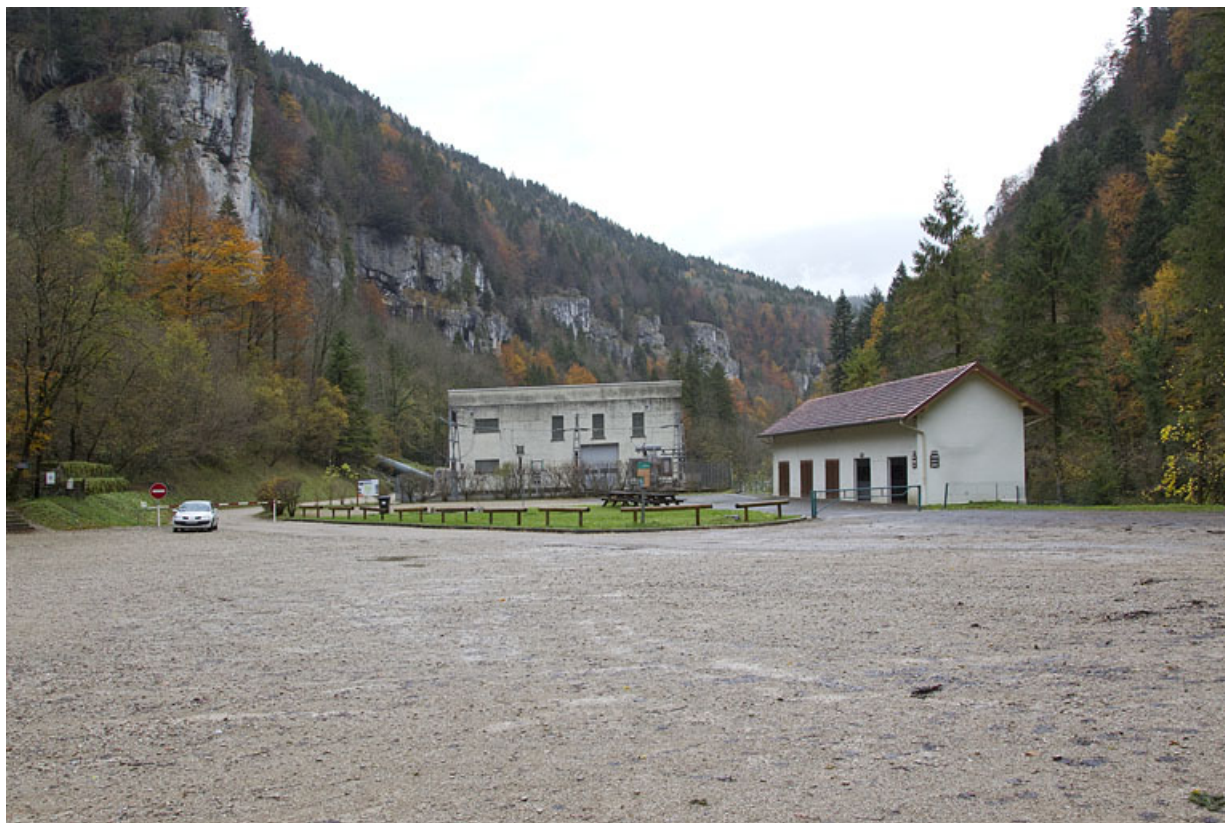
Vue d'ensemble, depuis le sud (amont).
