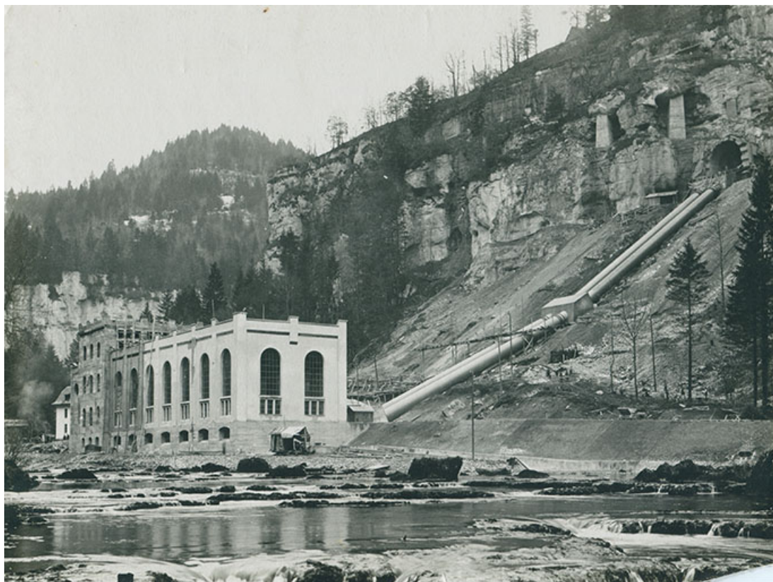
[Centrale en construction, vue de l'aval], [1908 ou 1909].
