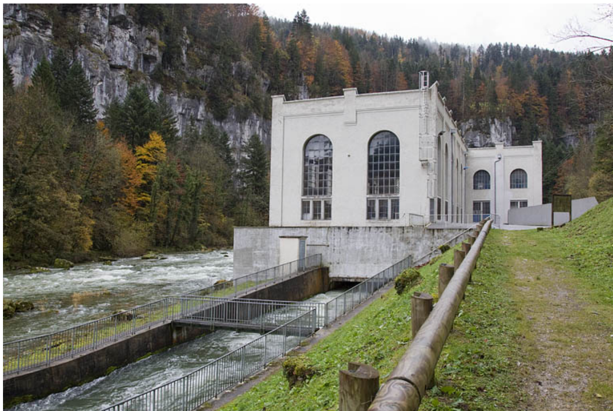
Centrale : façade postérieure (aval). 25, Charquemont, lieudit : Mortier
