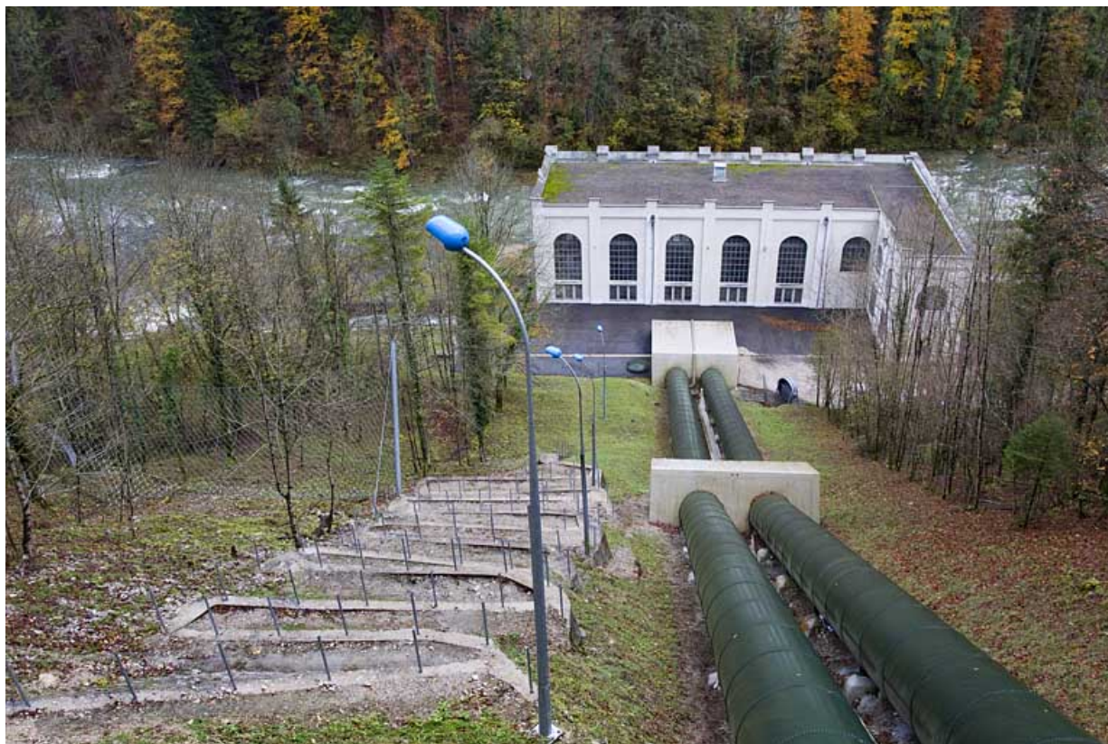
Centrale : vue plongeante depuis l'ouest.
