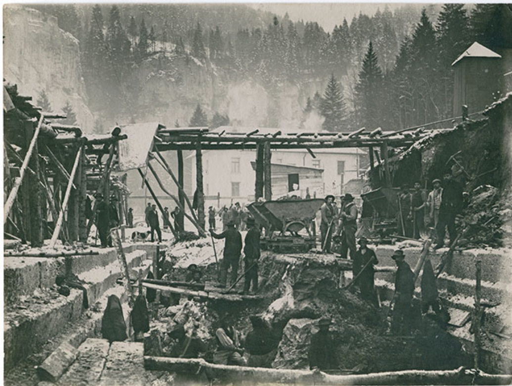
[Creusement de la chambre d'eau], [1907 ou 1908].
