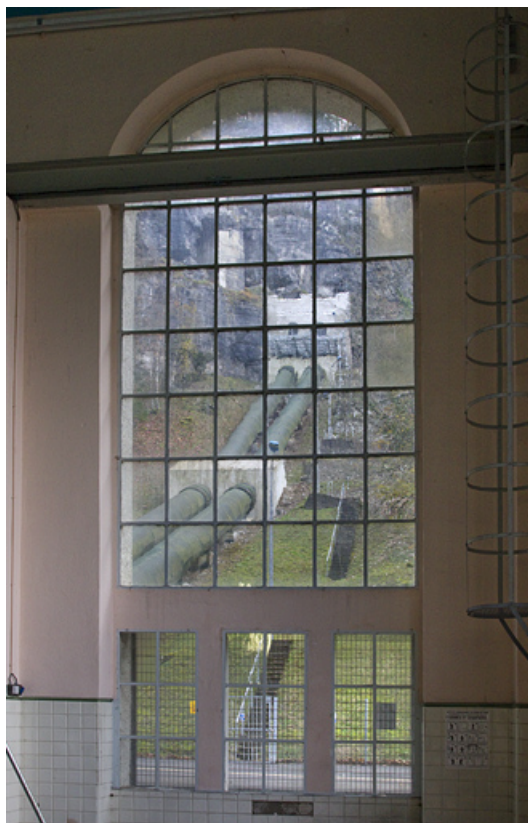
Conduite forcée, vue depuis l'intérieur de la salle des machines.
