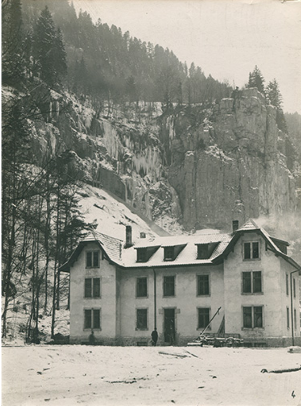
[Logement et travaux vers l'extrémité du tunnel côté centrale], [1907 ou 1908 ?]. 25, Charquemont, lieudit : Mortier
