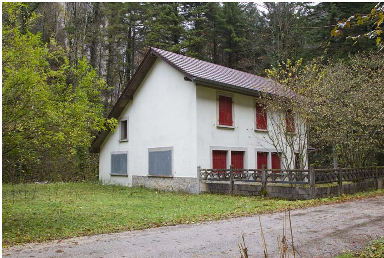
Ancienne école, vue de trois quarts gauche.
