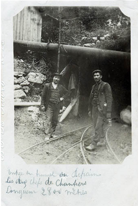
Entrée du tunnel du Refrain. Les deux chefs de chantiers. Longueur 2800 mètres, carte photo, 8 juin 1908.
