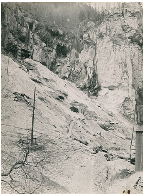
[Extrémité du tunnel vers la centrale], [1908 ?].
