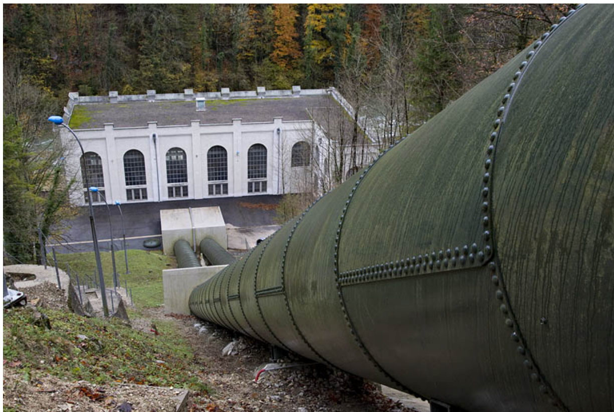
Conduite forcée : vue plongeante.
