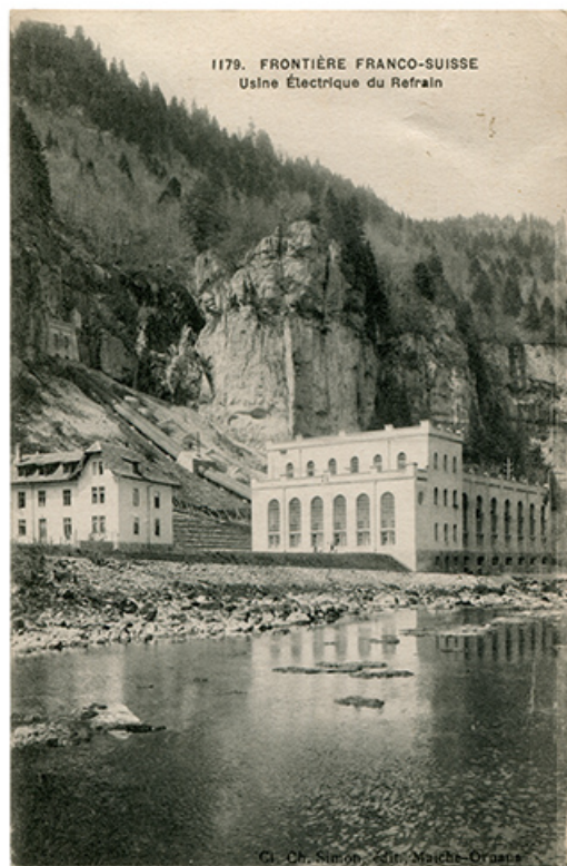
1179. Frontière Franco-Suisse. Usine Électrique du Refrain [logements et centrale depuis le sud (amont)], décennies 1910-1920. 25, Charquemont, lieudit : Mortier
