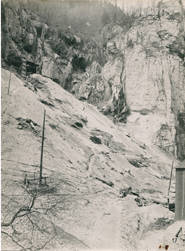
[Extrémité du tunnel vers la centrale], [1908 ?].
