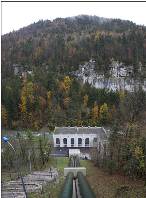
Centrale hydroélectrique du Refrain, à Charquemont.
