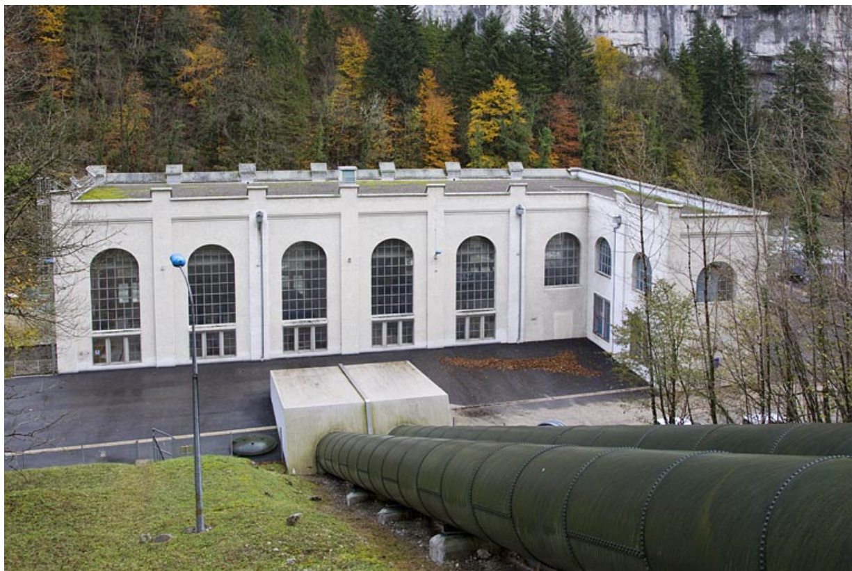
Centrale : façade latérale droite (élévation orientale).
