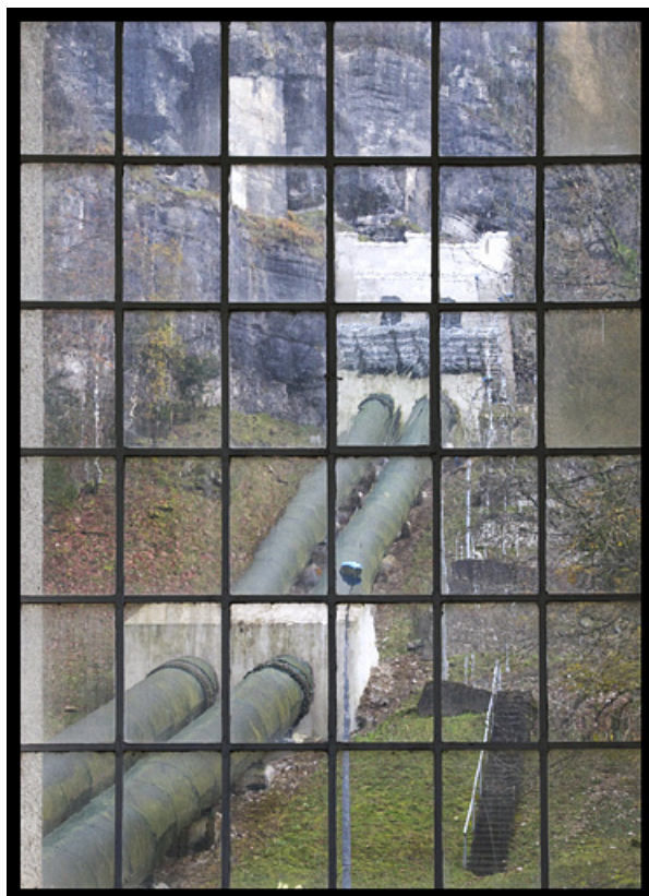
Conduite forcée, vue depuis l'intérieur de la salle des machines.
