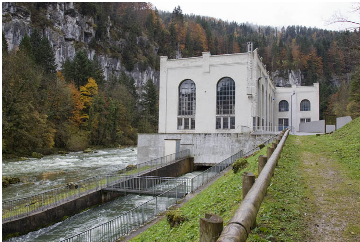
Centrale : façade postérieure (aval). 25, Charquemont, lieudit : Mortier
