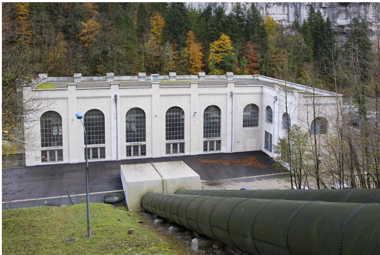
Centrale : façade latérale droite (élévation orientale).
