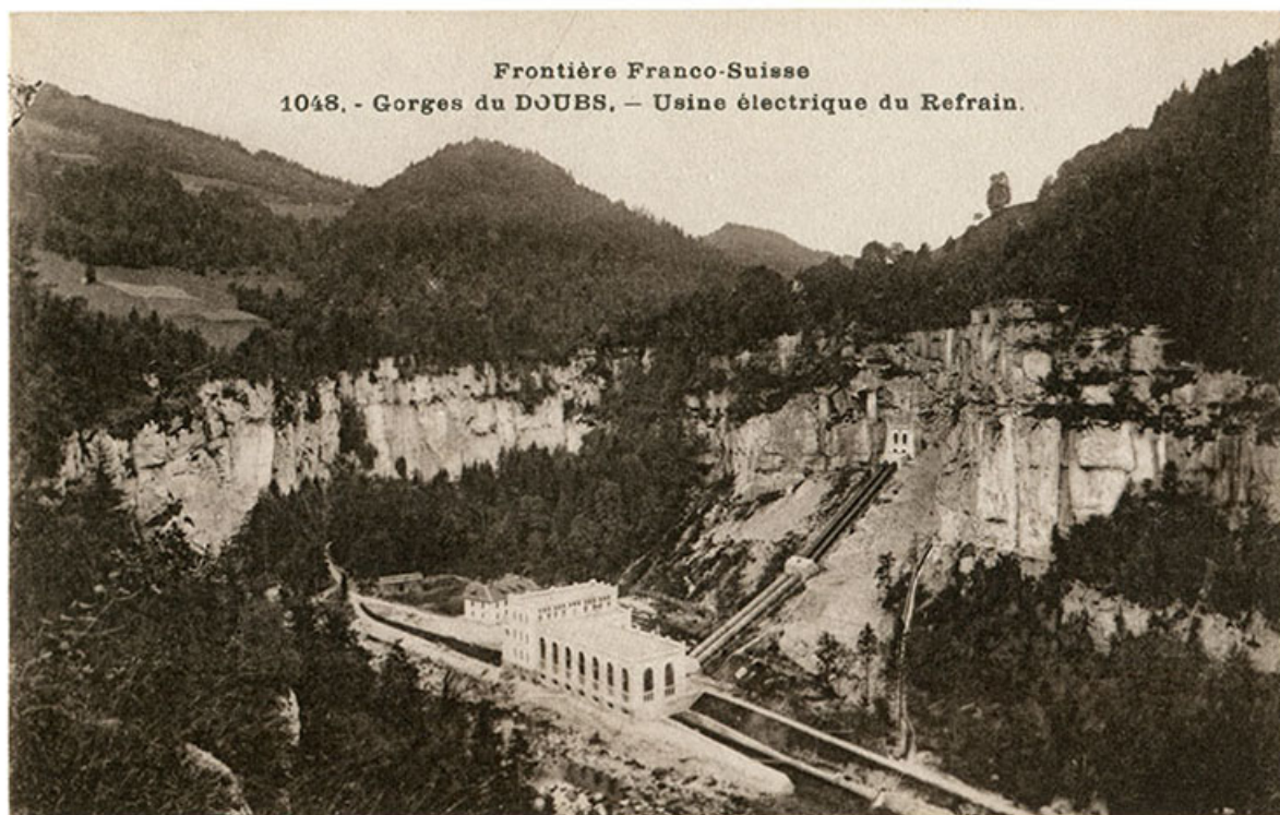
1048. - Frontière Franco-Suisse. Gorges du Doubs. - Usine Électrique du Refrain [vue plongeante sur la centrale depuis le nord-est (aval)], carte postale, décennies [1910-1920].
