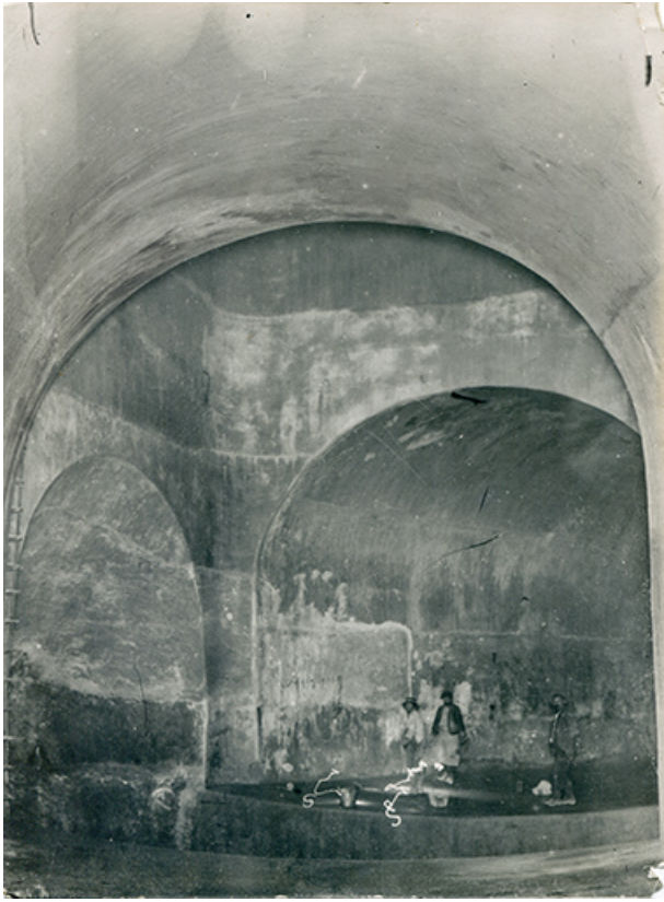
[Chambre de mise en charge achevée], [1908 ?]. 25, Charquemont, lieudit : Mortier
