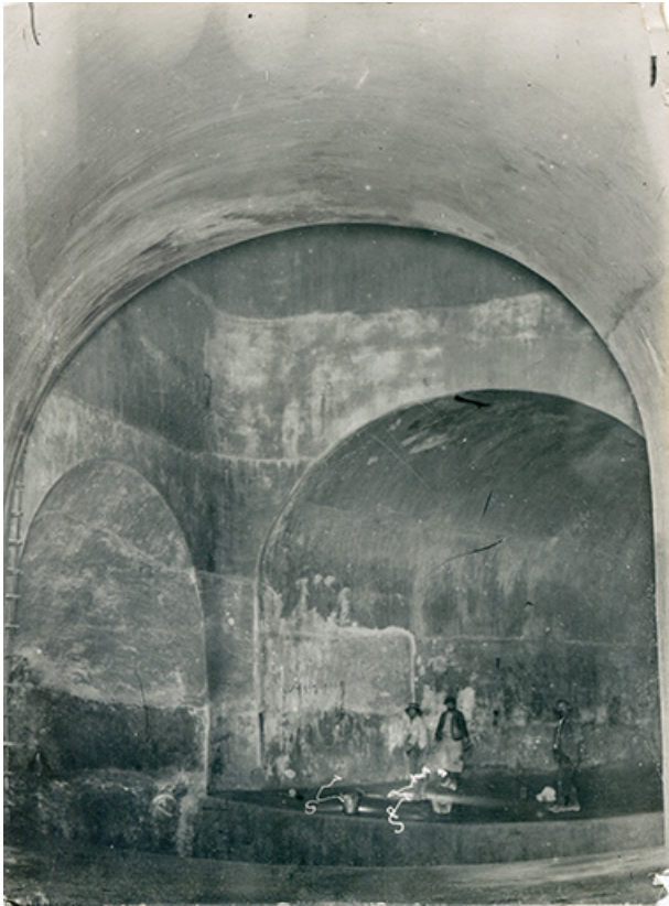
[Chambre de mise en charge achevée], [1908 ?].
