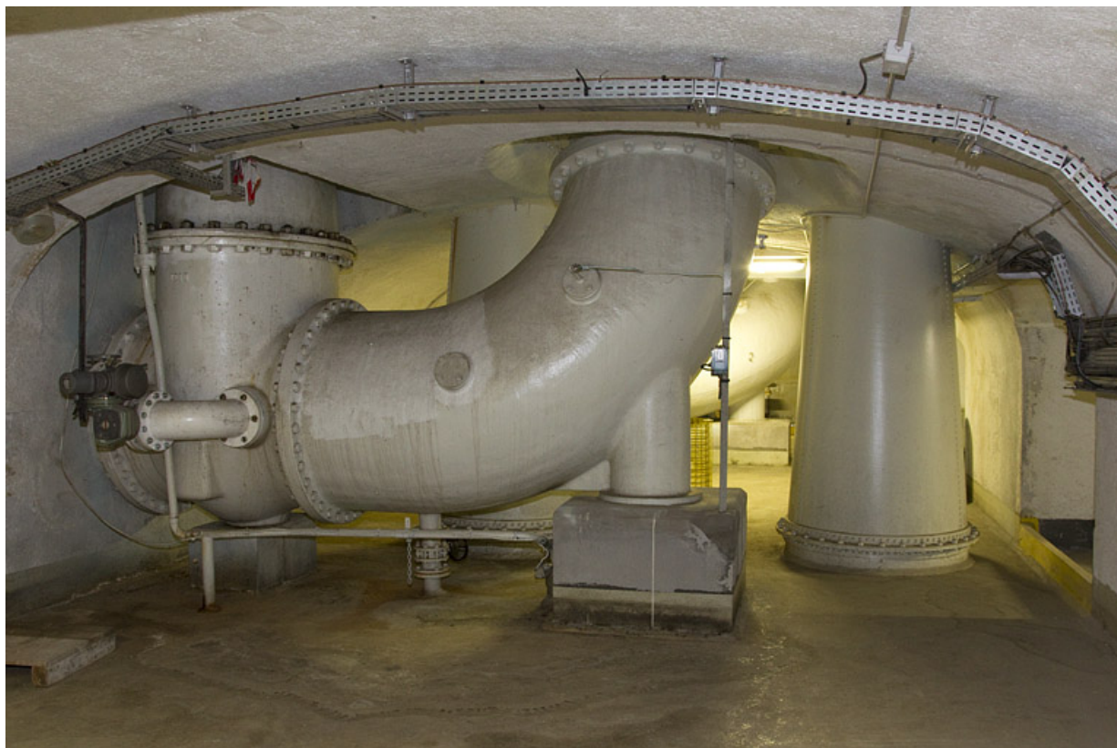
Centrale : soubassement, avec conduits d'alimentation des turbines et d'évacuation de l'eau. 25, Charquemont, lieudit : Mortier
