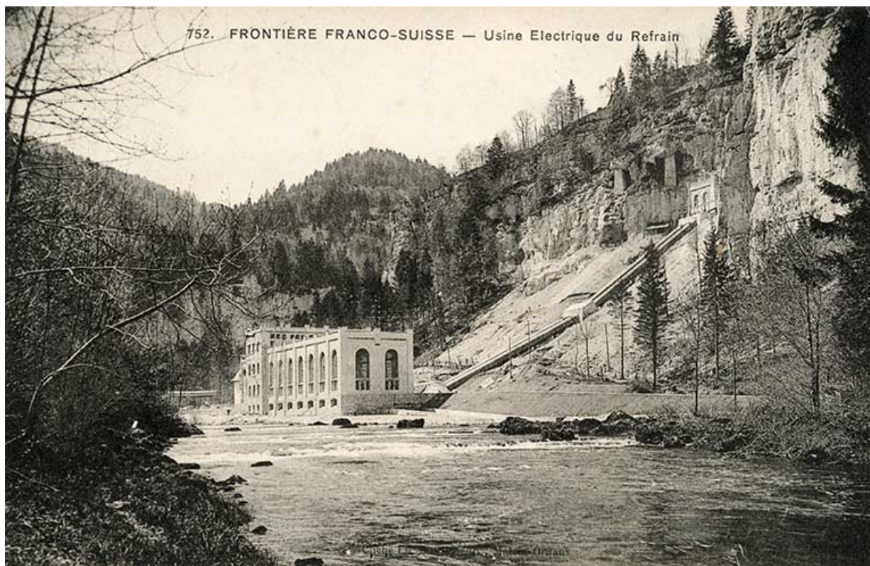
752. Frontière Franco-Suisse - Usine Électrique du Refrain [centrale depuis le nord (aval)], [décennies 1910-1920] 25, Charquemont, lieudit : Mortier
