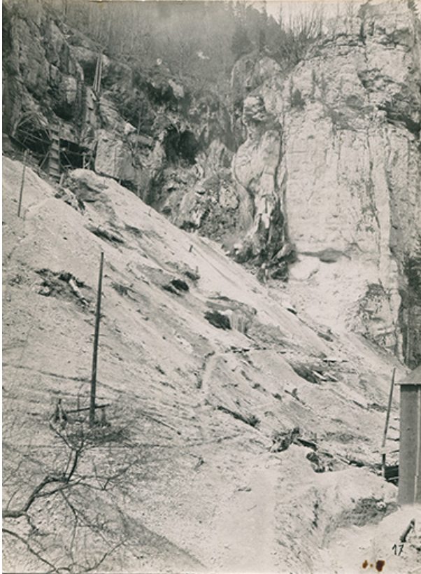
[Extrémité du tunnel vers la centrale], [1908 ?].
