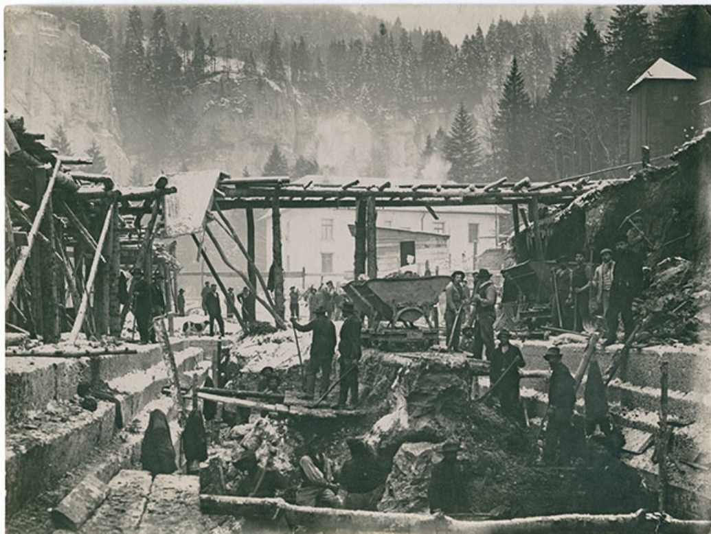
[Creusement de la chambre d'eau], [1907 ou 1908].
