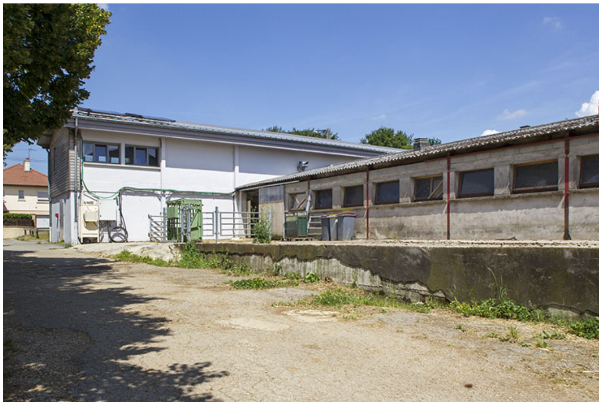
Façade postérieure du bâtiment de services et flanc ouest de l'étable est. 25, Dannemarie-sur-Crète, 16 rue de Damprichard
