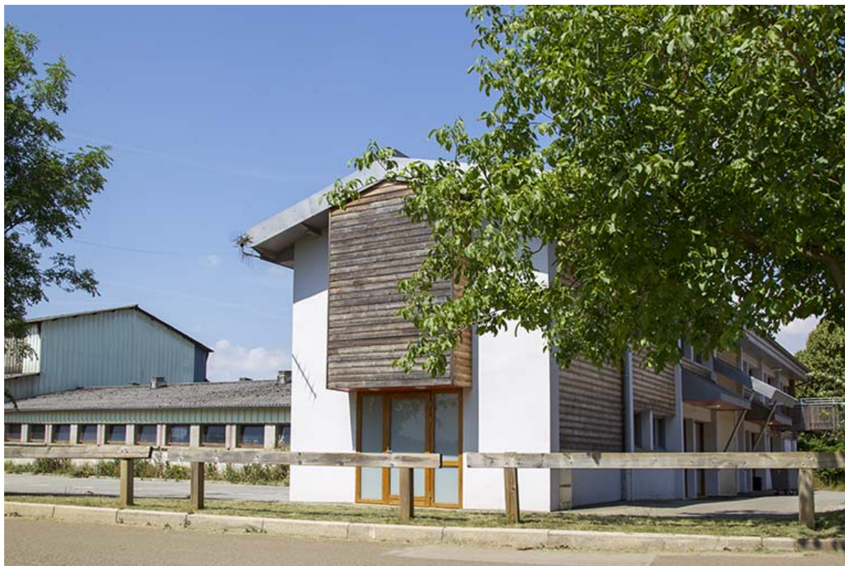
Pignon est du bâtiment de services et étable est. 25, Dannemarie-sur-Crète, 16 rue de Damprichard
