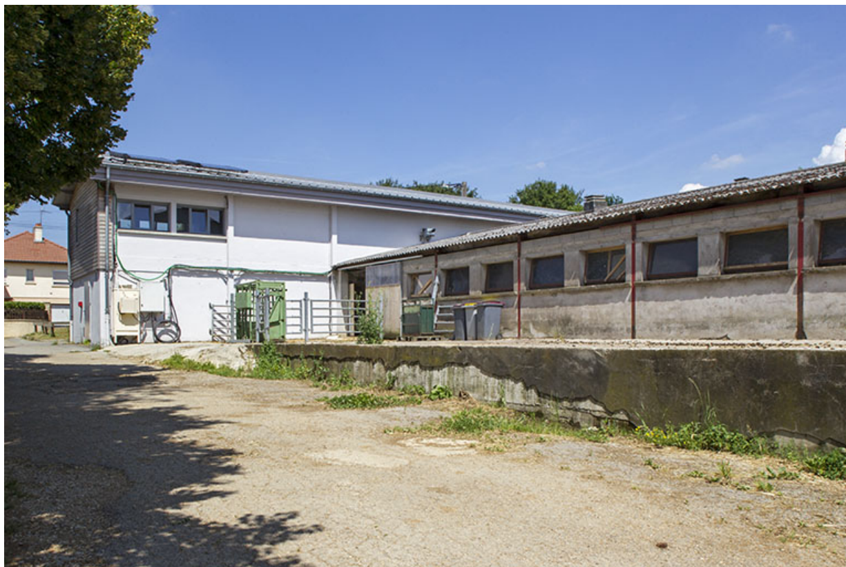
Façade postérieure du bâtiment de services et flanc ouest de l'étable est.
