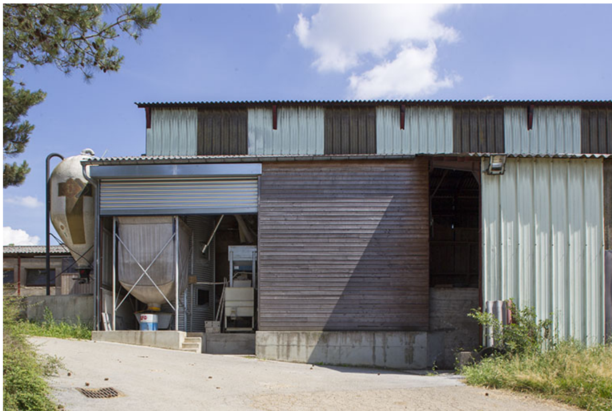
Silos, moulins à l'ouest de l'entrepôt agricole. 25, Dannemarie-sur-Crète, 16 rue de Damprichard
