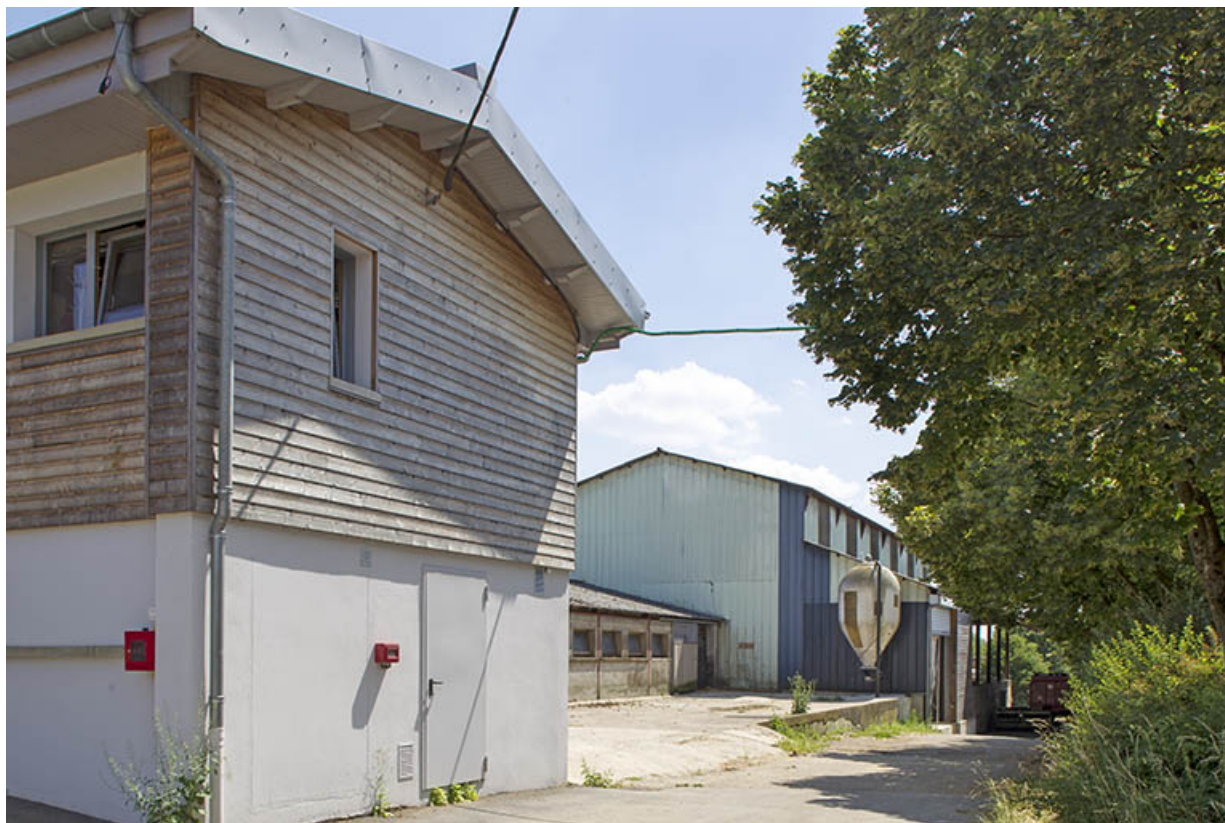
Pignon ouest du bâtiment de services et vue d'ensemble vers le sud.
