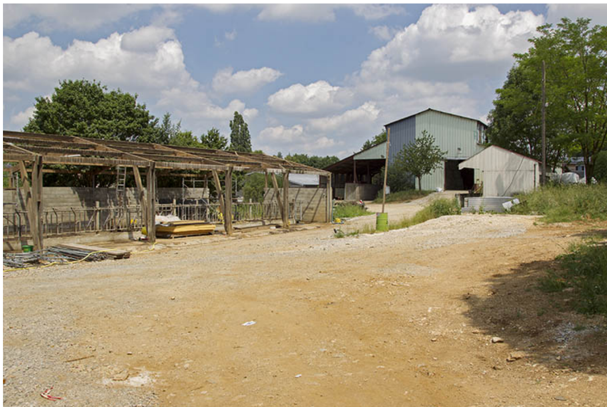
L'étable sud en travaux et pignons sud de la quarantaine et de l'entrepôt agricole.
