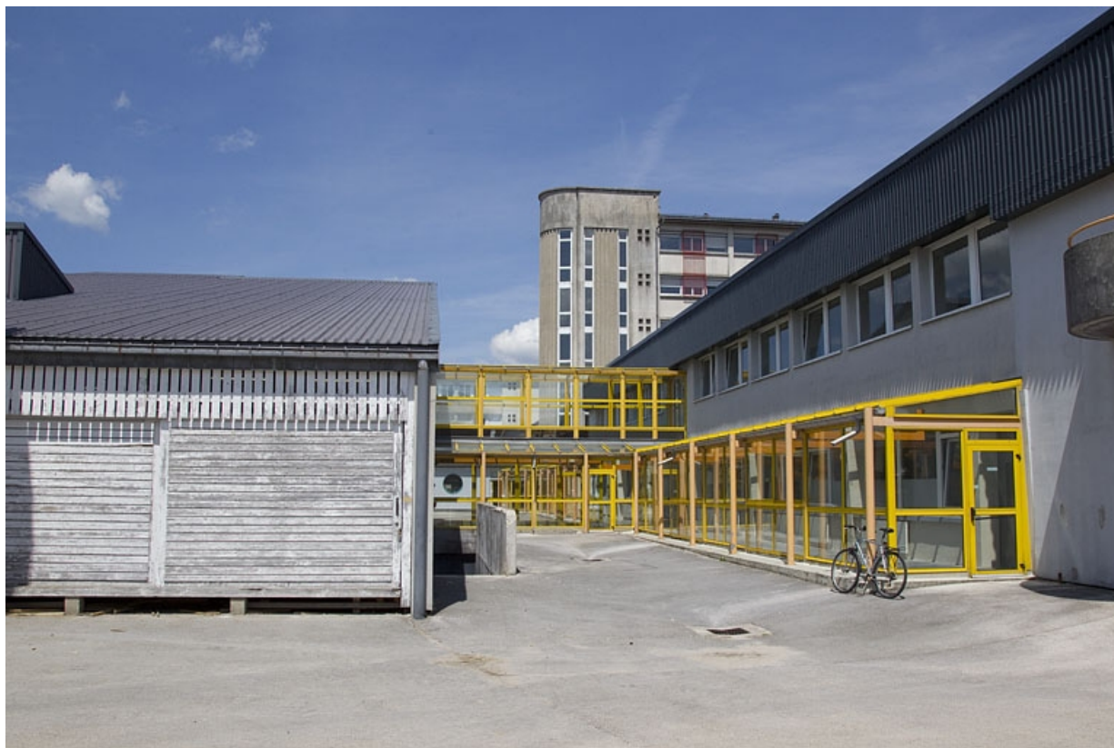
Galerie et atelier de maintenance et électrotechnique, depuis le sud. 25, Pontarlier, 3 rue des Fusillés
