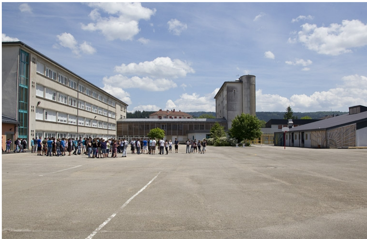
Vue d'ensemble de la cour, depuis l'ouest.
