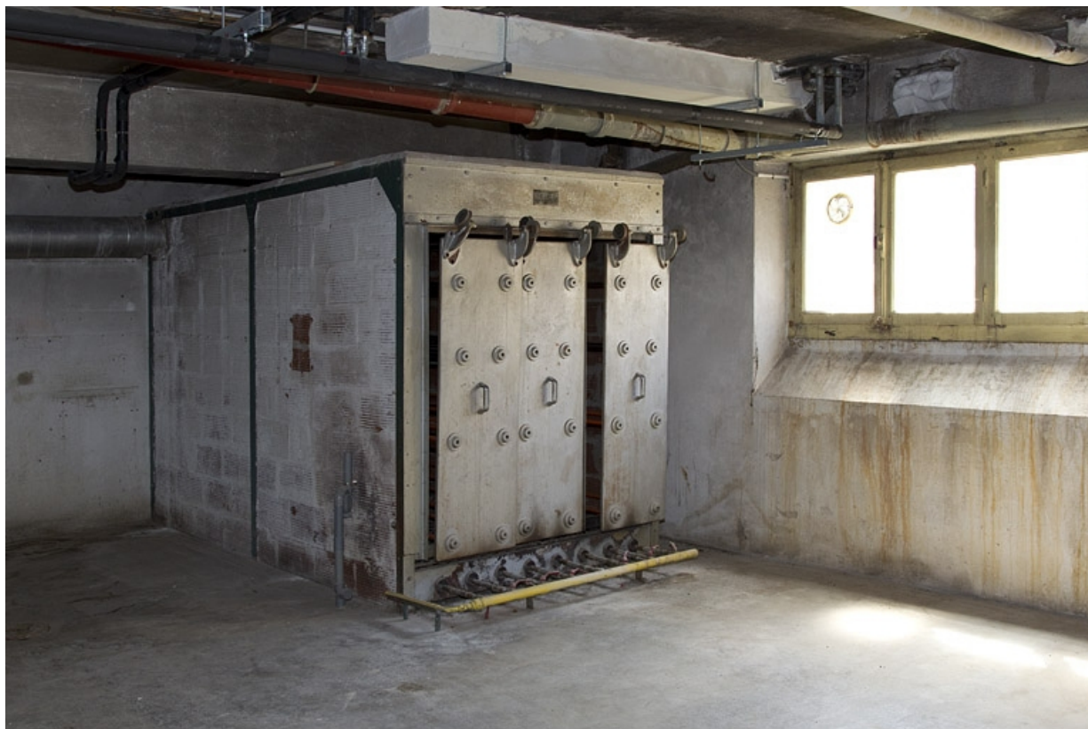
Bâtiment de l'hôtellerie (sous-sol) : séchoir à gaz désaffecté.
