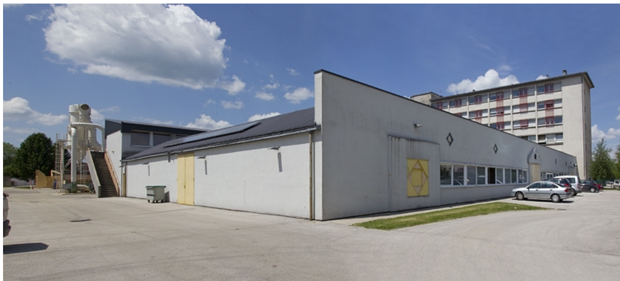
Atelier de maintenance et électrotechnique, depuis le sud-est. 25, Pontarlier, 3 rue des Fusillés
