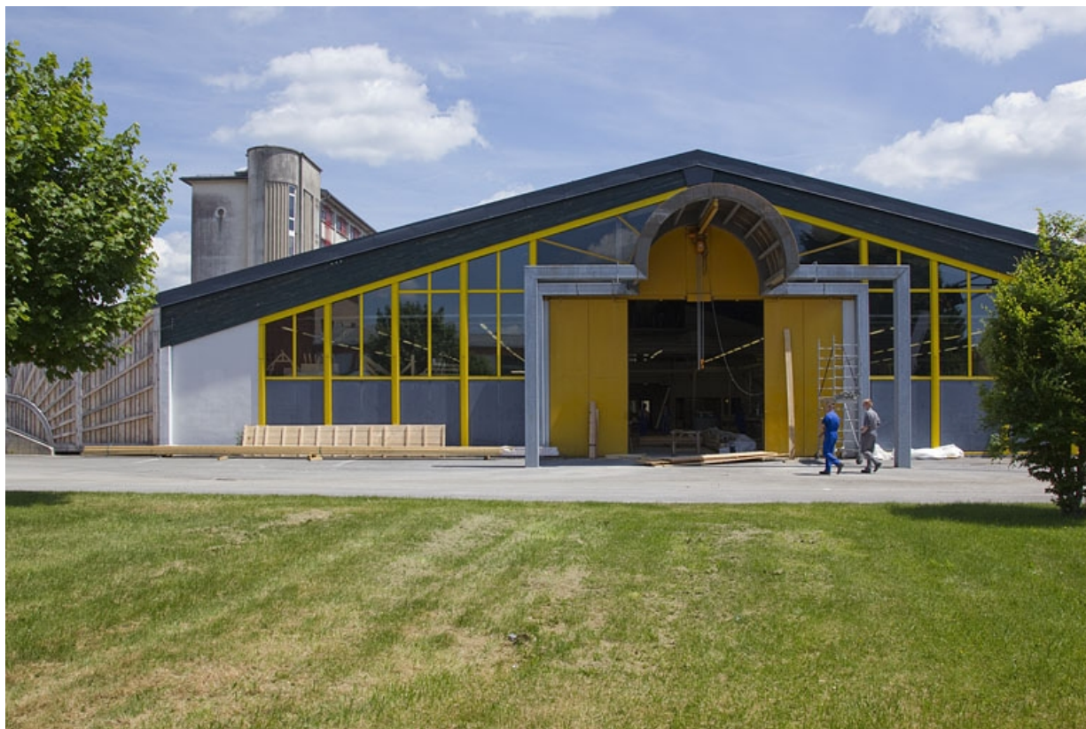
Atelier des métiers du bois : face ouest.
