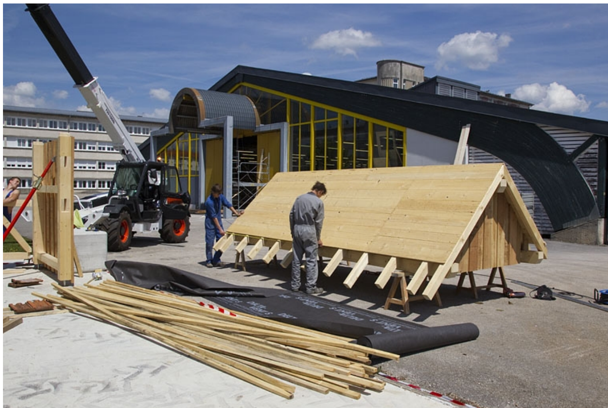
Atelier des métiers du bois et aire de montage : élèves réalisant une toiture. 25, Pontarlier, 3 rue des Fusillés
