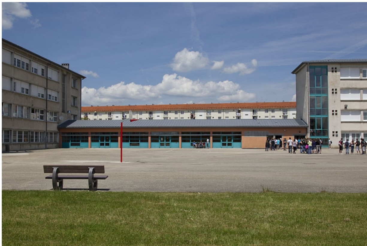
Bâtiment de l'administration : face postérieure.
