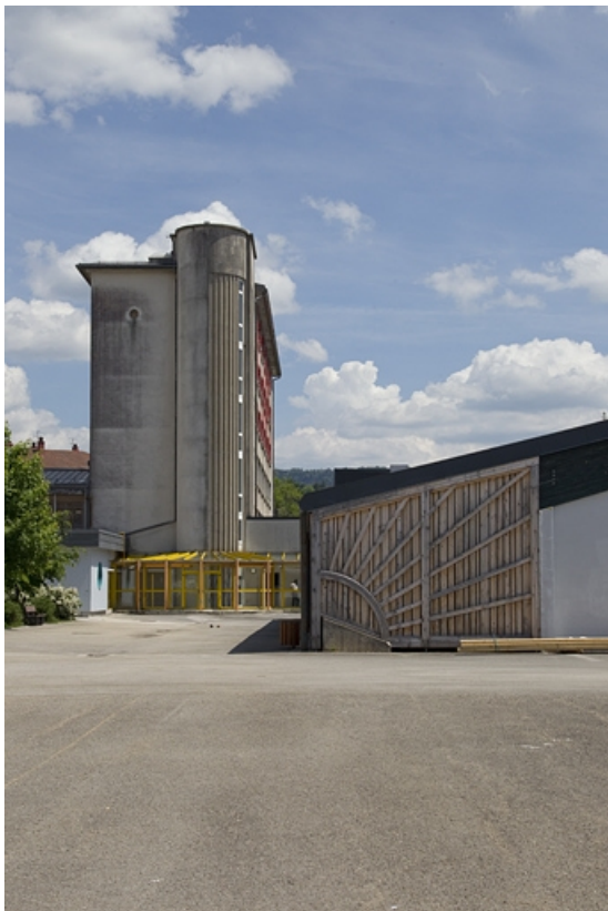
Internat garçons : face latérale et cage d'escalier.
