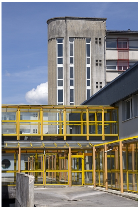
Galerie, depuis le sud.
