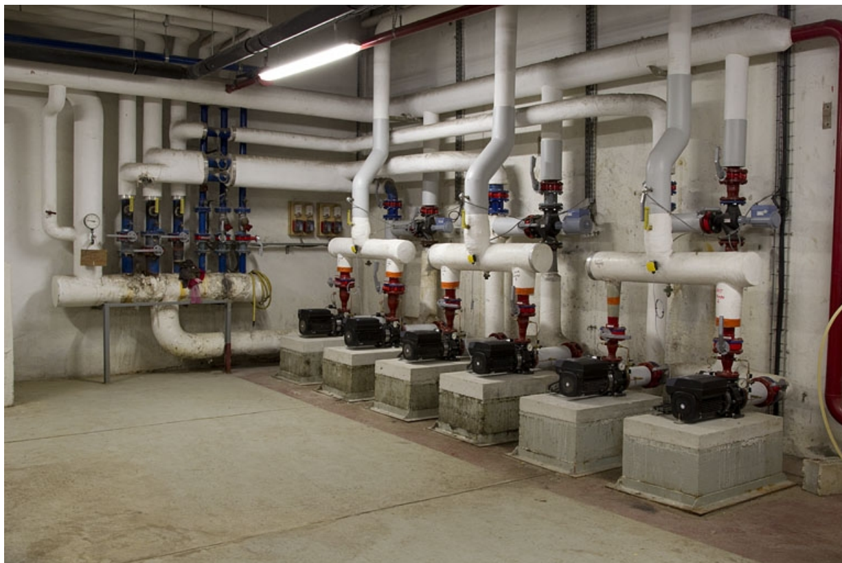
Bâtiment de l'internat ouest, chaufferie : les pompes.
