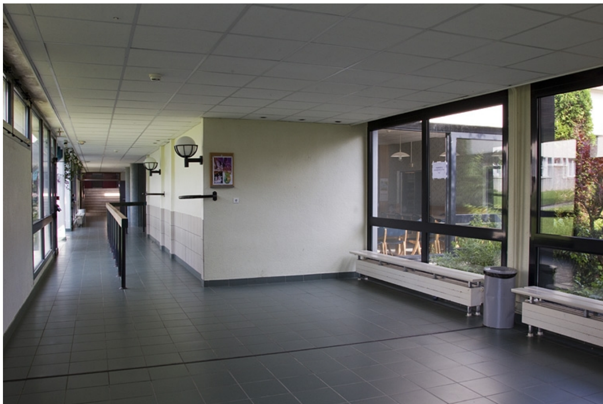
Restauration : couloir côté sud, au niveau d'un patio.
