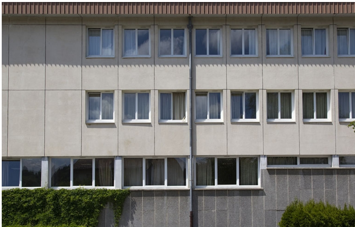
Ancien externat 1er cycle : détail du système constructif sur la façade antérieure.
