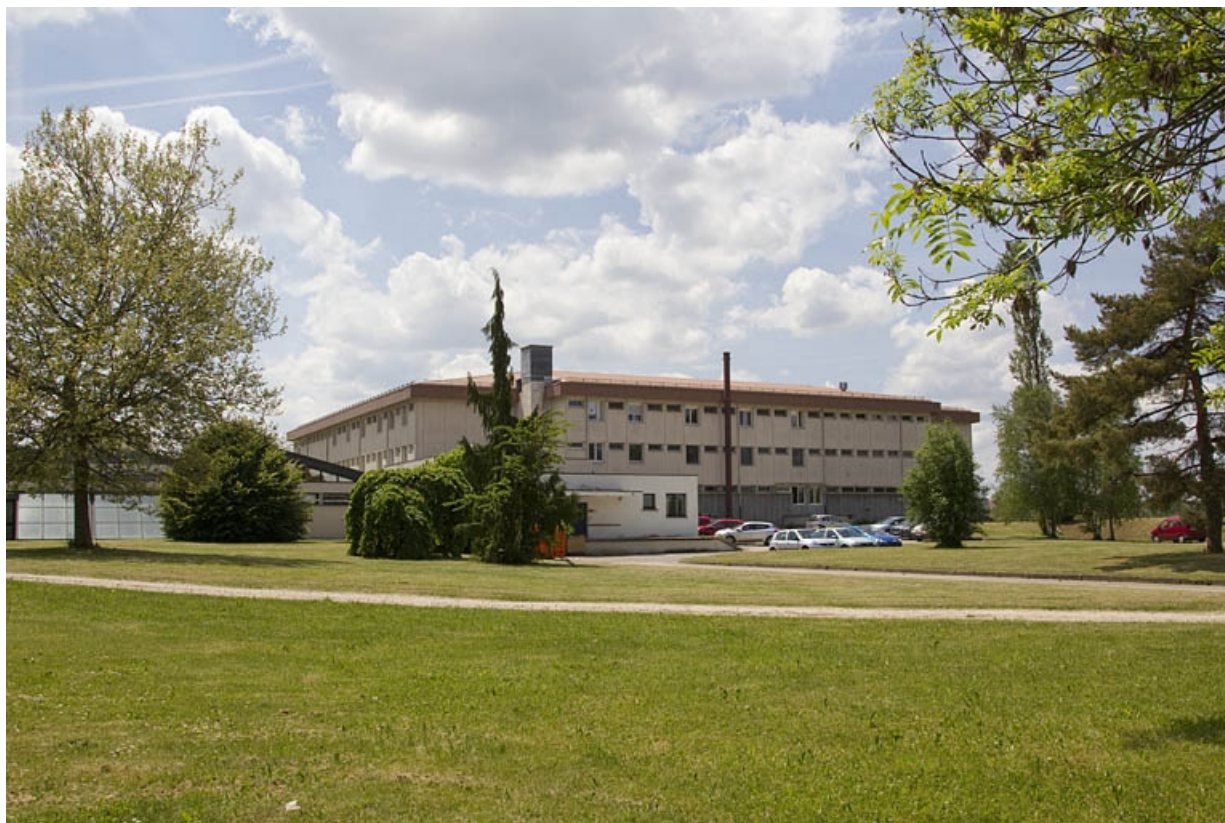
Bâtiment de l'internat ouest, vu du nord.
