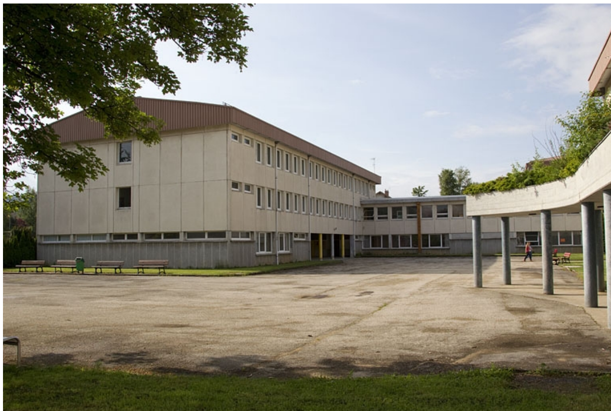
Ancien externat 2e cycle : façades postérieure et latérale gauche.
