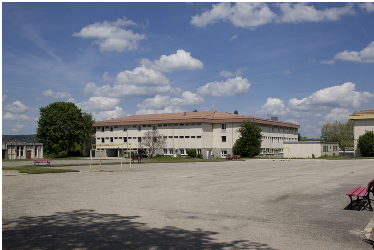
Bâtiment de l'internat ouest, vu du sud.
