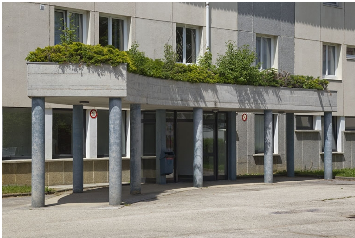
Bâtiment de l'infirmierie : portique.
