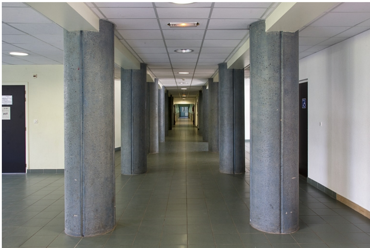
Bâtiment de l'infirmierie : colonnes.
