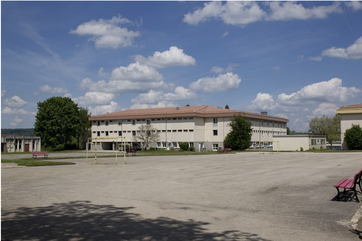
Bâtiment de l'internat ouest, vu du sud.
