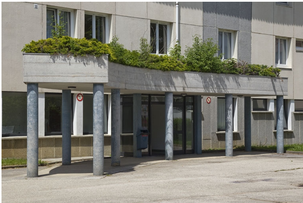
Bâtiment de l'infirmierie : portique.
