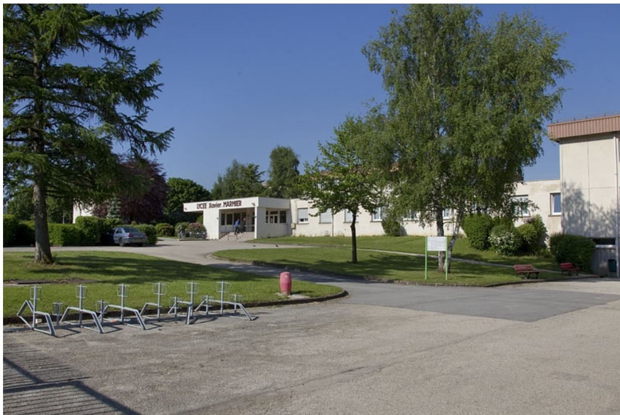
Bâtiment de l'administration depuis la rue de Doubs, à l'est. 25, Pontarlier, 53 rue de Doubs
