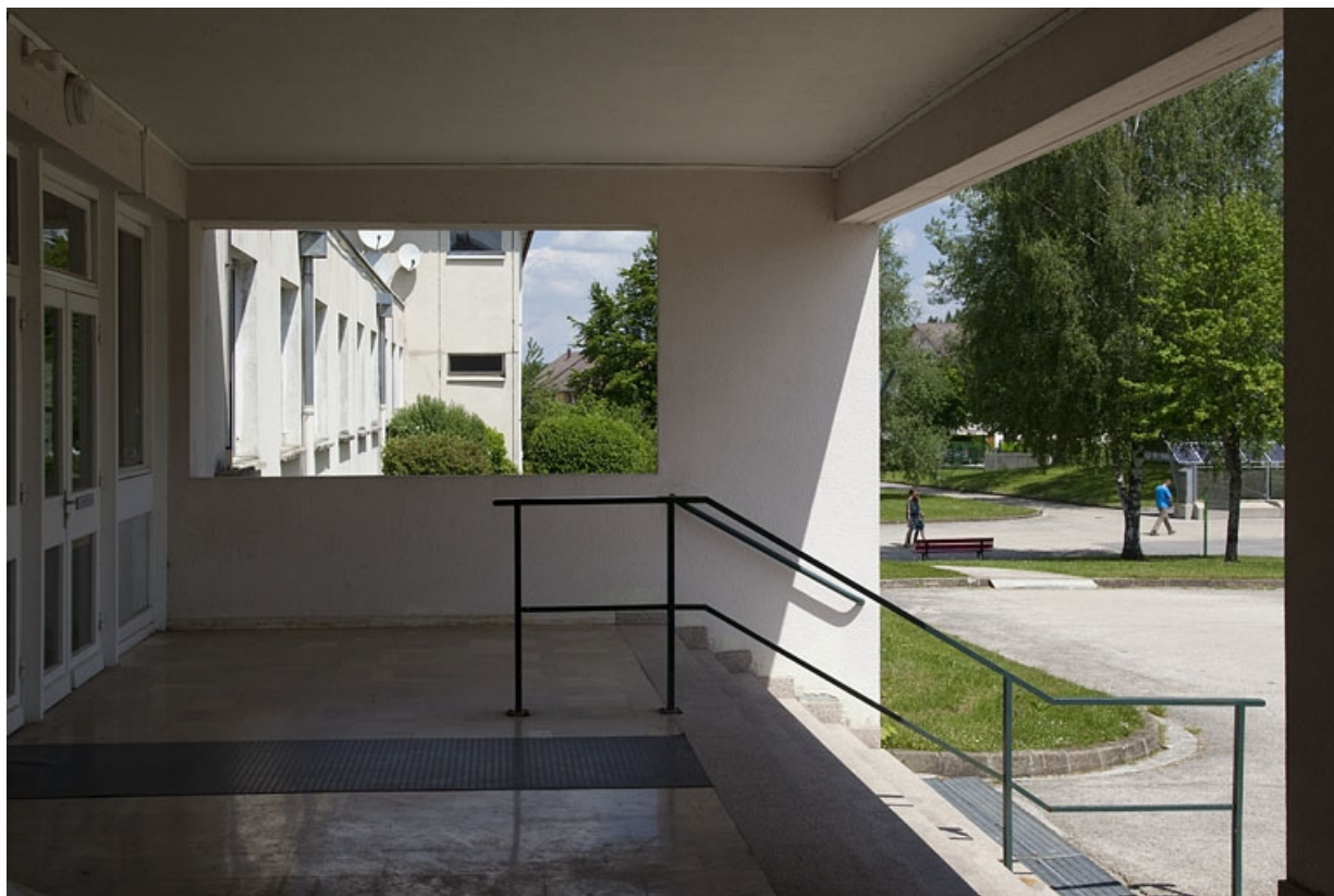
Bâtiment de l'administration : entrée couverte.
