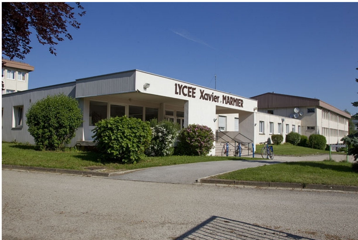
Bâtiment de l'administration et ancien externat 2e cycle.
