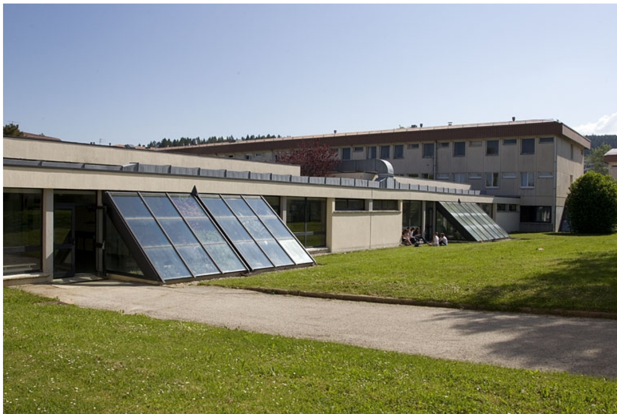
Bâtiment de la restauration : face sud.
