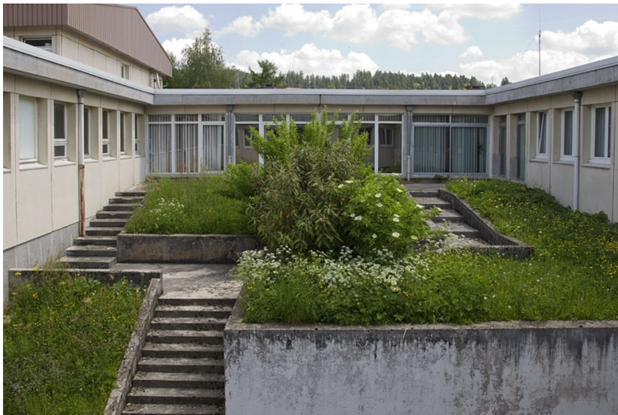
Bâtiment de l'administration : patio.
