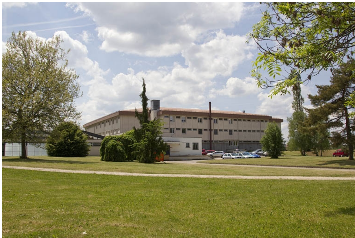
Bâtiment de l'internat ouest, vu du nord.
