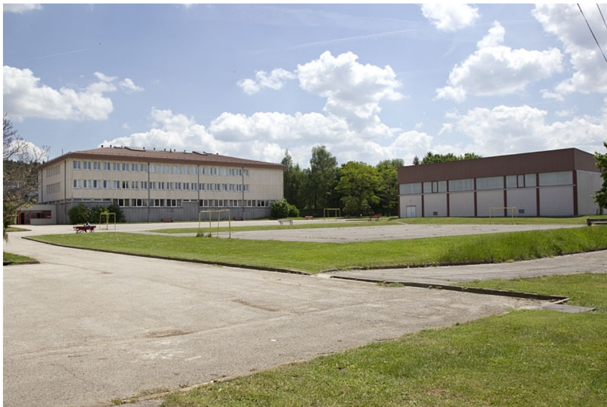
Ancien externat 1er cycle et gymnase, depuis le nord-ouest.
