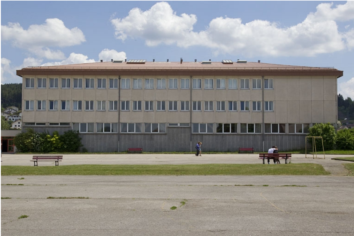
Ancien externat 1er cycle : façade postérieure (depuis l'ouest). 25, Pontarlier, 53 rue de Doubs
