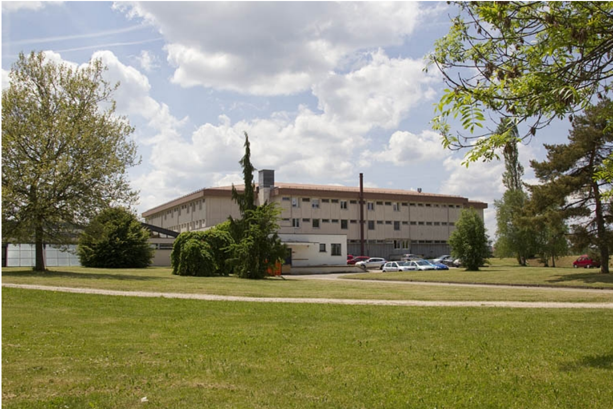
Bâtiment de l'internat ouest, vu du nord.
