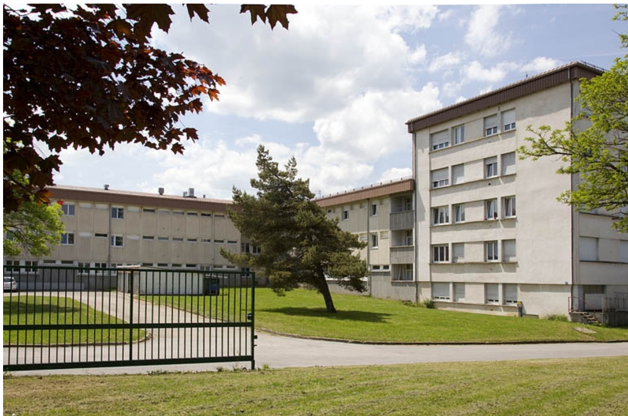
Face postérieure du bâtiment des salles techniques-internat et logements nord. 25, Pontarlier, 53 rue de Doubs
