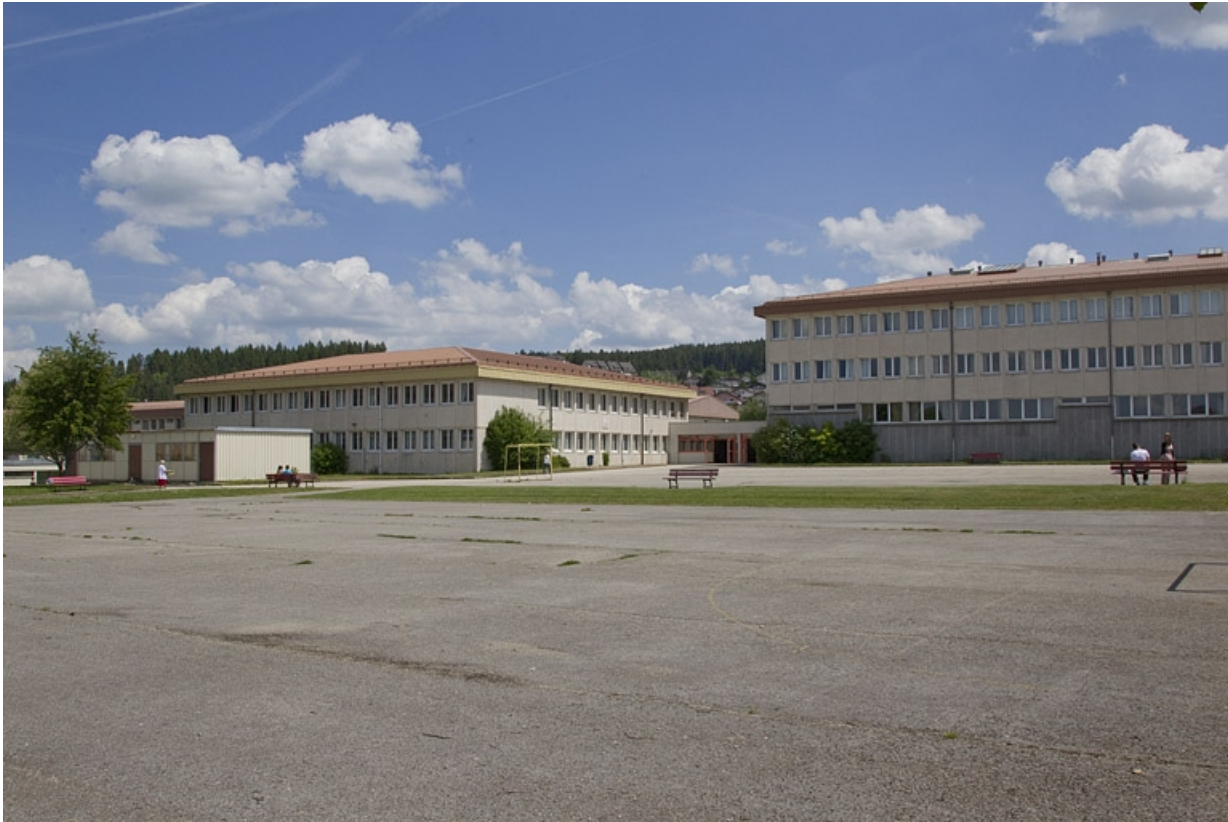
Ancien bâtiment des classe scientifiques, depuis les terrains de jeu à l'ouest. 25, Pontarlier, 53 rue de Doubs
