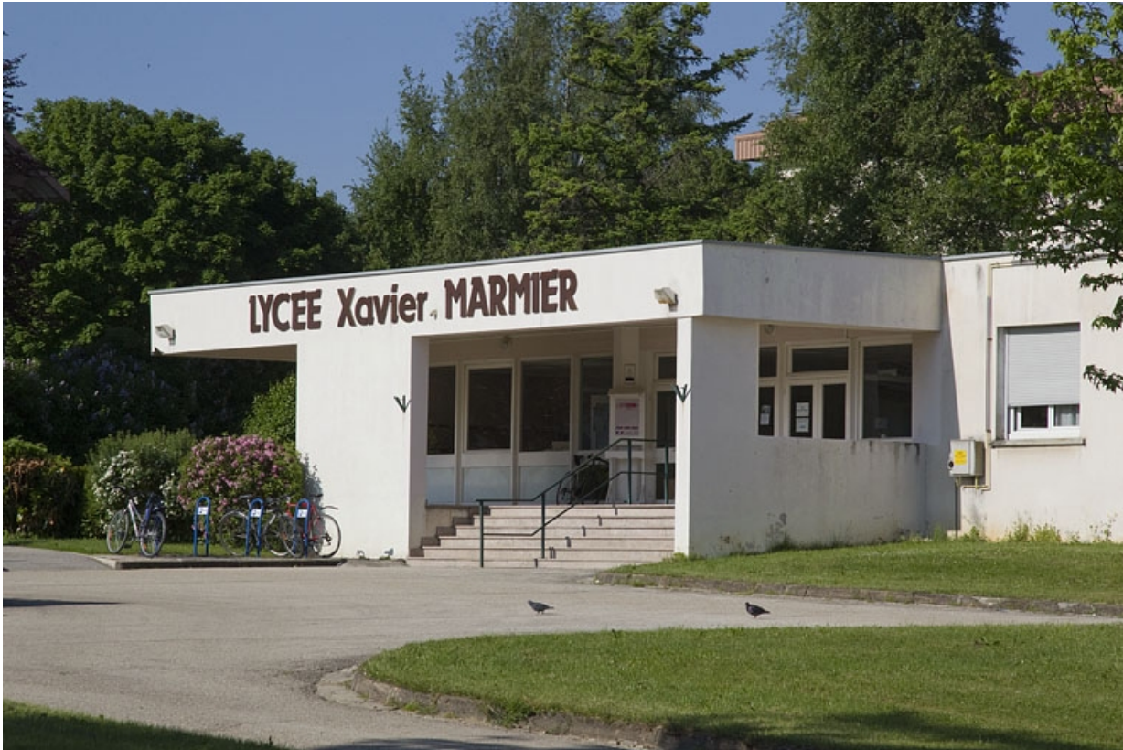
Bâtiment de l'administration : entrée.
