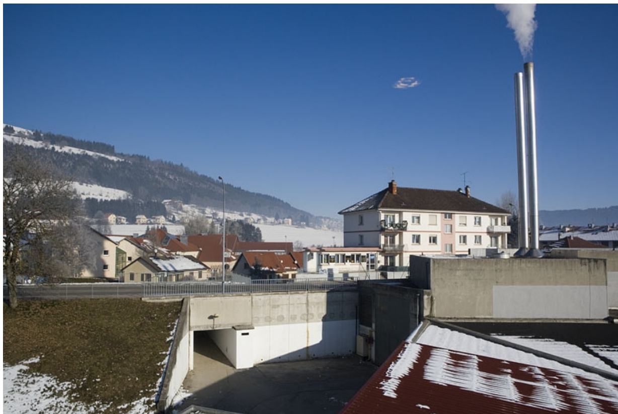
Site ancien : tunnel et chaufferie, depuis l'internat.
