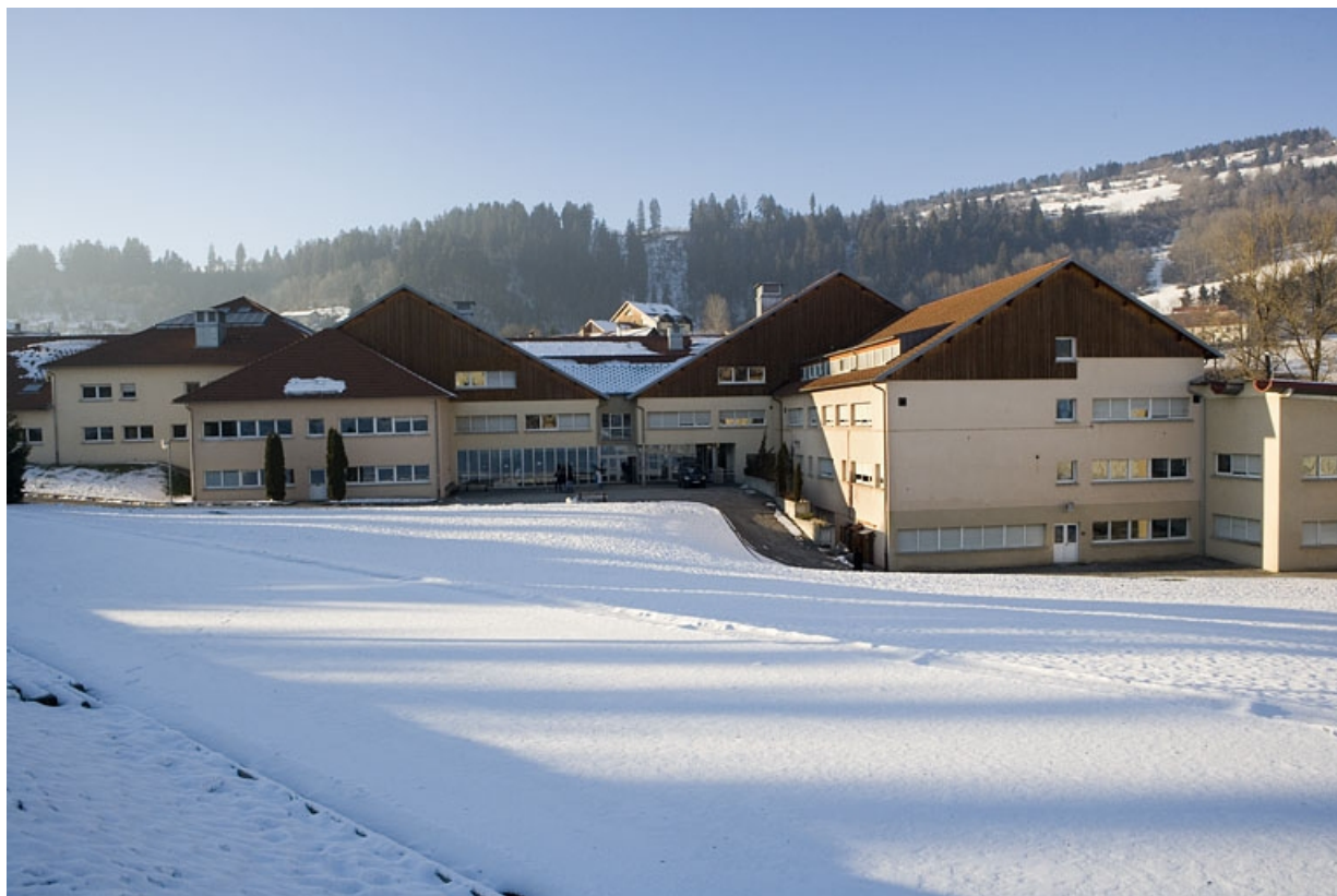
Site récent : bâtiments de l'administration (à gauche) et du pôle bijouterie (au centre et à droite), depuis l'est. 25, Morteau, 2 rue du Docteur Léon Sauze
