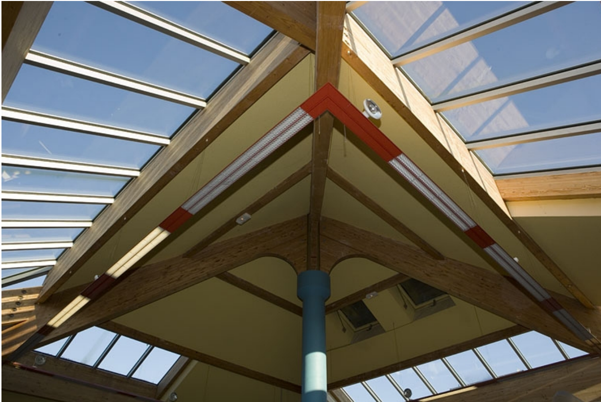
Site récent, centre de documentation (CDI) : charpente en lamellé-collé.
