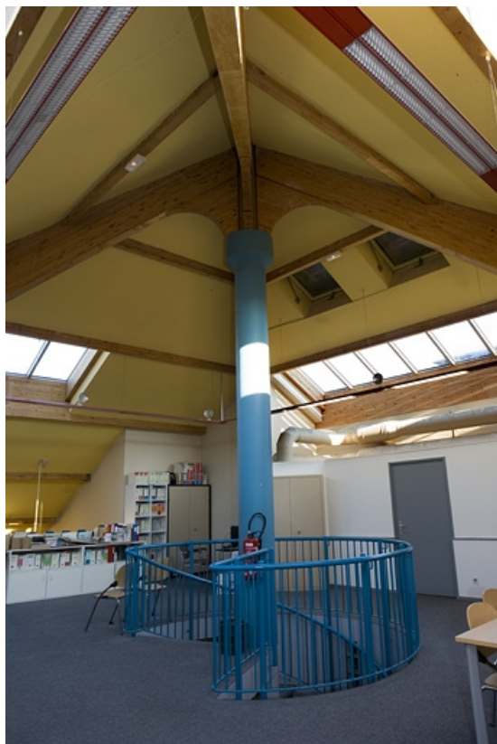
Site récent, centre de documentation (CDI) : escalier en vis desservant la tribune et colonne supportant la charpente. 25, Morteau, 2 rue du Docteur Léon Sauze
