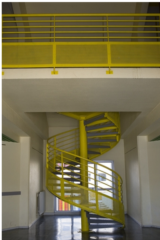
Site récent, bâtiment des salles d'informatique et du pôle bijouterie : escalier en vis et galerie à l'étage en surcroît. 25, Morteau, 2 rue du Docteur Léon Sauze
