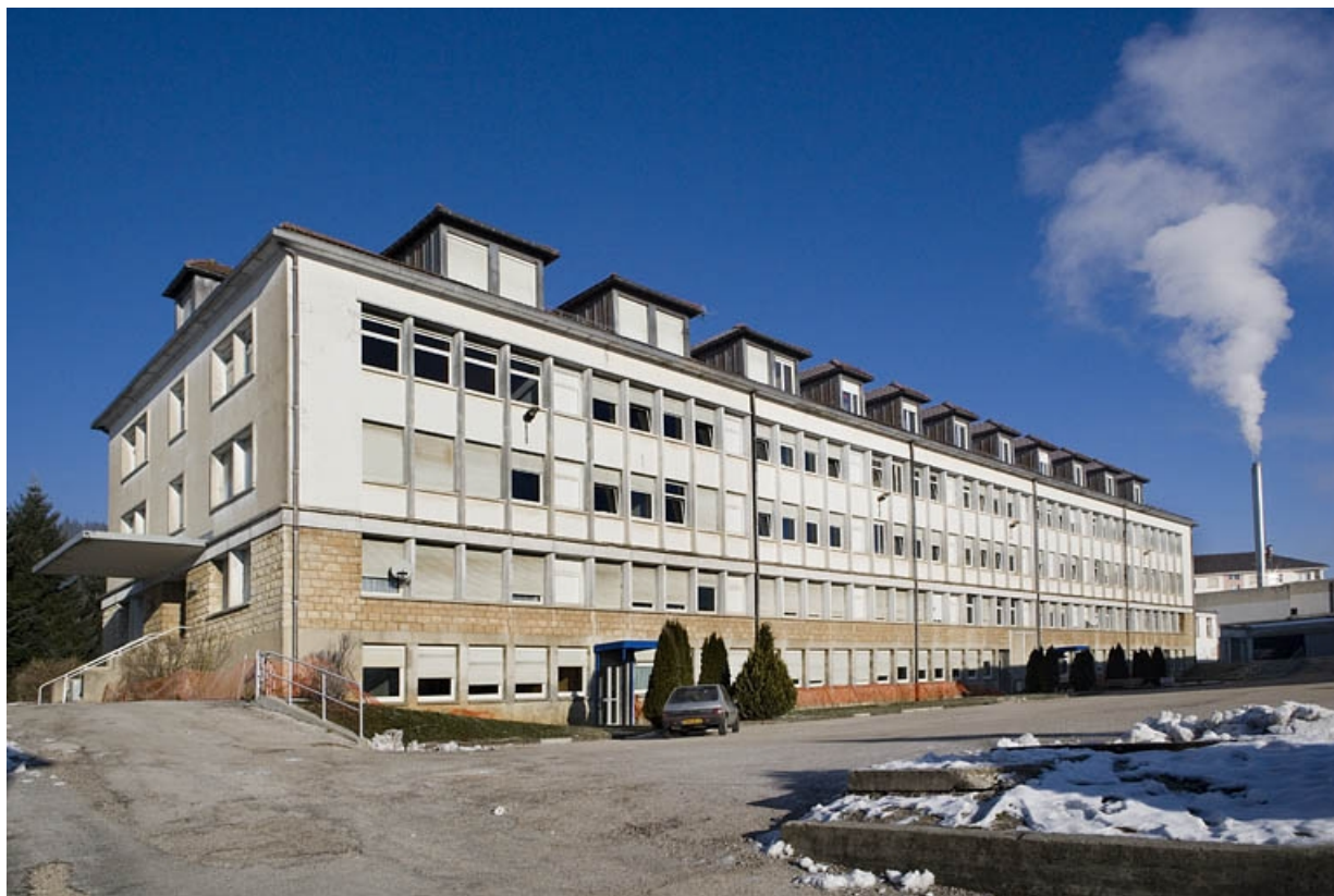
Site ancien : internat (ancien externat). 25, Morteau, 2 rue du Docteur Léon Sauze
