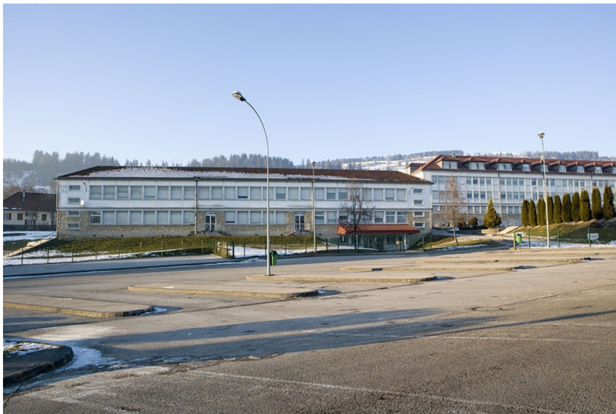
Site ancien : cantine (au centre) et internat, depuis le sud-est.
