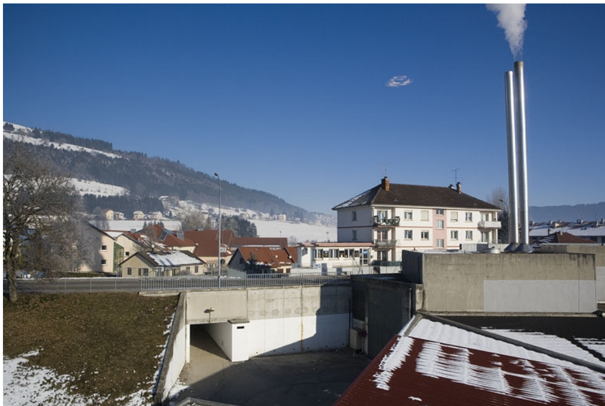
Site ancien : tunnel et chaufferie, depuis l'internat.
