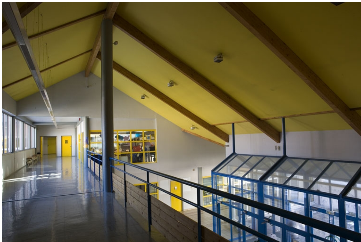
Site récent : galerie à l'étage de l'entrée des élèves (depuis le côté salles de physique-chimie). 25, Morteau, 2 rue du Docteur Léon Sauze
