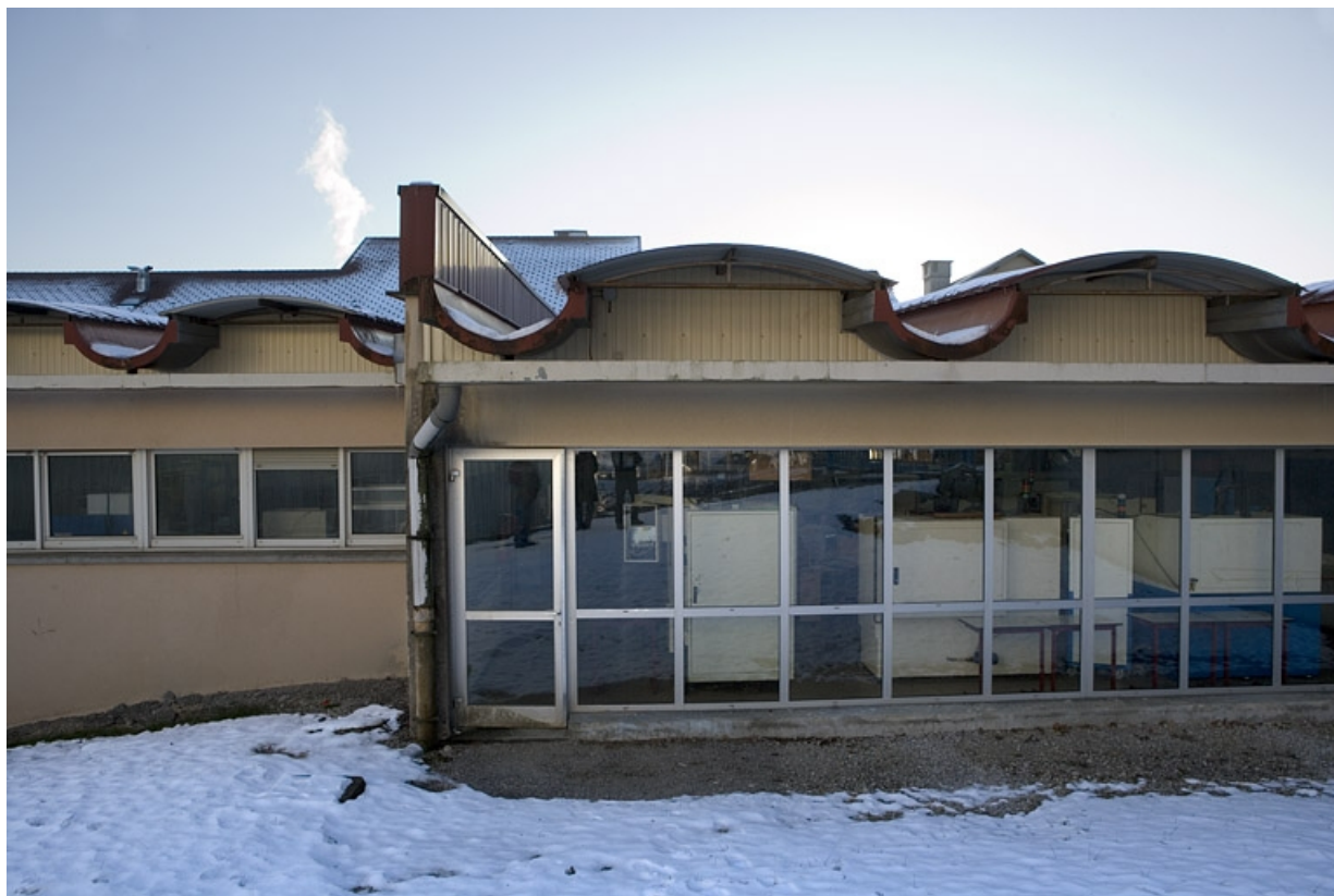
Site récent, atelier de microtechnique : paroi vitrée et toiture.
