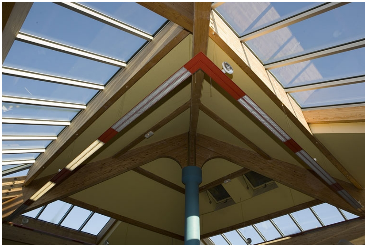
Site récent, centre de documentation (CDI) : charpente en lamellé-collé. 25, Morteau, 2 rue du Docteur Léon Sauze
