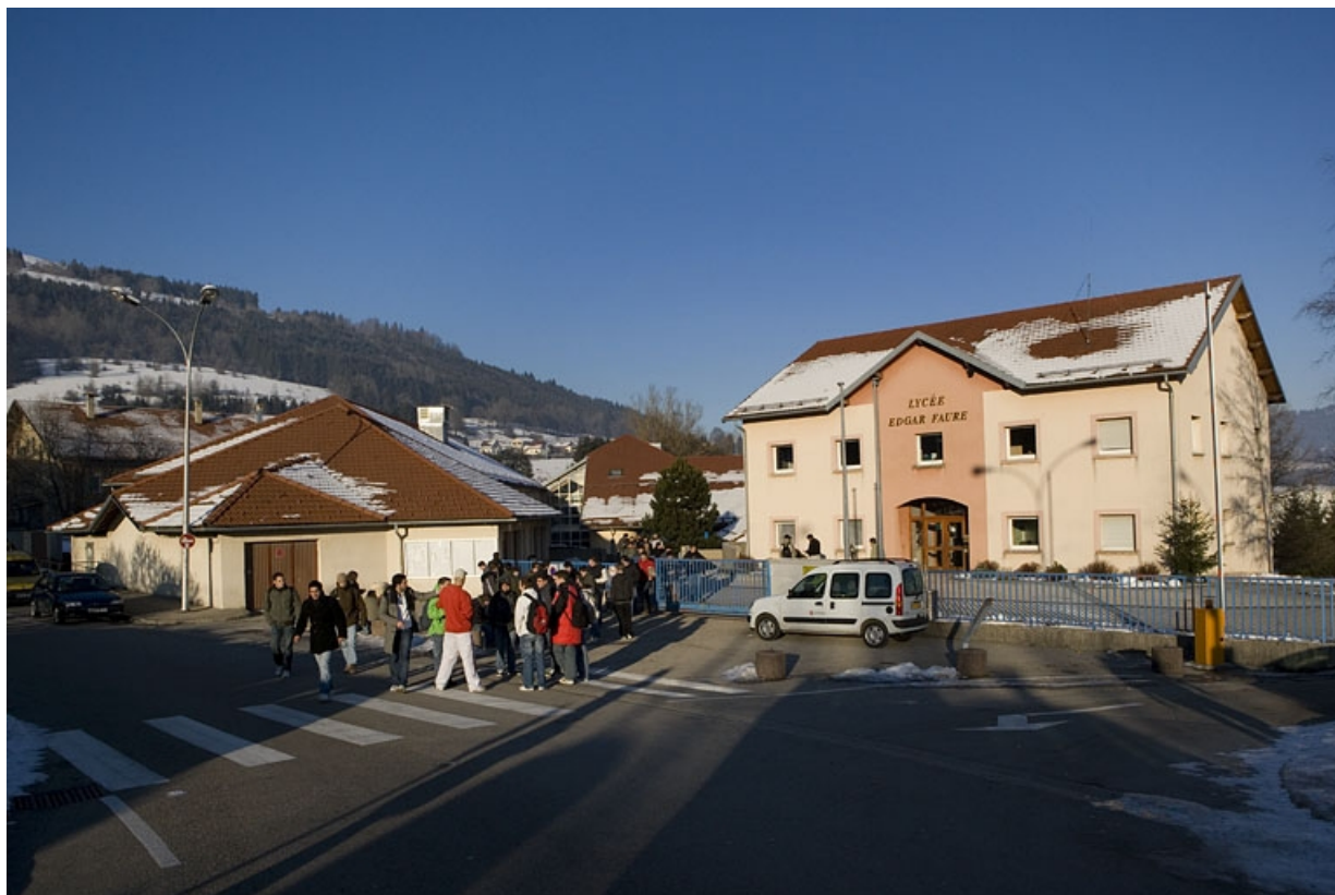
Site récent : vue d'ensemble de l'entrée, depuis le sud.
