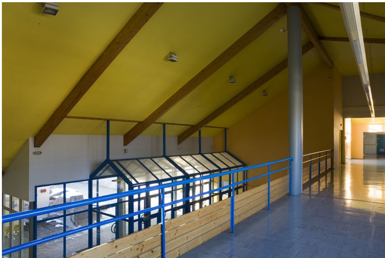
Site récent : galerie à l'étage de l'entrée des élèves (depuis le côté CDI-administration). 25, Morteau, 2 rue du Docteur Léon Sauze
