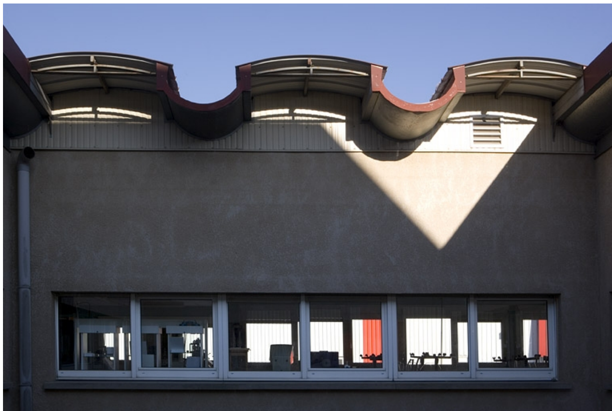
Site récent, atelier d'horlogerie : toiture. 25, Morteau, 2 rue du Docteur Léon Sauze
