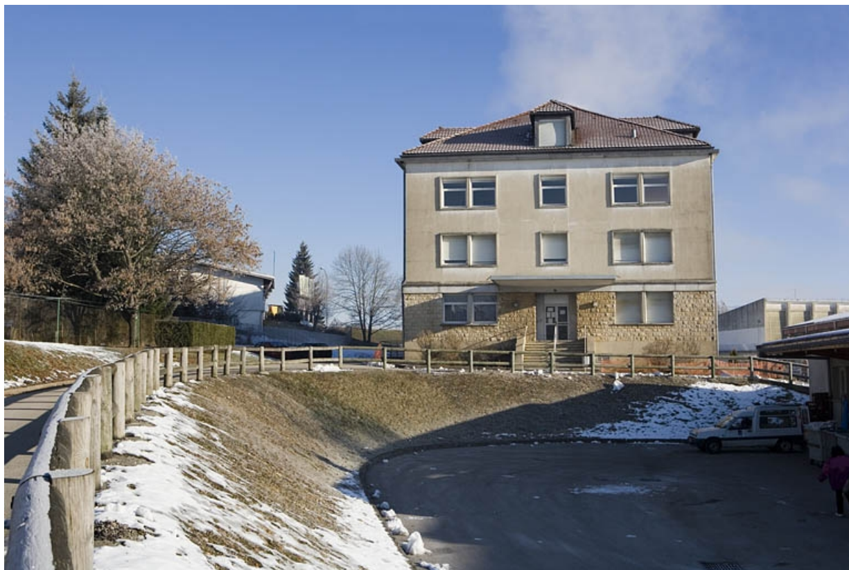
Site ancien, internat : mur pignon sud-ouest. 25, Morteau, 2 rue du Docteur Léon Sauze
