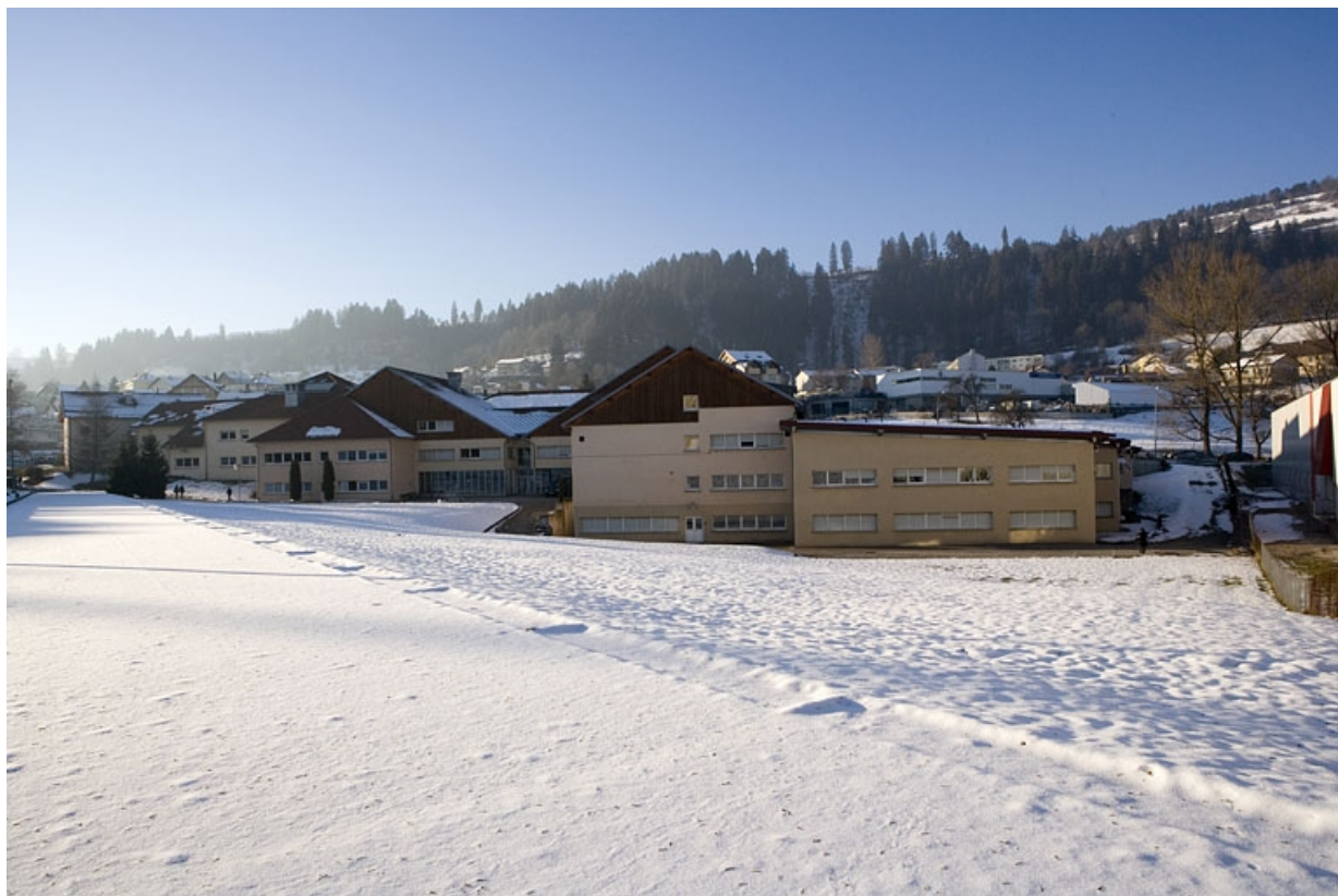
Site récent : vue d'ensemble, depuis l'est. 25, Morteau, 2 rue du Docteur Léon Sauze
