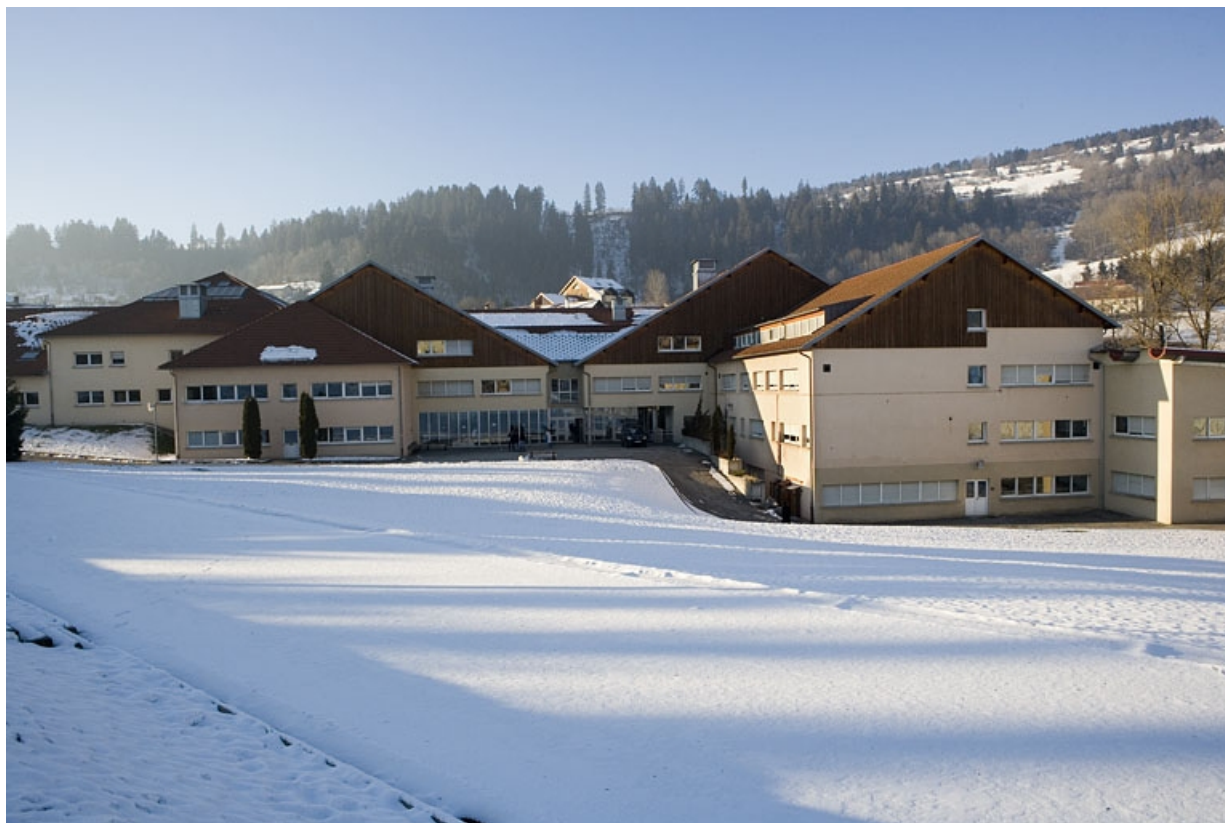
Site récent : bâtiments de l'administration (à gauche) et du pôle bijouterie (au centre et à droite), depuis l'est. 25, Morteau, 2 rue du Docteur Léon Sauze
