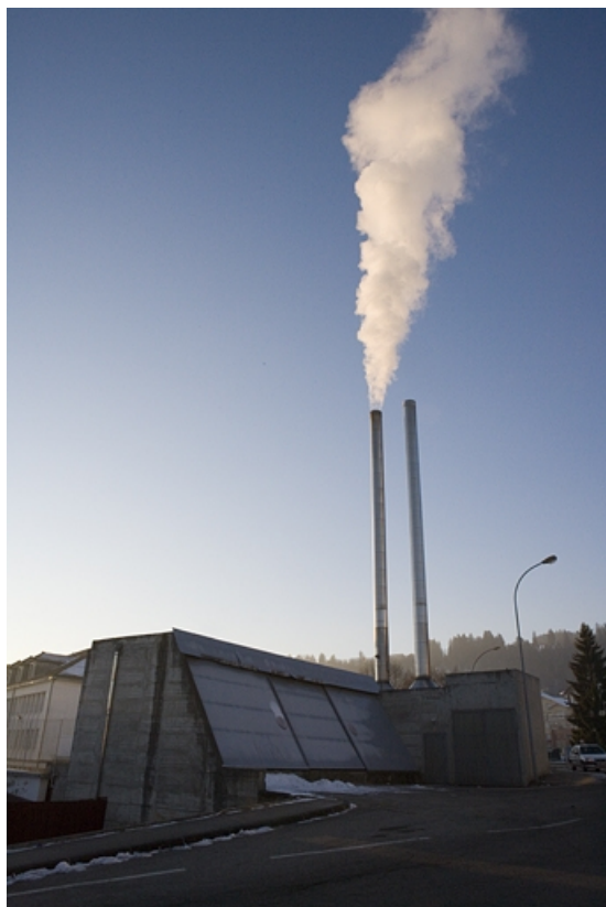
Site ancien : chaufferie, depuis l'avenue Charles de Gaulle. 25, Morteau, 2 rue du Docteur Léon Sauze
