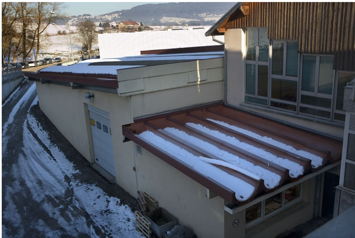
Site récent : angle de l'atelier de microtechnique et du bâtiment des laboratoires. 25, Morteau, 2 rue du Docteur Léon Sauze
