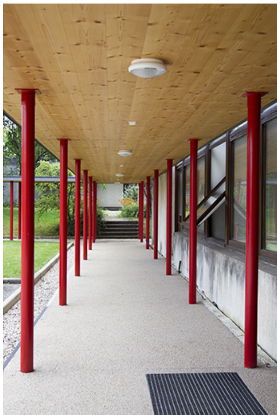
Le long de la façade antérieure est de l'administration.
