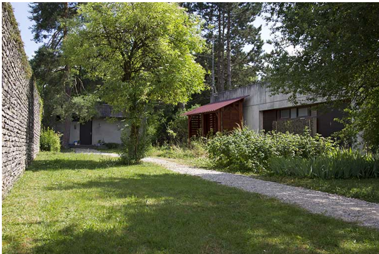
Les deux logements de fonction individuel situé au sud-est du parc, en bordure du mur d'enceinte. 25, Dannemarie-sur-Crète, 16 rue de Damprichard
