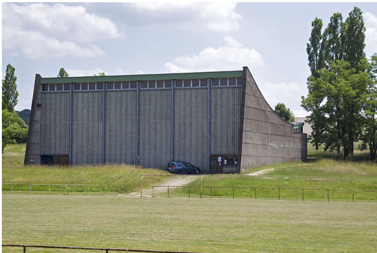
Vue de trois quart postérieur - nord-ouest - du gymnase.
