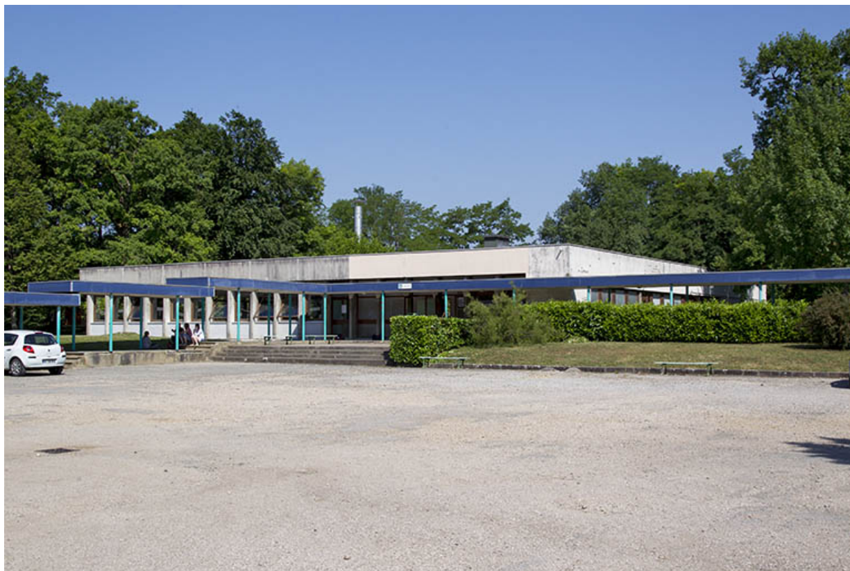
Façade sud de la cantine.
