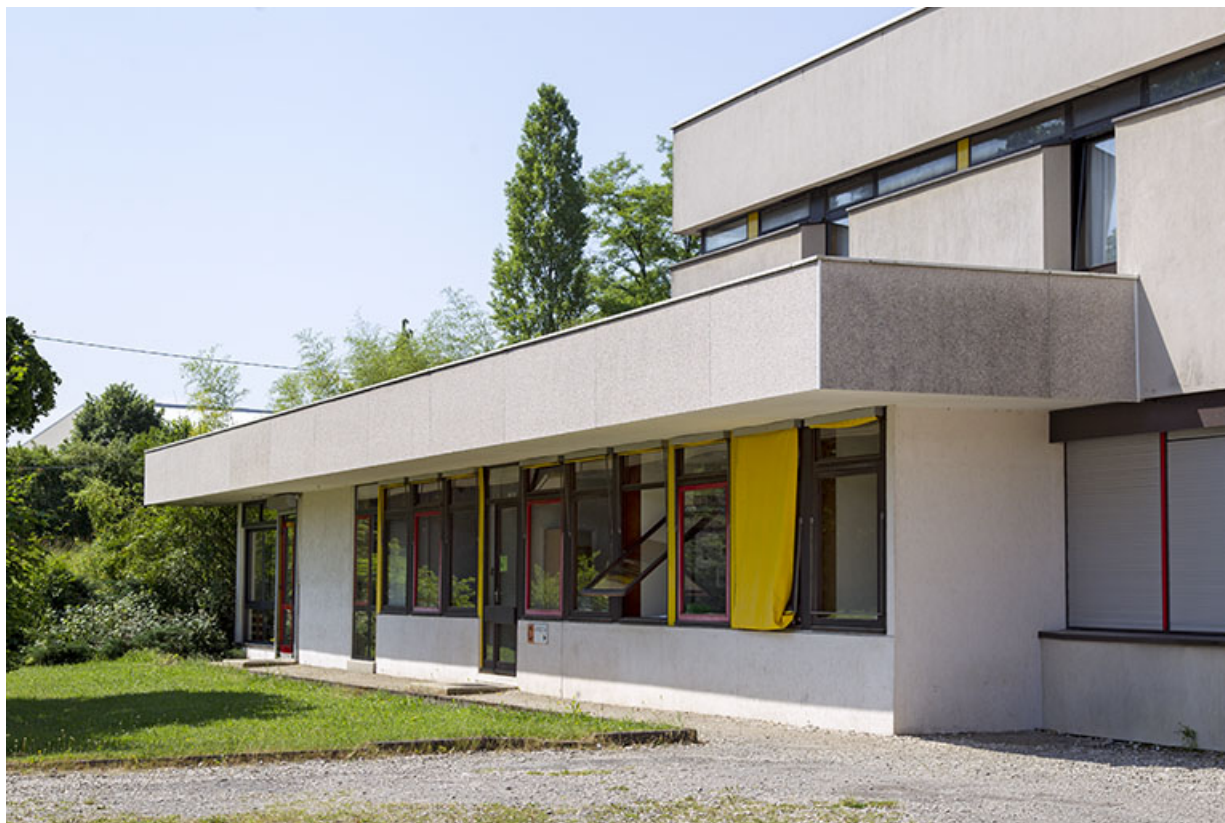
Façade sud-est du centre de documentation et d'information.
