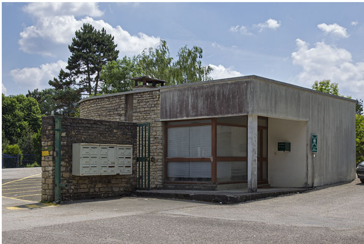
Loge d'entrée vue du nord-ouest.
