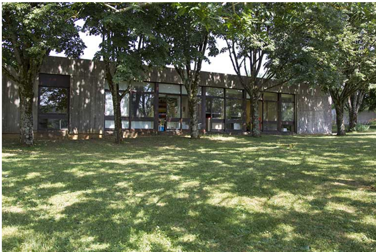
Façade postérieure - ouest - de l'administration.
