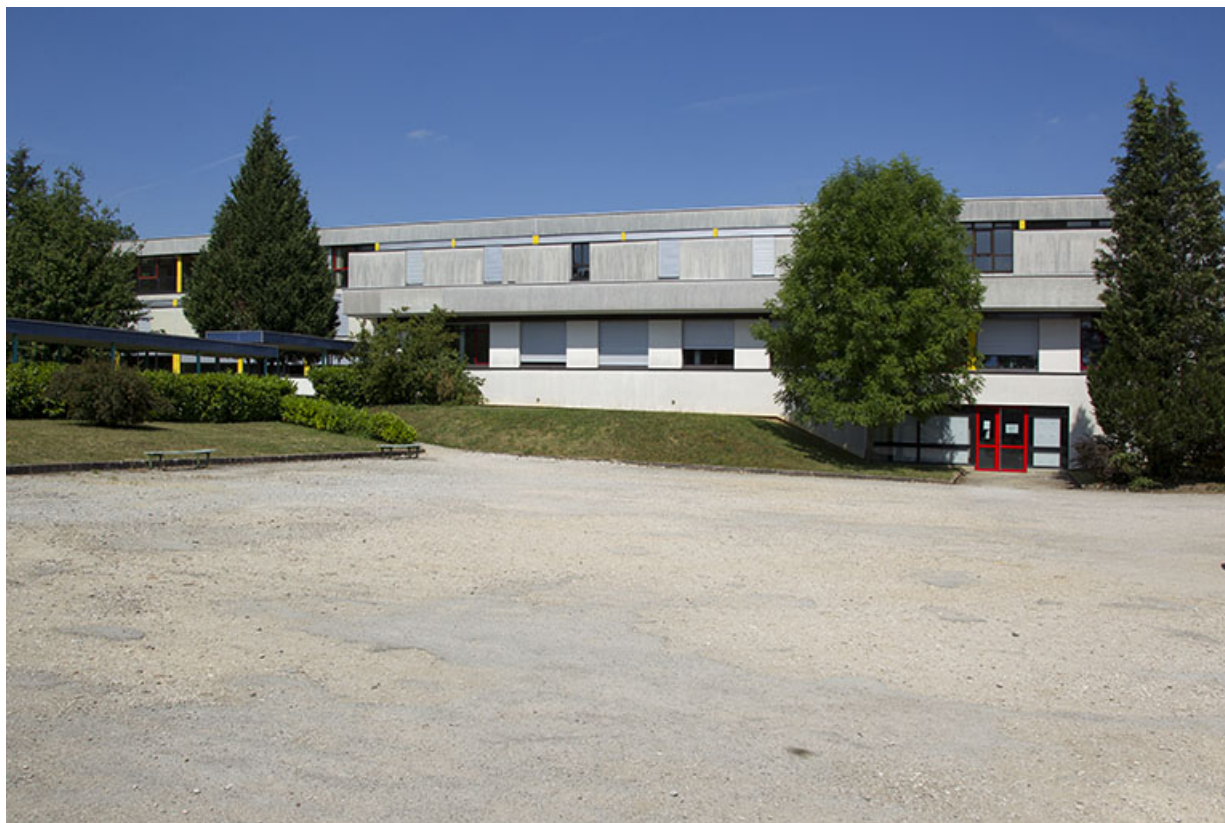
Façade ouest du bâtiment d'internat de garçons et d'externat.
