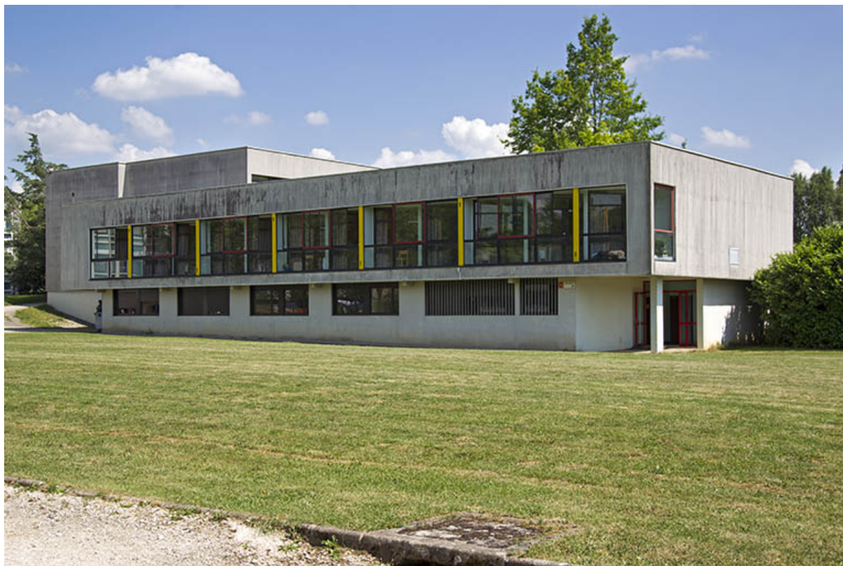
Façade nord et angle nord-ouest du bâtiment d'internat de filles.
