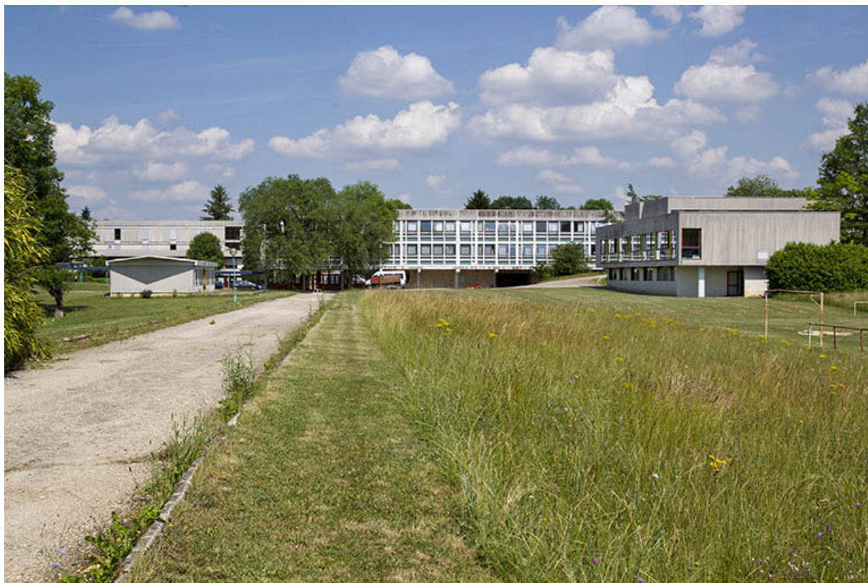
Vue d'ensemble depuis l'ouest du bâtiment d'internat de filles, du bâtiment des classes préparatoires et de l'externat. 25, Dannemarie-sur-Crète, 16 rue de Damprichard
