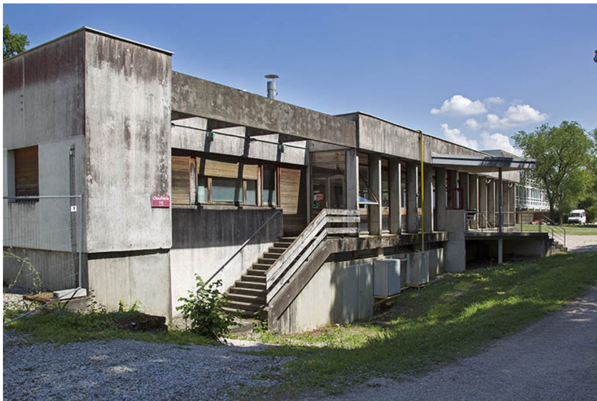
Angle nord-ouest et façade postérieure - nord - de la cantine.
