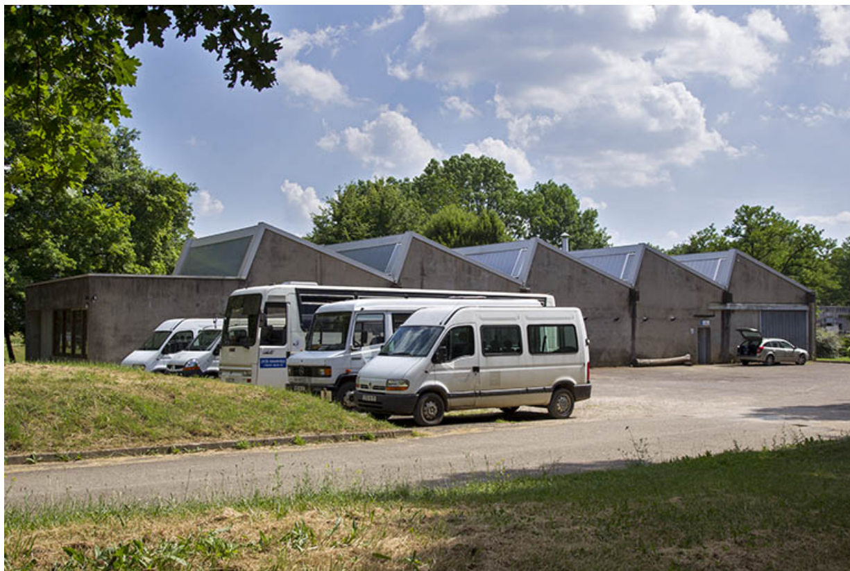
Façade antérieure - nord - de l'atelier.
