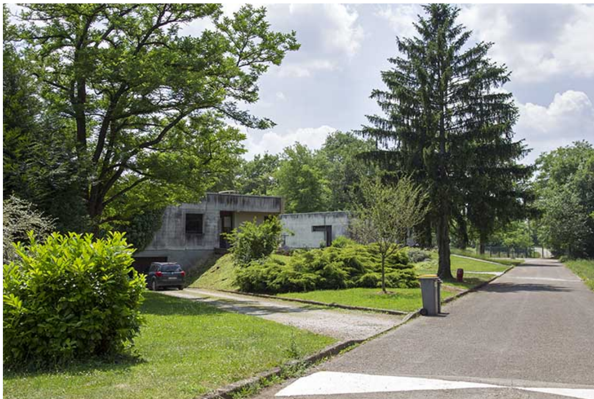
Façades nord des trois pavillons de logement individuel au nord-ouest.
