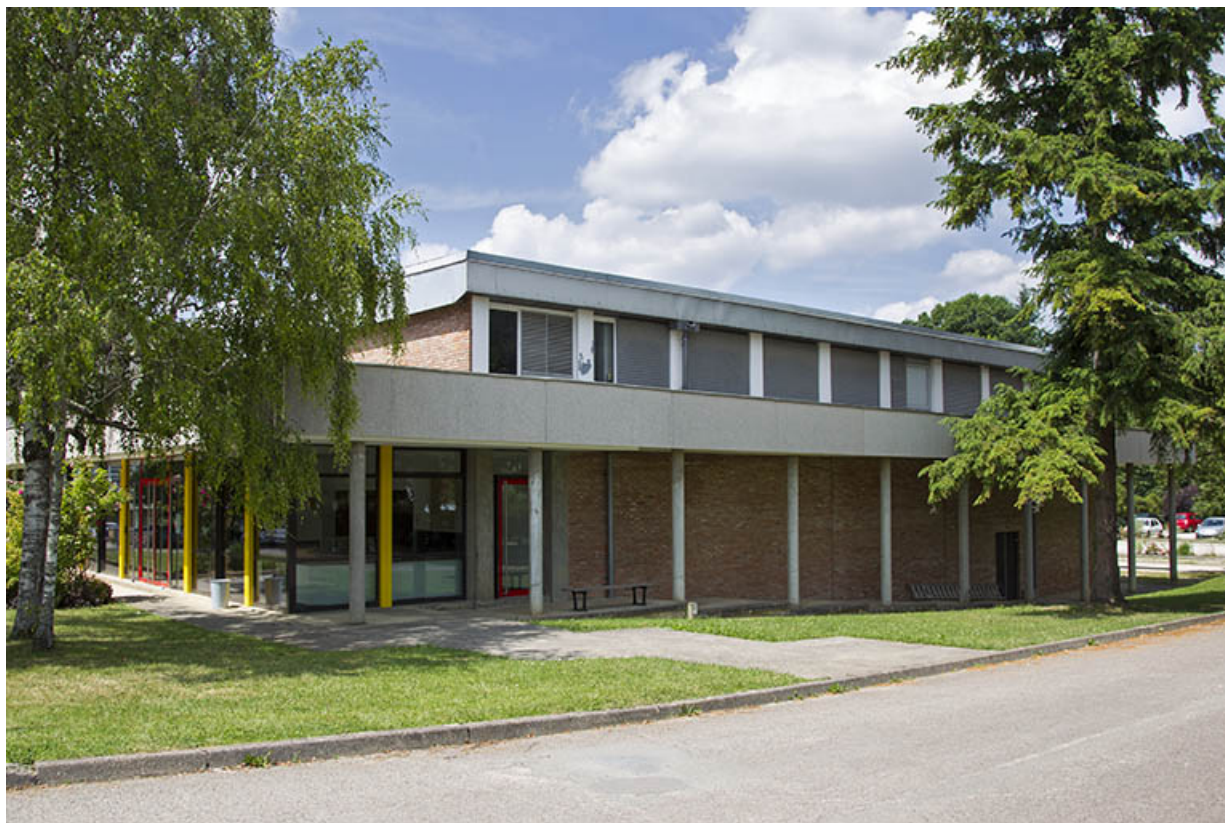
Angle sud-est du bâtiment d'internat de garçons et d'externat.
