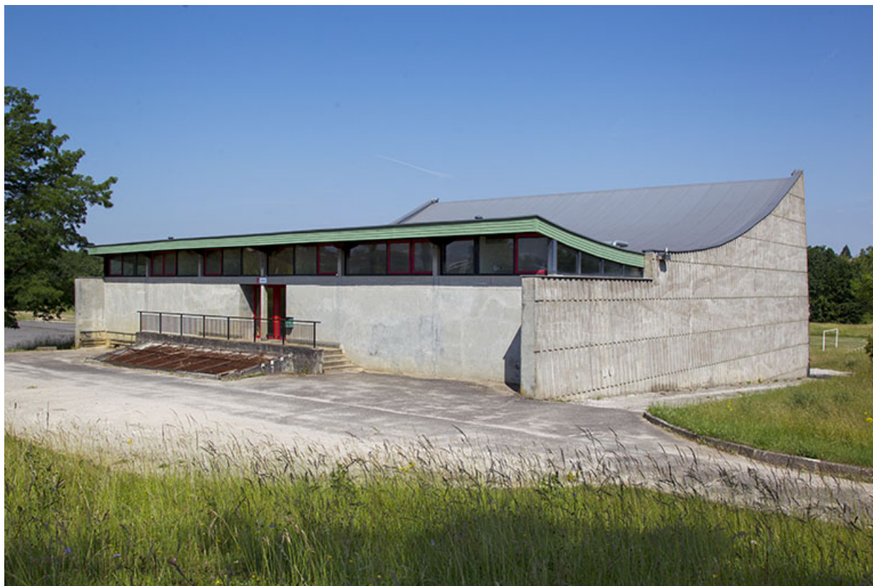
Façade antérieure sud, entrée, angle sud-est du gymnase.
