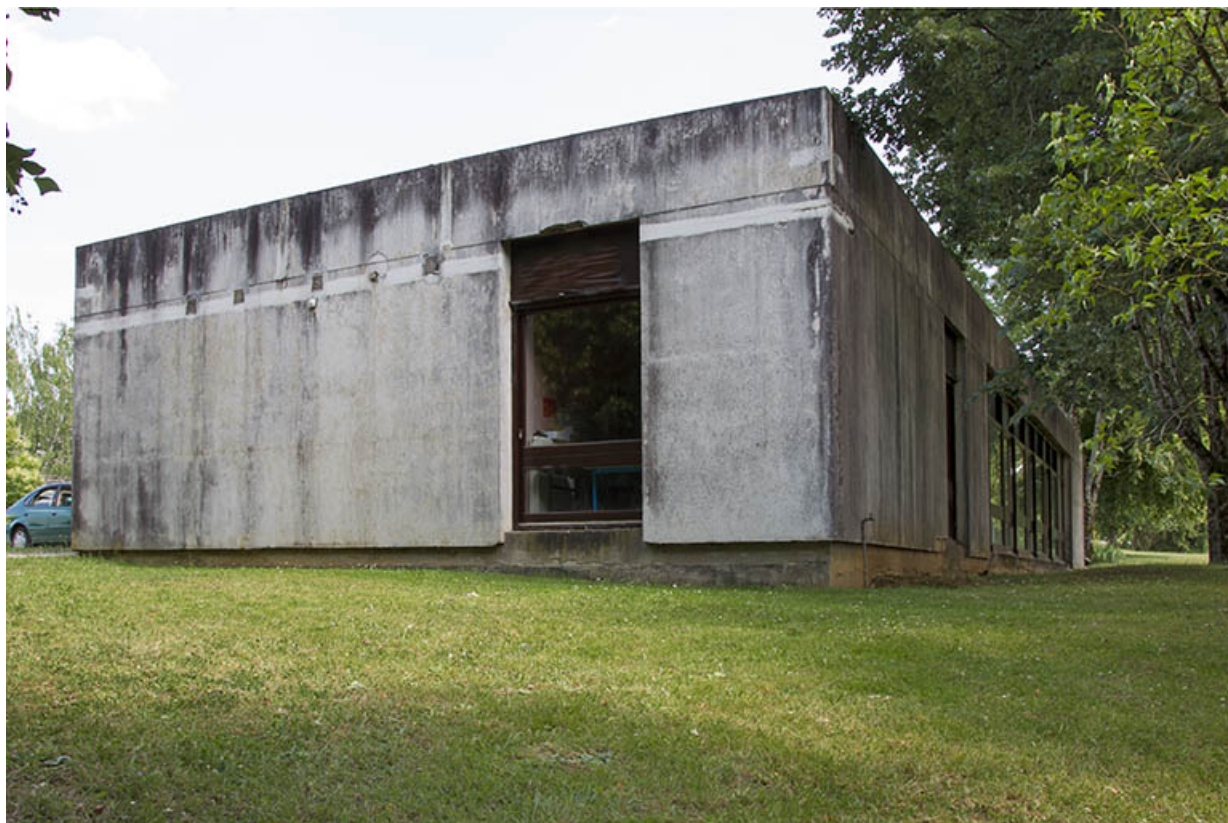
Angle nord-ouest de l'administration, pignon nord et façade postérieure.
