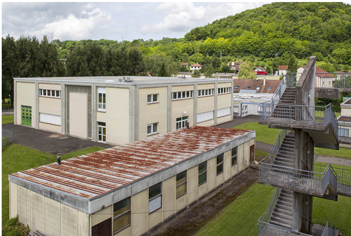
Détail de l'escalier nord-ouest de l'internat, et vue sur les façades est des salles de cours dans un préfabriqué et atelier d'électrotechnique, d'électronique et d'ascensoriste.
