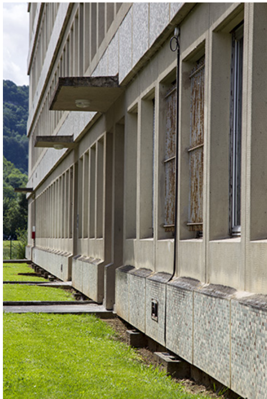
Détail du rez-de-chaussée de la façade antérieure de l'internat.
