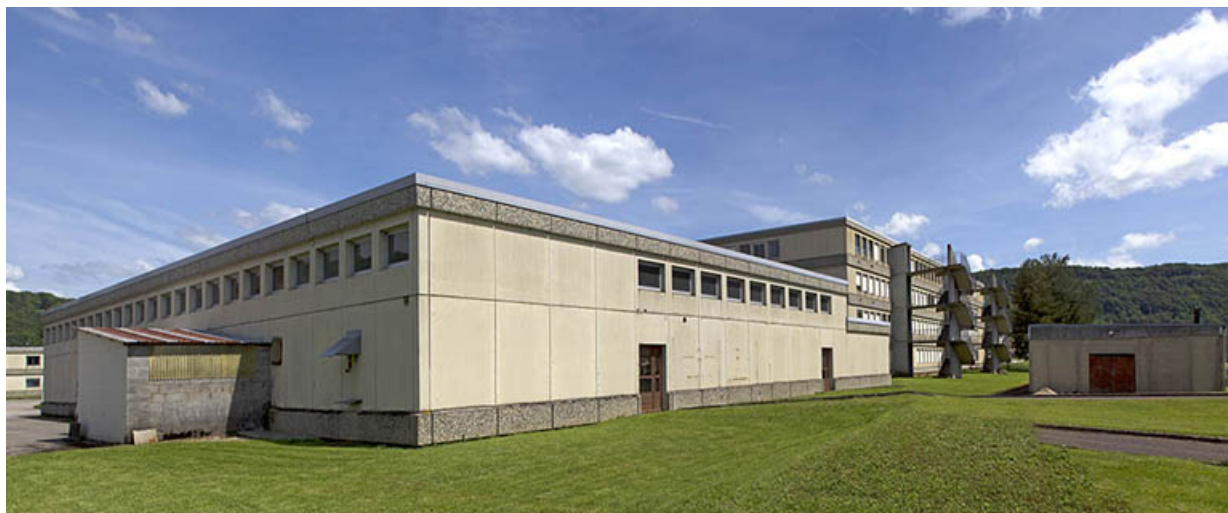
Angle nord-ouest de l'atelier dédié aux métiers de la maintenance.
