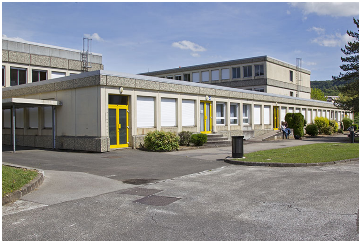
Façade ouest du bâtiment d'enseignement bio services.
