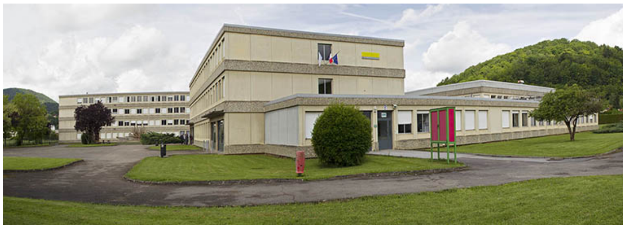
Vue d'ensemble de l'entrée, de la cour, de l'externat et au fond de l'internat. 25, Baume-les-Dames, 16 rue de l' Helvétie
