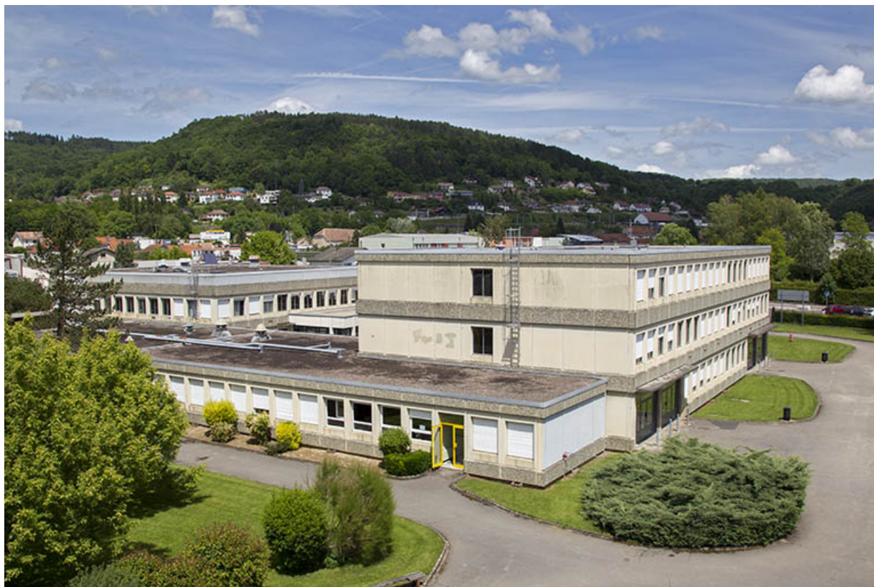
Angle sud de l'externat, vu de l'internat.
