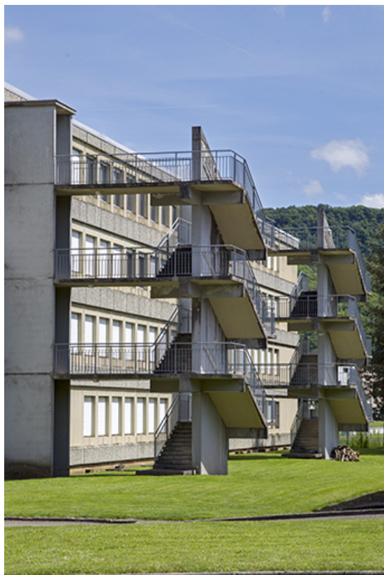
Les deux escaliers de secours sur la façade postérieure ouest de l'internat, vus du nord-ouest. 25, Baume-les-Dames, 16 rue de l' Helvétie
