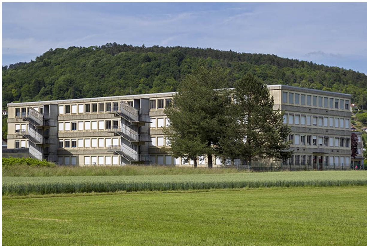
Façade postérieure ouest de l'internat et pignon sud, vus du sud.
