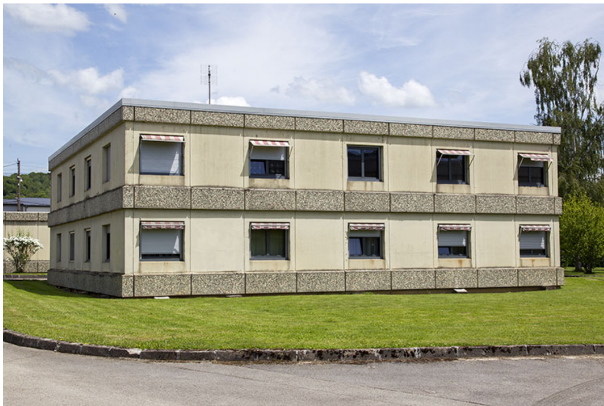
Façade sud-ouest et pignon nord-ouest des logements.
