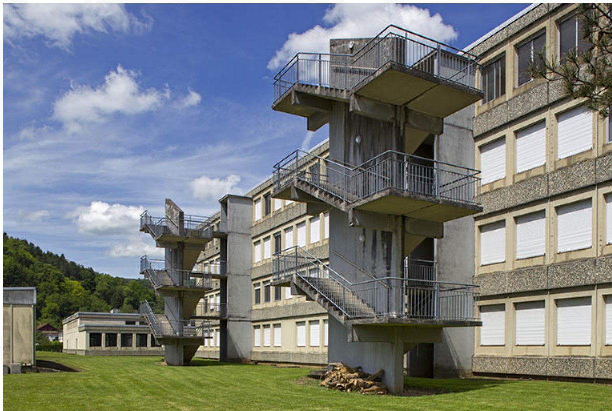
Les deux escaliers de secours sur la façade postérieure ouest de l'internat, vus du sud. 25, Baume-les-Dames, 16 rue de l' Helvétie
