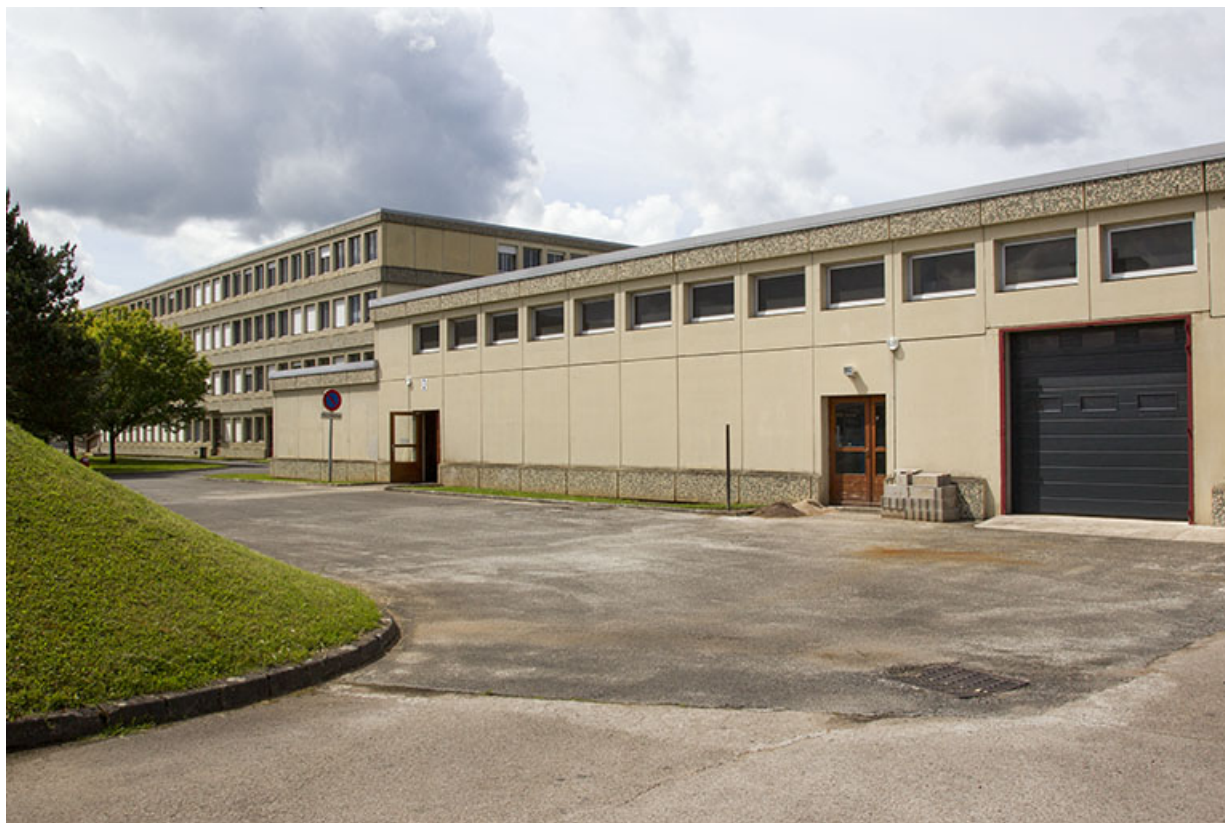
Façade est de l'atelier dédié aux métiers de la maintenance.
