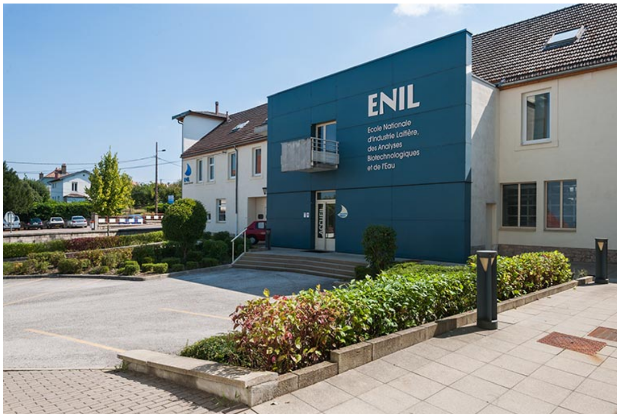
Cour, stationnement et façade antérieure du bâtiment d'administration et d'externat. 25, Mamirolle, 15 Grande Rue
