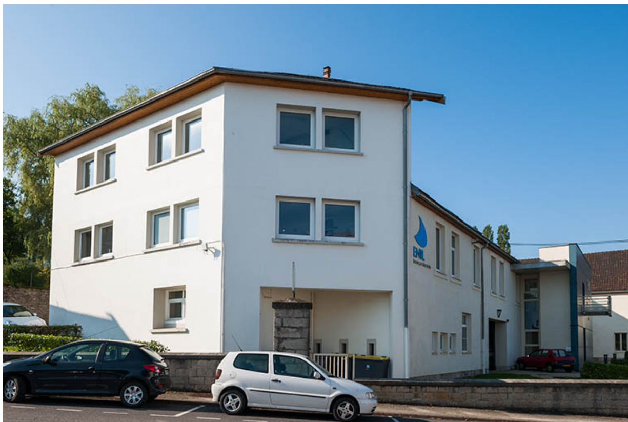
Pignon est du bâtiment d'administration et d'externat.
