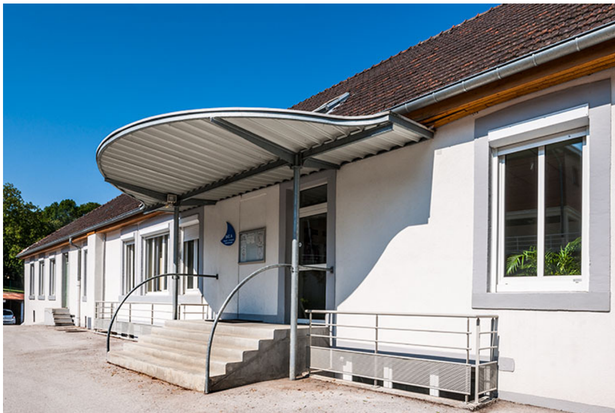
Détail de l'entrée postérieure du bâtiment d'externat.
