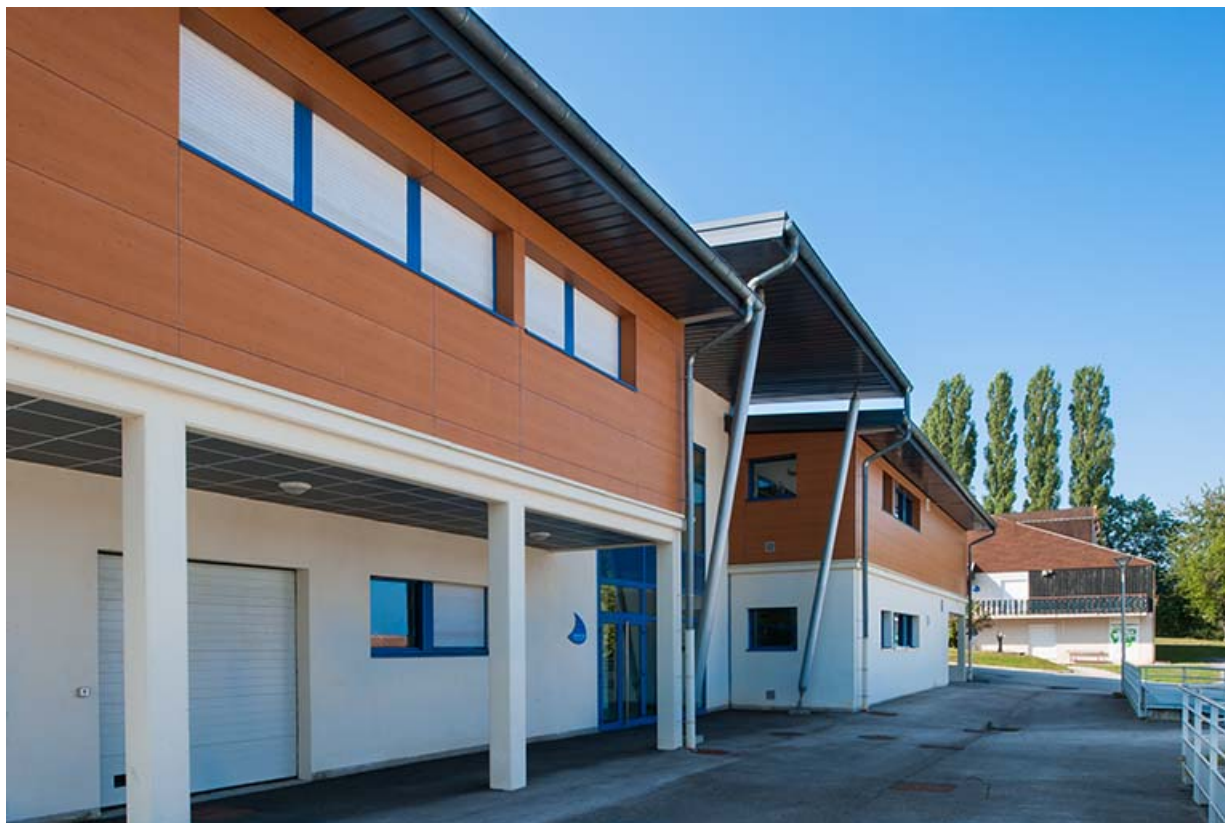
Depuis l'angle nord-est du bâtiment des salles de cours et laboratoires. 25, Mamirolle, 15 Grande Rue
