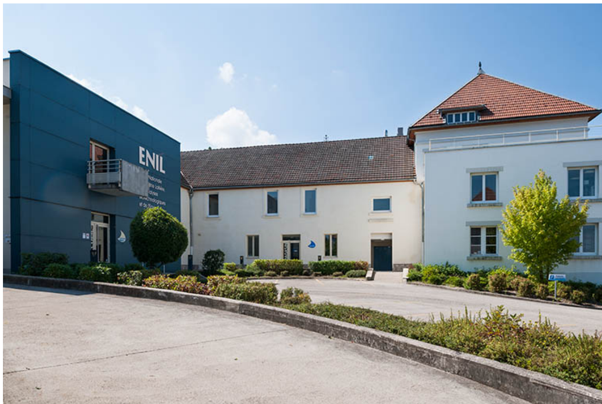
Cour, stationnement et pignon est du bâtiment d'administration et d'externat. 25, Mamirolle, 15 Grande Rue
