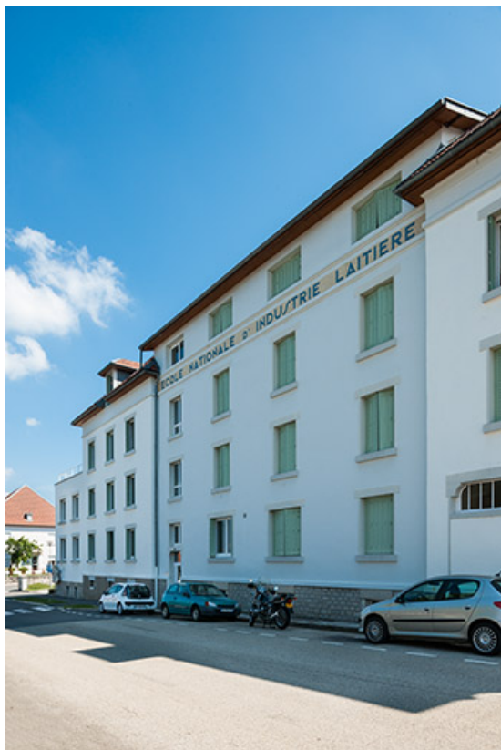
Détail de la façade sur rue du bâtiment d'administration et d'externat. 25, Mamirolle, 15 Grande Rue
