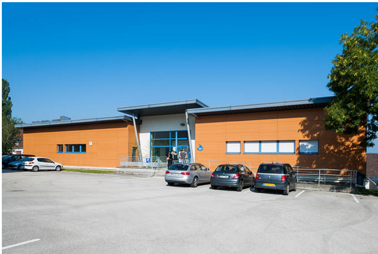
Entrée du bâtiment des salles de cours et laboratoires sur la façade sud-est. 25, Mamirolle, 15 Grande Rue
