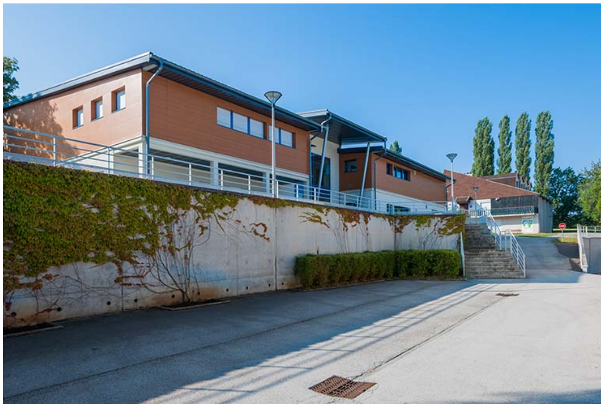
Cour et angle nord-est du bâtiment des salles de cours et laboratoires.
