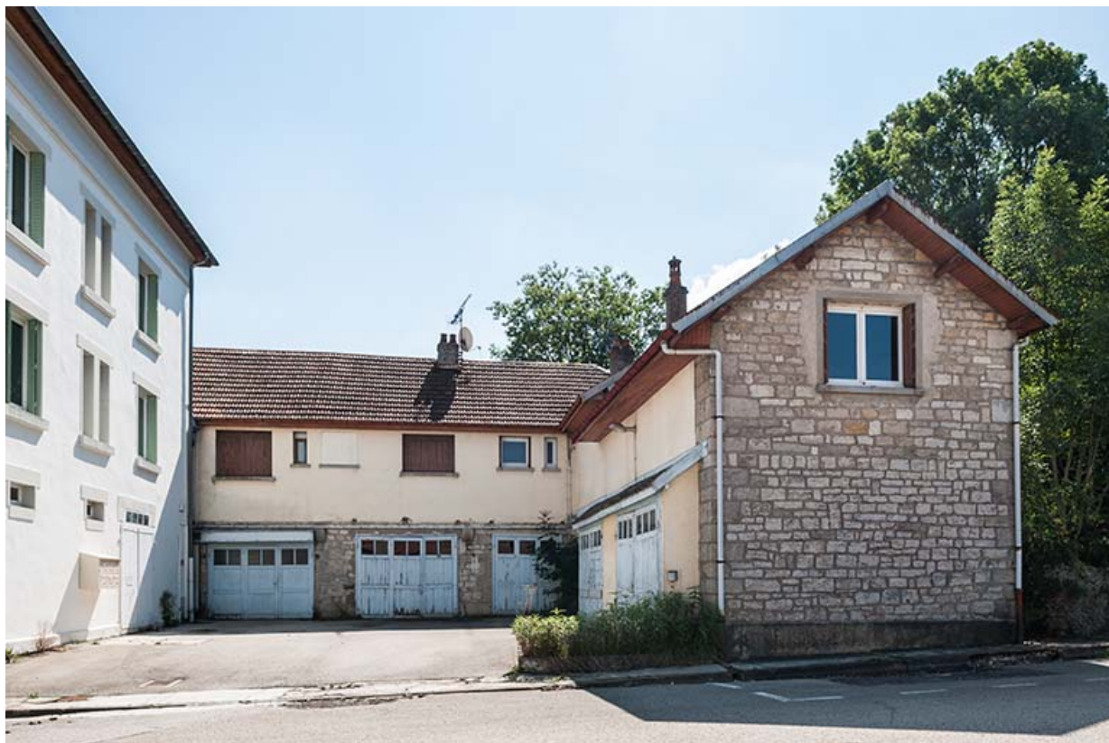
Pignon ouest du bâtiment d'administration et d'externat, garages et logement sur rue. 25, Mamirolle, 15 Grande Rue
