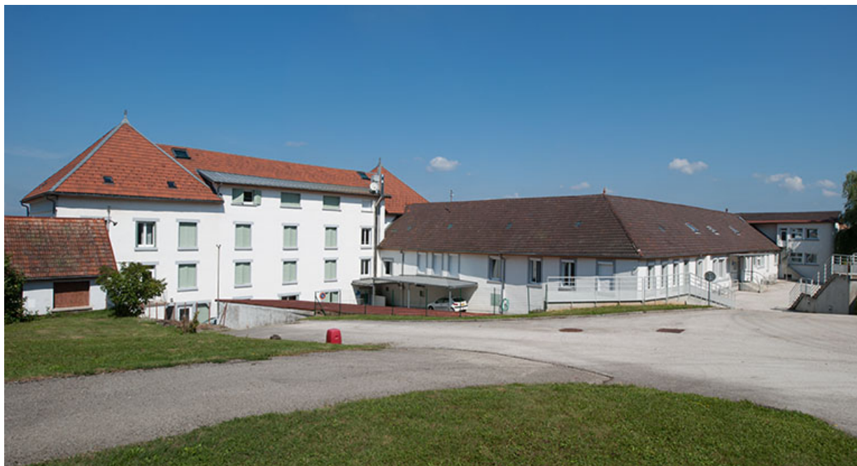
Cour et façade postérieure des bâtiments d'externat.
