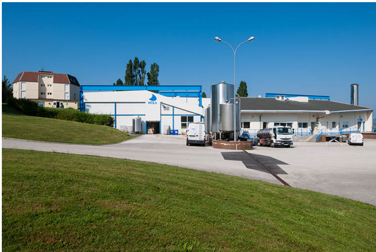
Façade est du hall des technologies laitières et agro-alimentaires. 25, Mamirolle, 15 Grande Rue
