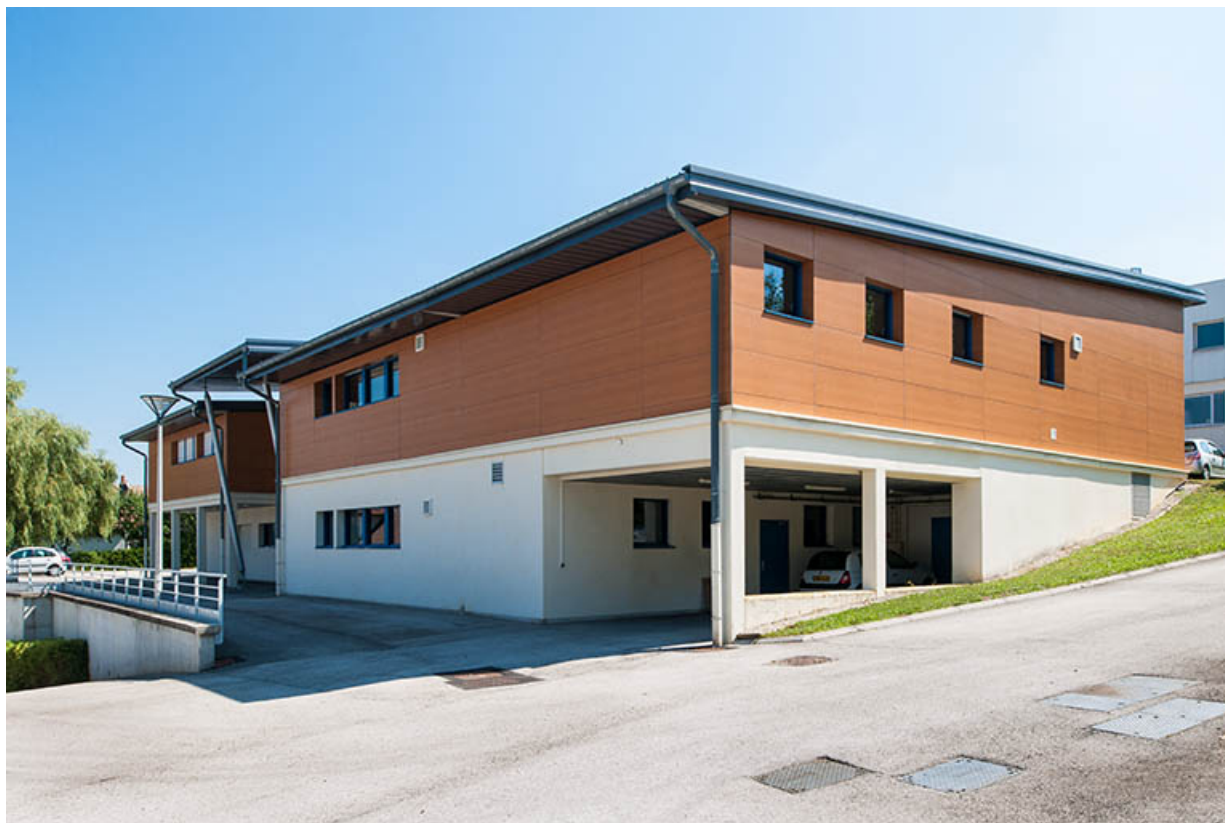
Angle ouest du bâtiment des salles de cours et laboratoires.
