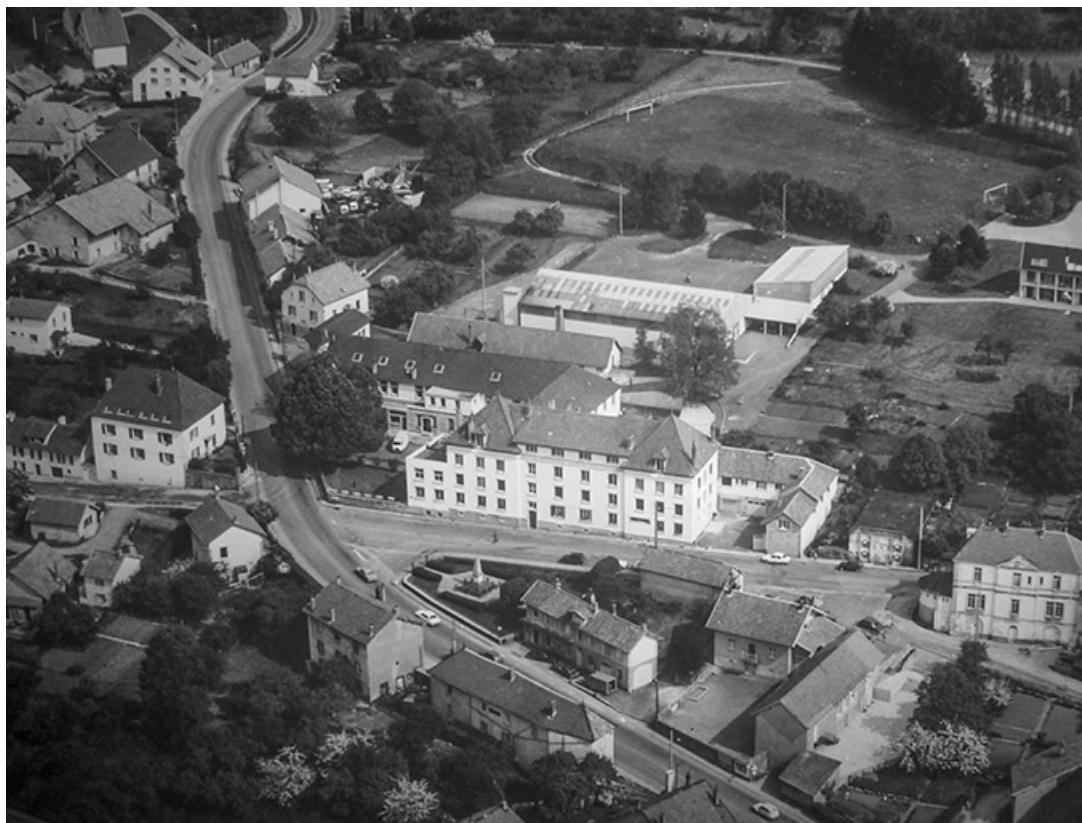
Vue aérienne du site avec notamment l'ancienne piscine et l'ancien gymnase (entre 1979 et 1989.) 25, Mamirolle, 15 Grande Rue
