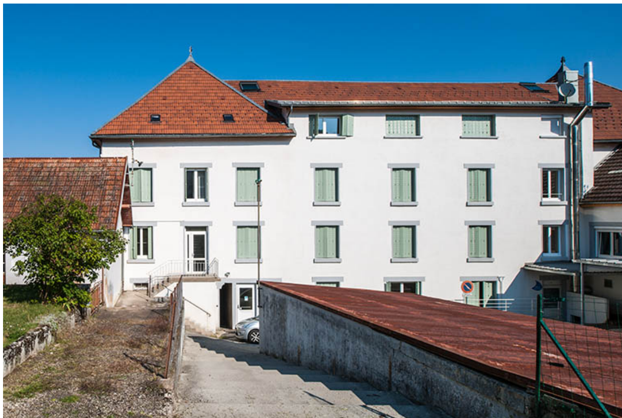
Cour, garages et façade postérieure du bâtiment d'administration et d'externat. 25, Mamirolle, 15 Grande Rue
