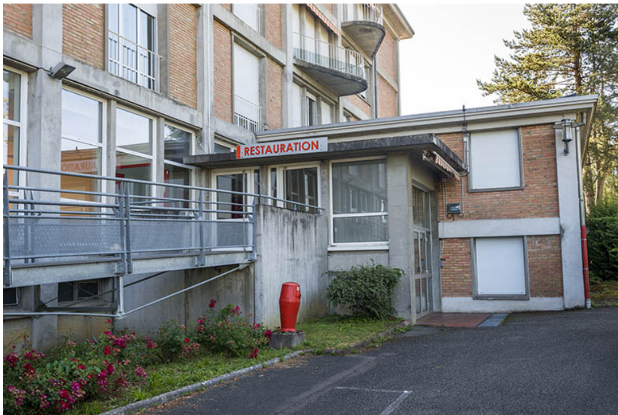
Entrée de la restauration sur la façade ouest du bâtiment d'internat, logement, restauration. (ex-Léger) 25, Audincourt, 6 rue René Girardot
