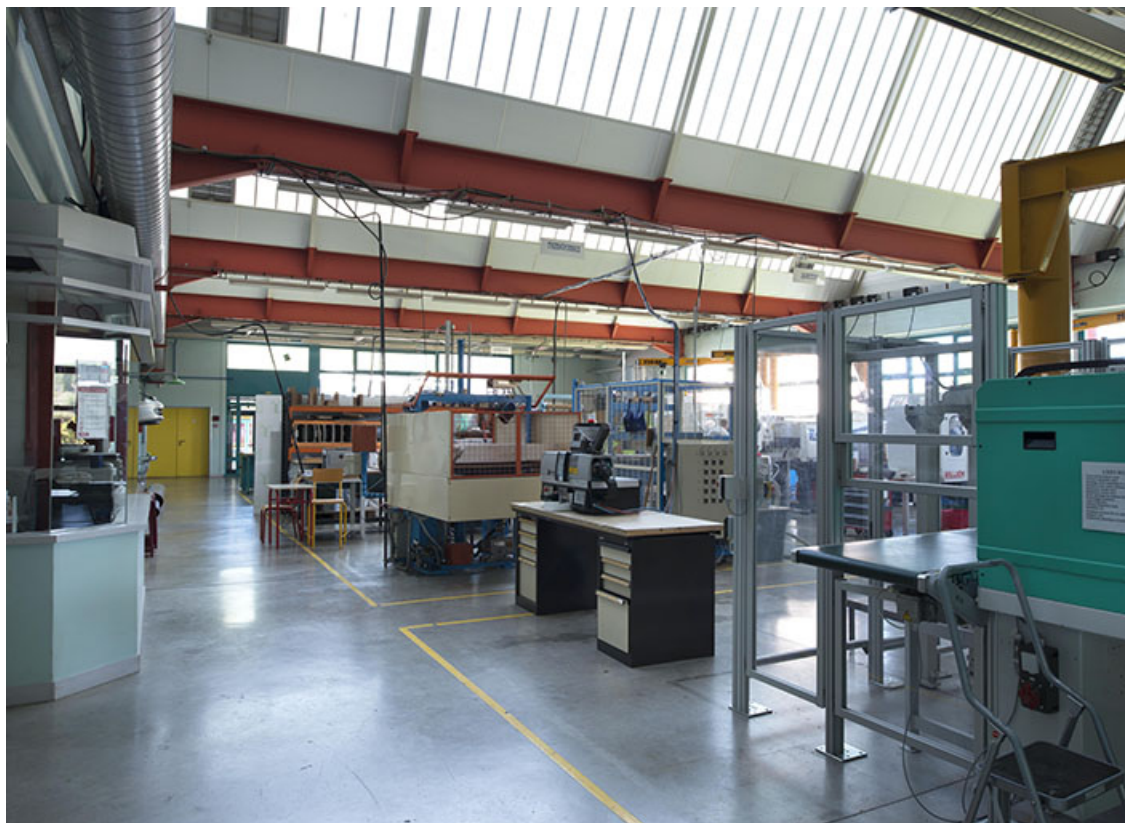
Détail d'atelier sous sheds. (ex.Léger)
