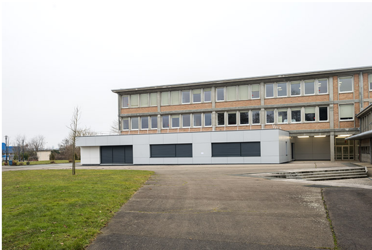
La cour, les façades antérieures et le préau de l'externat après les travaux. (ex-Léger)
