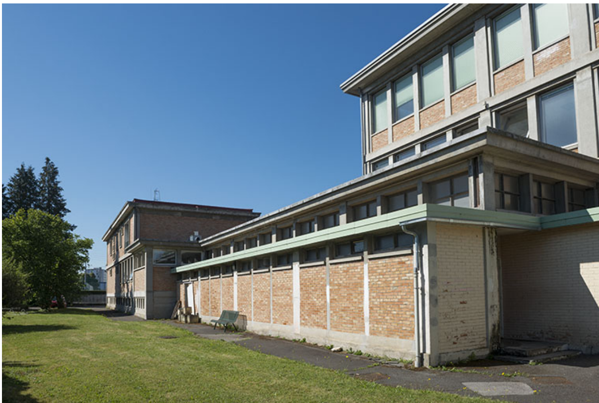
Angle nord est du bâtiment d'externat, transformateur, chaufferie (ex-Garnier). 25, Audincourt, 6 rue René Girardot
