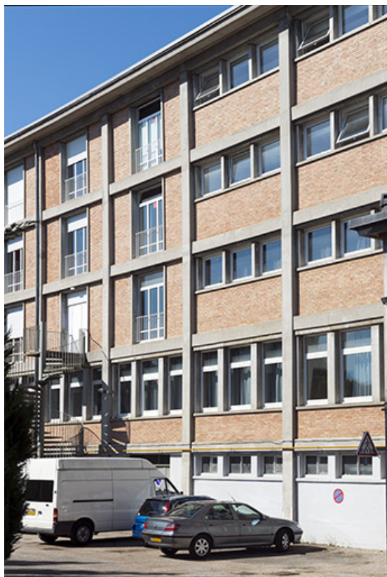
Détail de la façade postérieure du bâtiment d'internat, logement, restauration. (ex-Léger) 25, Audincourt, 6 rue René Girardot
