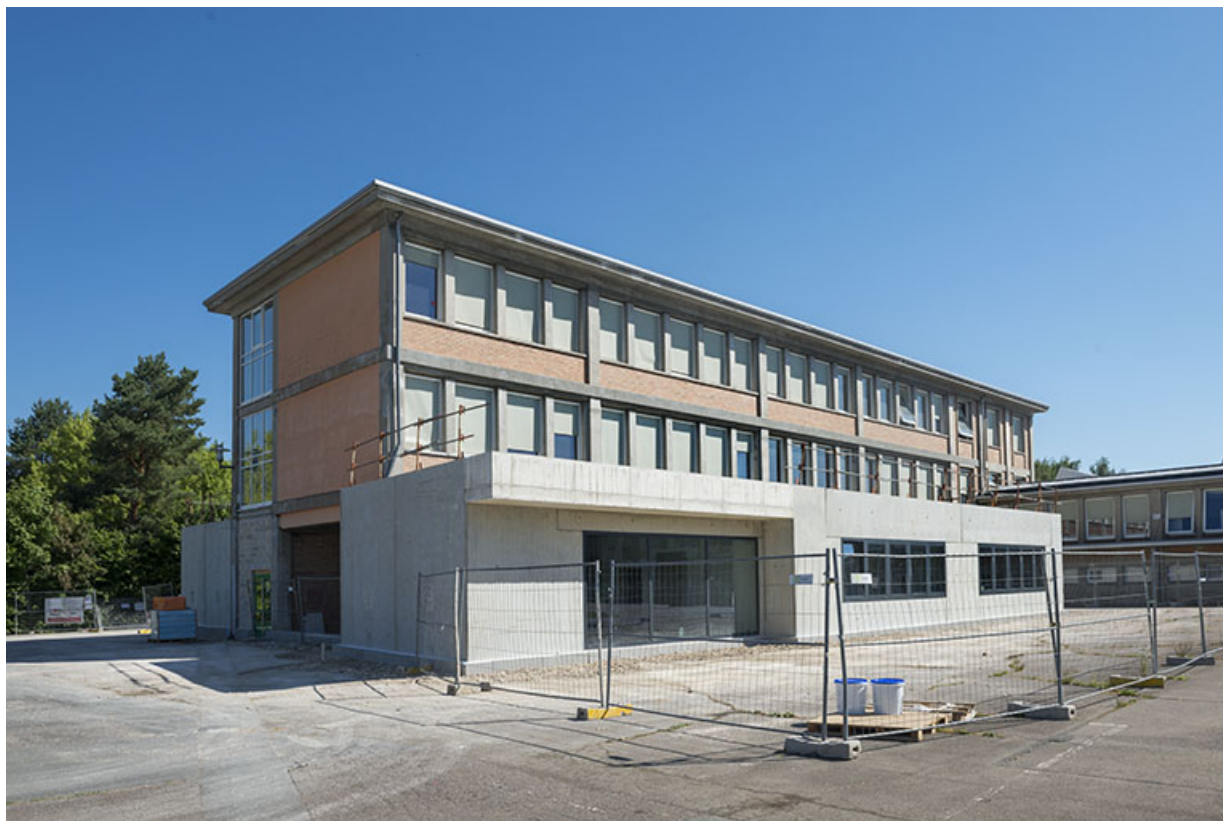
Pignon ouest et face antérieure de l'externat (ex-Léger) durant les travaux.
