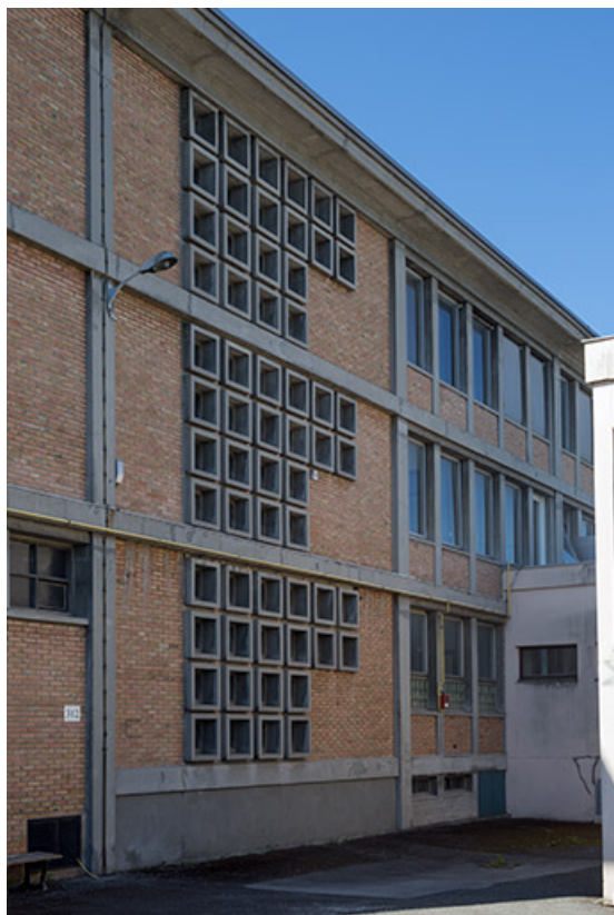
Détail de la façade nord du bâtiment d'externat.(ex-Garnier) 25, Audincourt, 6 rue René Girardot
