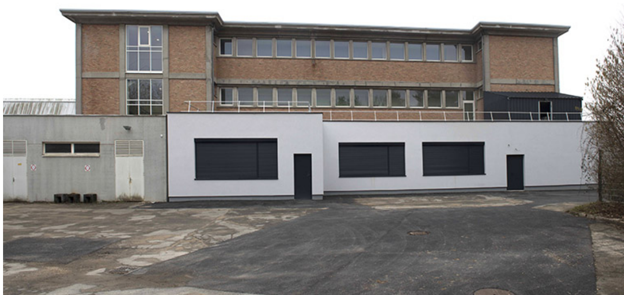
Façade postérieure nord de l'externat après les travaux. (ex-Léger) 25, Audincourt, 6 rue René Girardot
