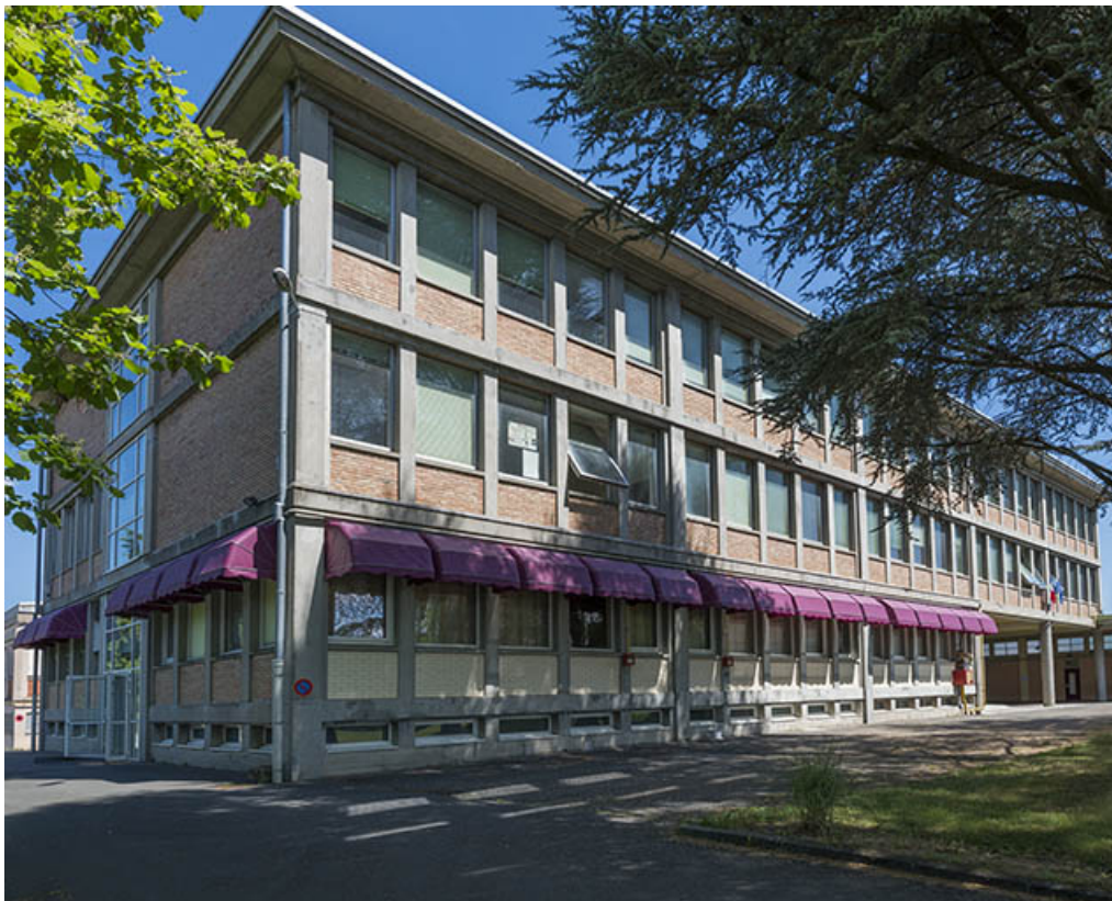
Façade antérieure et pignon ouest de l'externat restaurant d'application (ex Garnier) 25, Audincourt, 6 rue René Girardot
