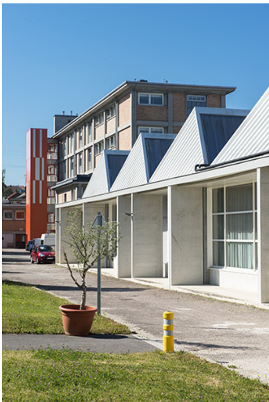
Façade postérieure est du bâtiment des ateliers et de l'administration. (ex-Léger) 25, Audincourt, 6 rue René Girardot
