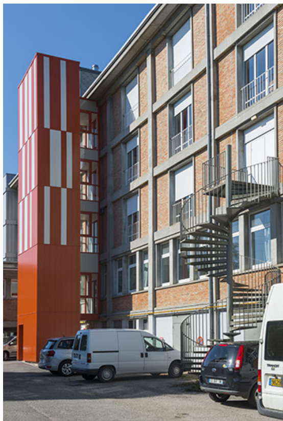
Détail de la face postérieure du bâtiment d'internat, logement, restauration. (ex-Léger) 25, Audincourt, 6 rue René Girardot
