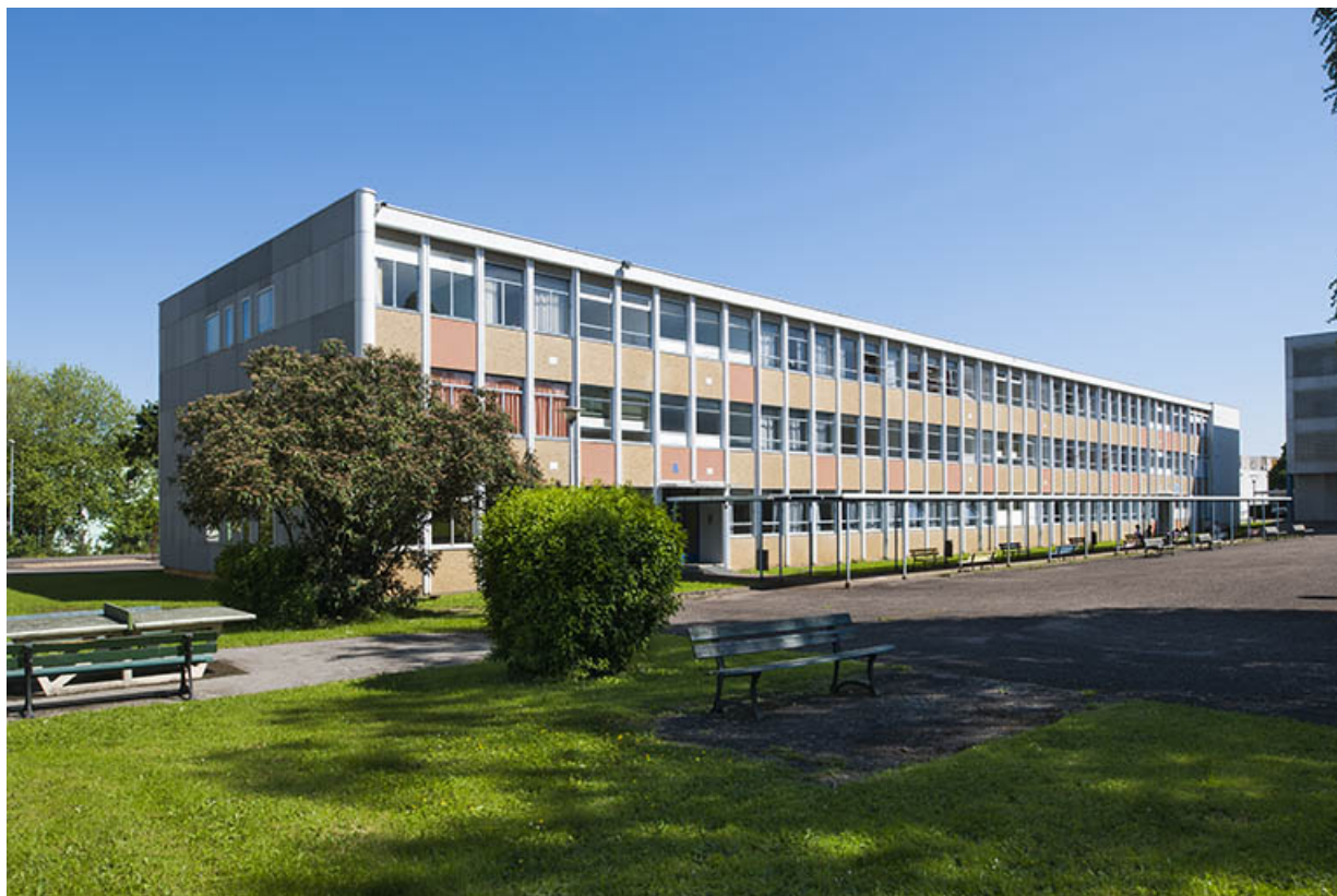
Pignon ouest et façade antérieure sud du bâtiment d'internat, externat, logements, infirmerie depuis la cour. 25, Besançon, 13 rue Goya
