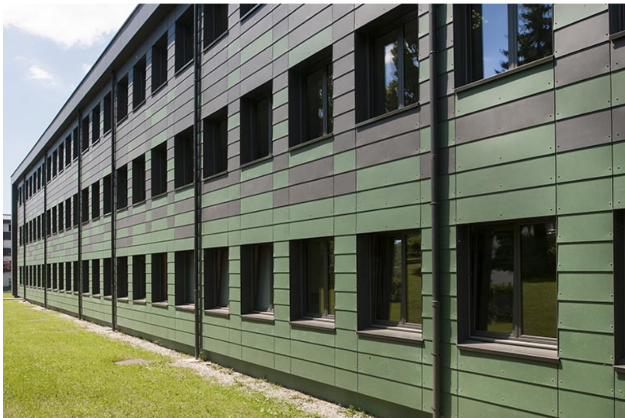
Détail de la façade sud et du pignon est de l'externat.
