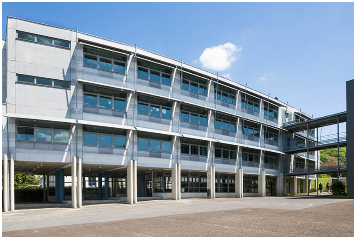
Façade ouest du bâtiment d'enseignement professionnel et passerelle. 25, Besançon, 13 rue Goya
