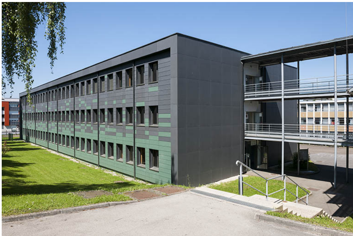
Façade sud et pignon est de l'externat.
