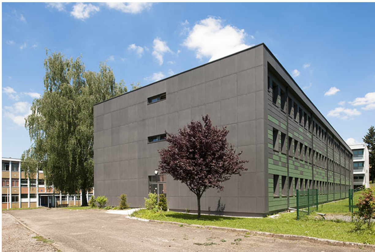
Façade sud et pignon ouest de l'externat.
