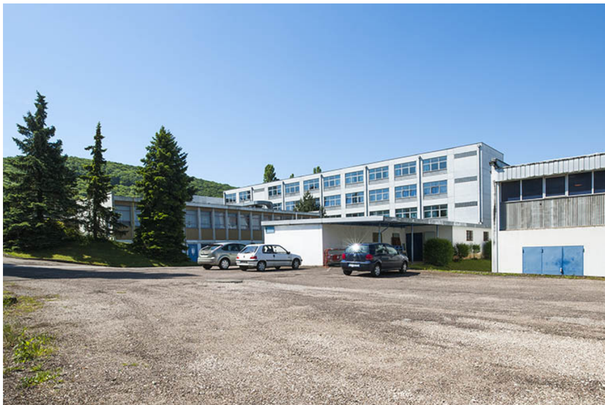
Vue d'ensemble depuis le nord-est sur le gymnase, le garage, la cantine et le bâtiment d'enseignement professionnel. 25, Besançon, 13 rue Goya
