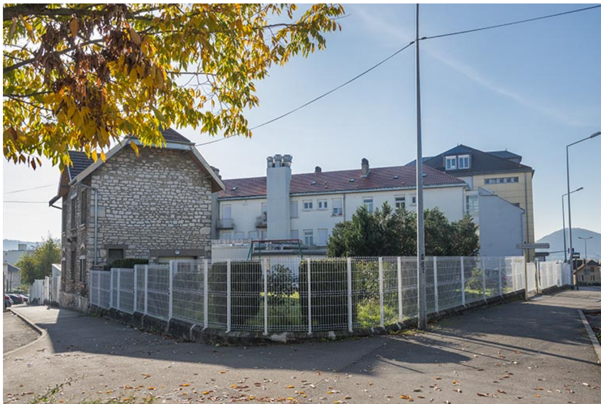
L'extrémité nord de la parcelle avec le pignon nord-ouest du logement.
