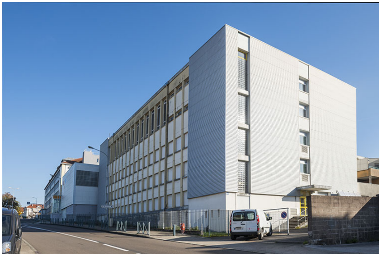
Les bâtiments le long de l'avenue Montjoux vus du sud.
