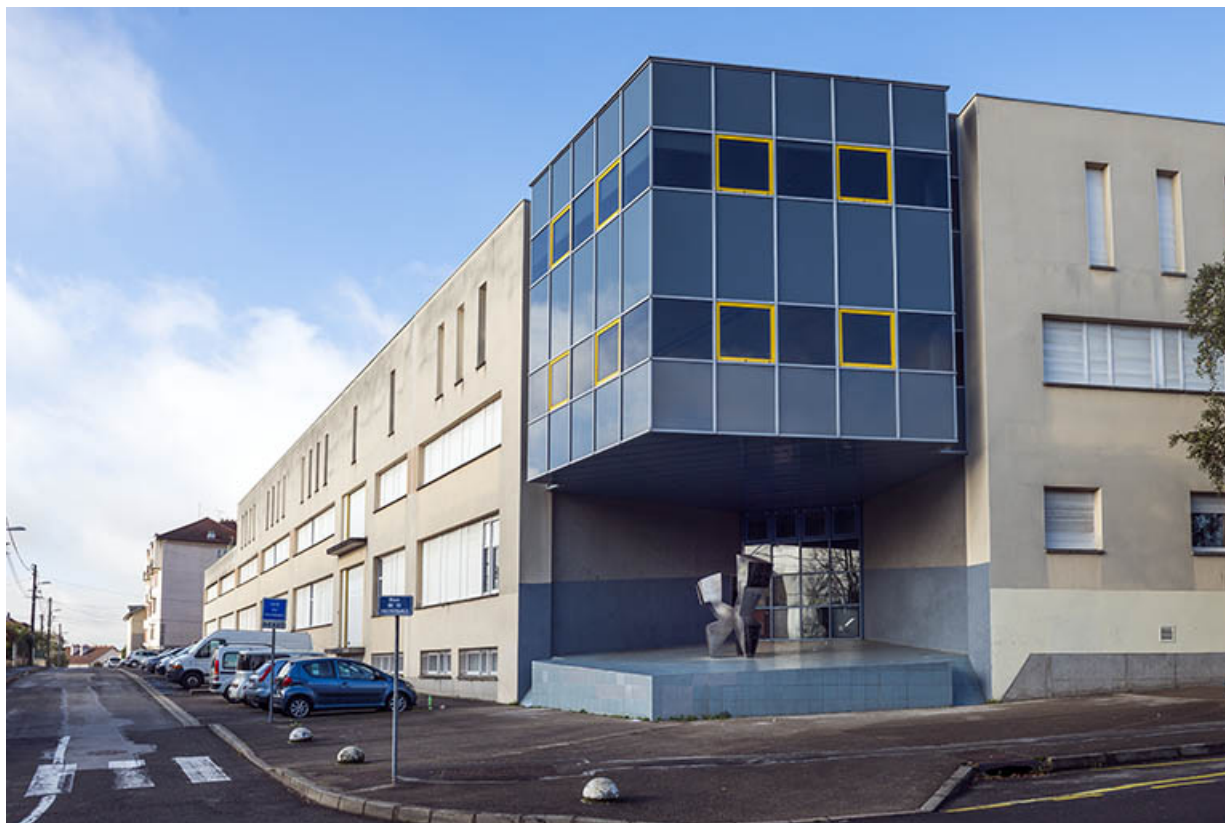
La sculpture et les façades sud-est du lycée rue de la prévoyance.
