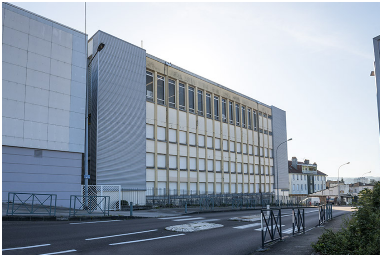
Façade du gymnase et des ateliers avenue Montjoux.
