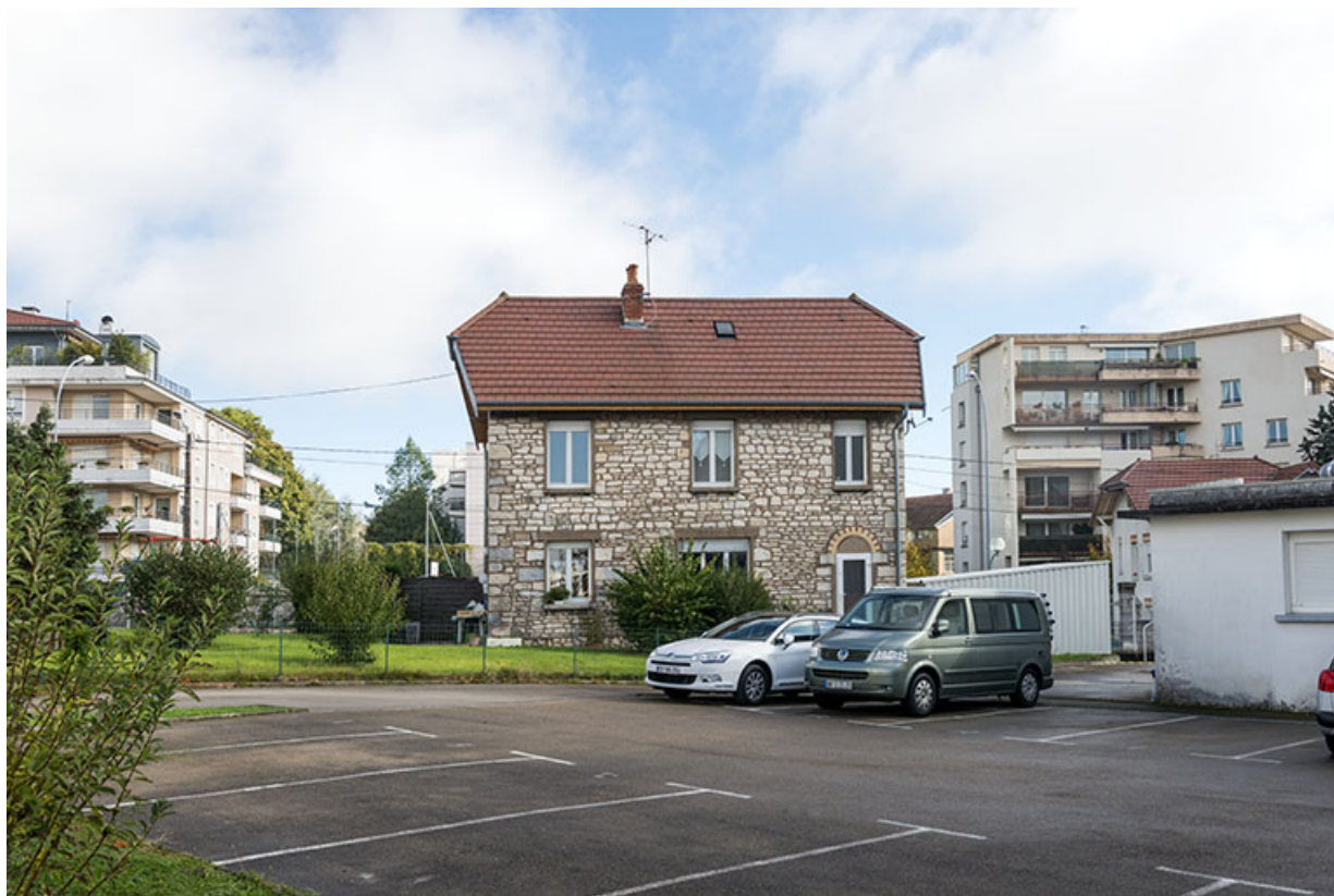
Aire de stationnement et façade intérieure sud du logement au nord.
