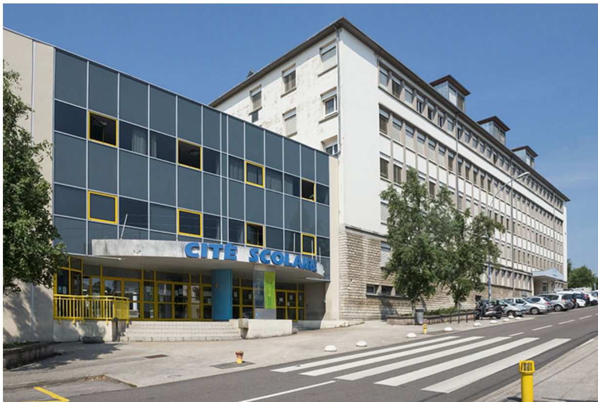
Entrée de la cité scolaire depuis l'avenue Marceau : bâtiment de l'administration.
