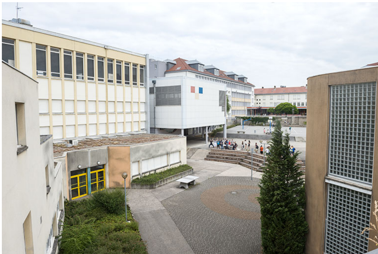
Depuis le sud, vue sur la cour et les bâtiments qui la bordent.
