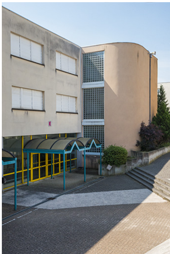
Détail de l'entrée du bâtiment d'administration et d'atelier.
