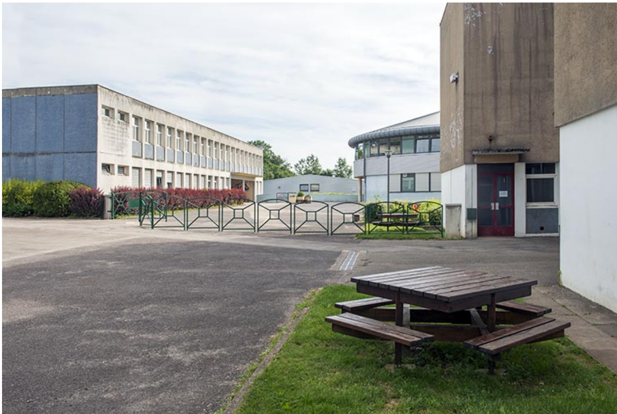
Cour devant l'entrée de l'internat-restauration.
