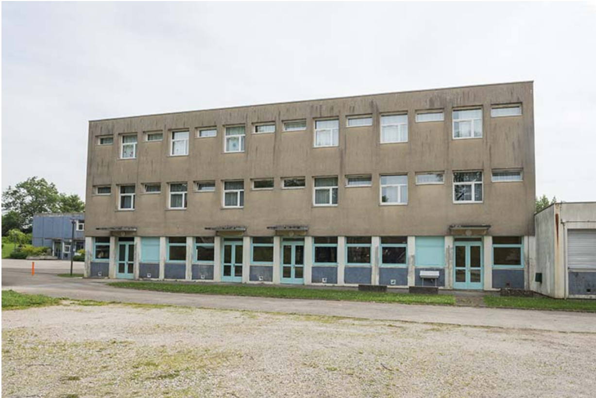
Façade sud-ouest de l'internat restauration.
