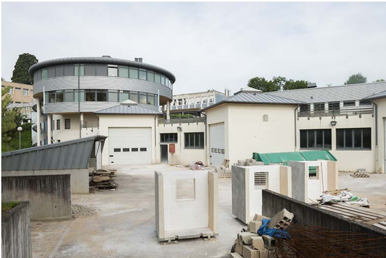
Vue sur la tour et les ateliers depuis l'est.
