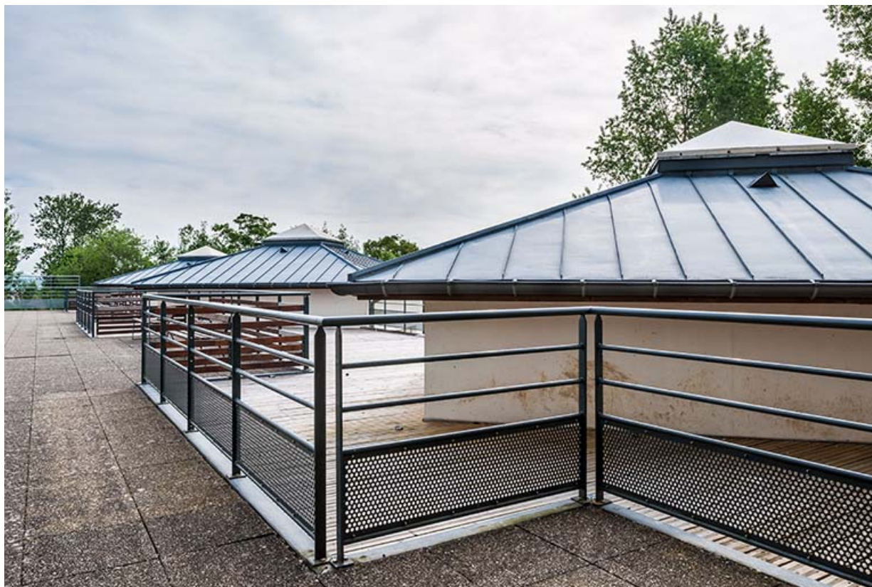
Terrasse et toiture des ateliers.
