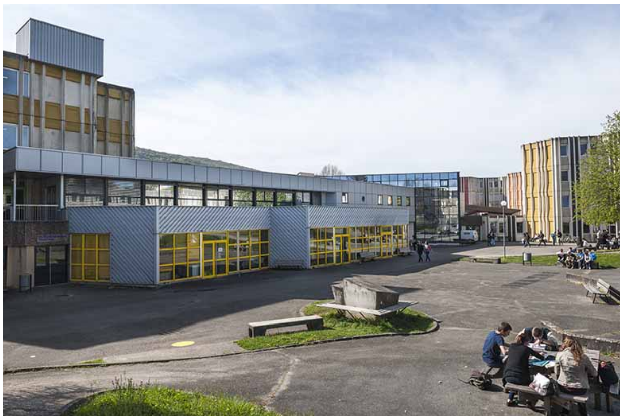
La cour, devant la façade de l'externat avec sa machinerie d'ascenseur. 25, Besançon, 1 rue Rembrandt
