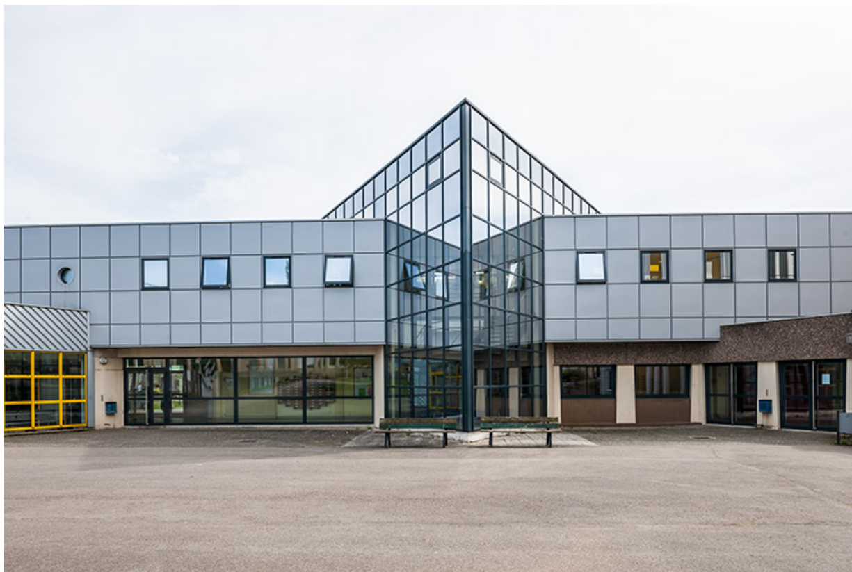
Face au bâtiment de l'administration et centre de documentation et d'information (cdi) à l'étage. 25, Besançon, 1 rue Rembrandt
