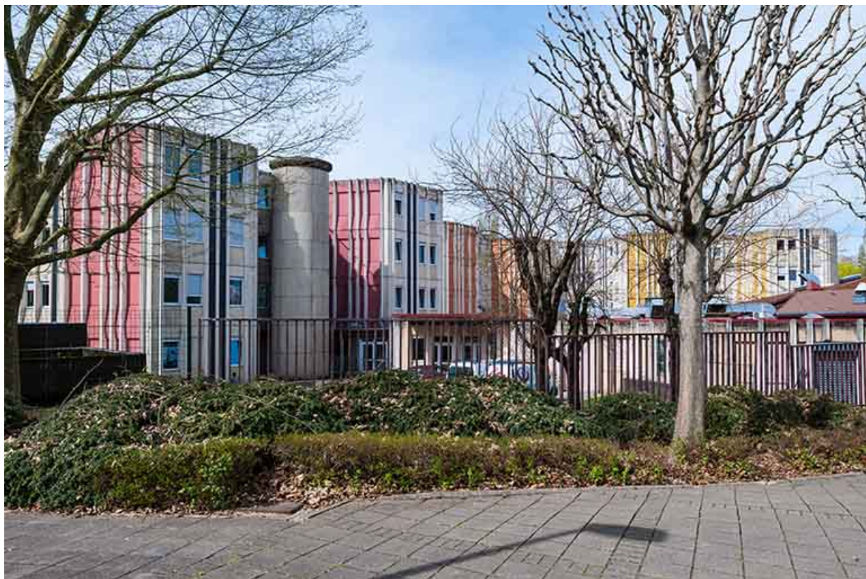
Les internats et la cantine, vus de l'extérieur, au sud.
