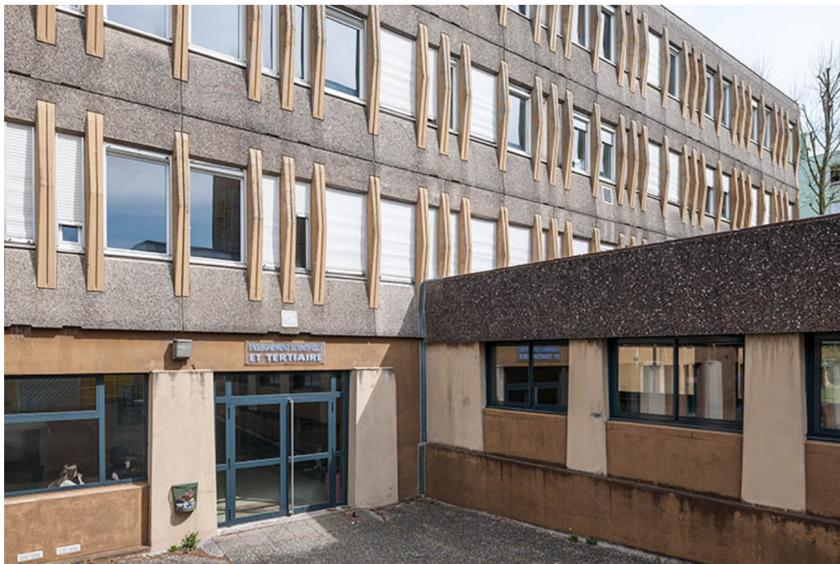
Façade sud-ouest et entrée sur cour de l'externat nord-est.
