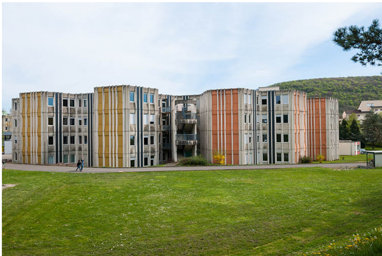
Vue d'ensemble des façades postérieures de l'internat.
