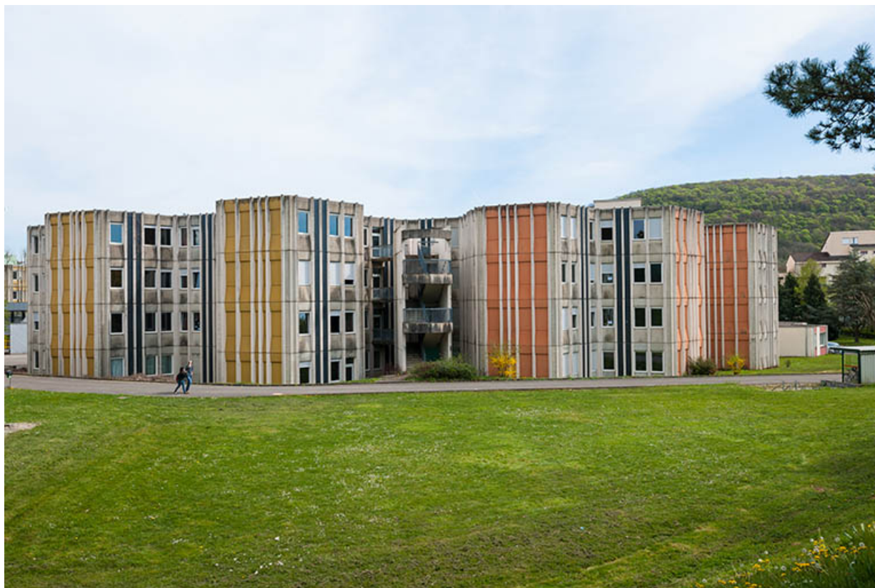
Vue d'ensemble des façades postérieures de l'internat.
