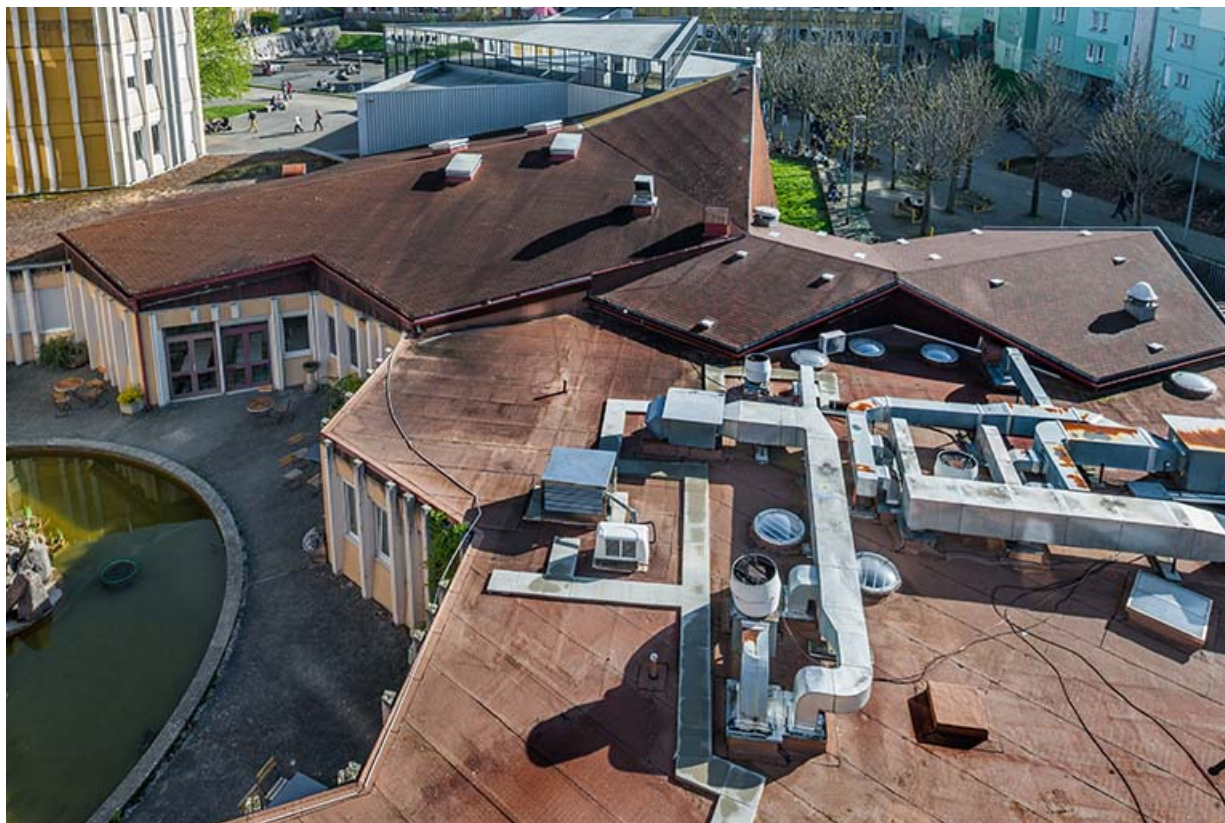
Bassin, toitures de l'entrée, de l'administration et du centre de documentation et d'information. 25, Besançon, 1 rue Rembrandt
