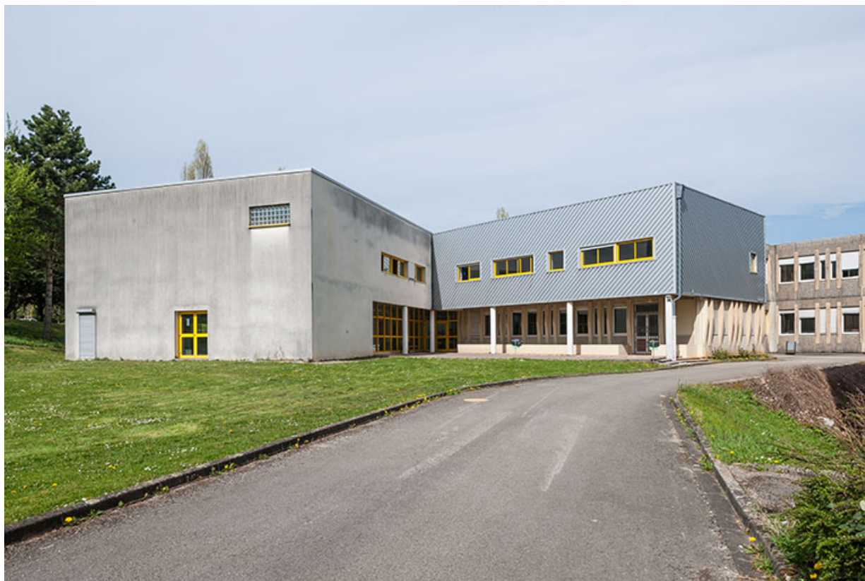
Pignon ouest et façade antérieure sur cours de l'externat ouest.
