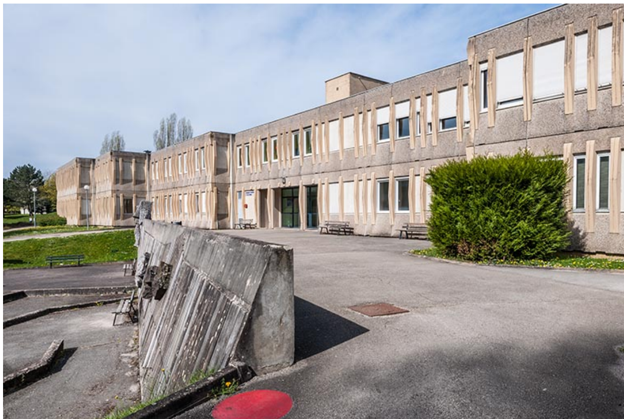
Depuis l'est, vue de profil de l'oeuvre de Jean Gilles et des façades sud des ateliers-externats. 25, Besançon, 1 rue Rembrandt
