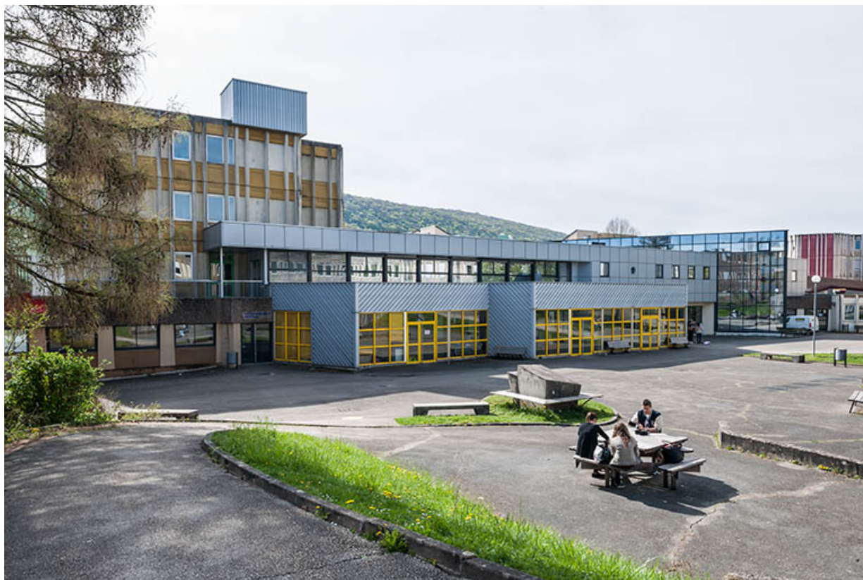
Face nord-est du bâtiment d'externat avec sa machinerie d'ascenseur. 25, Besançon, 1 rue Rembrandt
