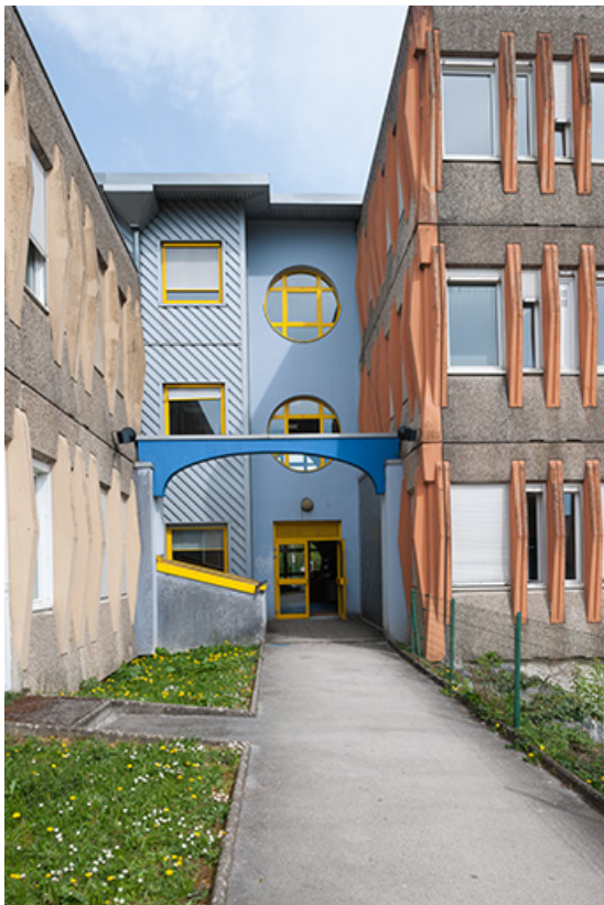
Au nord-est de la cour, l'entrée du bâtiment des classes préparatoires aux grandes écoles. 25, Besançon, 1 rue Rembrandt
