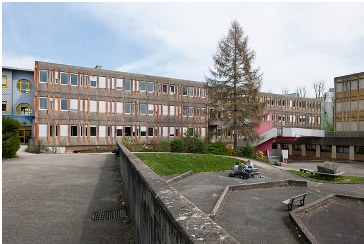
Depuis l'ouest, vue des bâtiments bordant la cour au nord-est.
