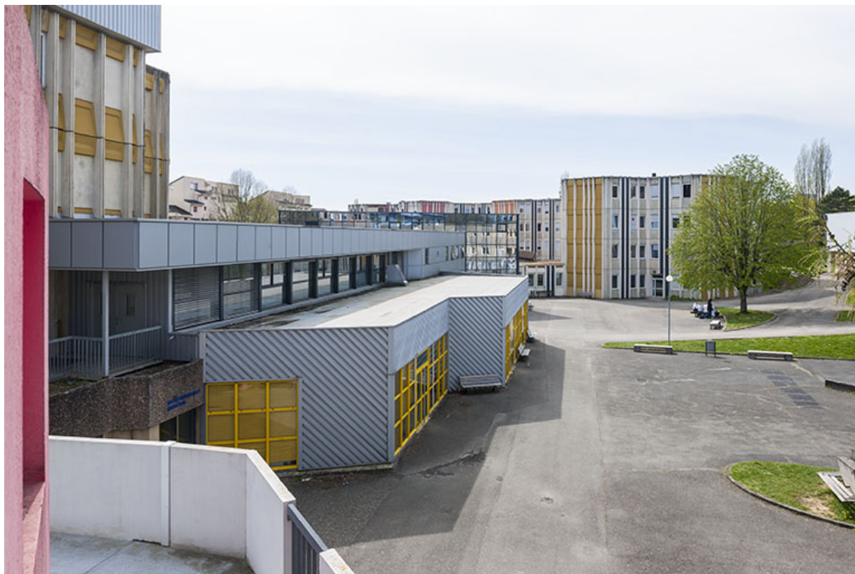
Depuis le nord-est, vue de profil des bâtiments bordant la cour au sud-est. 25, Besançon, 1 rue Rembrandt
