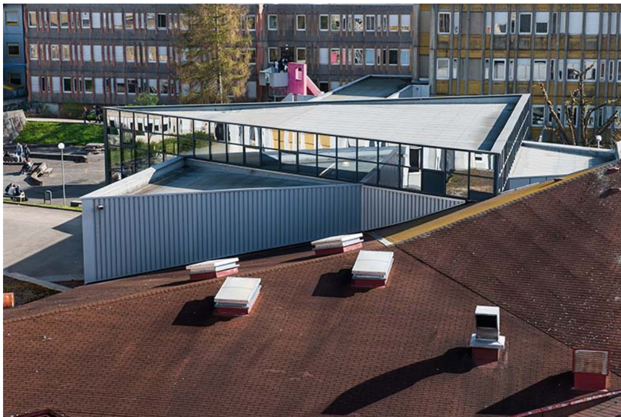
Vue sur la toiture du bâtiment d'entrée depuis l'ouest.
