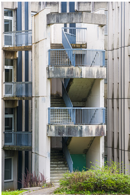
Détail de l'escalier extérieur de l'internat.
