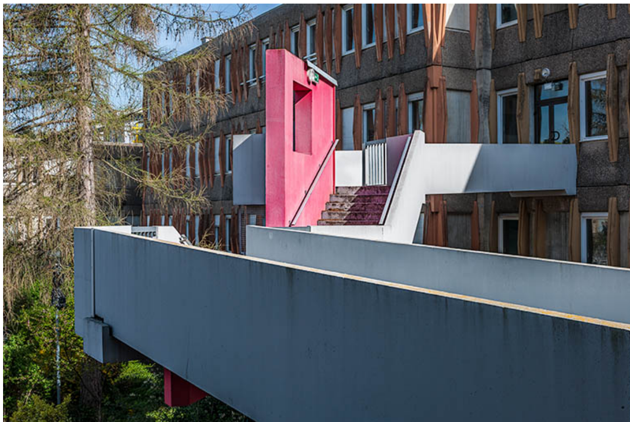
Détail de la passerelle et escalier devant l'externat d'enseignement scientifique et tertiaire. 25, Besançon, 1 rue Rembrandt
