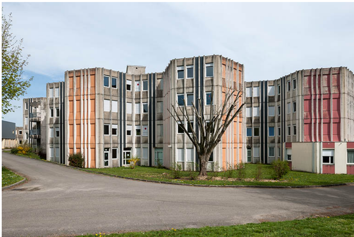
Les façades ouest de l'internat.
