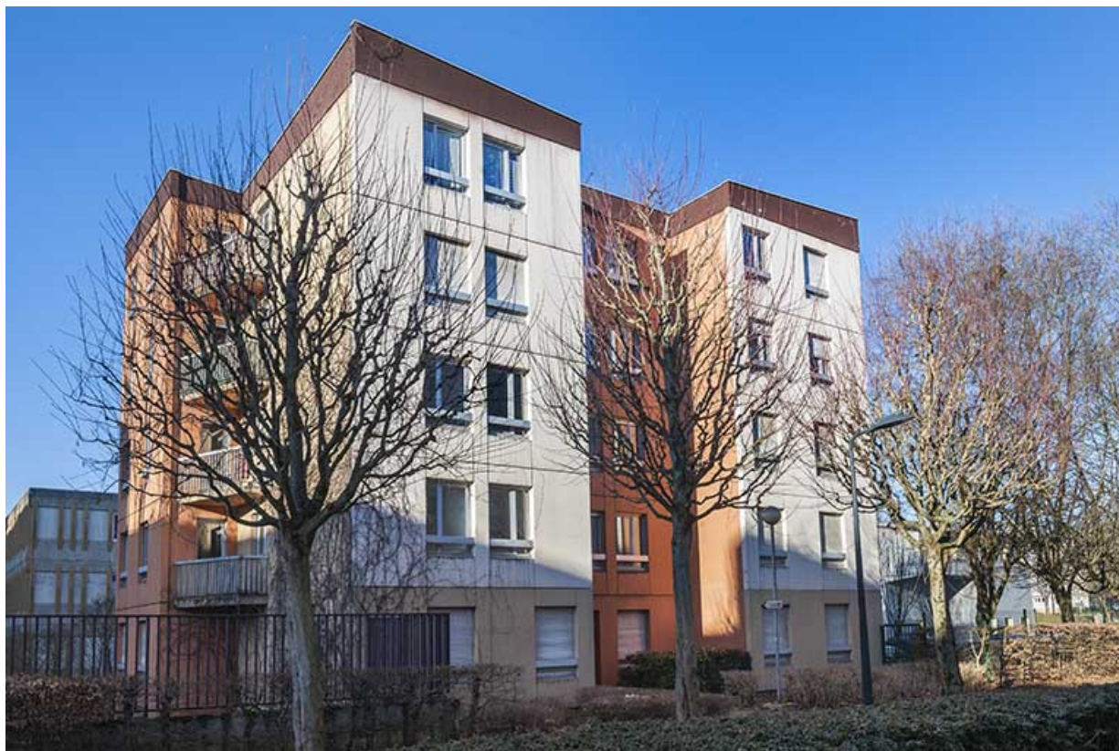
Angle est des logements et façades nord-est sur la rue Auguste Renoir. 25, Besançon, 1 rue Rembrandt
