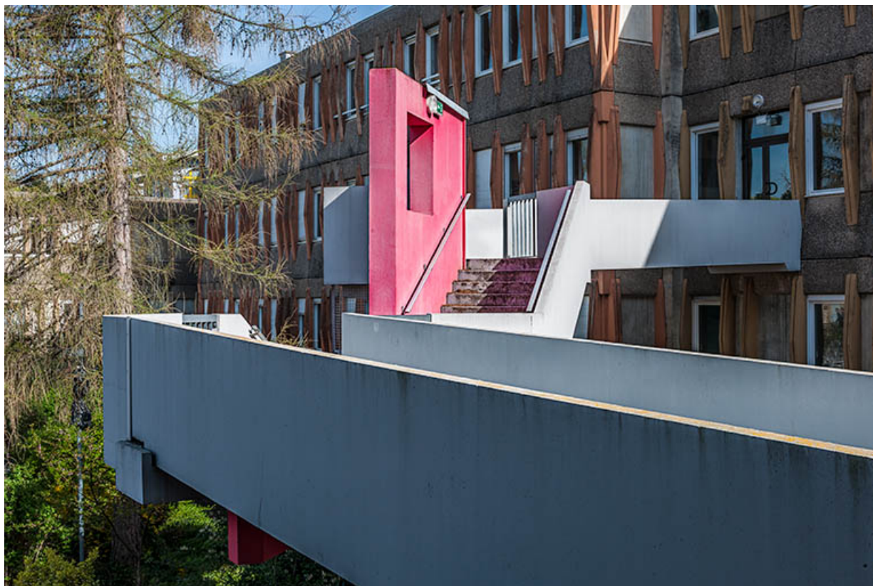
Détail de la passerelle et escalier devant l'externat d'enseignement scientifique et tertiaire. 25, Besançon, 1 rue Rembrandt
