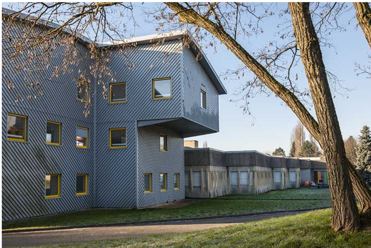
Façades postérieures nord-ouest des ateliers et des classes préparatoires aux grandes écoles. 25, Besançon, 1 rue Rembrandt
