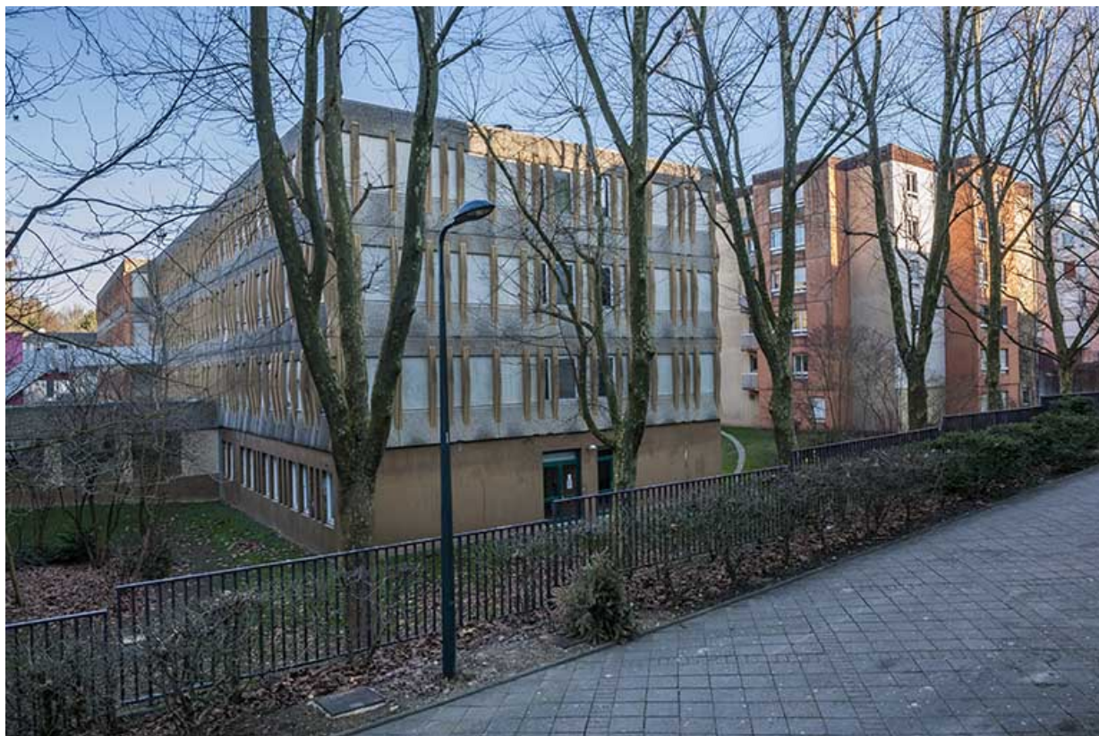
Vues sur le pignon sud-est de l'externat depuis la rue Rembrandt 25, Besançon, 1 rue Rembrandt
