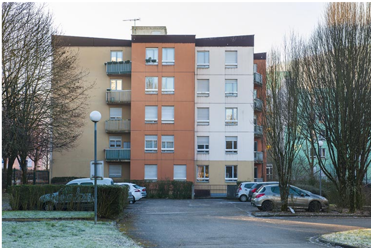
Les logements : façade nord-ouest.
