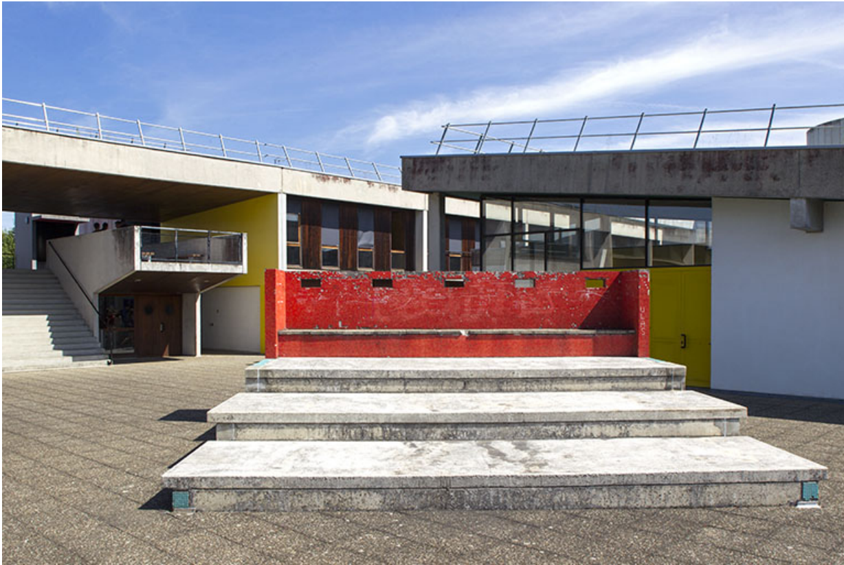
Détail de la terrasse devant la cantine au sud-ouest de l'ensemble.
