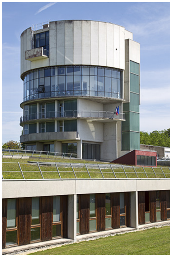
La tour et détail des façades sud de l'externat. 25, Besançon, 14 rue Alain Savary, lieudit : Temis
