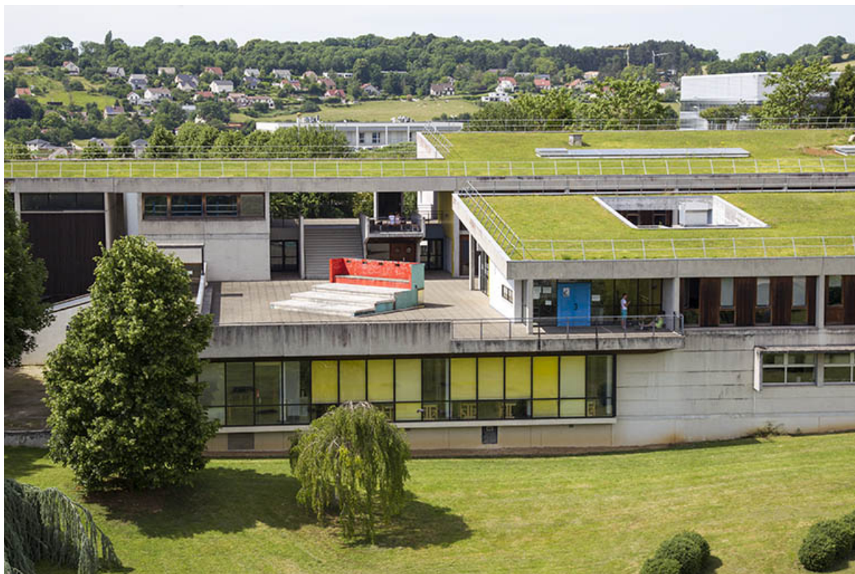
Détail des façades antérieures (sud) et des terrasses, devant la cantine, à l'ouest de l'ensemble. 25, Besançon, 14 rue Alain Savary, lieudit : Temis
