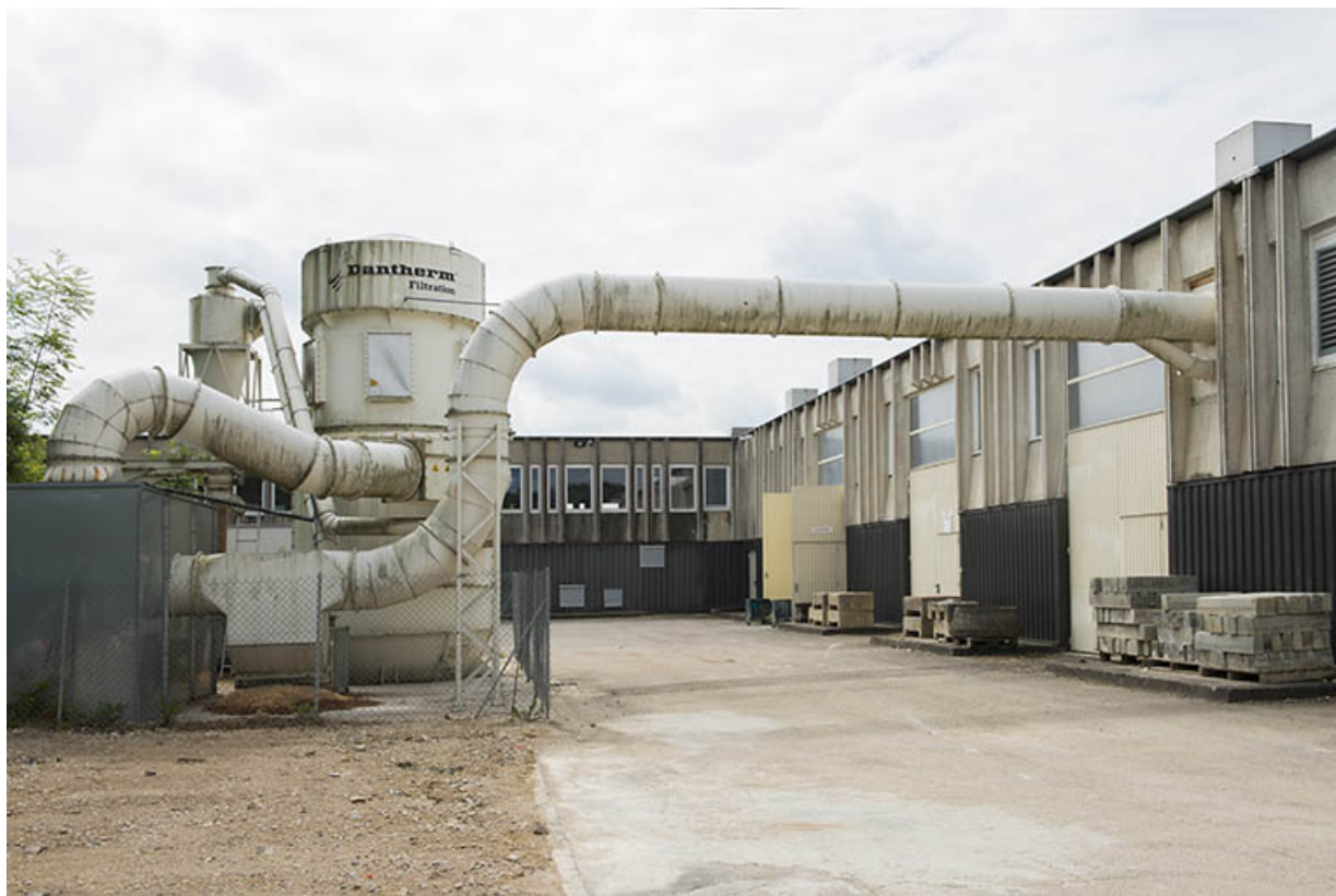
Angle de la façade postérieure nord-est de l'externat avec son aile nord-est. 25, Besançon, 8 rue Mercator
