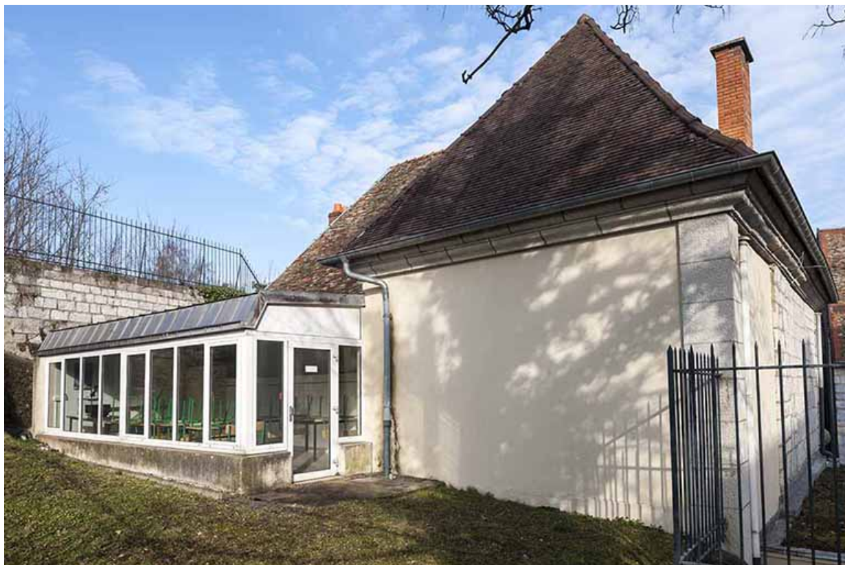
Façade sud de l'ancien corps de garde : ancien restaurant d'application. 25, Besançon, 5 place Marulaz
