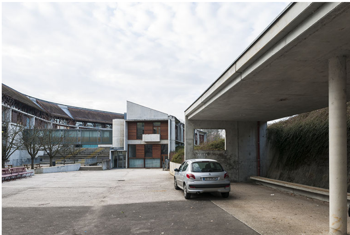
La cour, la passerelle et le pignon nord du restaurant d'application vues depuis le nord. 25, Besançon, 5 place Marulaz
