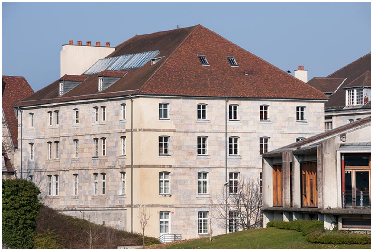
Pavillon des officiers ouest, vu depuis le sud-ouest.
