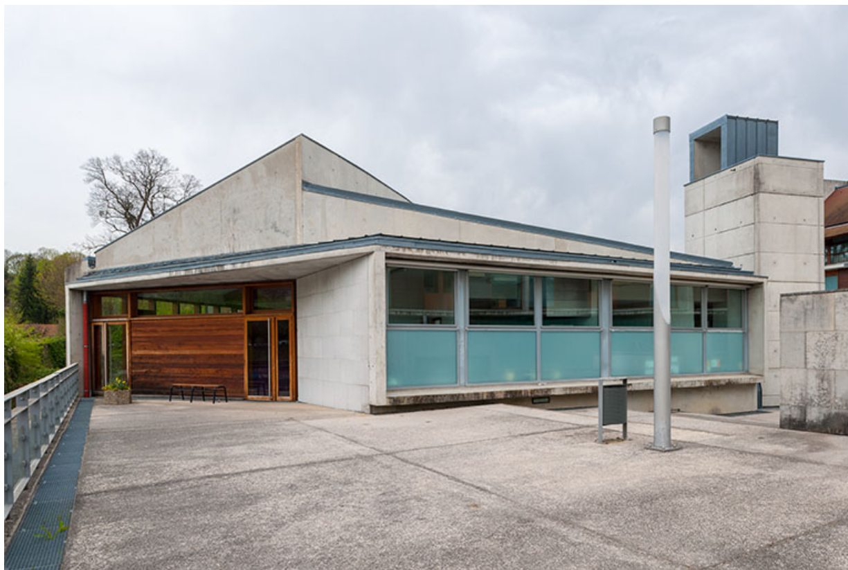
Façade sud-ouest du restaurant d'application.
