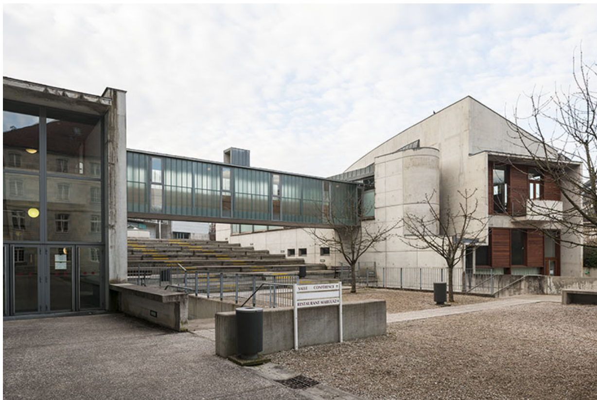
Vue de la cour, de la passerelle et du pignon nord du restaurant d'application depuis le nord-est. 25, Besançon, 5 place Marulaz
