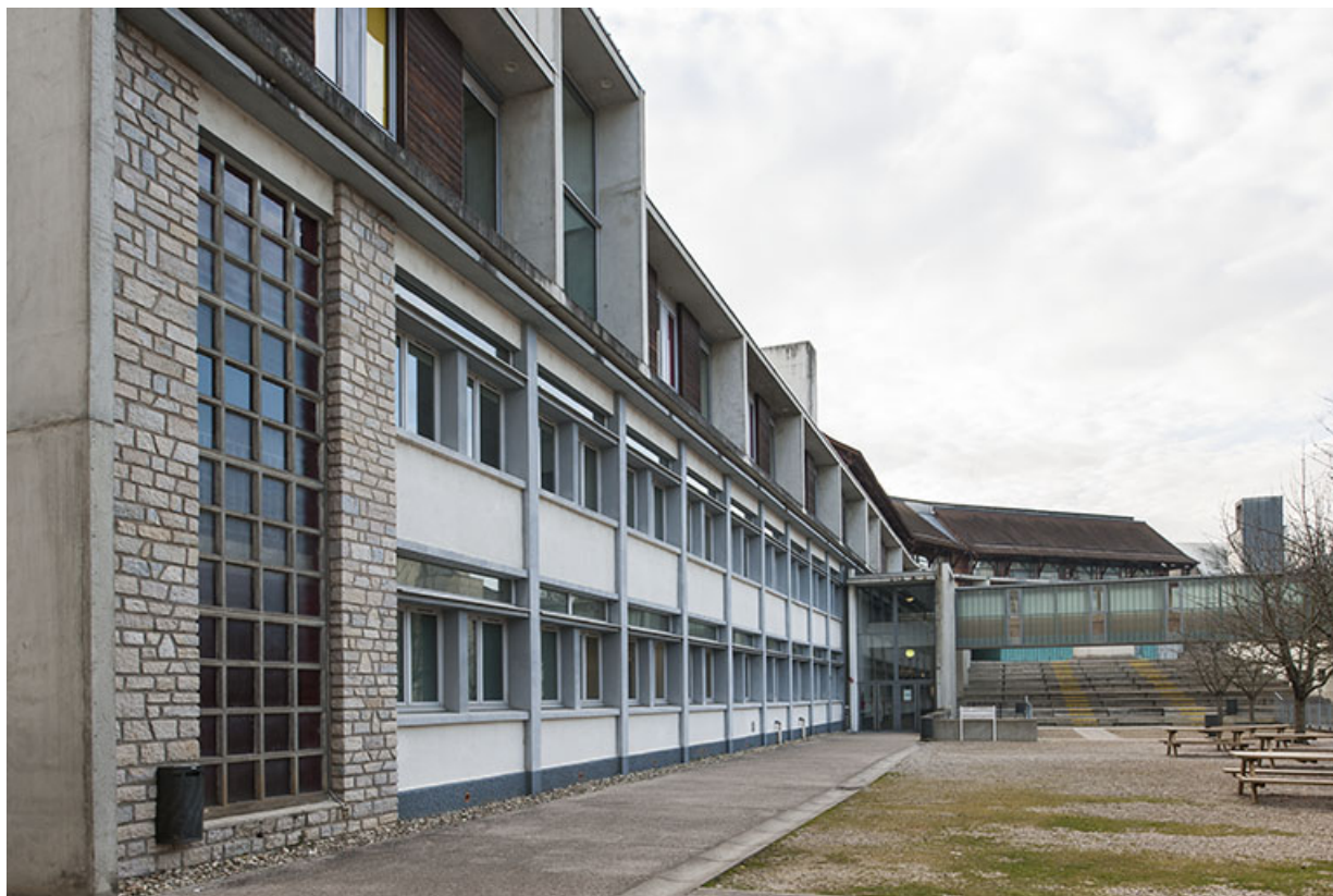
Détail de la façade ouest sur cour de l'externat.
