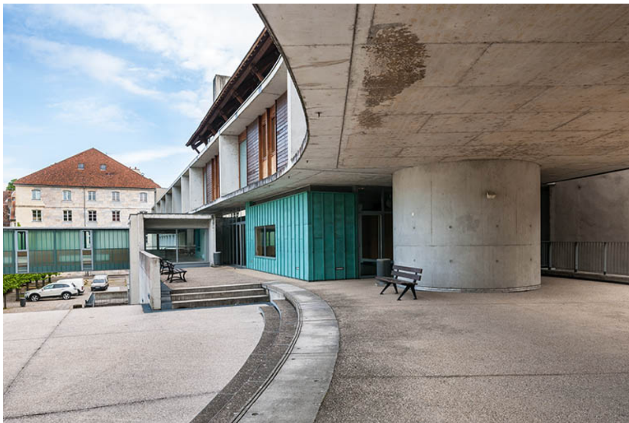
Vue depuis le sud, sous l'internat de filles.
