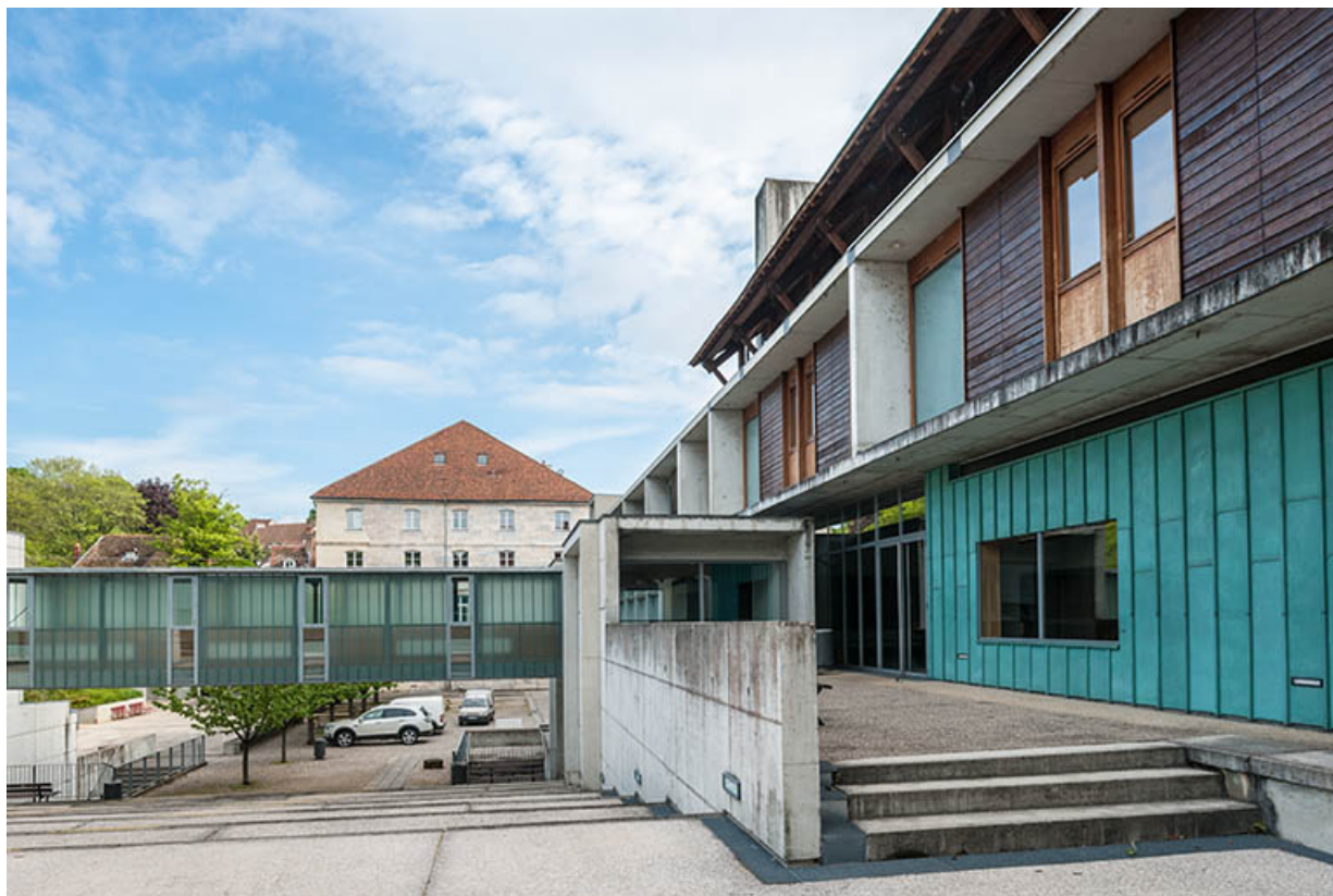
Depuis le sud, vue sur la passerelle reliant le restaurant d'application à l'externat. 25, Besançon, 5 place Marulaz
