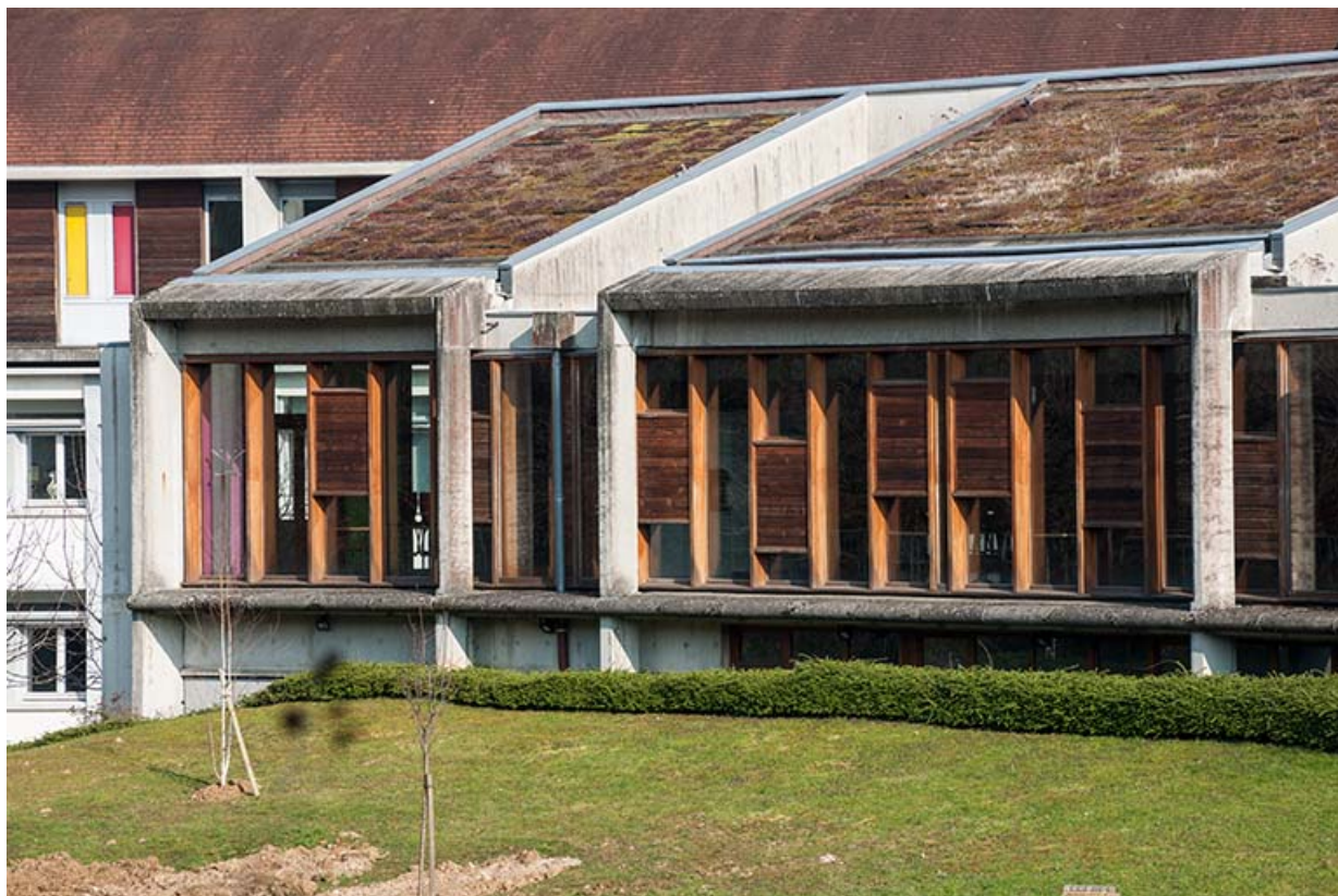
Détail des façades ouest et toitures du restaurant d'application.
