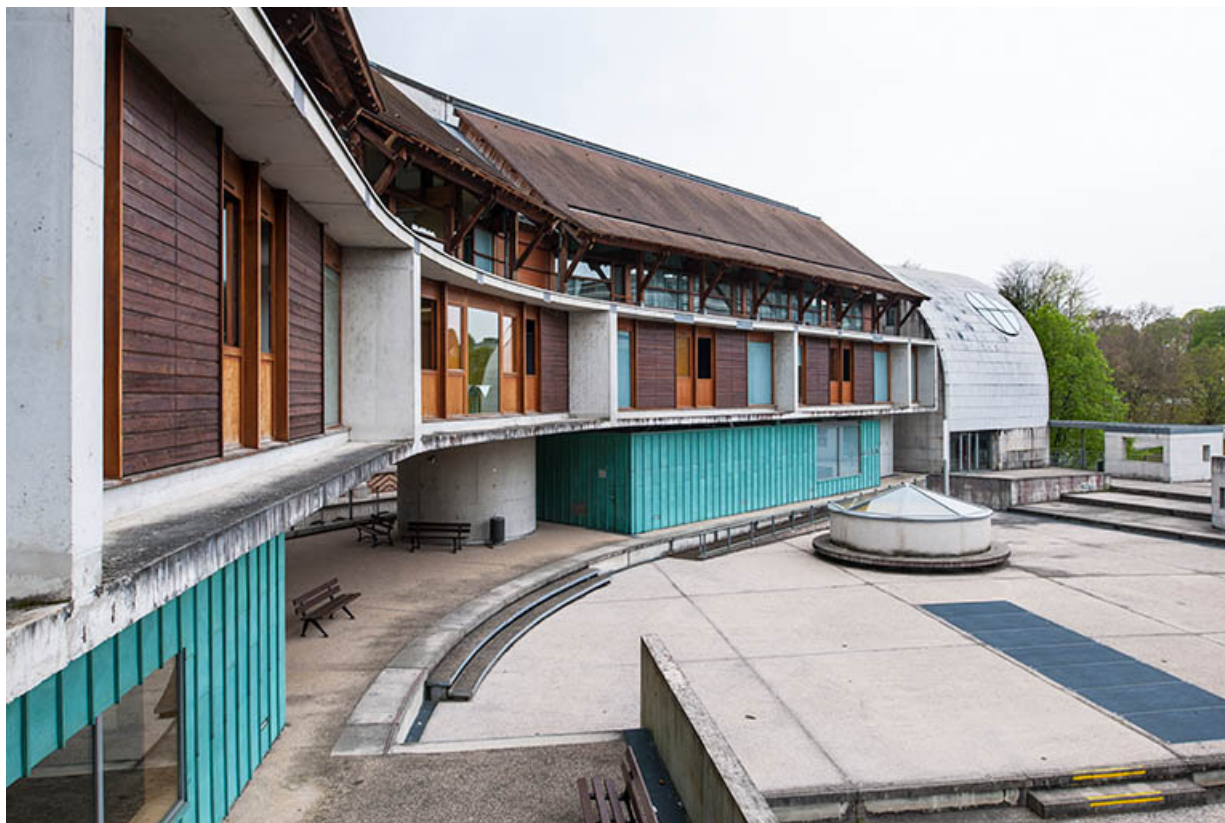
Cour au dessus du gymnase, devant les façades antérieures de l'externat et de l'internat des filles. 25, Besançon, 5 place Marulaz
