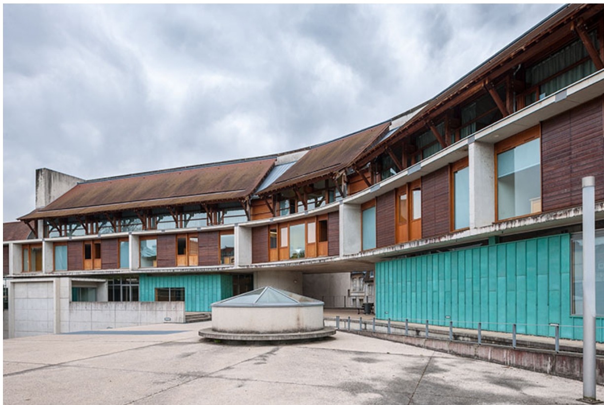
Vue du sud, la cour au dessus du gymnase, devant les façades antérieures de l'externat et de l'internat des filles. 25, Besançon, 5 place Marulaz
