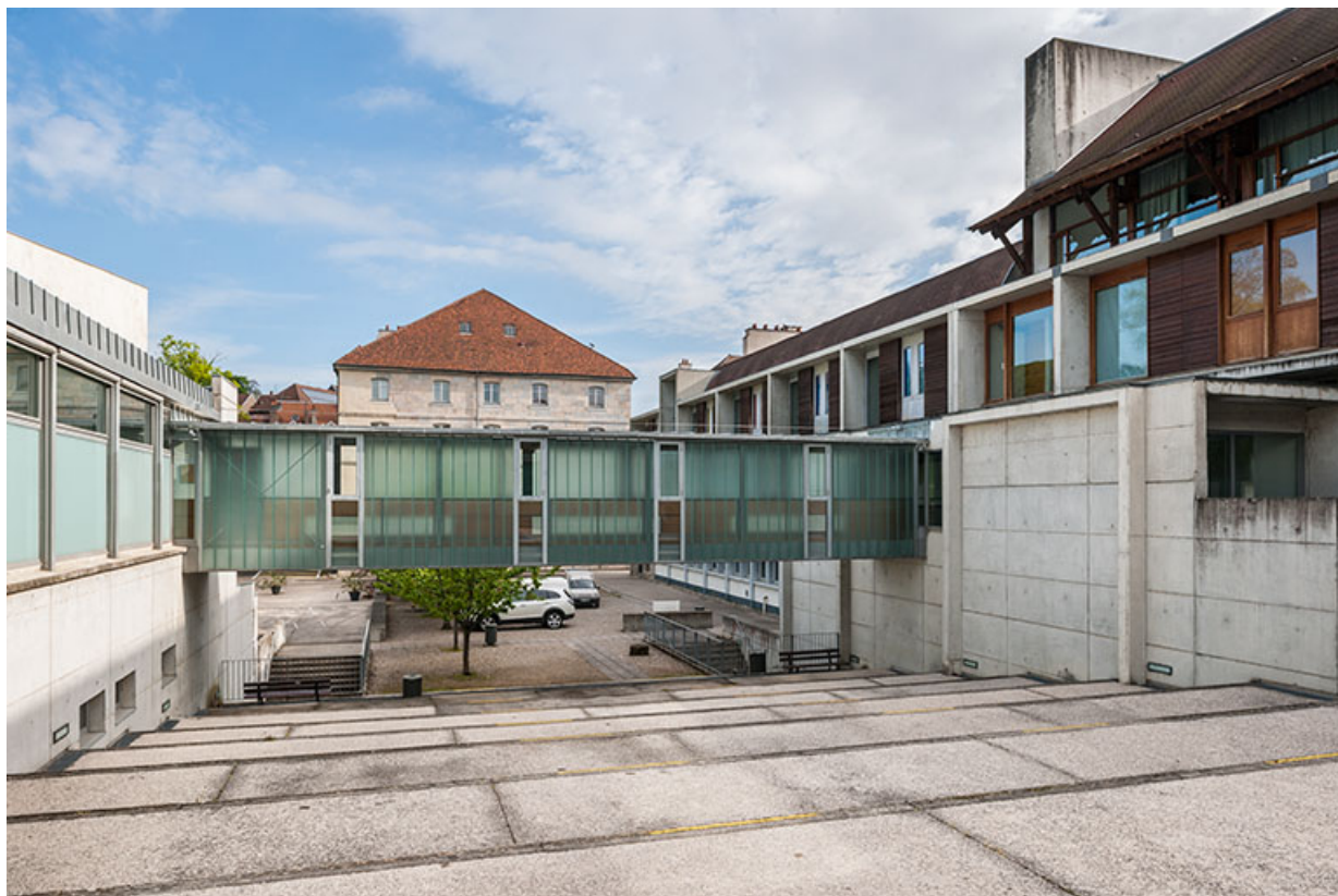
Depuis le sud, vue sur la passerelle reliant le restaurant d'application à l'externat. 25, Besançon, 5 place Marulaz
