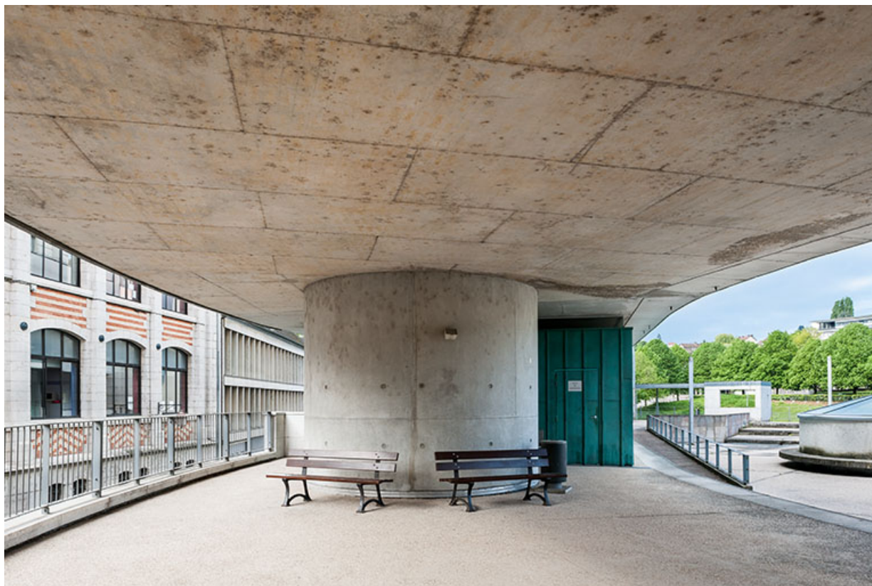
Vue sur les façades de la rue d'Arènes, depuis le passage sous l'internat de filles.
