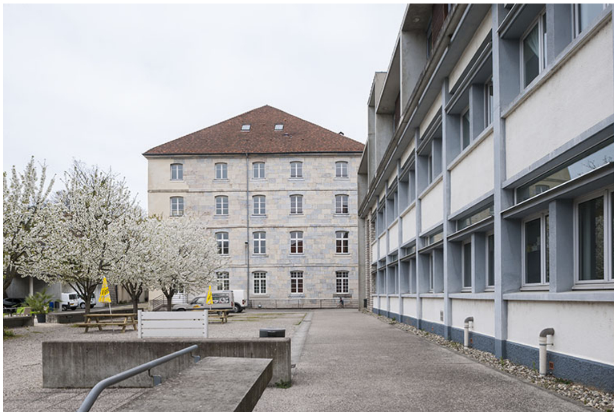
Face au pignon sud du pavillon des officiers ouest, le long de l'externat. 25, Besançon, 5 place Marulaz
