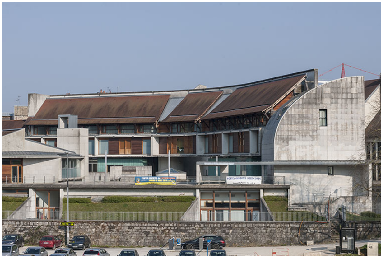
Façades ouest de l'externat et de l'internat de filles.
