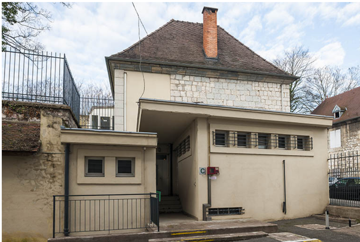
Façade est sur cour de l'ancien corps de garde et des bâtiments adjacents, vus de face.
