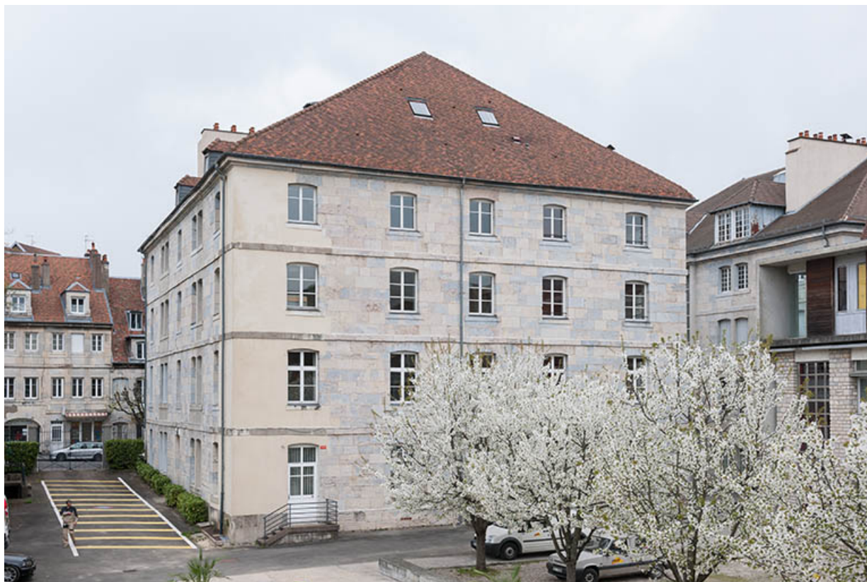
Angle sud-ouest du pavillon des officiers ouest.
