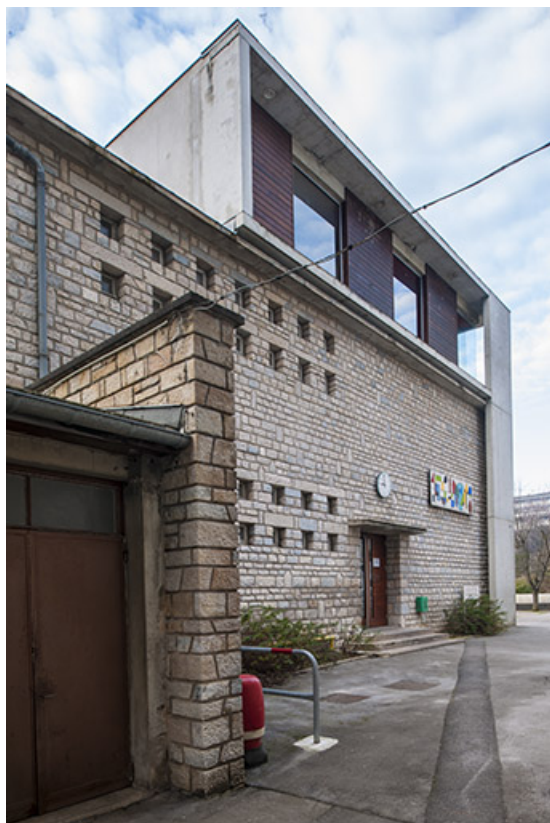
Vue de trois-quart du pignon nord de l'externat.
