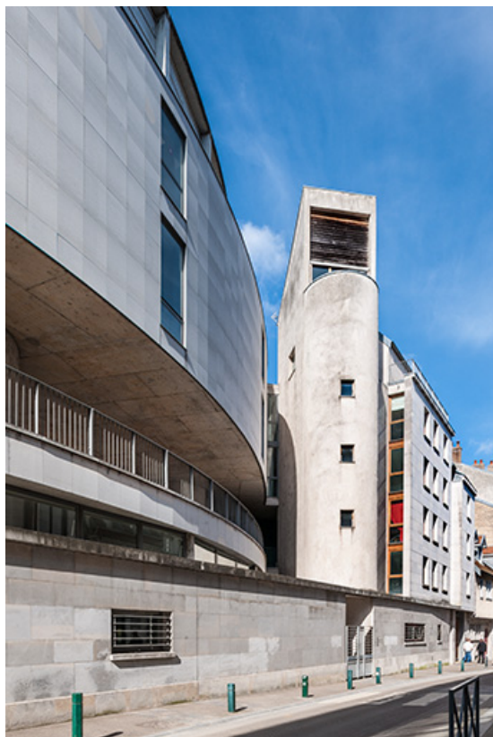
Vue tangentielle depuis la rue d'Arènes de l'internat de filles et du pignon sud de l'externat. 25, Besançon, 5 place Marulaz
