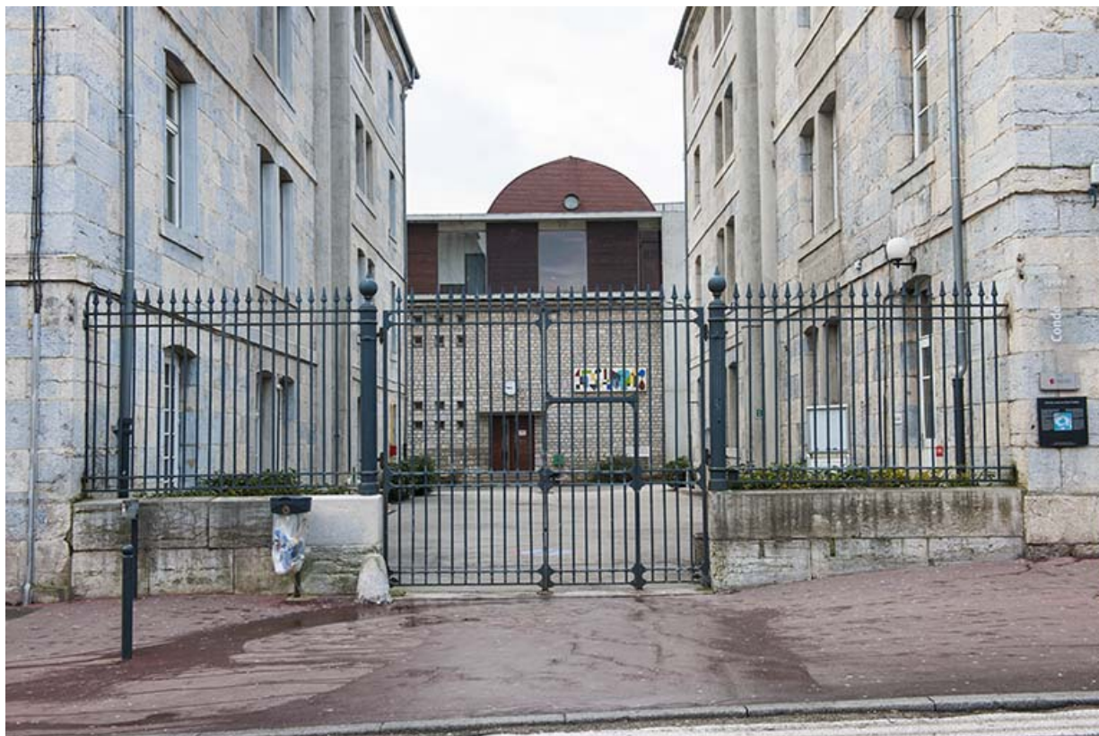
Grille d'entrée donnant sur la place.
