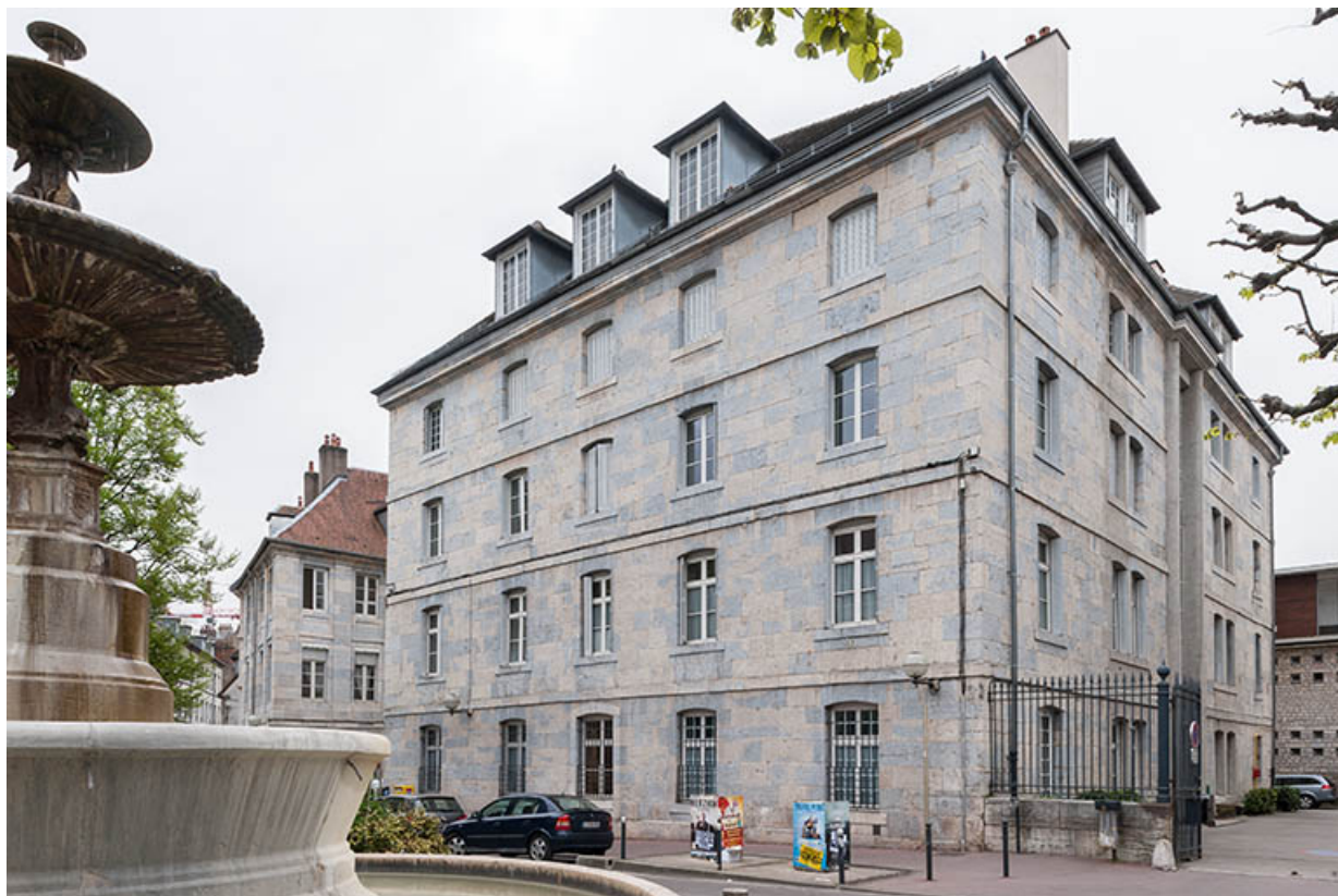
Angle nord-ouest et façade du pavillon des officiers est donnant sur la place Marulaz. 25, Besançon, 5 place Marulaz
