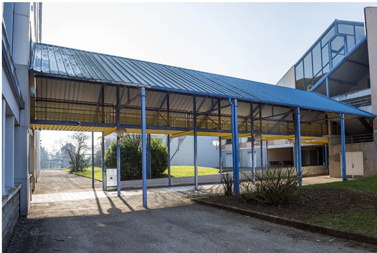
Passage couvert reliant l'externat au centre de documentation et d'information.
