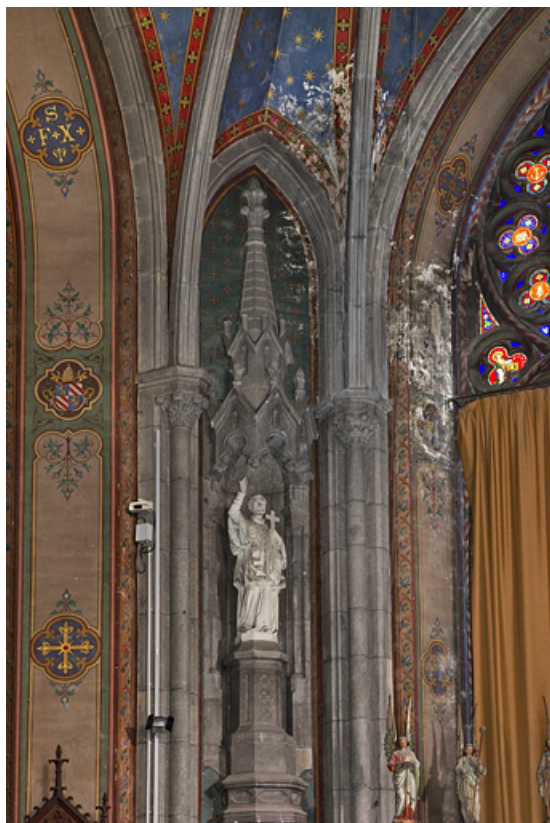
Décor sculpté du chœur situé entre deux retombées d'ogives (côté nord). 25, Besançon, 4 rue du Lycée
