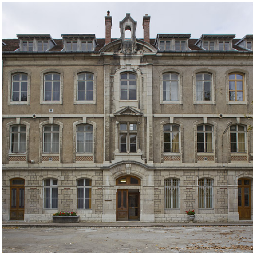
Façade antérieure du bâtiment Ducat.
