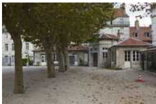
Vue de la loge du lycée formant l'angle des rues du lycée et Girod de Chantrans depuis la cour. 25, Besançon, 4 rue du Lycée
