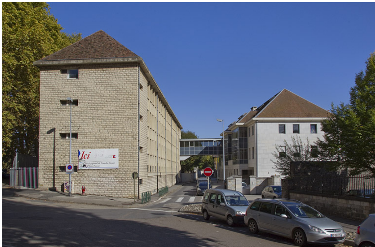
Vue générale des bâtiments Chamars et Charvet reliés par la passerelle. 25, Besançon, 4 rue du Lycée
