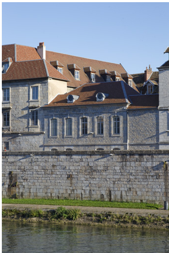
Façade postérieure de l'infirmerie.
