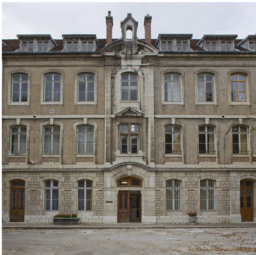
Façade antérieure du bâtiment Ducat.
