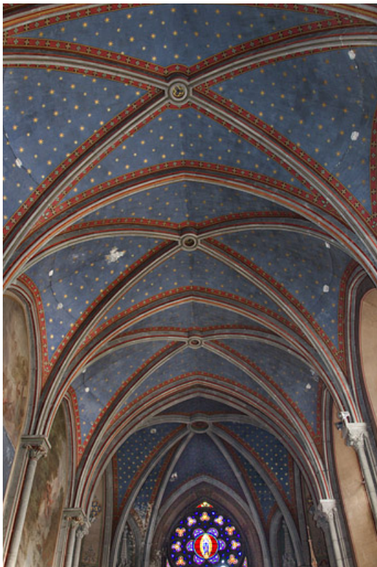
Voûtes de la nef de la chapelle.
