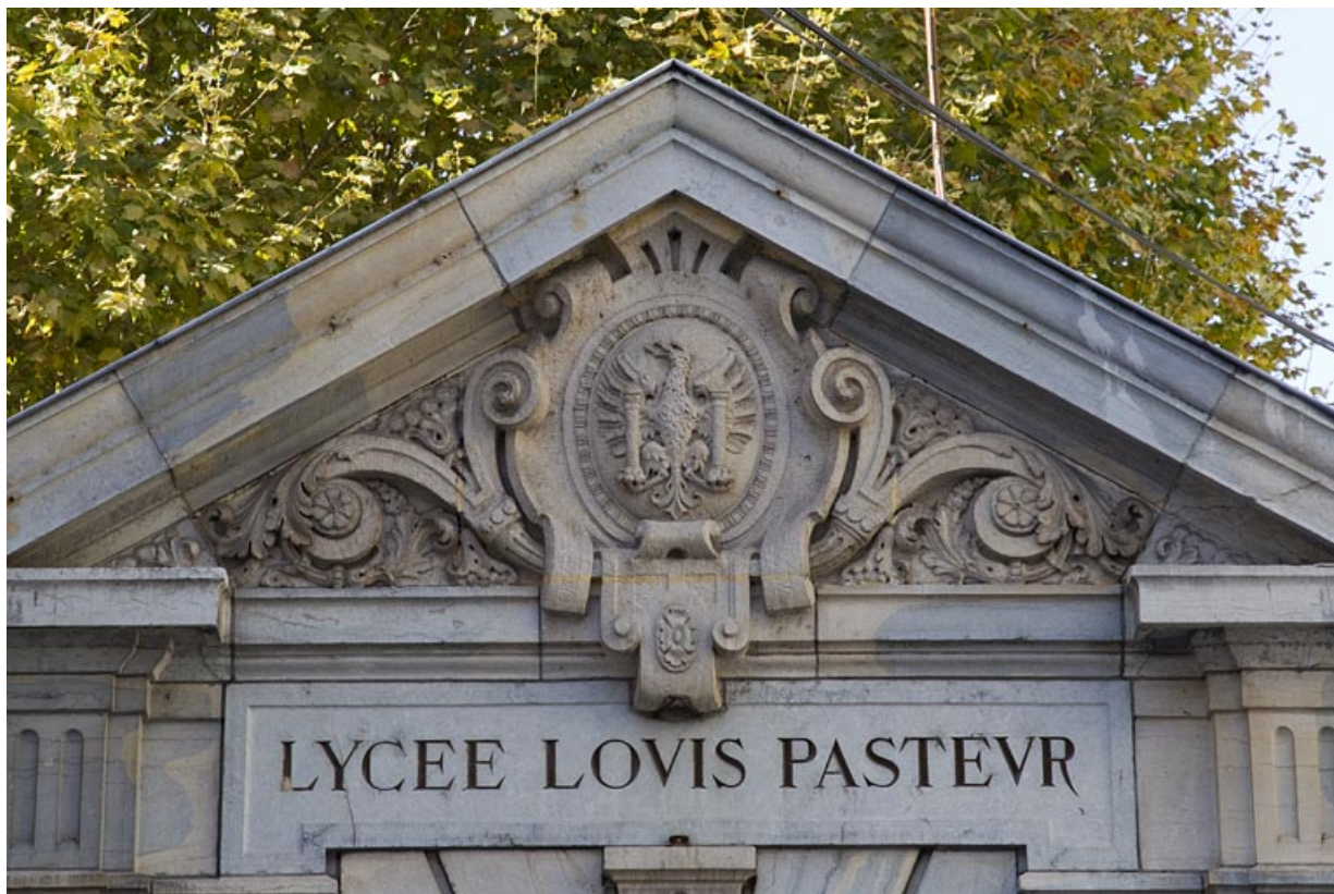
Détail du fronton de la loge d'entrée du lycée.
