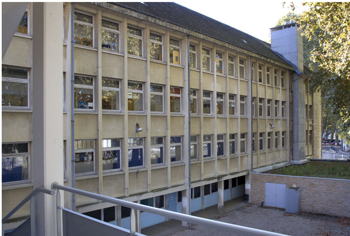
Façade antérieure du bâtiment Chamars.
