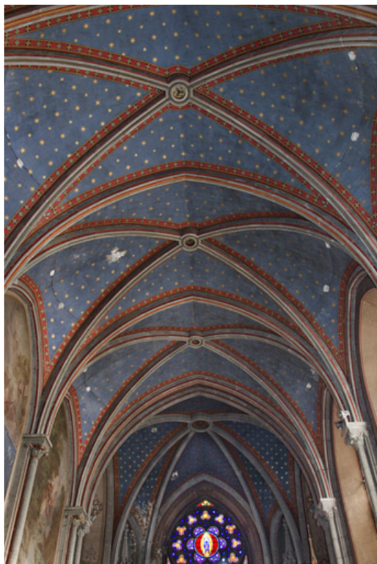
Voûtes de la nef de la chapelle.
