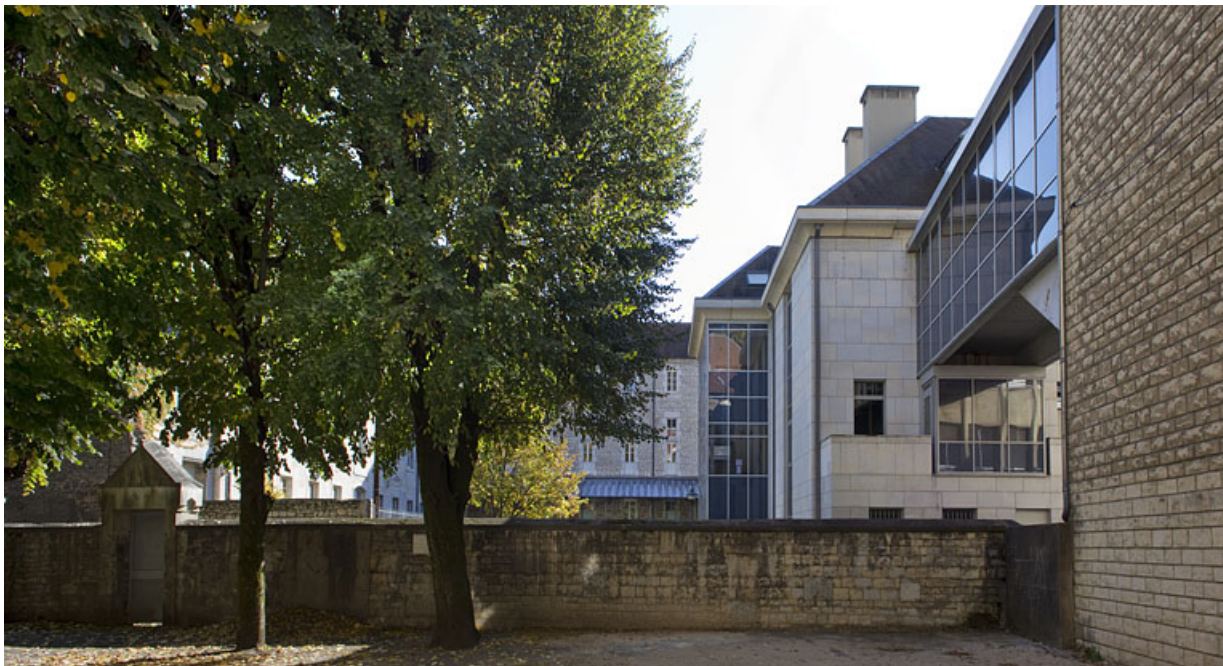
Vue latérale du bâtiment Charvet et de la passerelle depuis la cour du lycée située devant le bâtiment Ducat. 25, Besançon, 4 rue du Lycée
