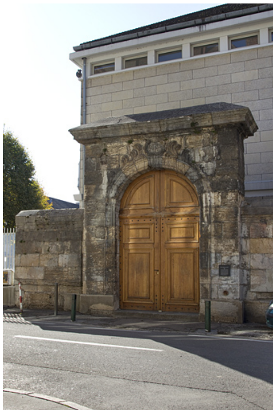
Ancien portail du couvent des Cordeliers situé dans la rue du Lycée. 25, Besançon, 4 rue du Lycée
