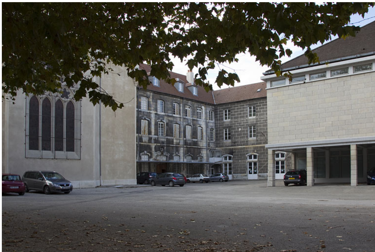
Vue générale de la chapelle, des bâtiments Ducat et Vauban ainsi que du gymnase depuis la cour du lycée. 25, Besançon, 4 rue du Lycée
