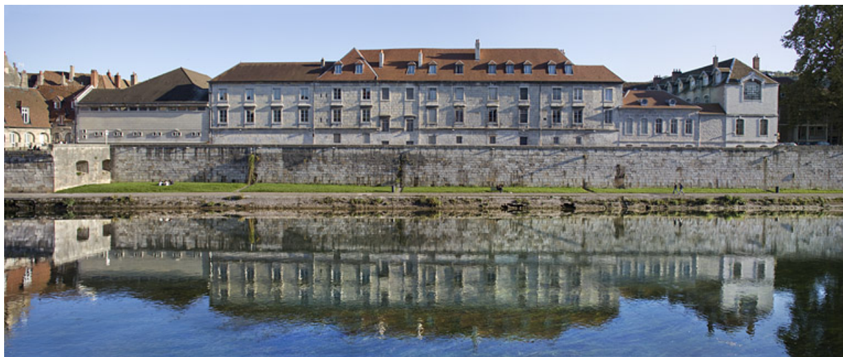
Façade postérieure du bâtiment Ducat depuis les quais.
