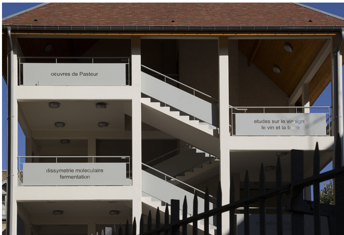
Détail de l'escalier de distribution extérieur situé à l'extrémité ouest du bâtiment Ducat. 25, Besançon, 4 rue du Lycée
