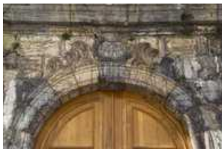
Détail de l'ancien portail du couvent des Cordeliers situé dans la rue du Lycée. 25, Besançon, 4 rue du Lycée
