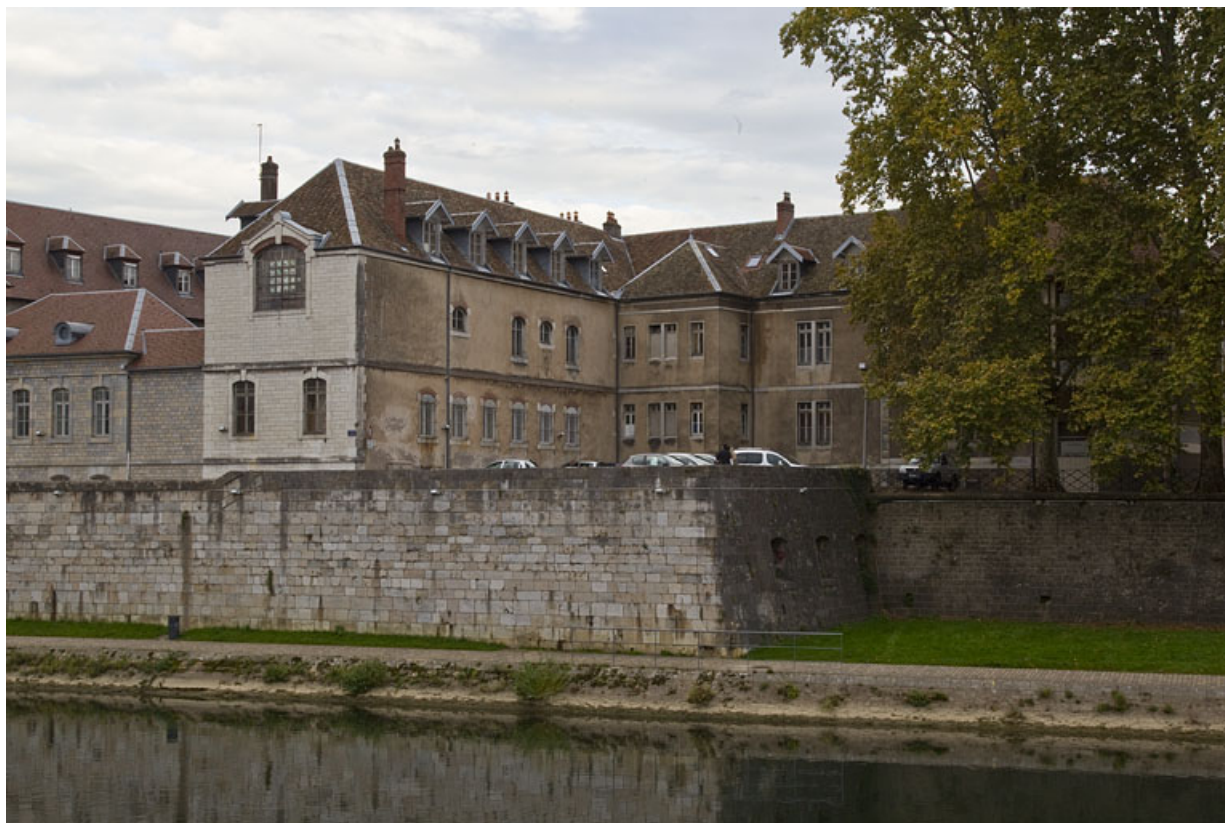
Façades postérieures de l'extrémité ouest du bâtiment Ducat.
