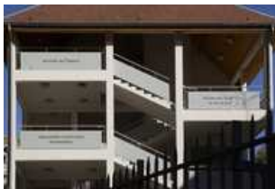
Détail de l'escalier de distribution extérieur situé à l'extrémité ouest du bâtiment Ducat.
