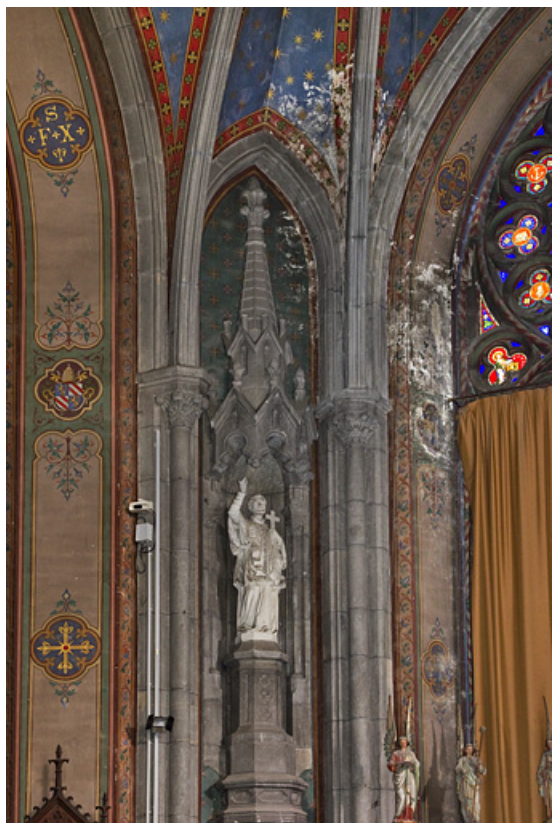
Décor sculpté du chœur situé entre deux retombées d'ogives (côté nord). 25, Besançon, 4 rue du Lycée
