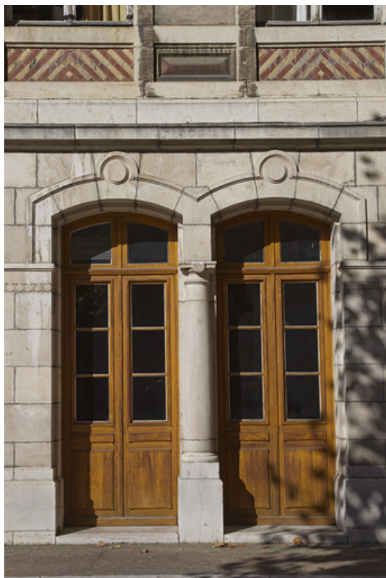
Portes d'entrée situées au rez-de-chaussée du bâtiment Ducat. 25, Besançon, 4 rue du Lycée
