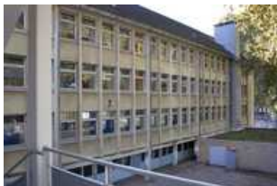
Façade antérieure du bâtiment Chamars.
