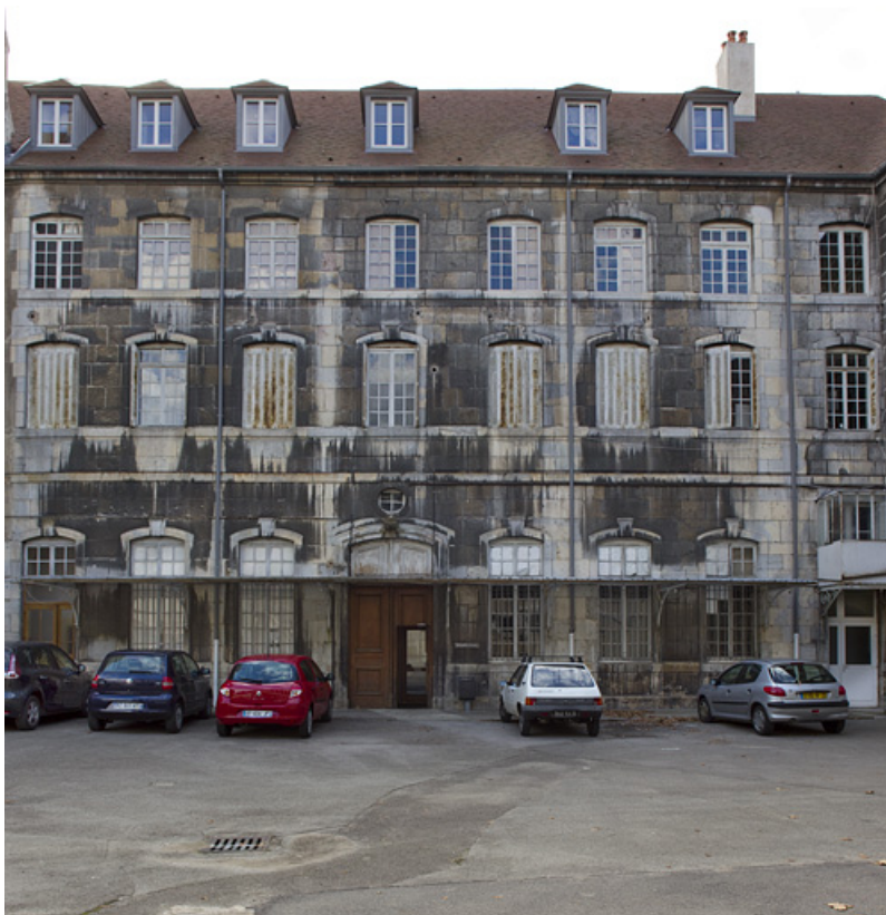
Façade latérale du bâtiment Ducat.
