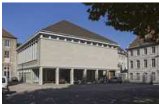
Façade antérieure du gymnase.
