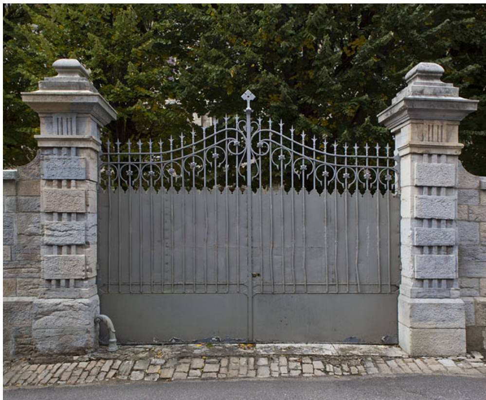
Vue rapprochée du portail situé dans la rue Girod de Chantrans permettant l'accès à la cour du bâtiment Ducat. 25, Besançon, 4 rue du Lycée
