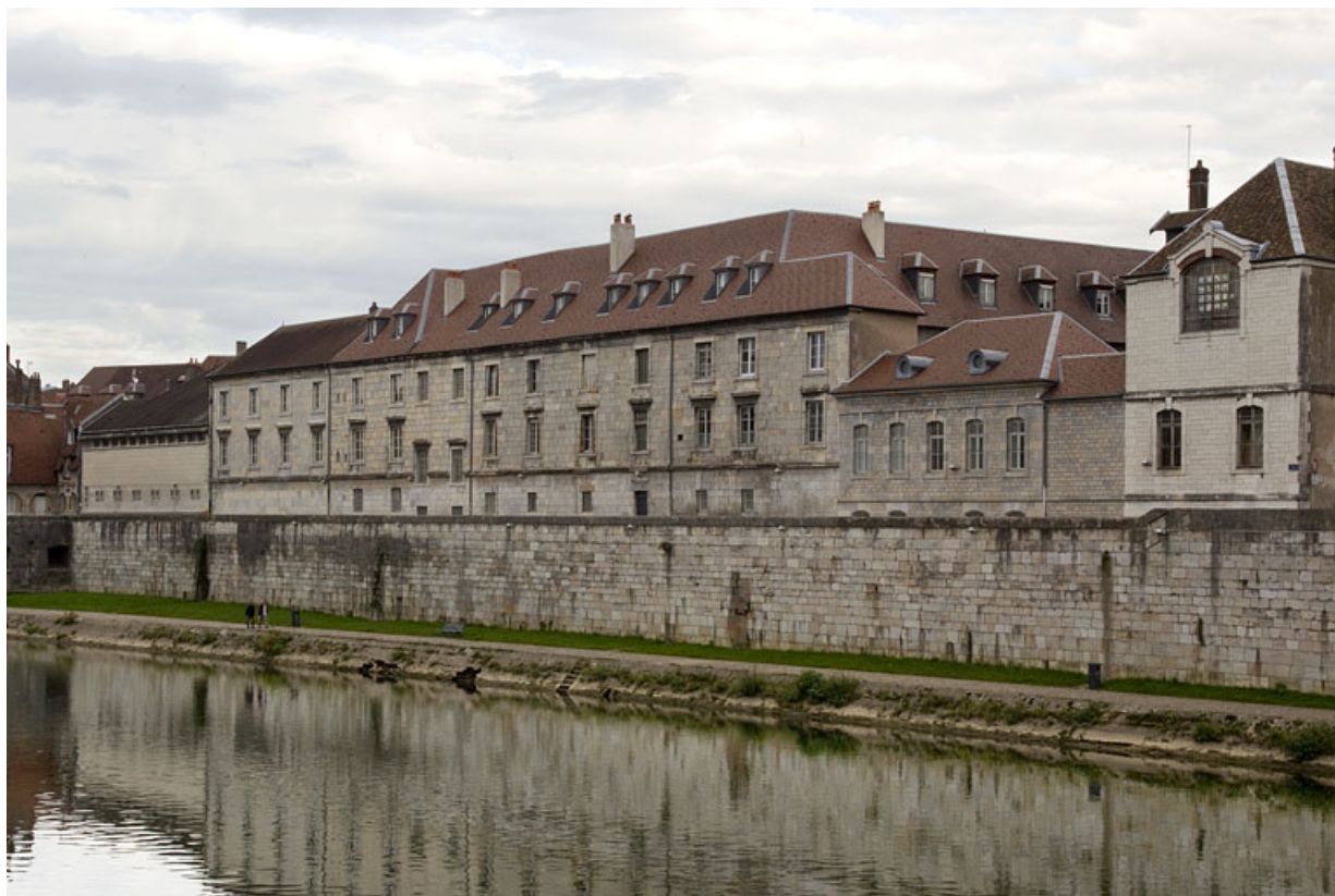
Façades postérieures des bâtiments du lycée depuis les quais.
