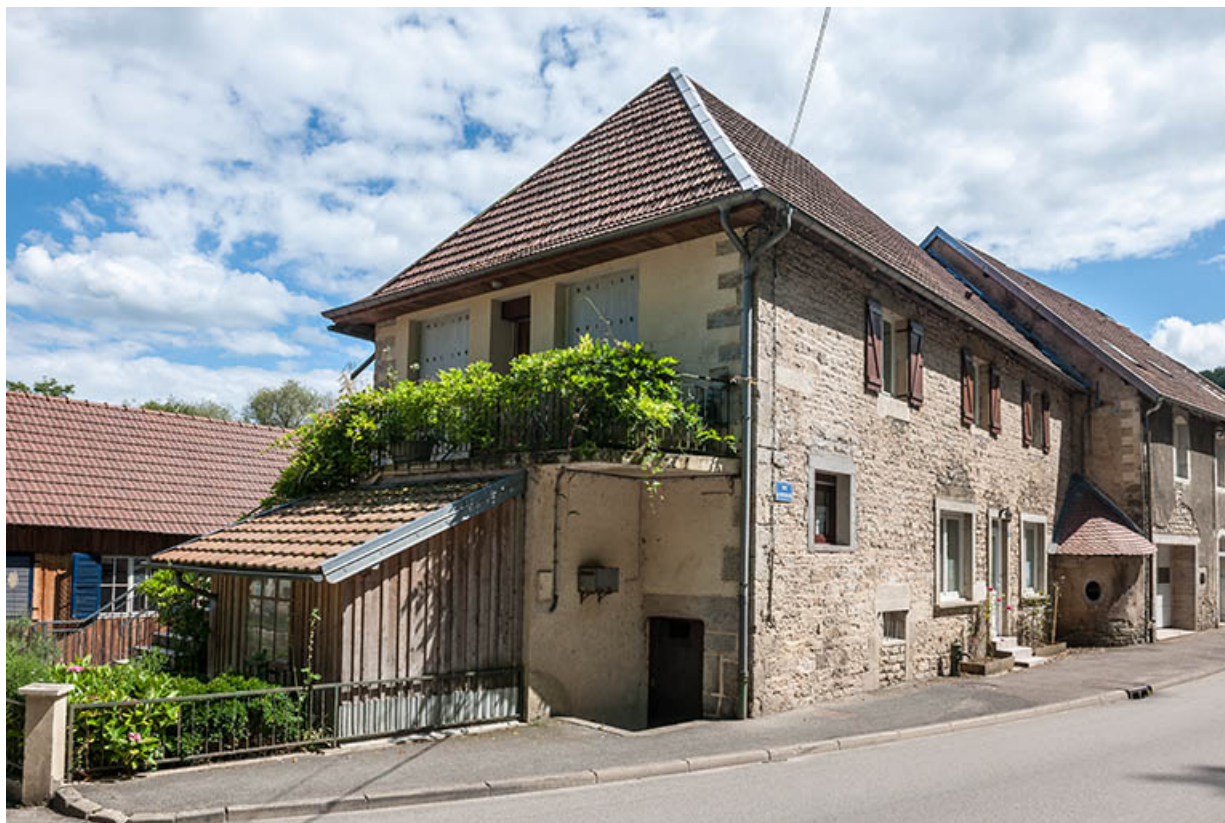
Bâtiment du moulin vu de trois quarts gauche.
