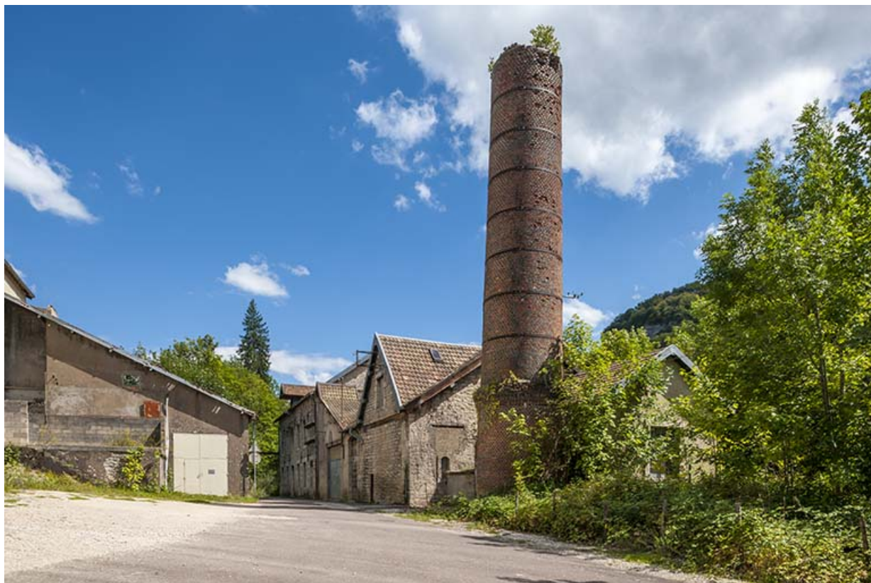
Vue des bâtiments du moulin depuis l'ouest.
