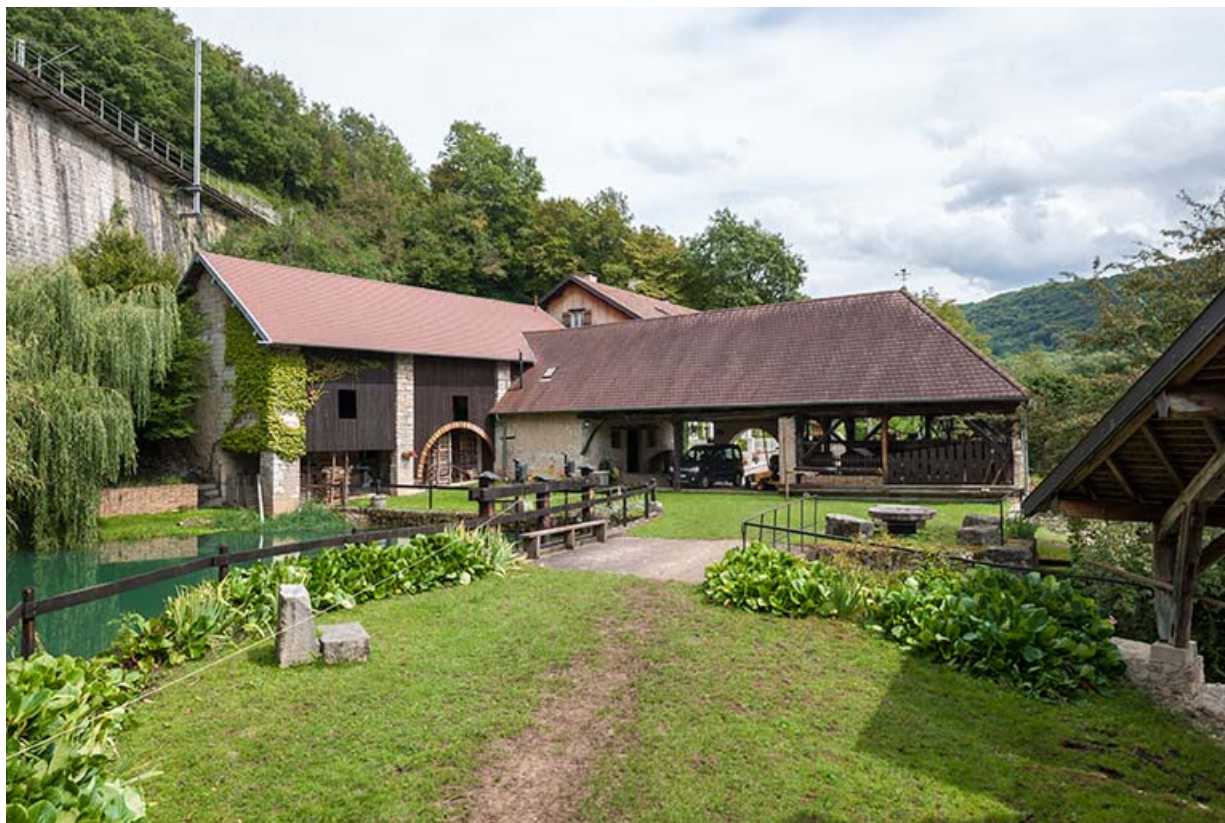
Grange, écurie et remise depuis l'ouest. 25, Fourbanne, 8 chemin du Moulin
