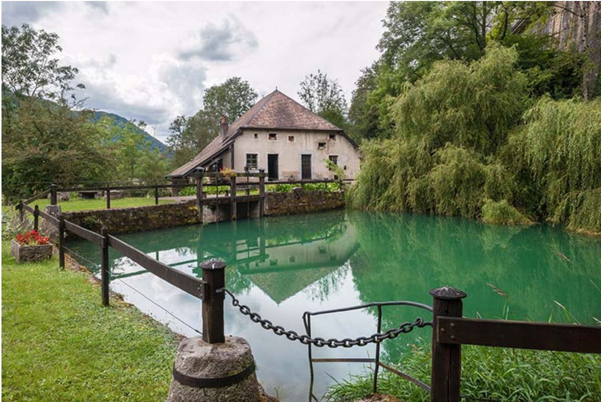
La source et le moulin depuis le nord-est.
