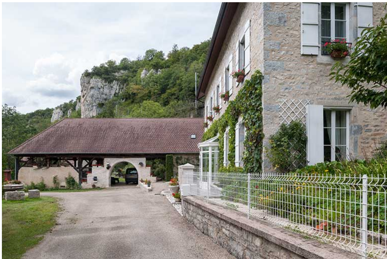
Vue depuis l'entrée du site.
