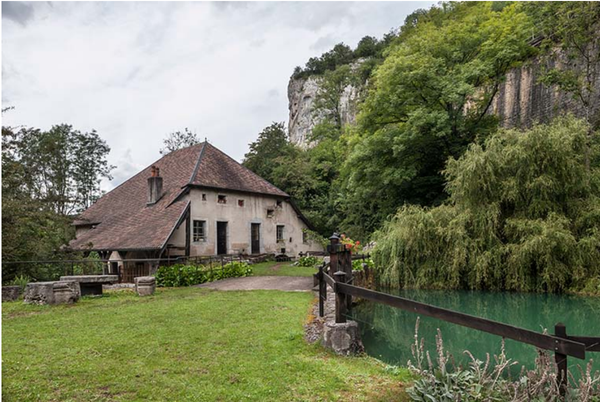
Le moulin vu depuis le nord-est. 25, Fourbanne, 8 chemin du Moulin
