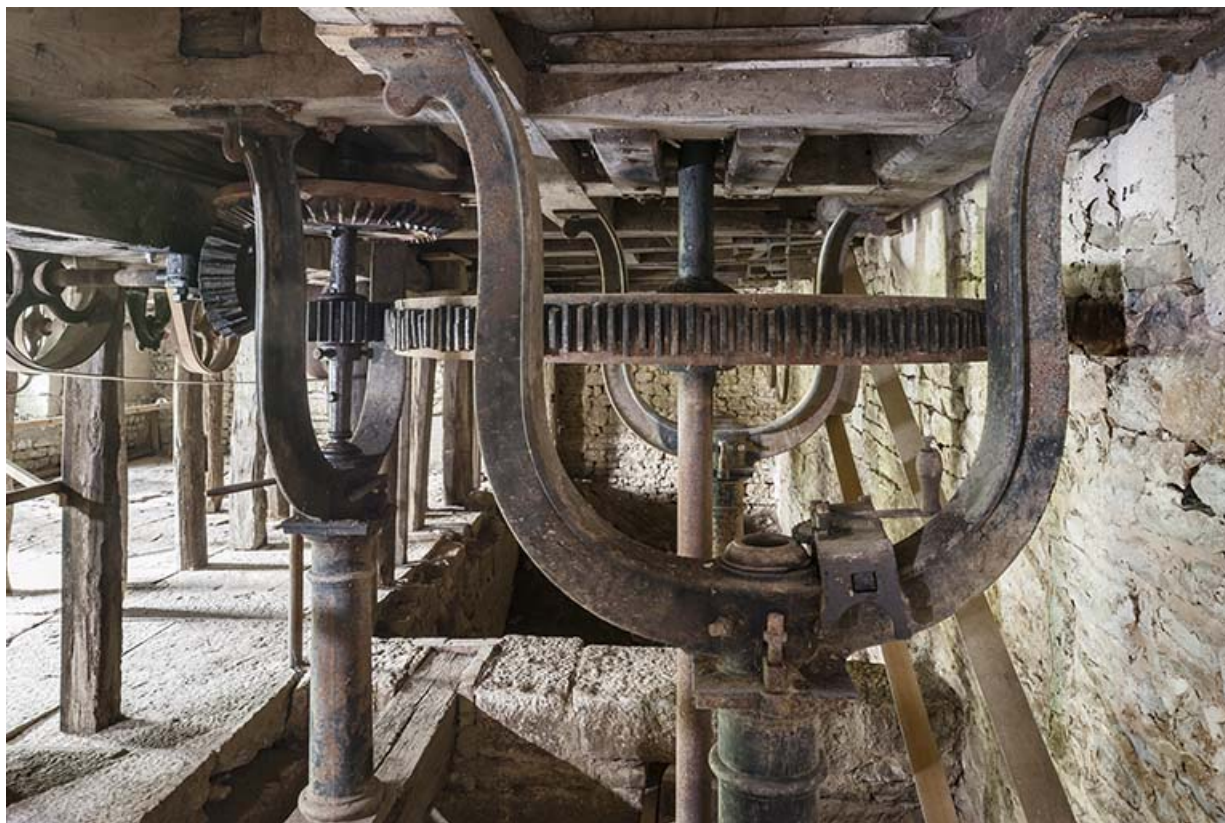
Etage de soubassement. Beffroi du moulin. 25, Fourbanne, 8 chemin du Moulin
