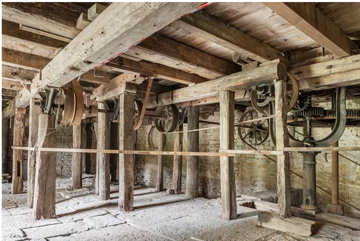
Vue d'ensemble de l'étage de soubassement.
