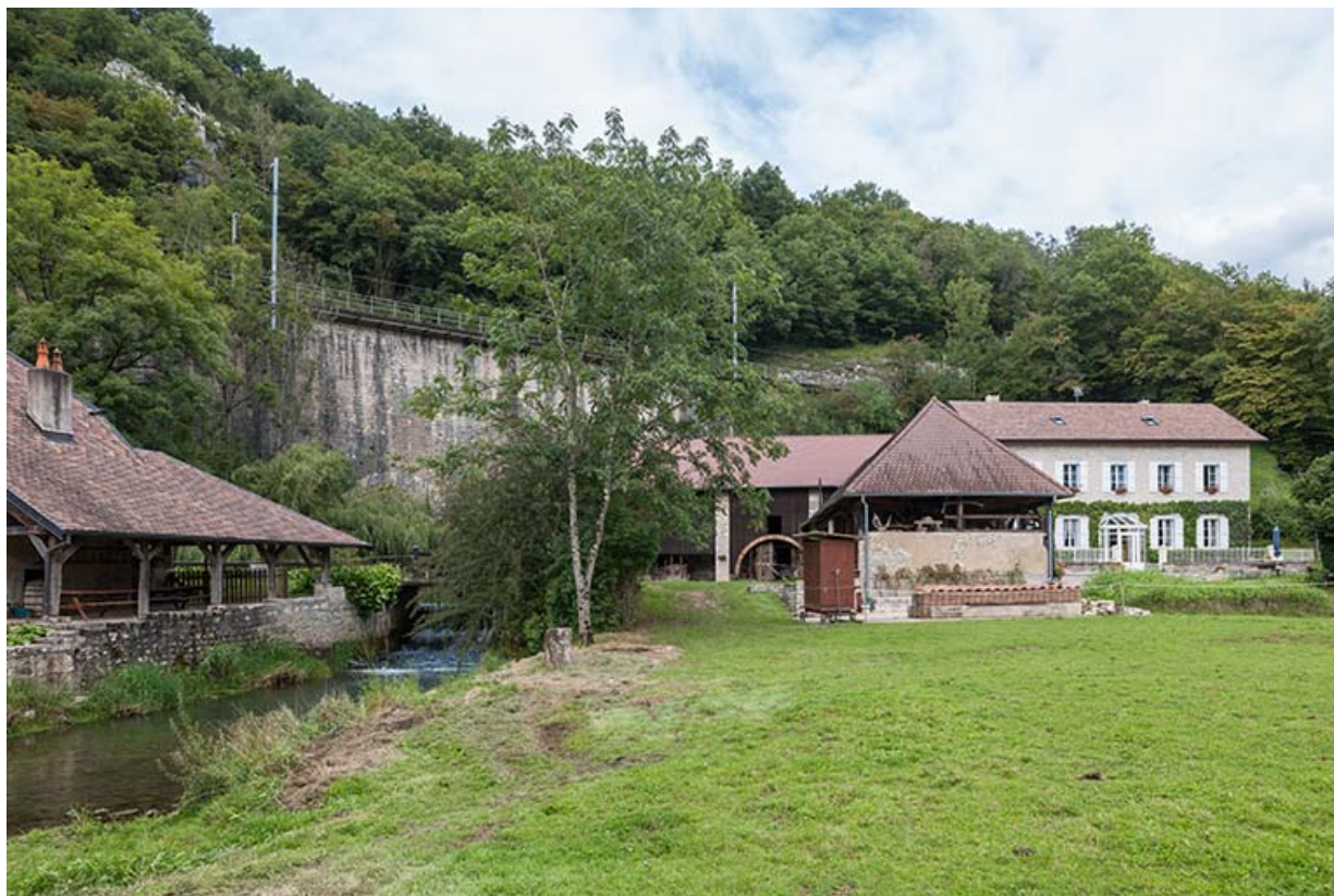
Vue rapprochée des dépendances et du moulin depuis le sud-ouest.
