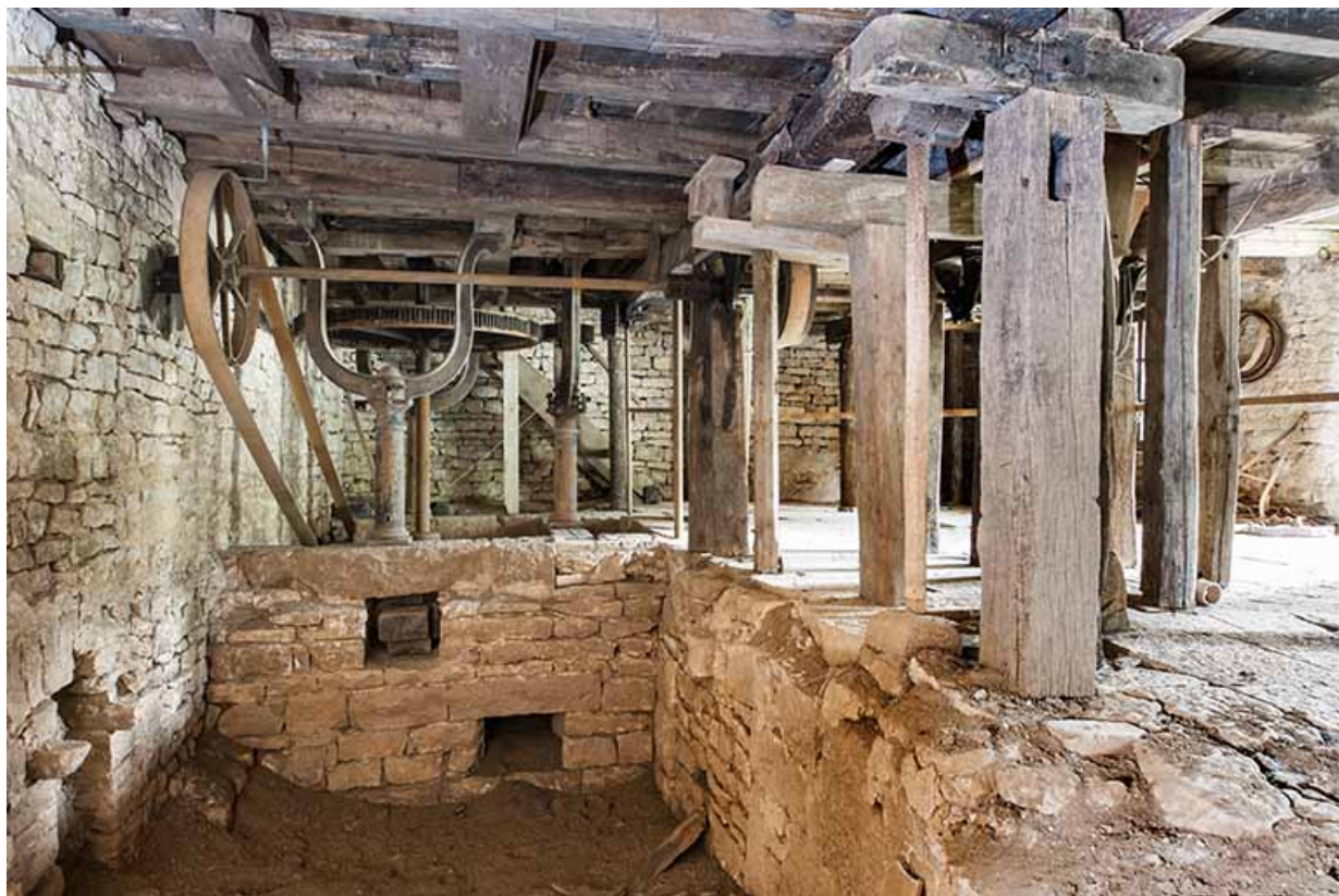
Etage de soubassement. Vue depuis l'ouest. 25, Fourbanne, 8 chemin du Moulin
