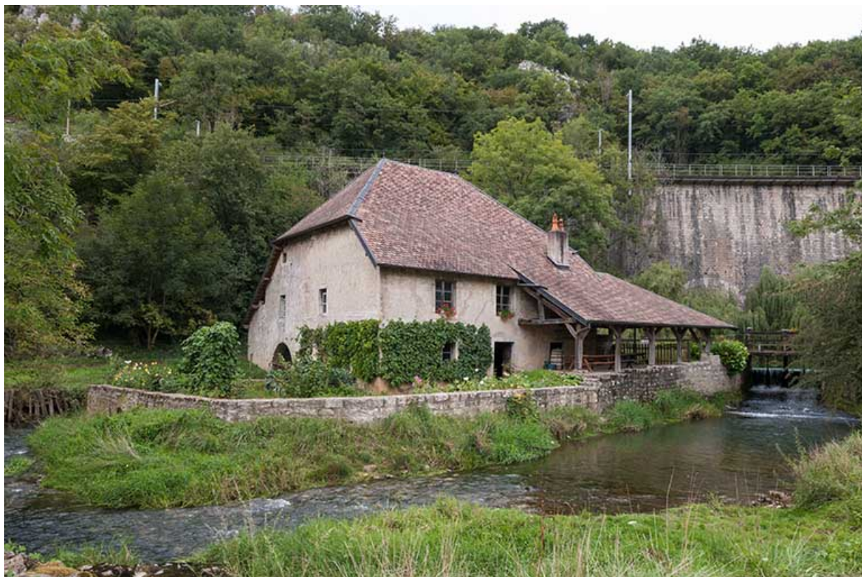
Vue rapprochée du moulin depuis le sud-ouest.
