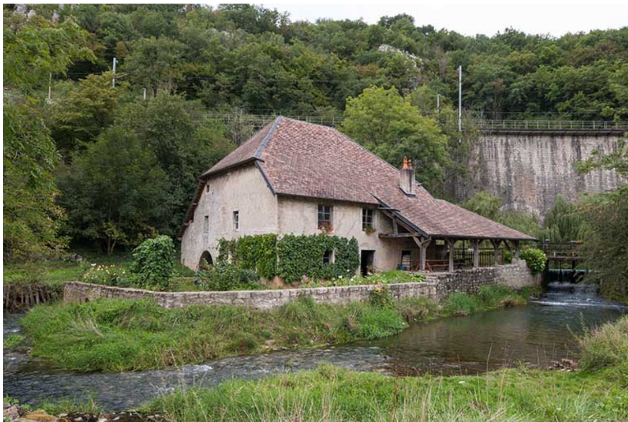
Vue rapprochée du moulin depuis le sud-ouest.
