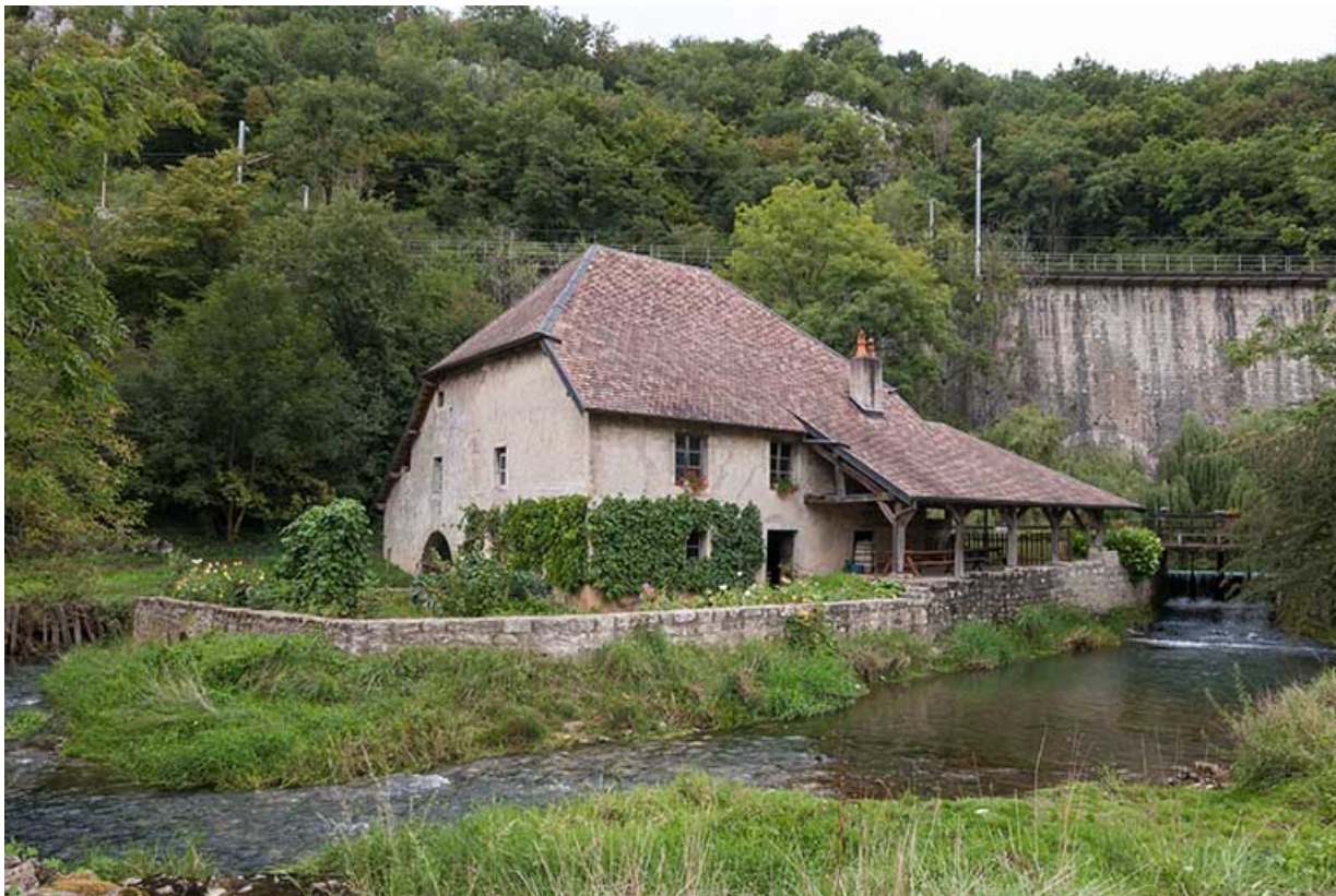
Vue rapprochée du moulin depuis le sud-ouest.
