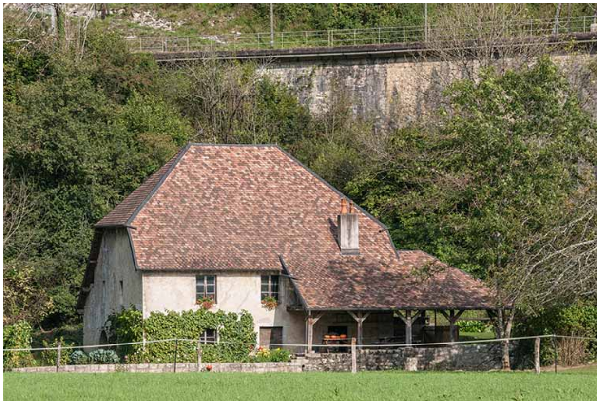
Le moulin depuis le sud-est.
