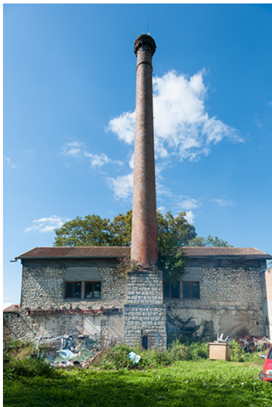
Façade sud de l'atelier de fabrication.
