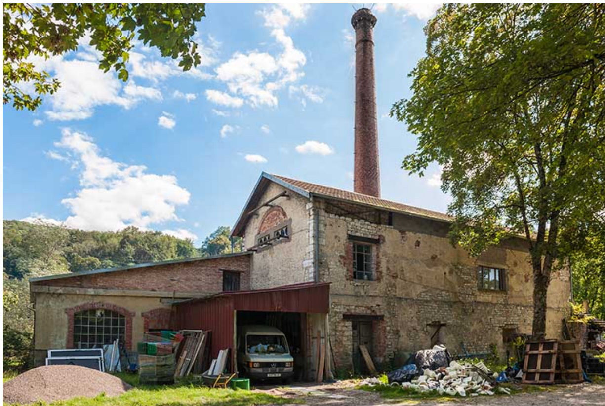
Bâtiment de la centrale hydroélectrique et atelier de fabrication.
