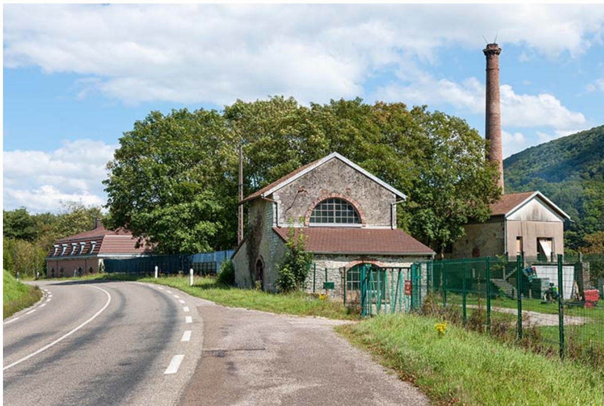
Vue d'ensemble depuis la route nationale, à l'ouest.
