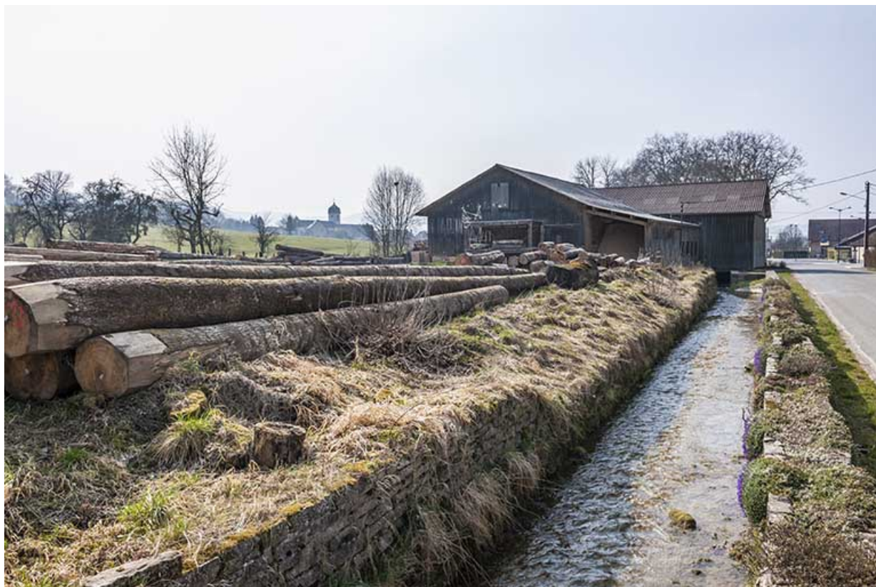
Vue d'ensemble depuis le parc à grumes, à l'est. 25, Sancey-le-Long, 2 Grande-rue
