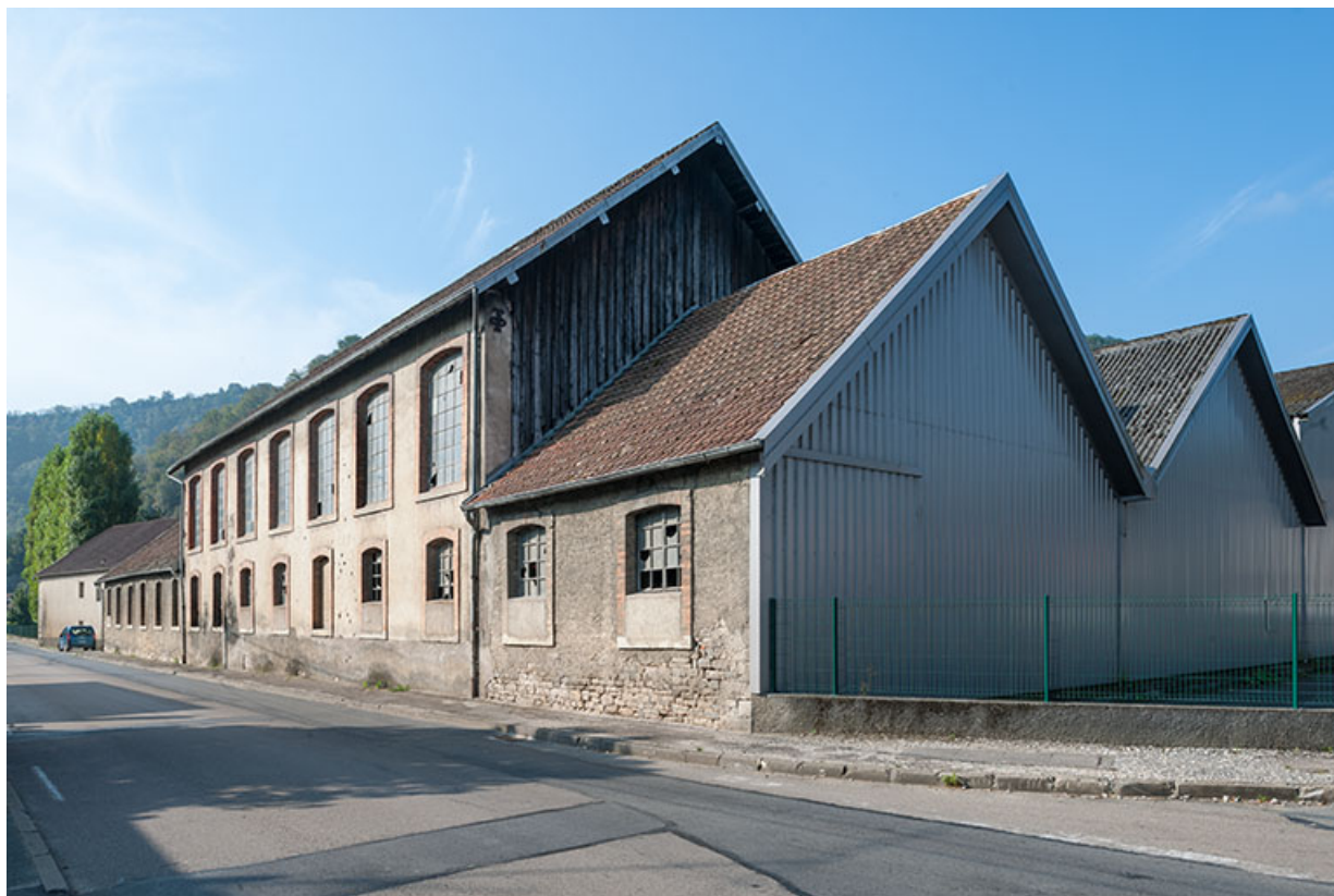
Atelier de fabrication depuis le nord-est. 25, Clerval, 21 avenue Gaston Renaud
