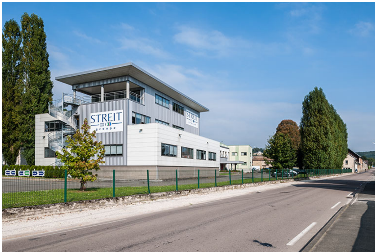
Le bâtiment du nouveau siège social de la société Streit. 25, Clerval, 21 avenue Gaston Renaud
