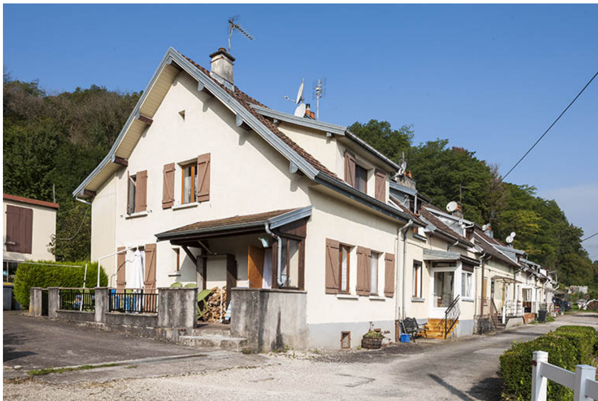
Habitation ouvrière rue du Quartier. Vue de trois quarts.
