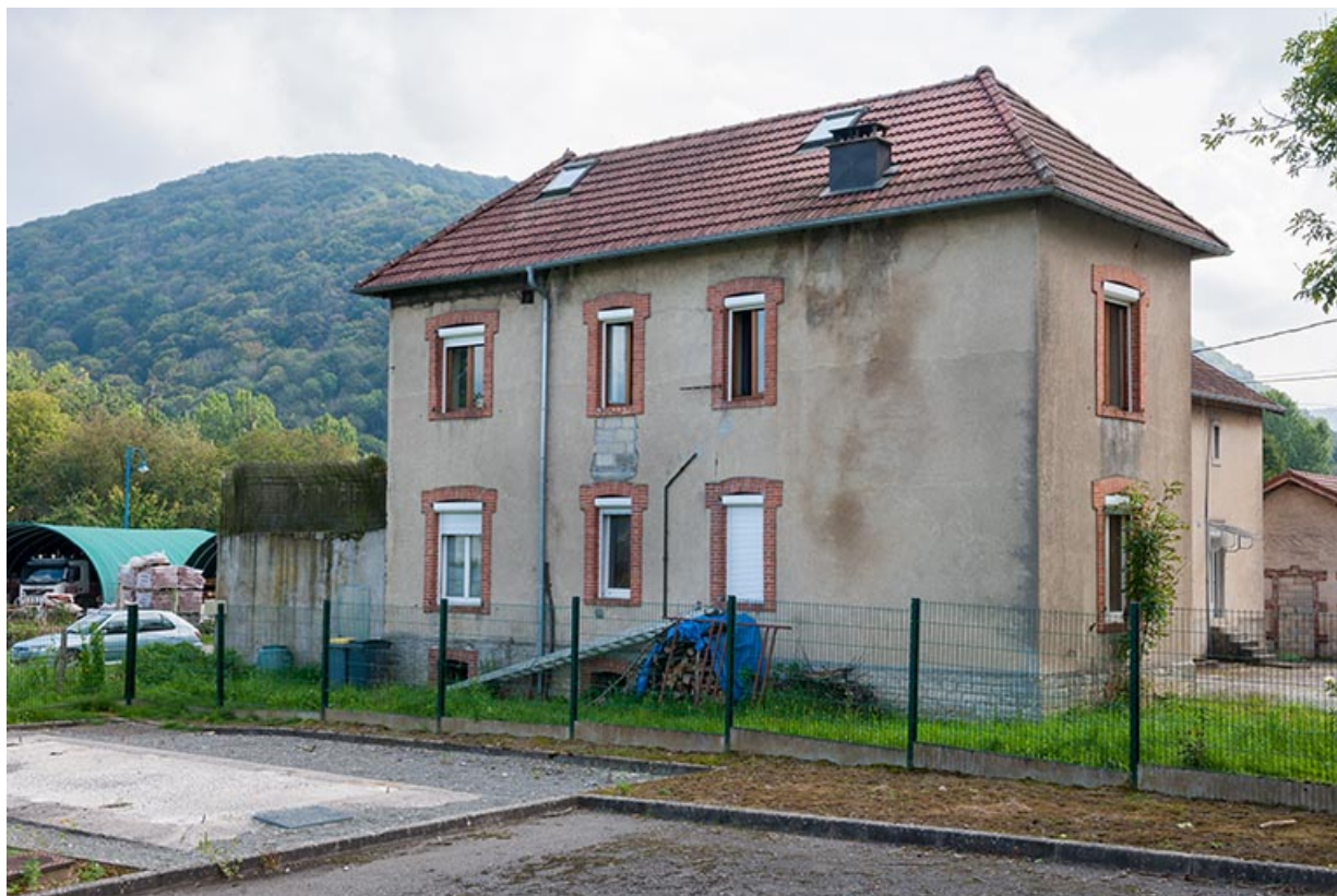
Logement ouvrier rue de Santoche. Façade postérieure. 25, Clerval, 21 avenue Gaston Renaud
