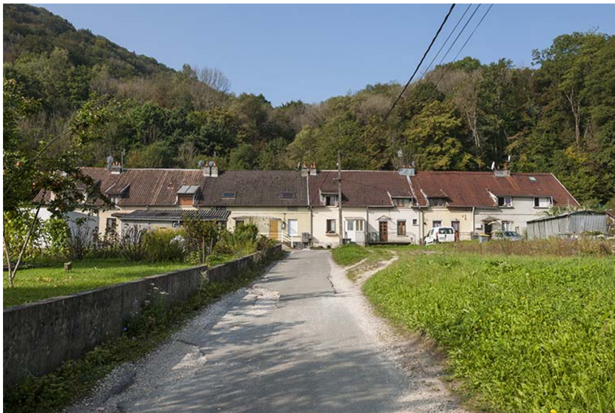
Habitation ouvrière (rue du Quartier). Façade antérieure depuis l'est. 25, Clerval, 21 avenue Gaston Renaud
