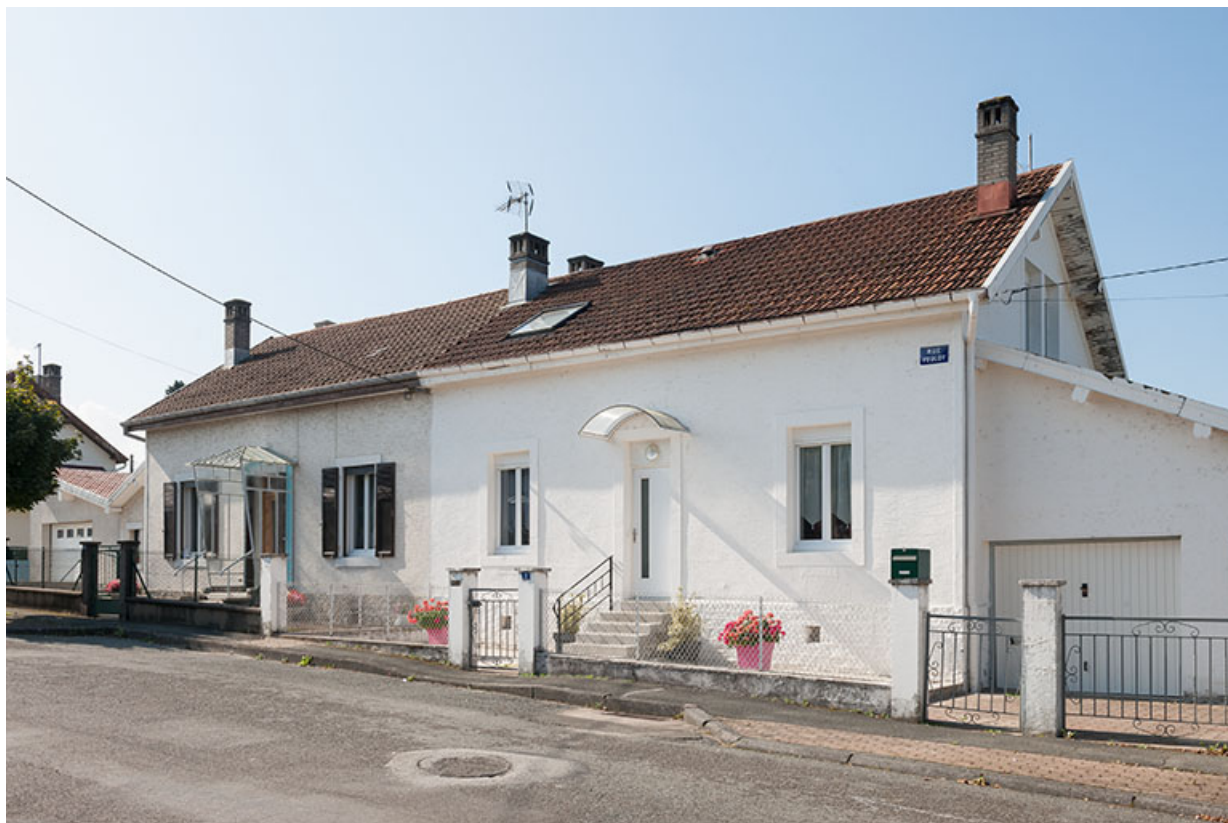
Maison jumelée vue de trois quarts droite.
