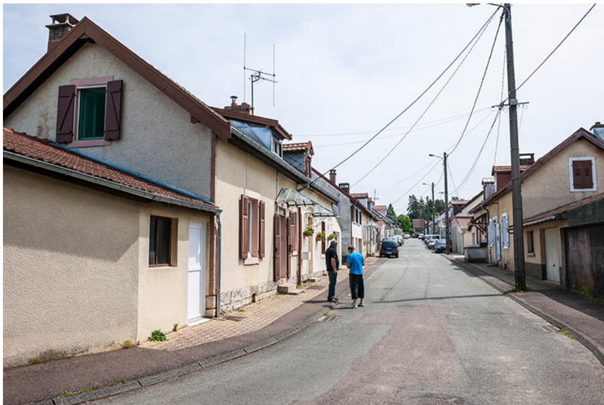
Vue depuis le bas de la rue de la cité Meiner. 25, L'Isle-sur-le-Doubs, lieudit : Champs des Arbues
