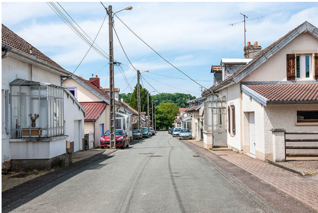
Vue depuis le haut de la rue de la cité Meiner.
