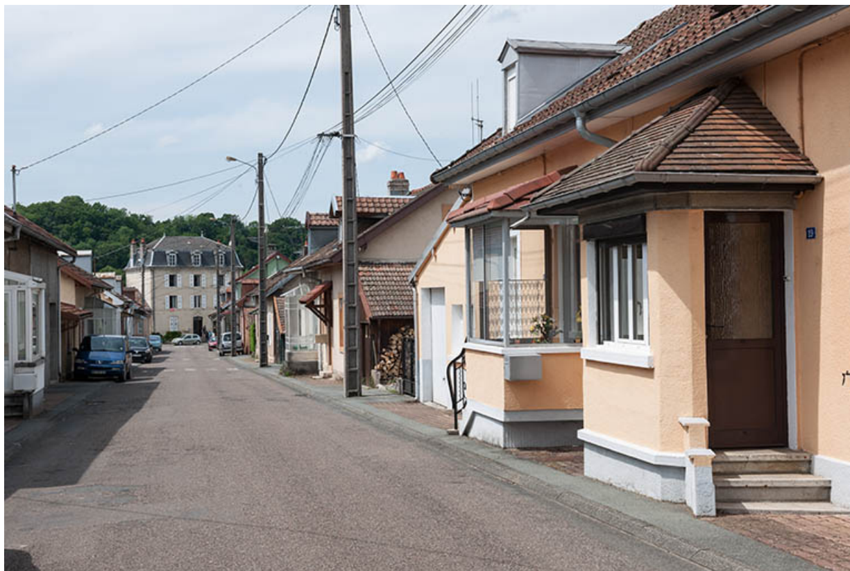
Vue depuis le haut de la rue de la Cité immobilière. 25, L'Isle-sur-le-Doubs, lieudit : Champs des Arbues
