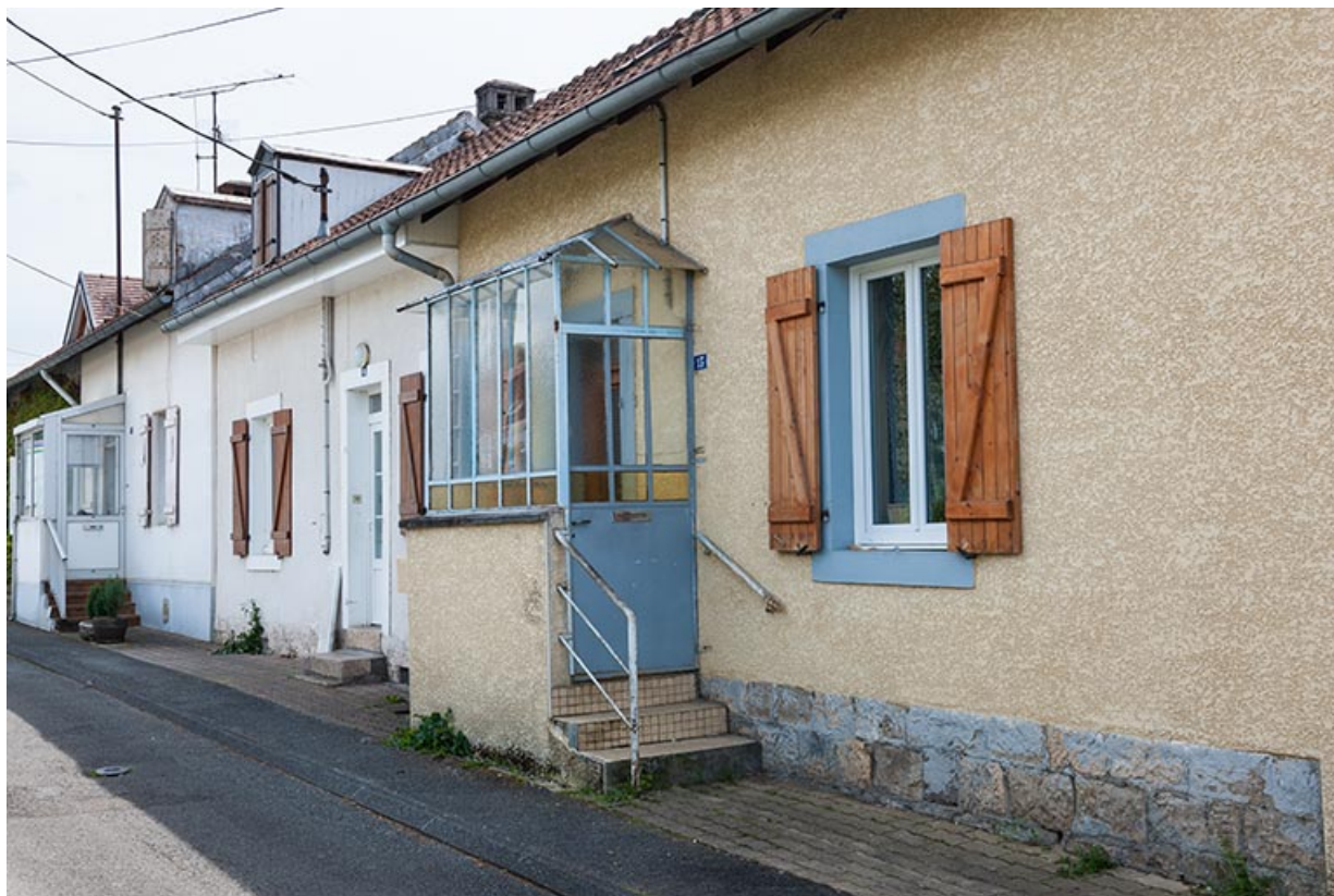
Rue de la 3e Cité. Façade nord vue de trois quarts droite.
