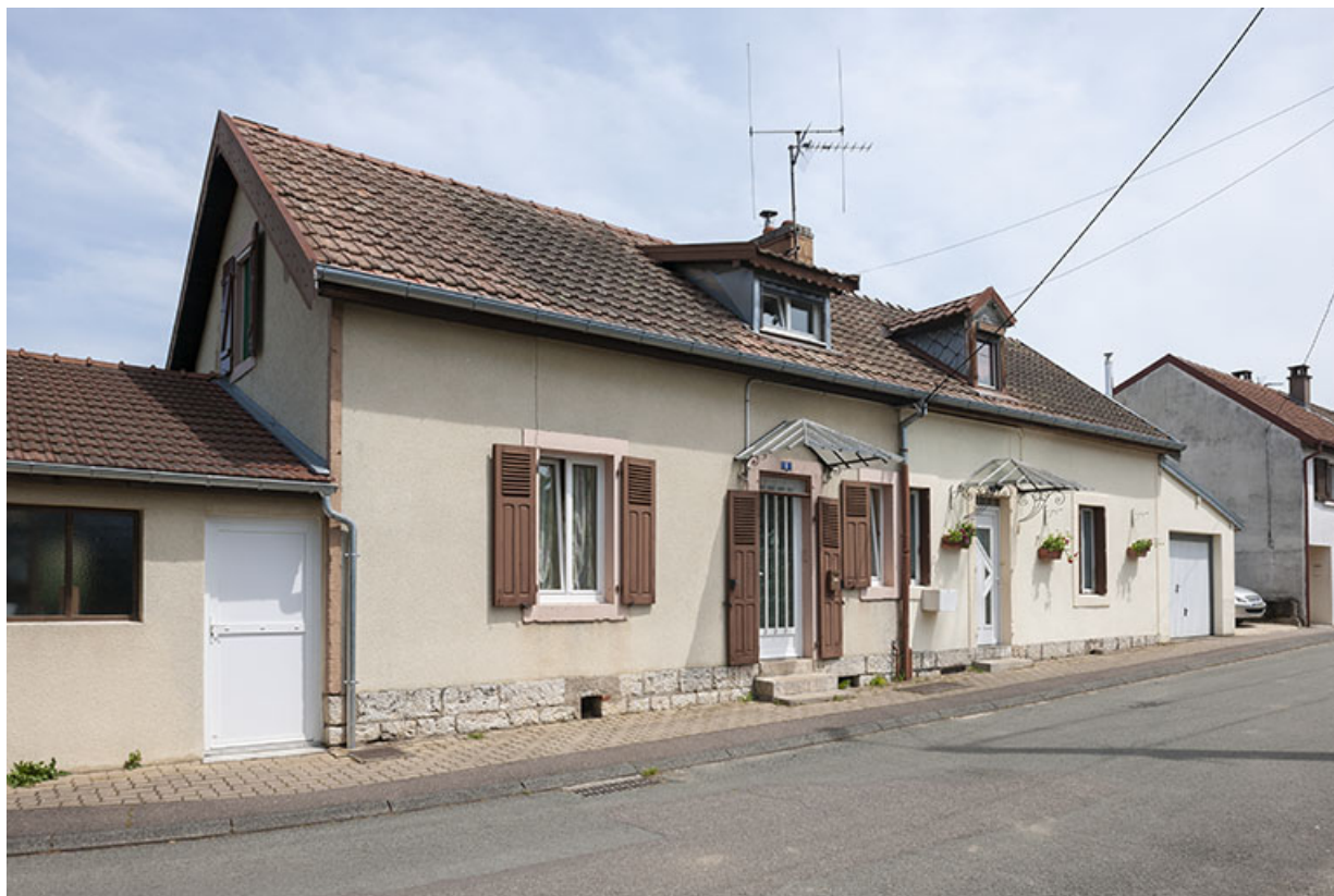
Maison jumelée (1 et 3 rue de la cité Meiner).
