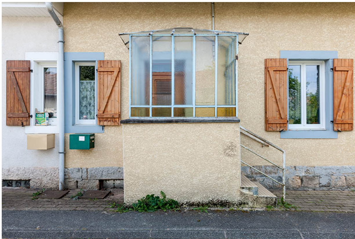
Rue de la 3e Cité. Détail d'une entrée d'un logement.
