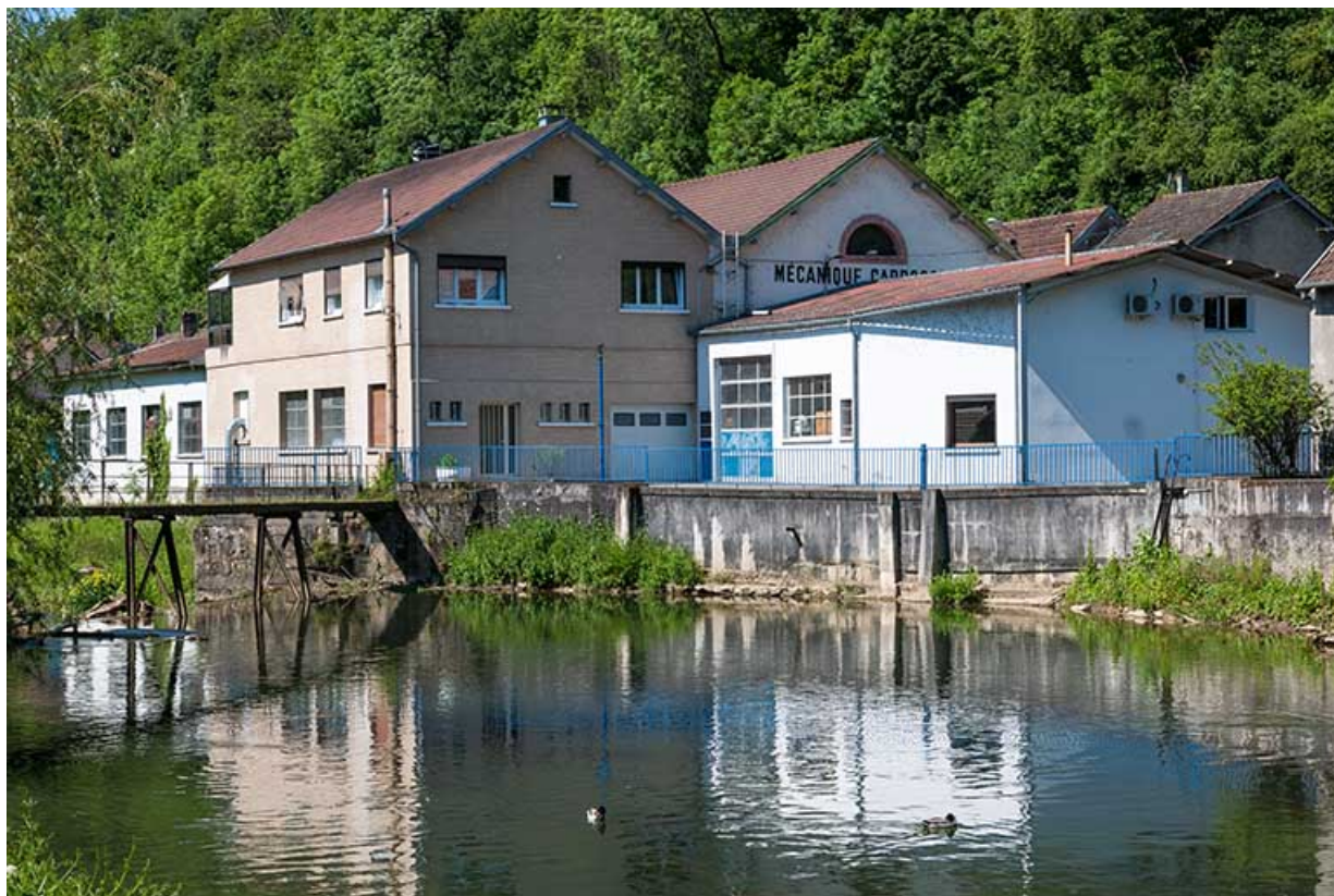
Vue du pont, depuis l'amont.
