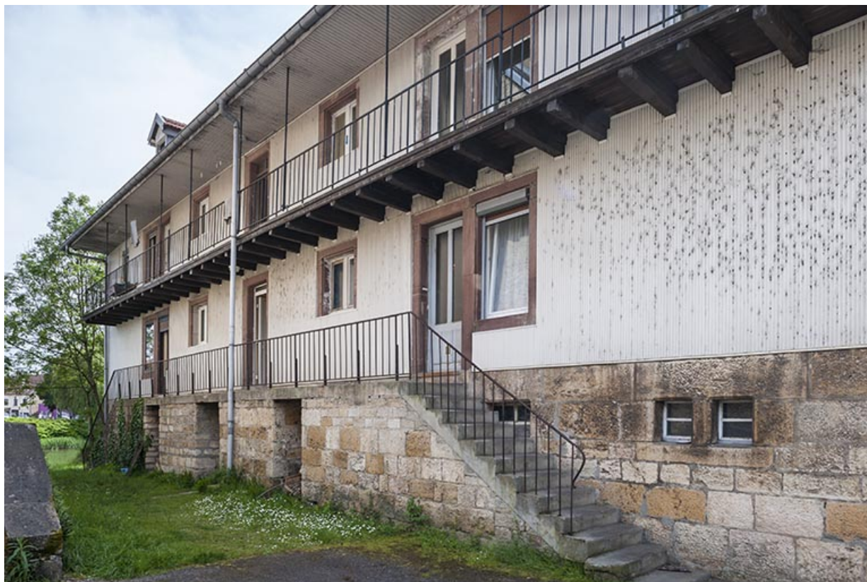
Logement oriental. Détail de la façade nord. 25, L'Isle-sur-le-Doubs, 18 à 22 rue de la Velle
