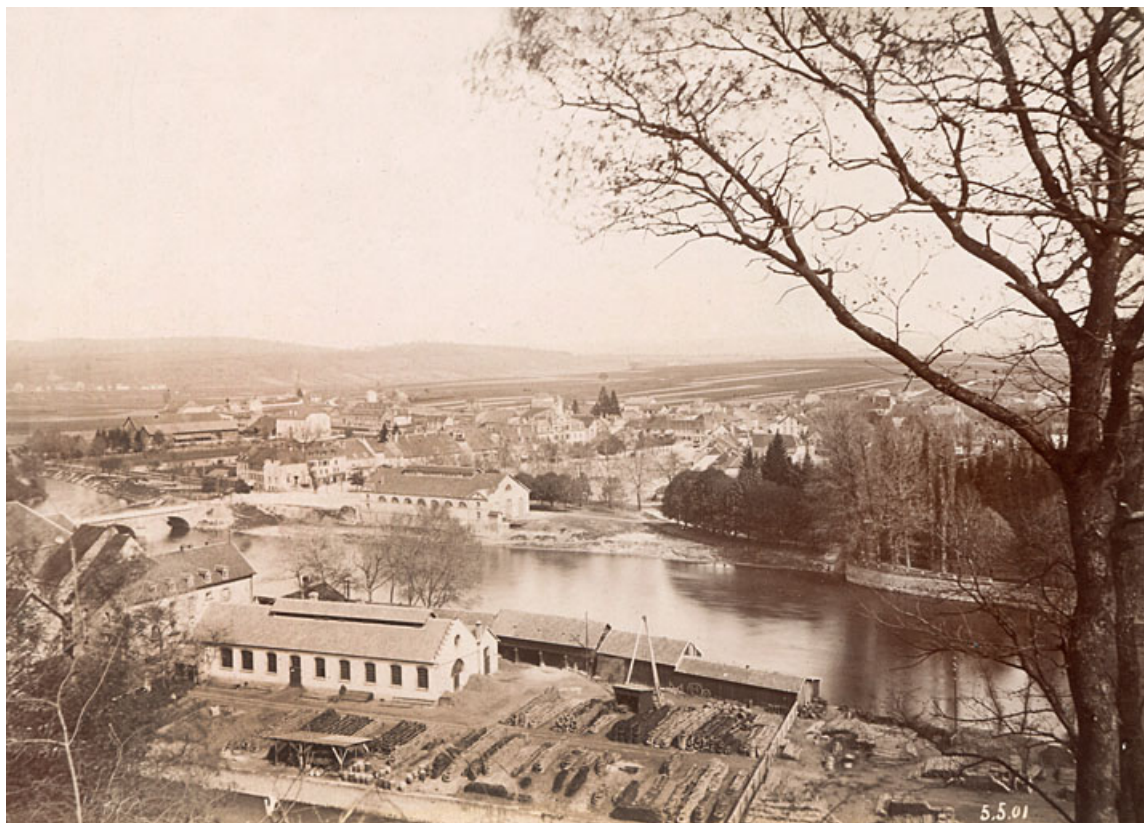
Vue d'ensemble de l'usine des Boillots depuis l'ouest.
