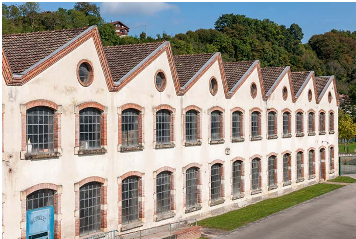
Façade est de l'atelier de fabrication. 25, L'Isle-sur-le-Doubs rue de la Velle
