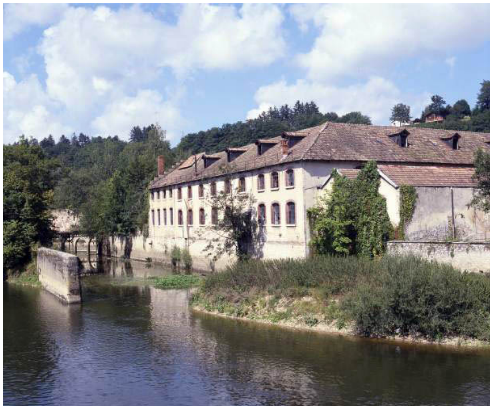
Vue de la façade et de la coursière.
