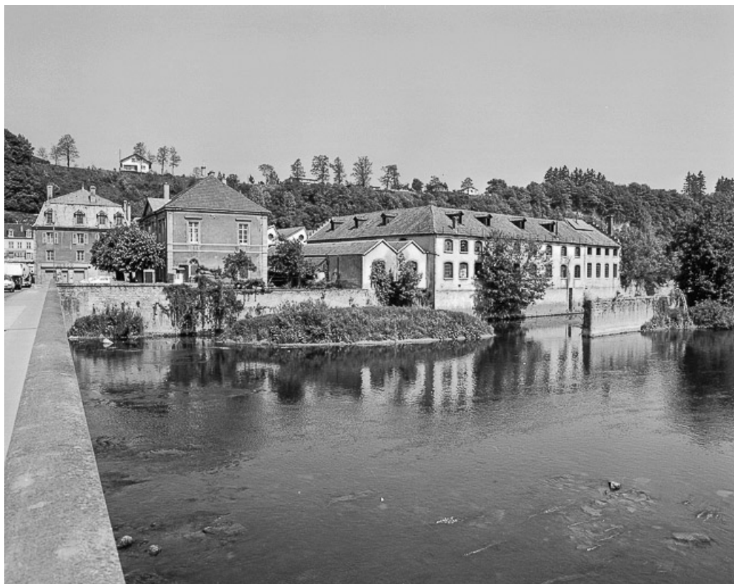
Vue générale avec la fabrique.
