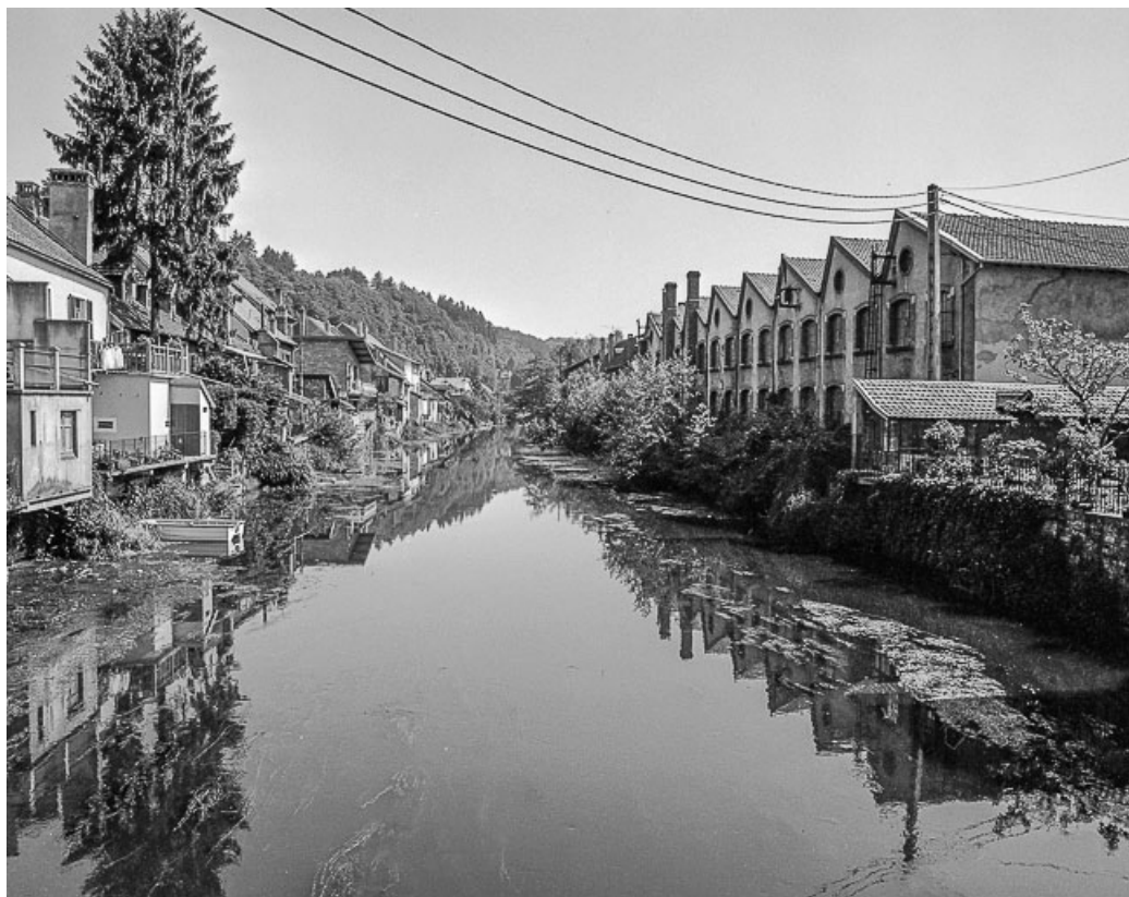
Canal. Arrière de la fabrique.
