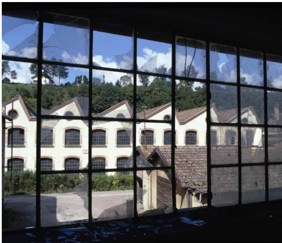
Vue de la cour intérieure depuis un atelier.
