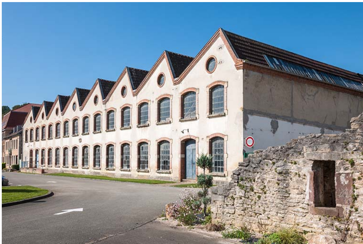
Atelier de fabrication. Vue de trois quarts droite.
