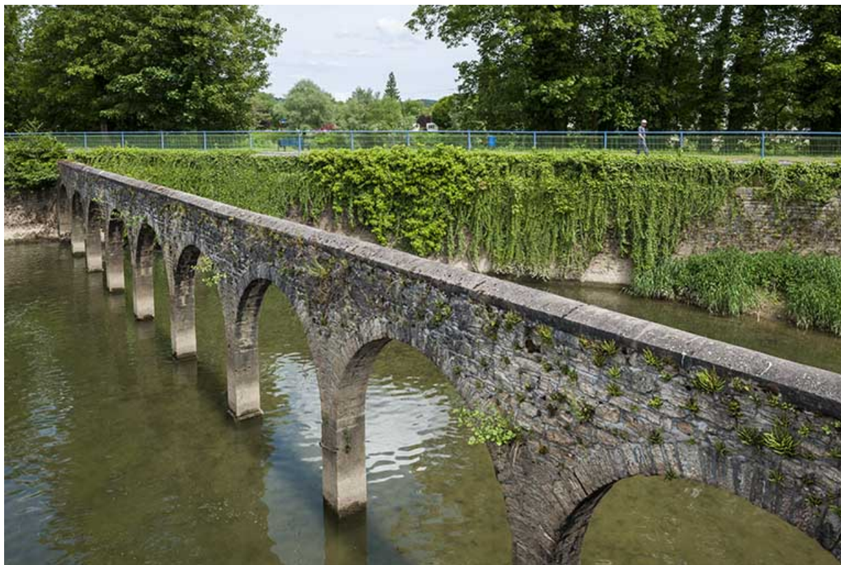
Arcades enjambant l'ancien canal de fuite.
