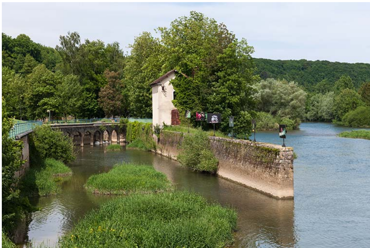
L'ancien canal de fuite et le transformateur.
