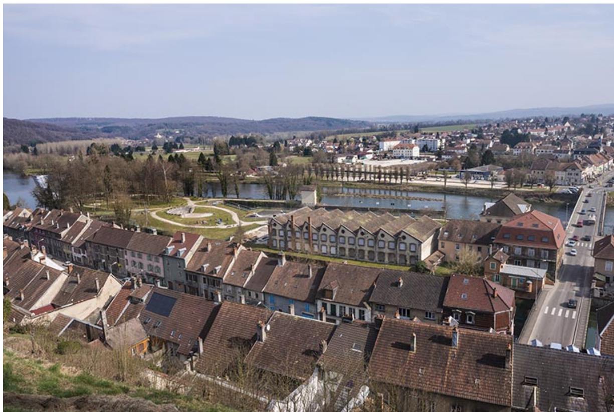
Vue d'ensemble plongeante sur le site des forges.
