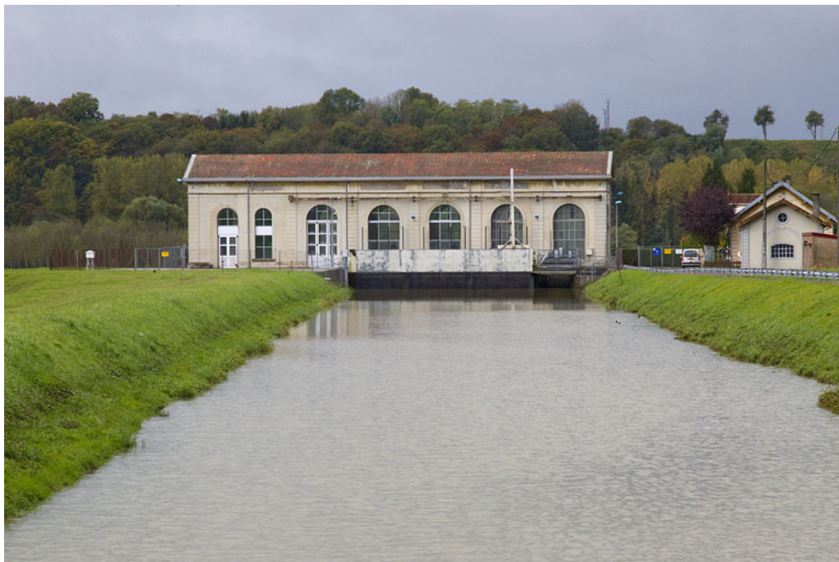
Façade est de la centrale depuis l'amont du bief.
