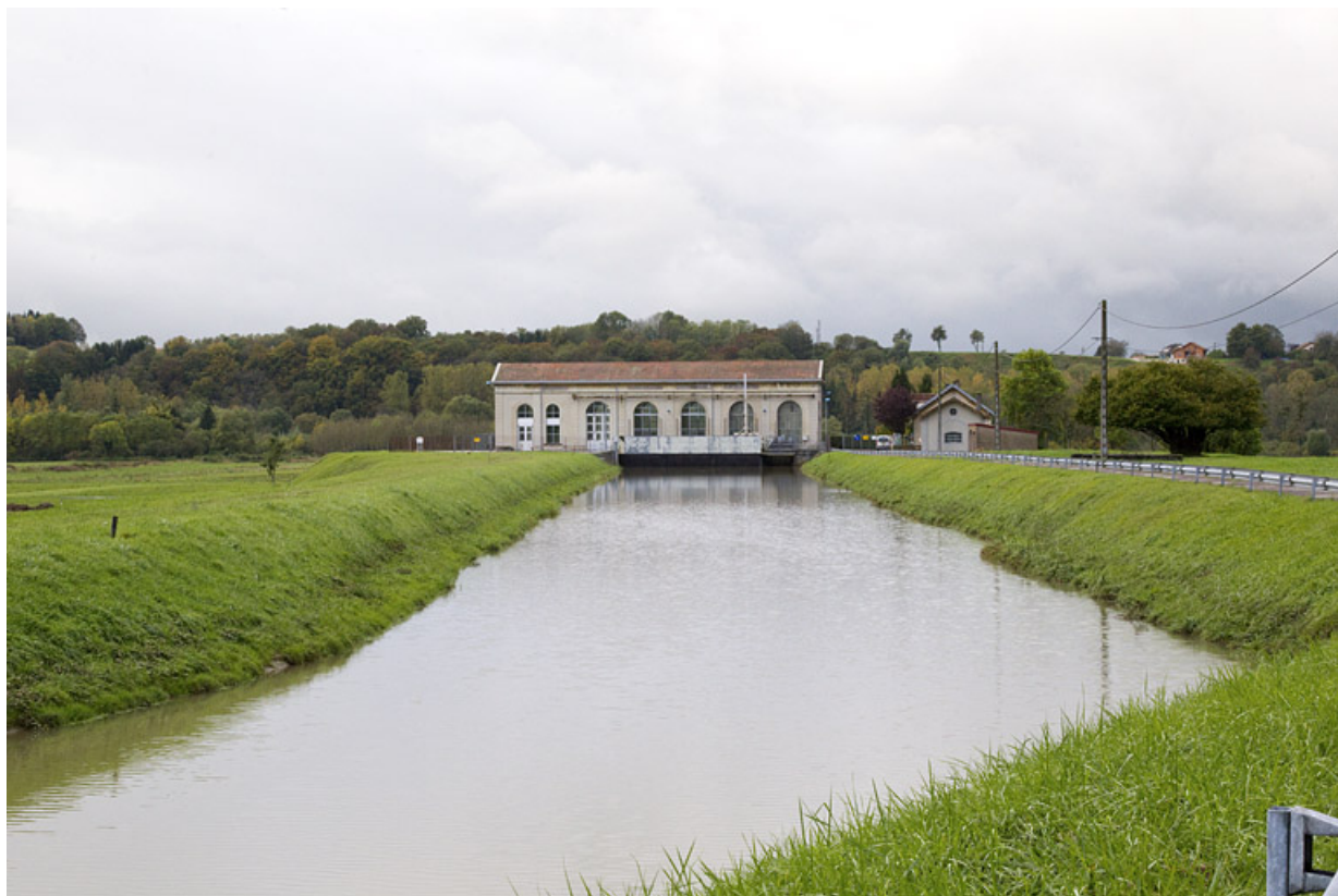
La centrale depuis le bief d'aménée.
