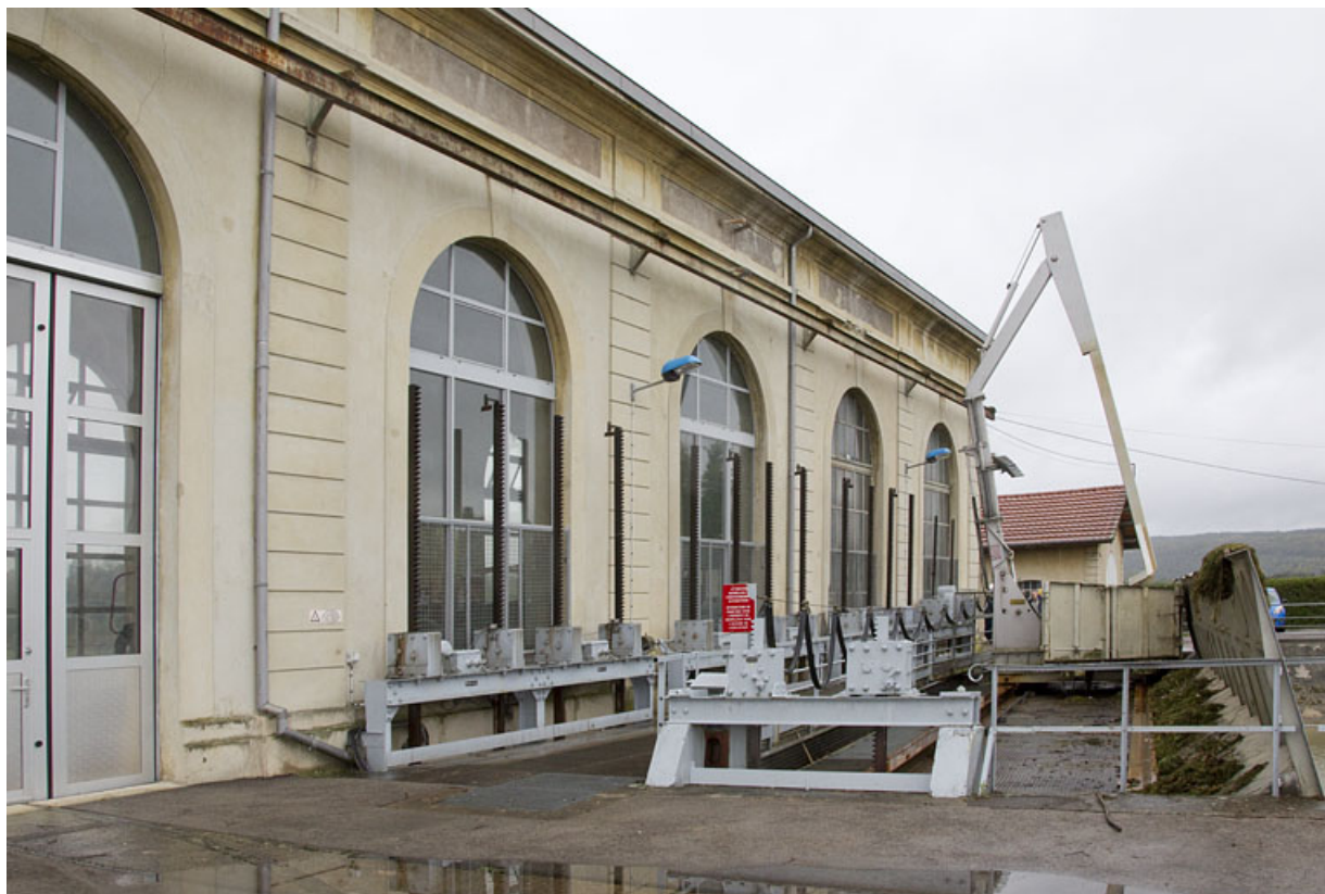
Façade est de la centrale. Vannage d'admission et dégrilleur.
