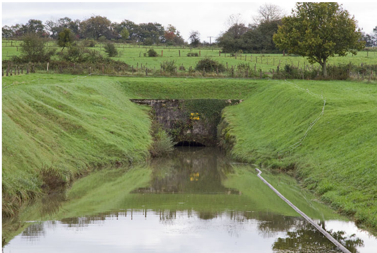
Bief d'aménée. Tête du tunnel.
