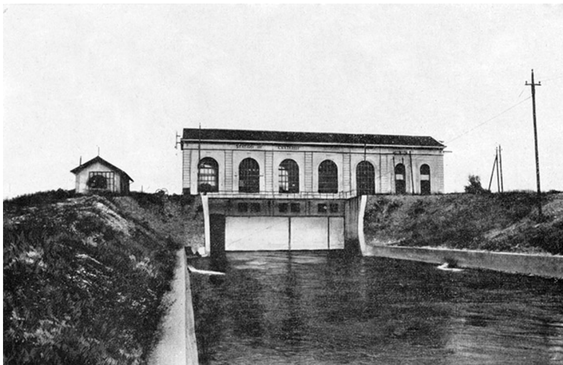
USINE DU CHATELOT : Vue aval.
