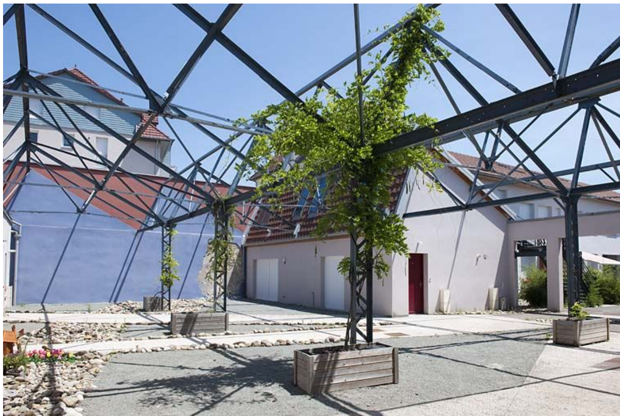
Réhabilitation d'un bâtiment industriel. Vue depuis le nord-ouest.
