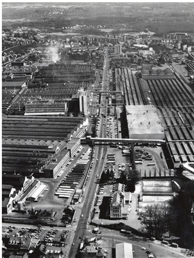
Vue plongeante depuis l'ouest en 1968.
