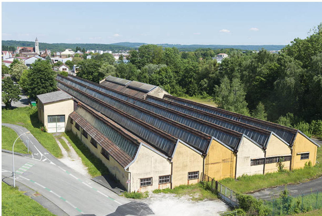
Vue plongeante sur l'ancien atelier de tréfilerie.
