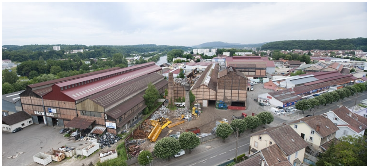
Vue plongeante panoramique depuis l'est.
