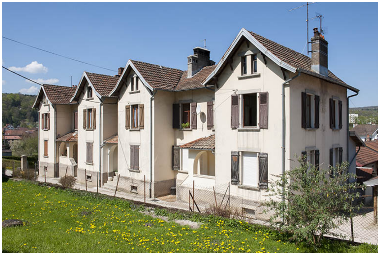
Logement de cadres (6 logements). Vue de trois quarts.
