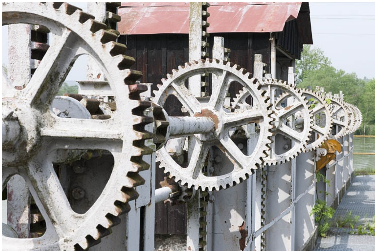
Vannage du barrage. Détail des engrenages.
