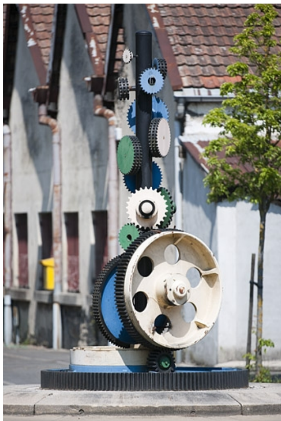
Sculpture du giratoire et sheds de l'atelier de laitonnerie.
