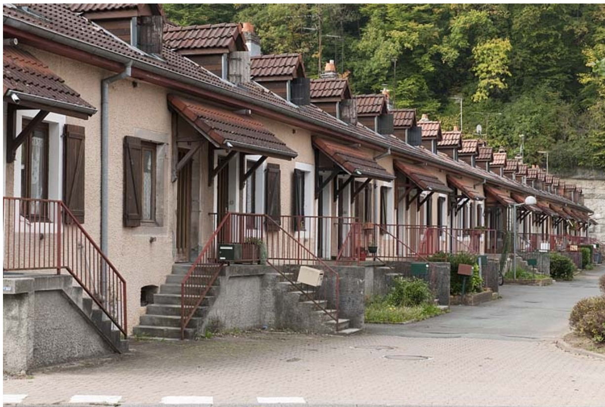
Caserne F. Façade antérieure vue de trois quarts.
