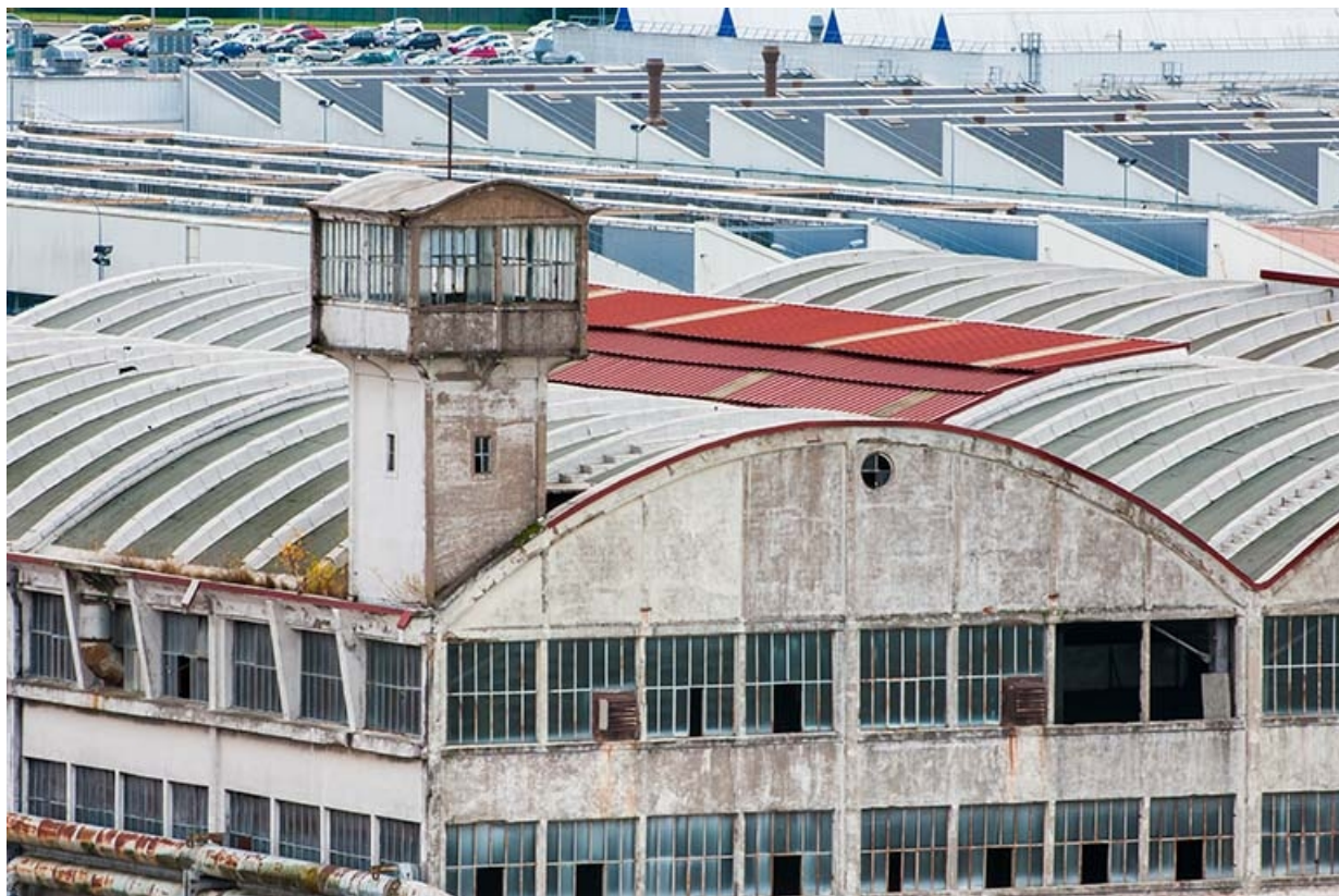
Détail de l'ancien entrepôt des véhicules (201).
