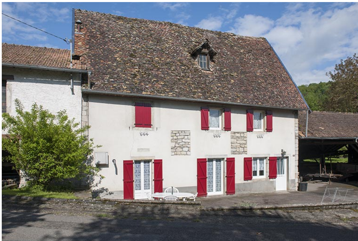
Façade est du moulin.
