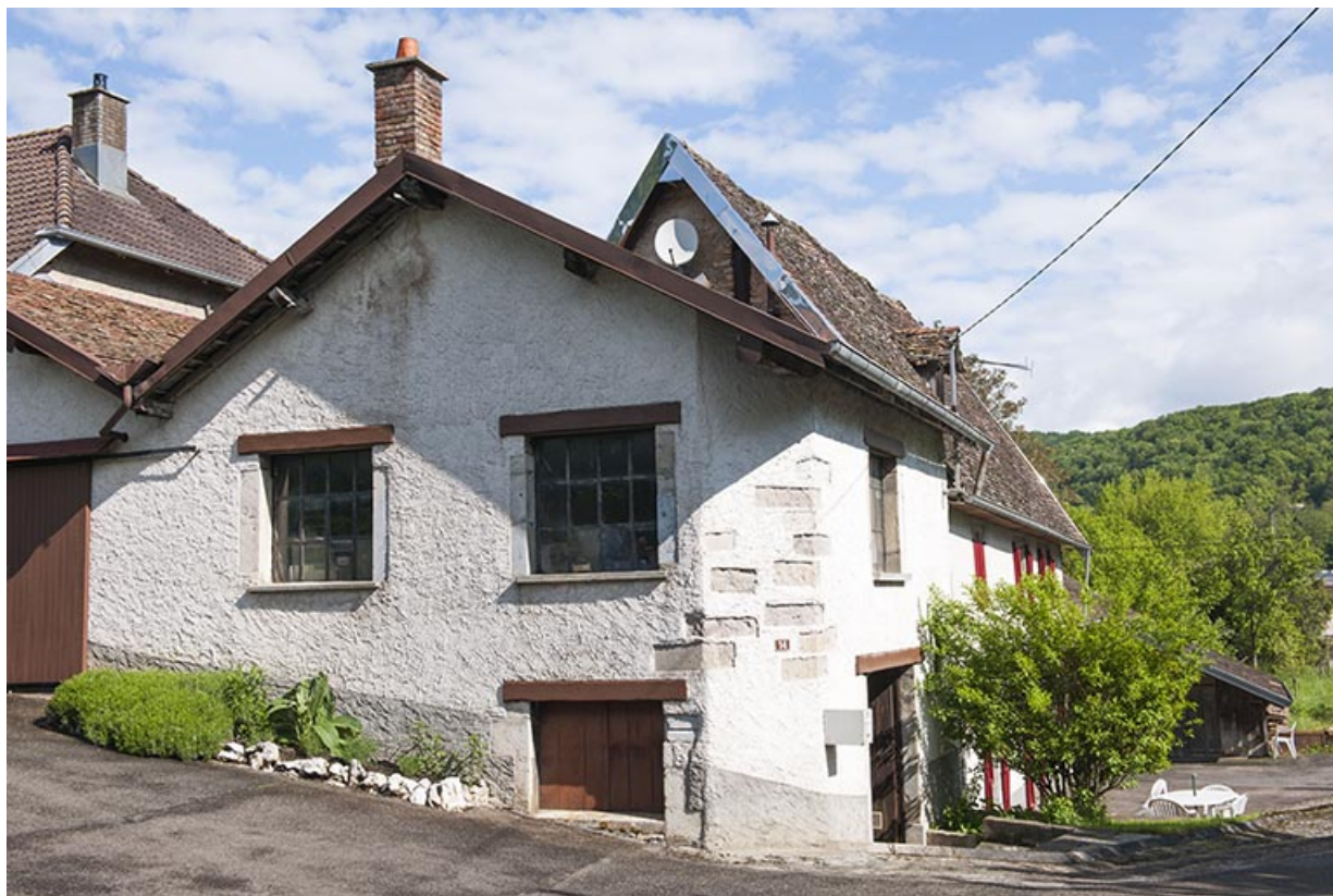
Partie est de la scierie : atelier d'affûtage.
