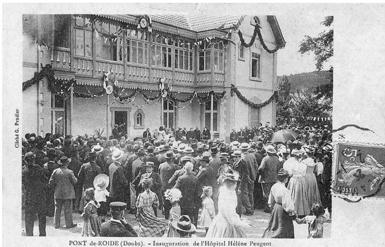
Pont-de-Roide (Doubs) - Inauguration de l'hôpital Hélène Peugeot. Carte postale, cliché G. Pradier, s.d. [1907] 25, Pont-de-Roide, 42 rue du général Herr
