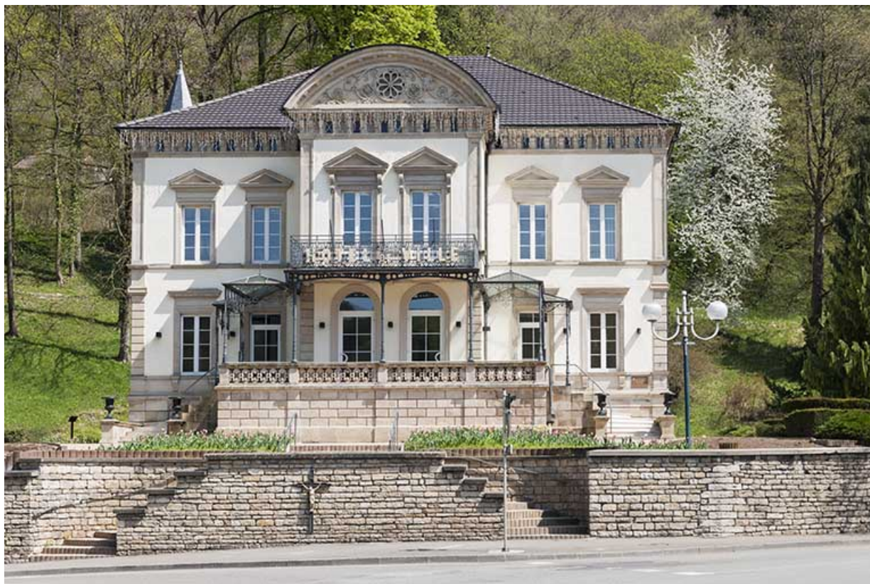
Façade antérieure vue de face.
