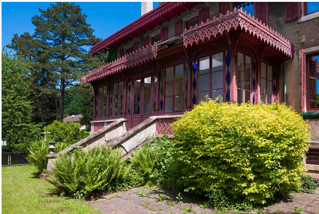
Véranda sur la façade ouest.
