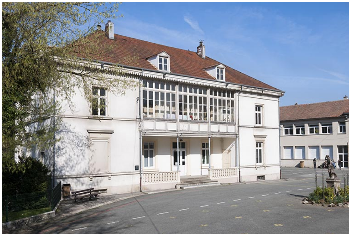
Façade est vue de trois quarts gauche. 25, Pont-de-Roide, 14 rue du général Herr
