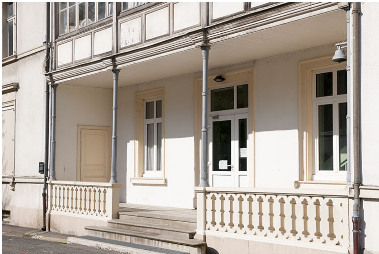
Accès au rez-de-chaussée de la façade est.. 25, Pont-de-Roide, 14 rue du général Herr
