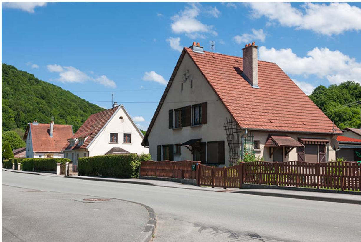
Vue d'ensemble depuis l'ouest. 25, Pont-de-Roide rue d'Helvétie
