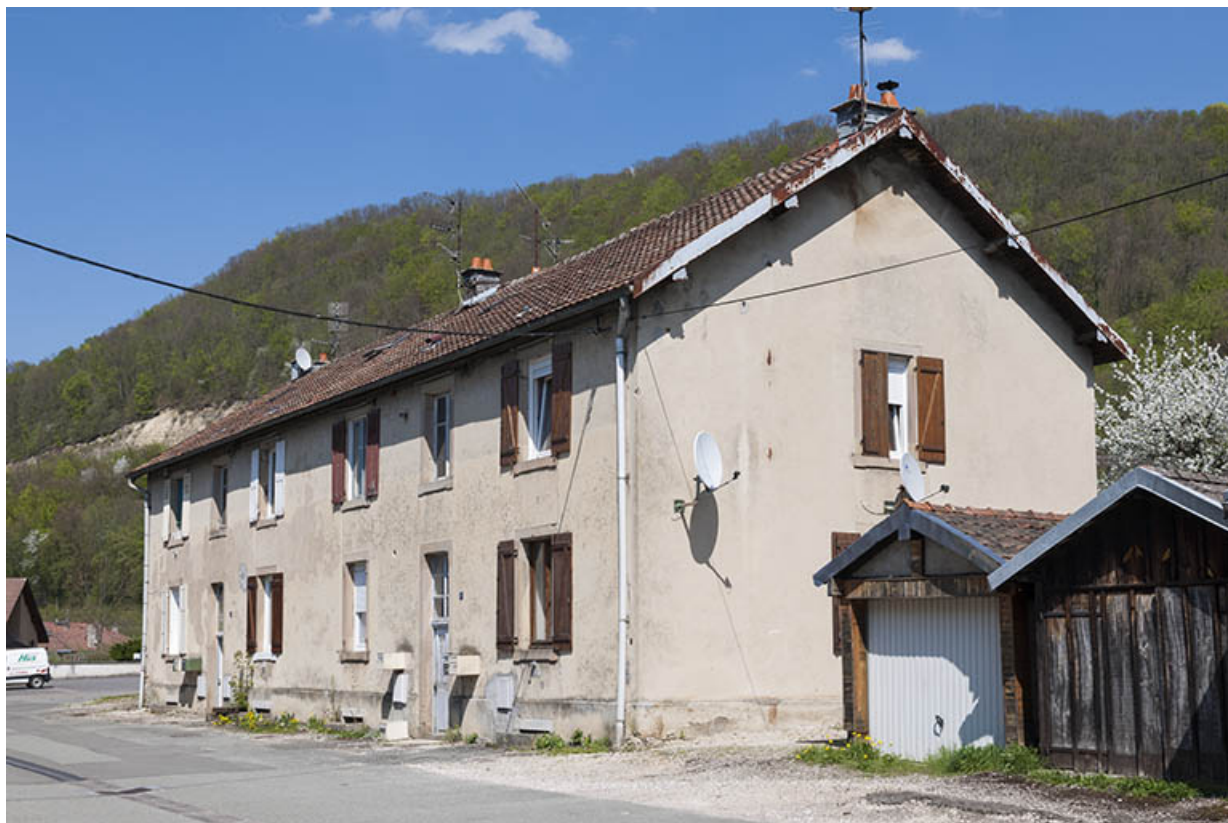
Habitation (6-8 logements) vue de trois quarts.
