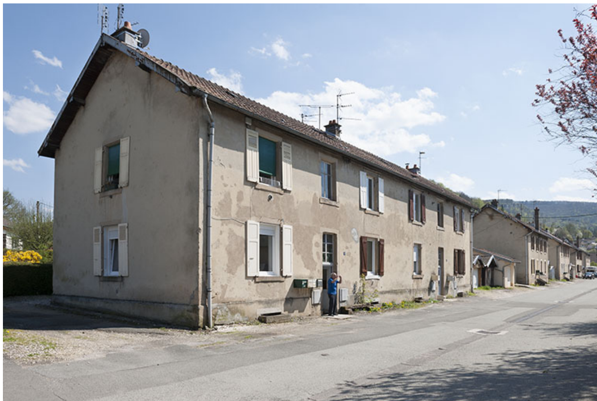
Façades ouest des habitations (côté impair). 25, Pont-de-Roide rue du 4ème RTT
