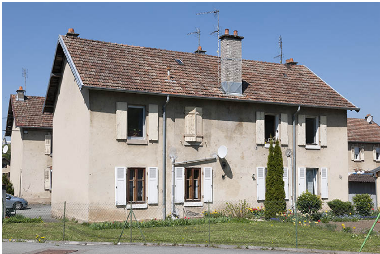
Façade postérieure d'une habitation.
