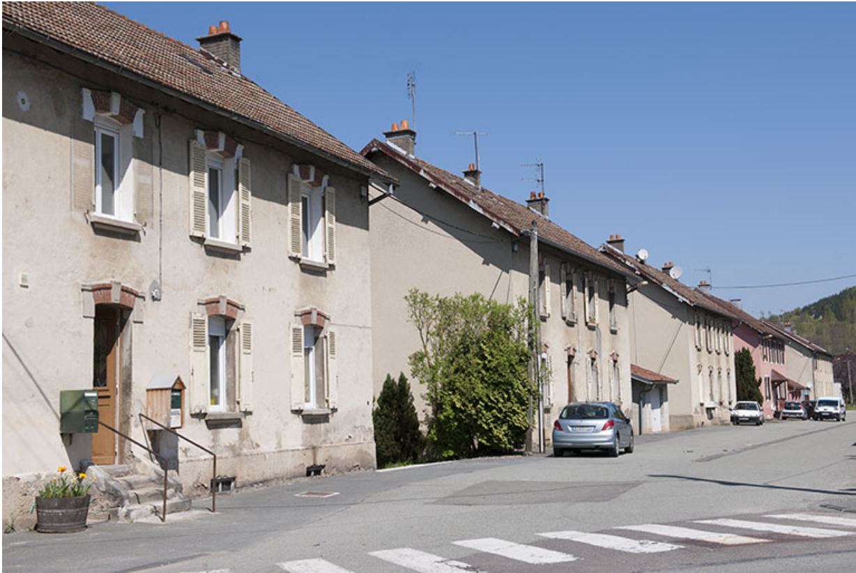
Alignement de façades rue du 4e R.T.T. 25, Pont-de-Roide rue du 4ème RTT
