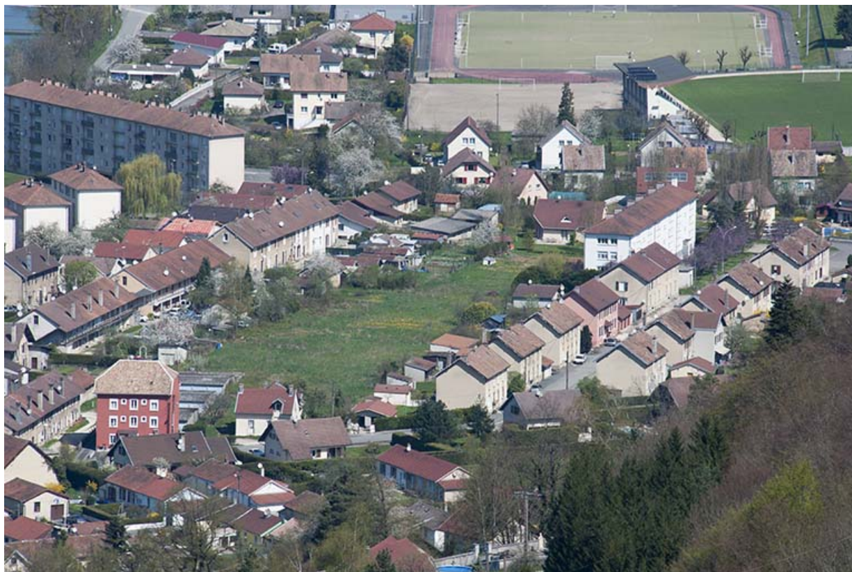
Vue d'ensemble depuis le sud (à droite). 25, Pont-de-Roide rue du 4ème RTT
