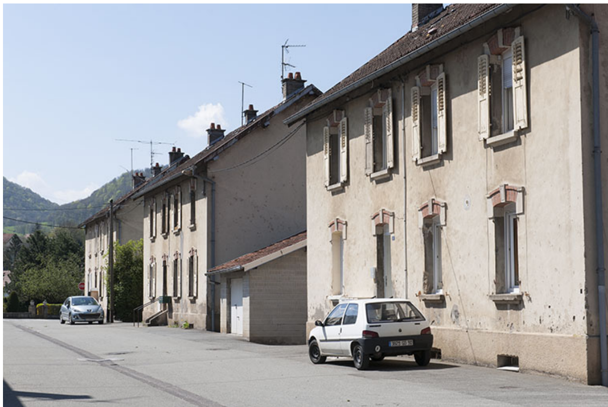
Façades antérieures d'habitations (3-4 logements). 25, Pont-de-Roide rue du 4ème RTT
