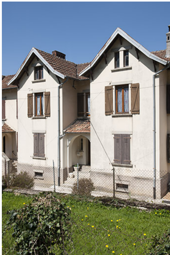
Logement de cadres. Détail de la façade sud. 25, Pont-de-Roide rue Emile Peugeot
