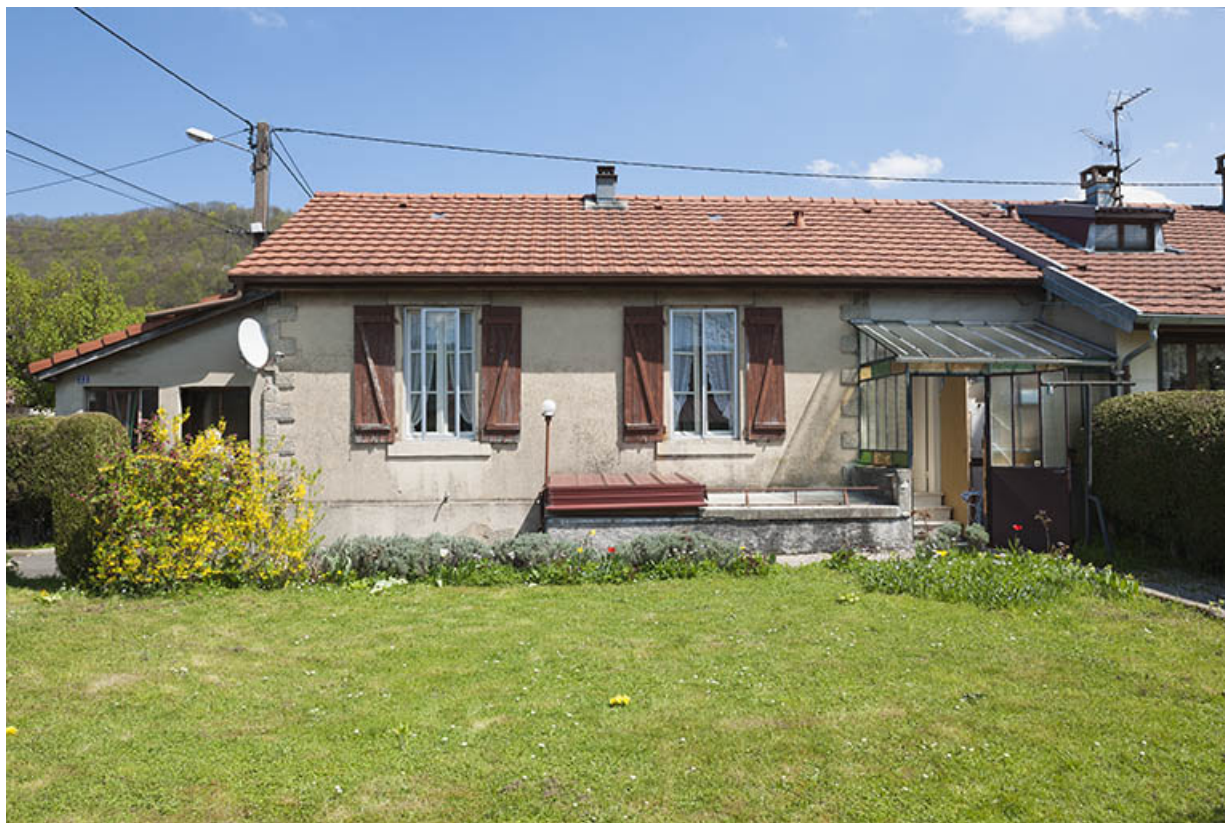
Façade postérieure d'une maison individuelle.
