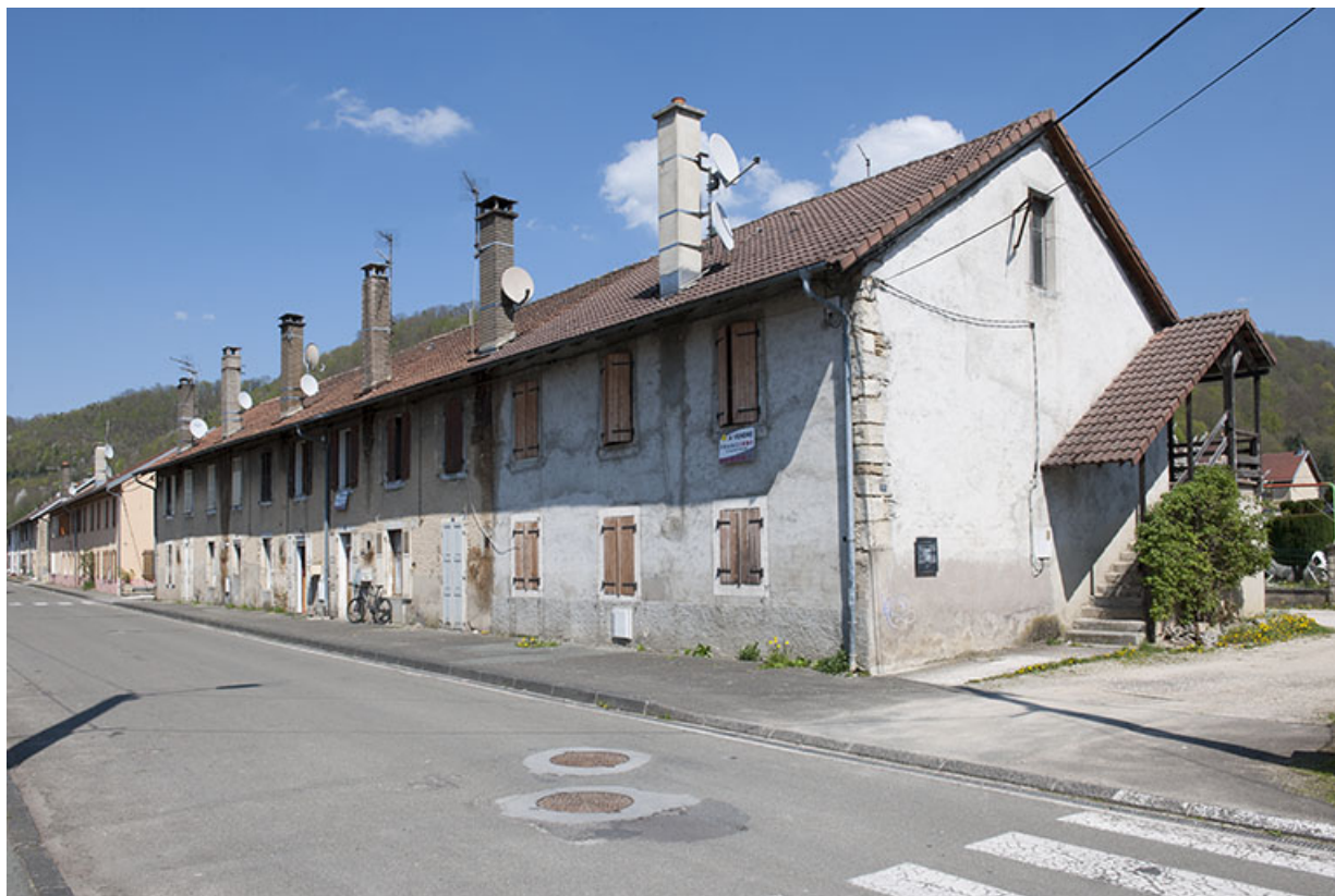
Alignement des façades des casernes (côté impair).
