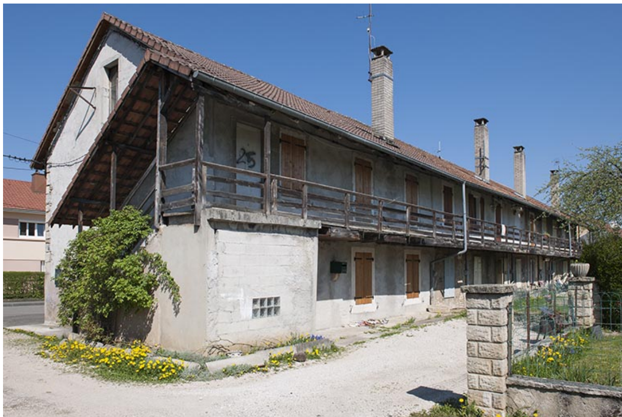
Façade postérieure d'une caserne.
