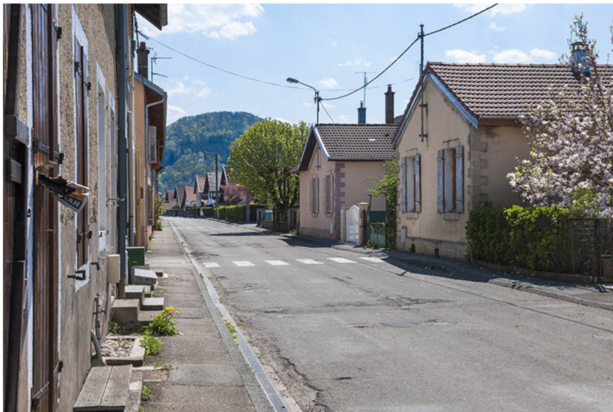
Vue d'ensemble de la rue depuis le nord.
