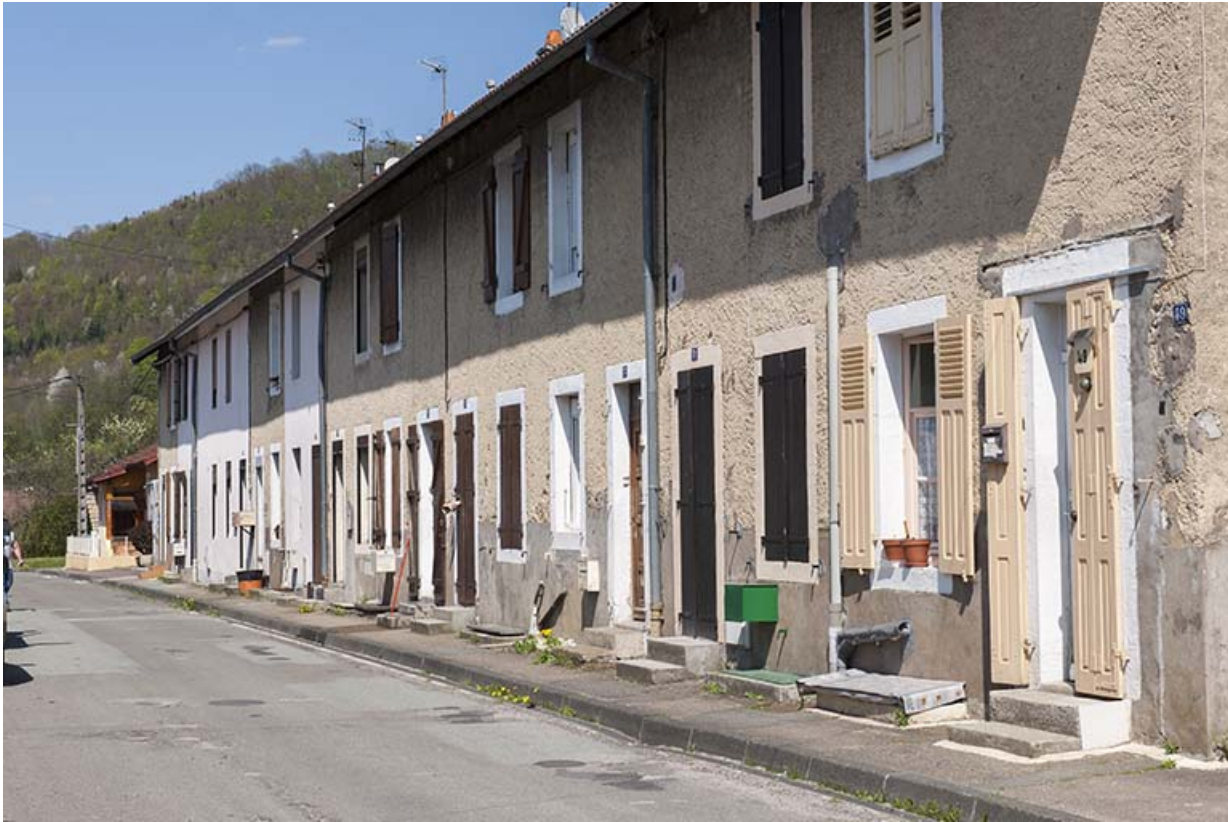
Vue de trois quarts de la façade d'une caserne.
