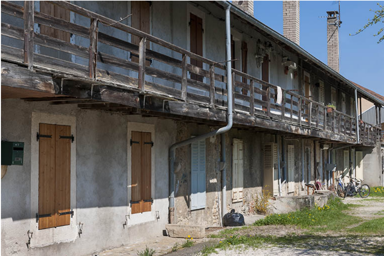
Façade postérieure d'une caserne. Détail de la galerie de desserte. 25, Pont-de-Roide rue Hélène Peugeot
