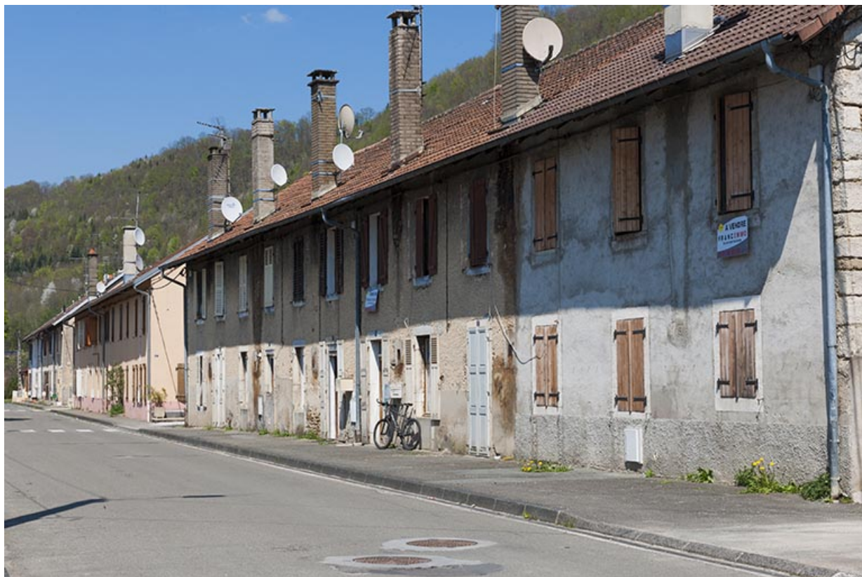
Habitations de type caserne (côté impair). 25, Pont-de-Roide rue Hélène Peugeot
