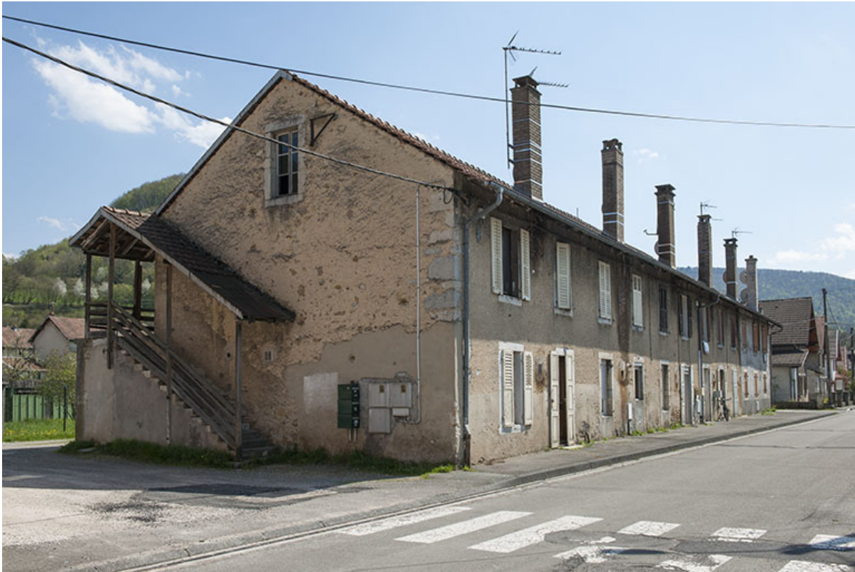
Habitation de type caserne vue de trois quarts gauche.
