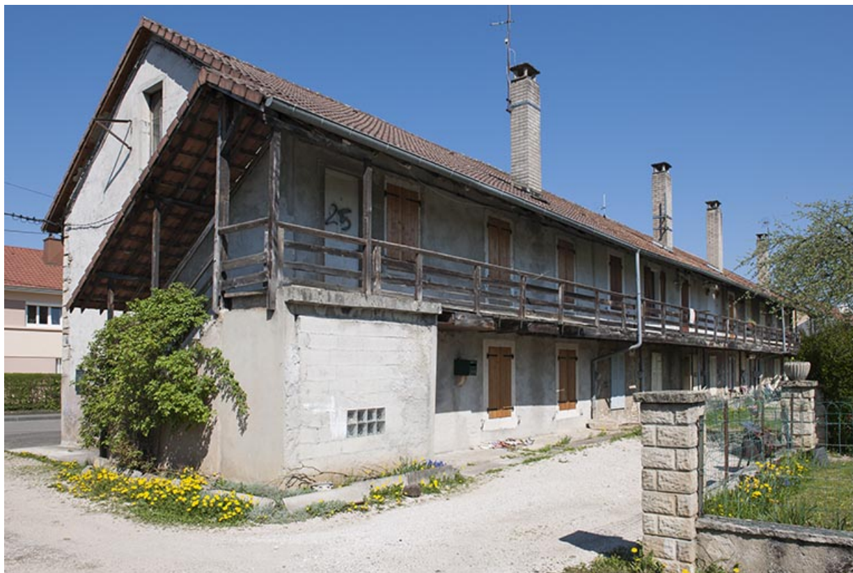
Façade postérieure d'une caserne.
