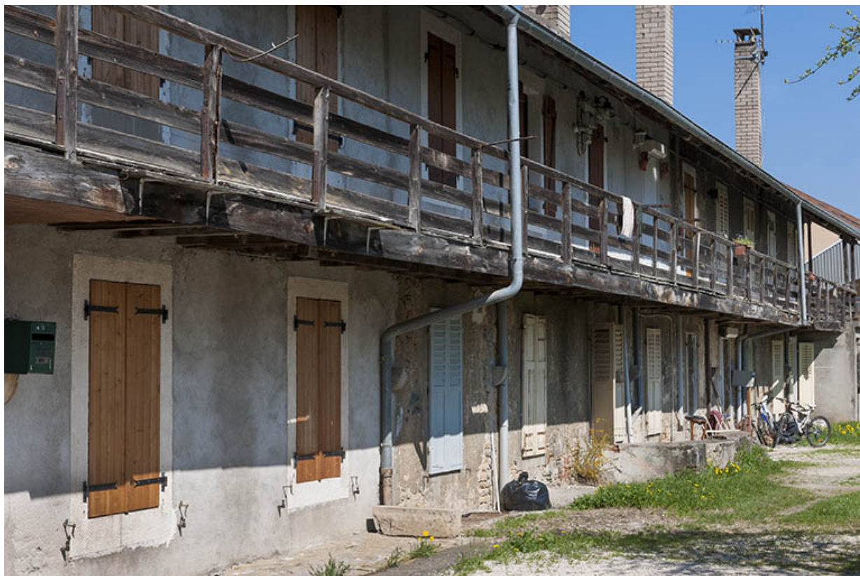
Façade postérieure d'une caserne. Détail de la galerie de desserte. 25, Pont-de-Roide rue Hélène Peugeot
