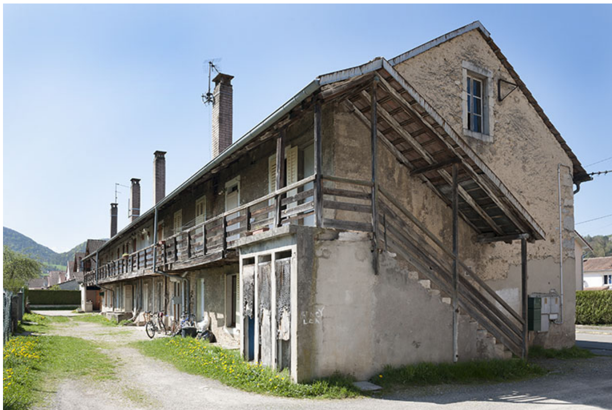
Habitation de type caserne. Escalier sur le pignon et galerie de desserte.
