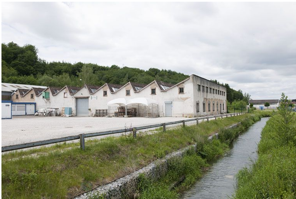
Atelier de menuiserie depuis l'est. 25, Fesches-le-Châtel
