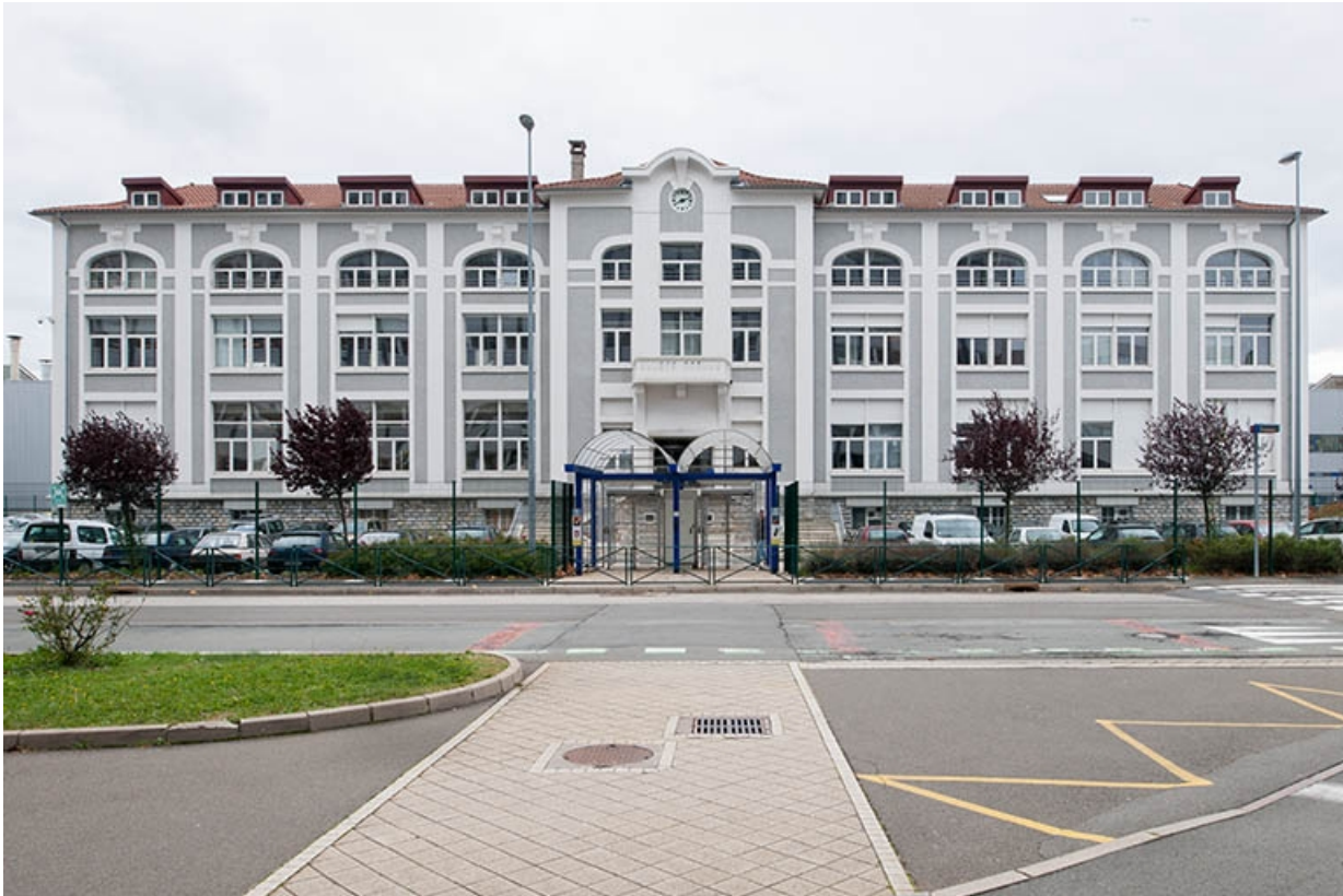
Bâtiment du Cercle. Vue de face.
