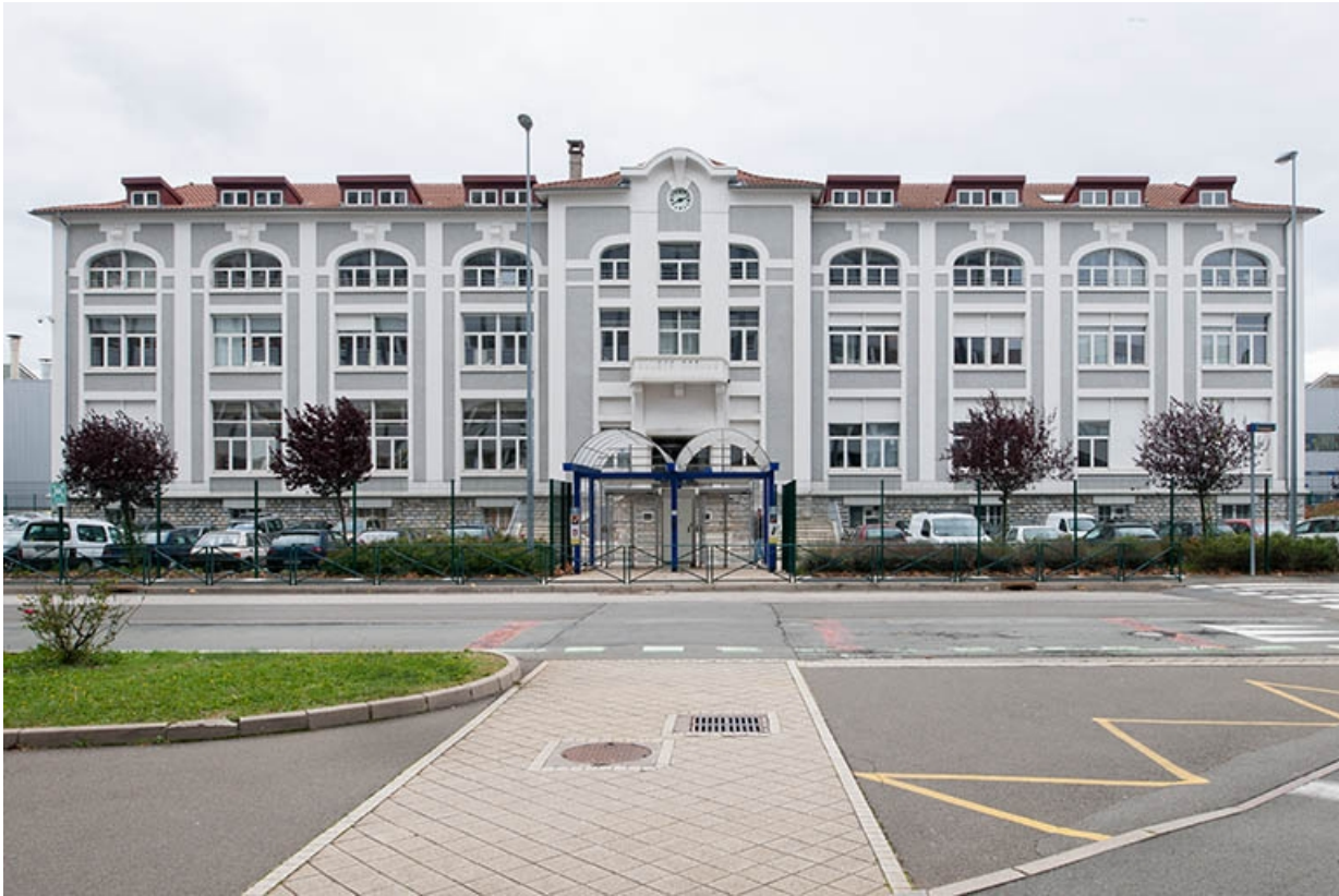
Bâtiment du Cercle. Vue de face.
