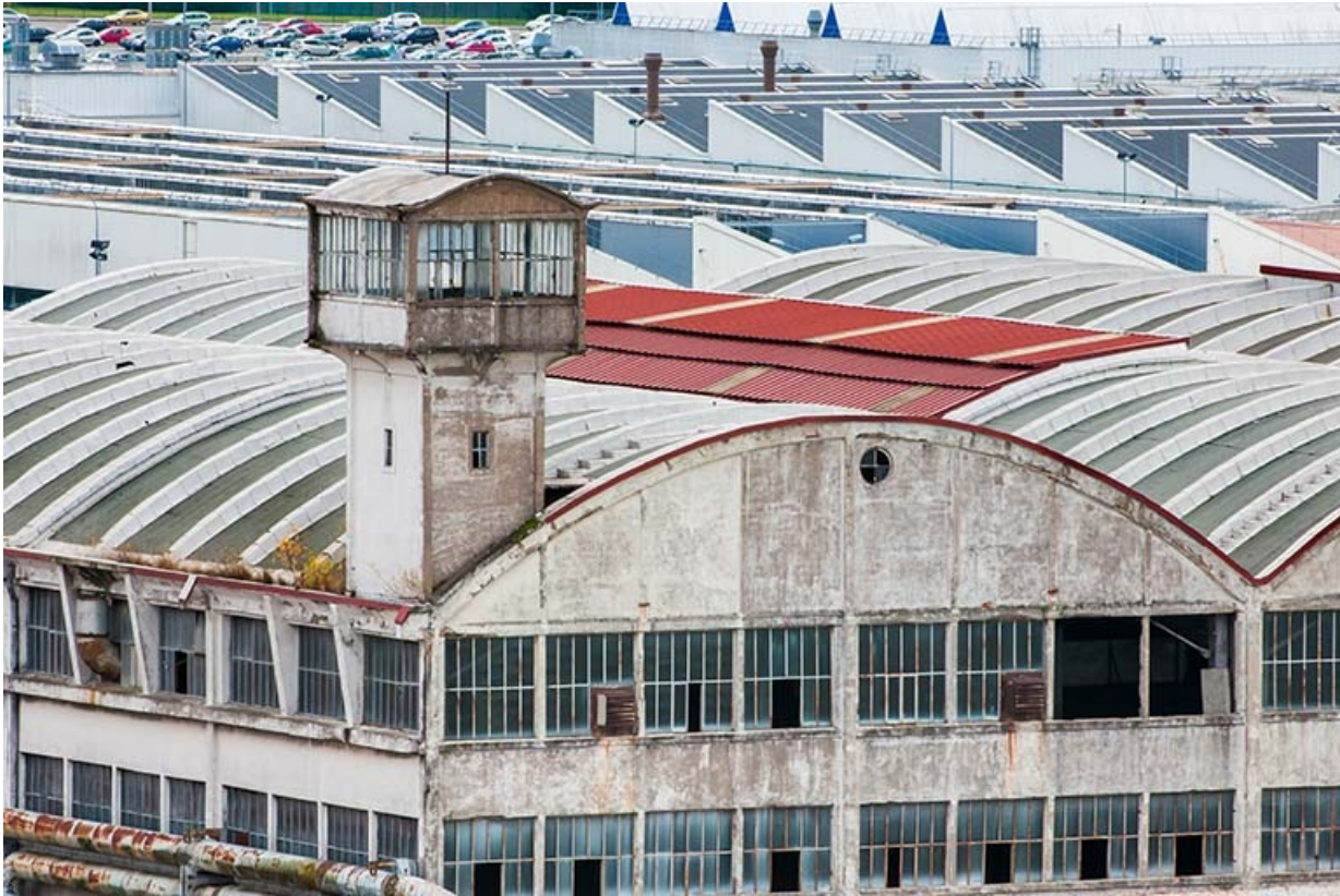
Détail de l'ancien entrepôt des véhicules (201).
