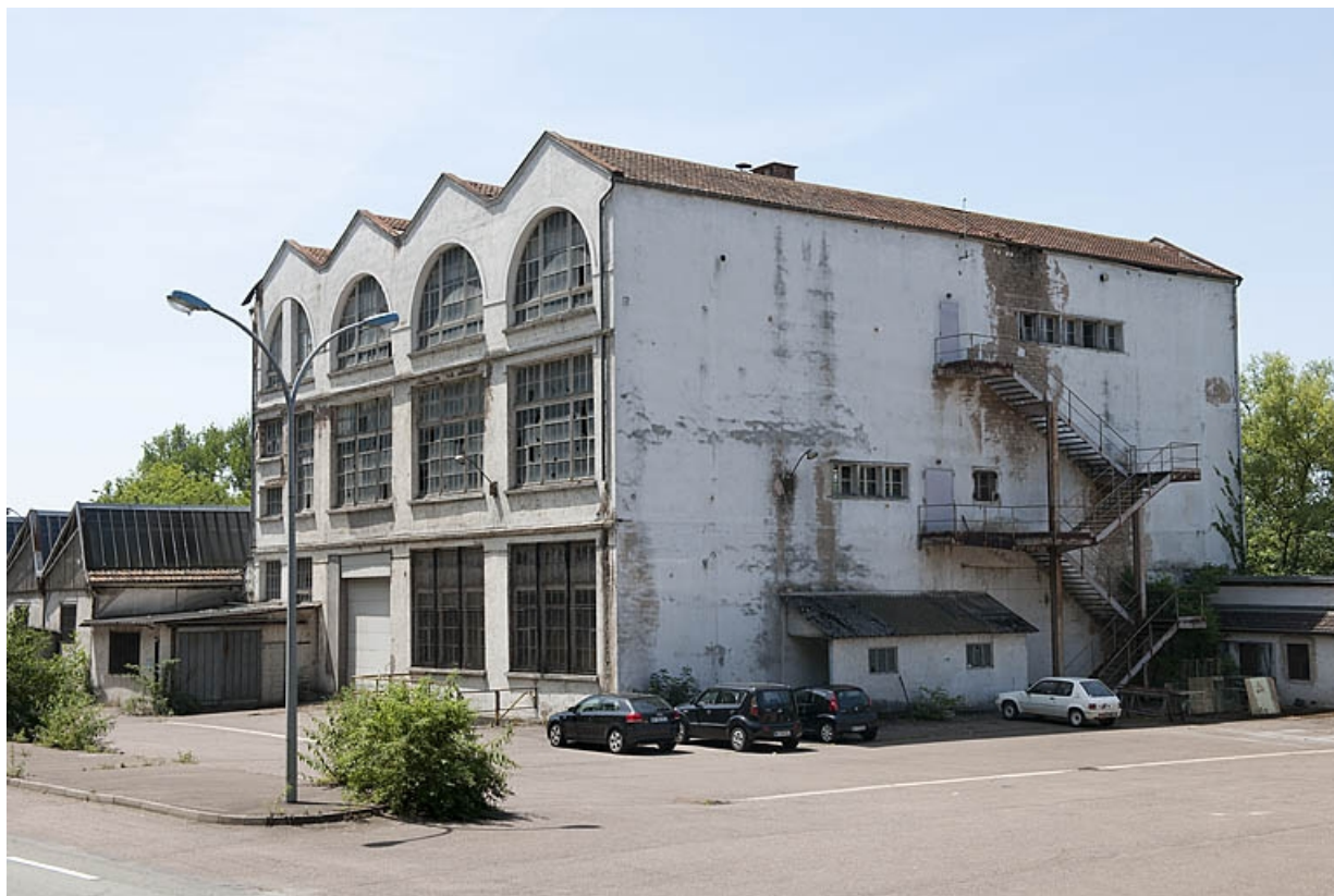
Atelier des presses (puis des scies) vu de trois quarts.
