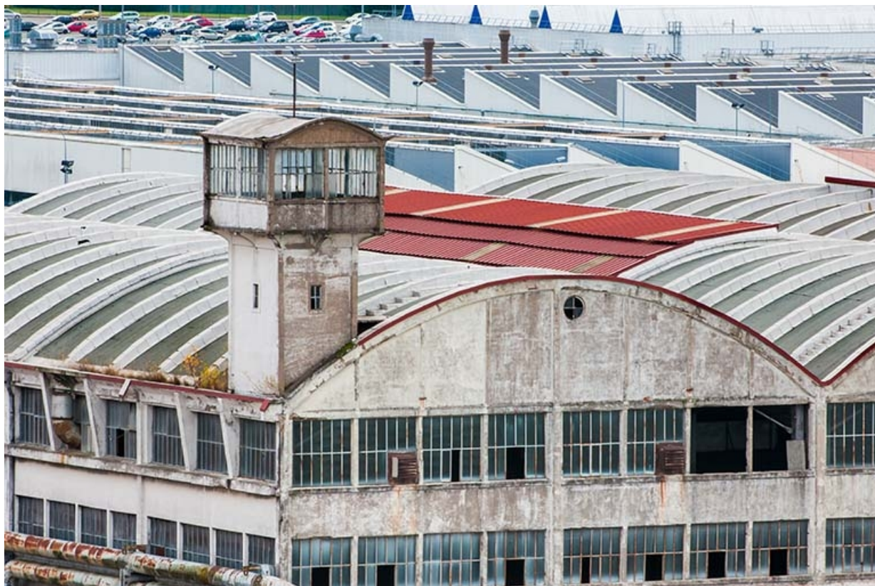
Détail de l'ancien entrepôt des véhicules (201).
