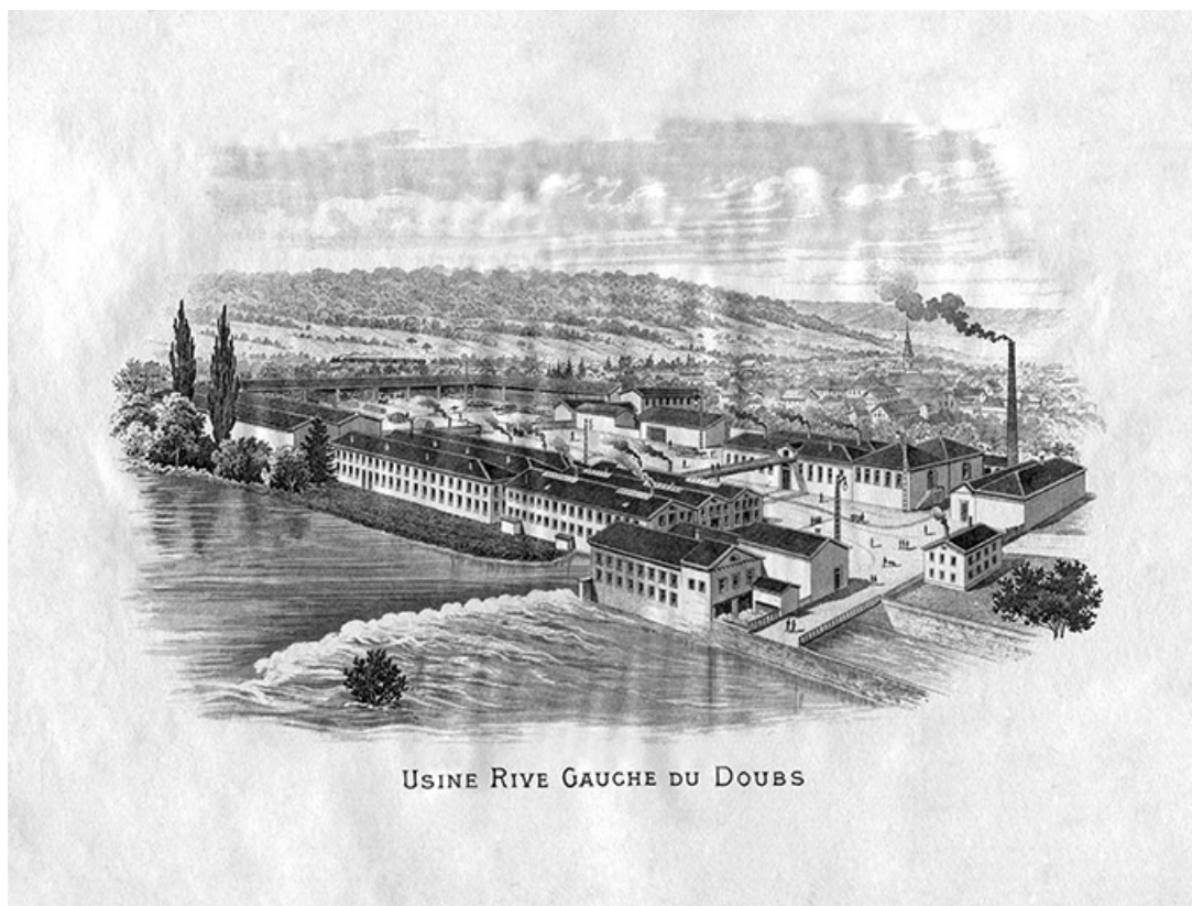
Usine rive gauche du Doubs, s.d. [vers 1911]. 25, Pont-de-Roide rue de Saint-Hippolyte
