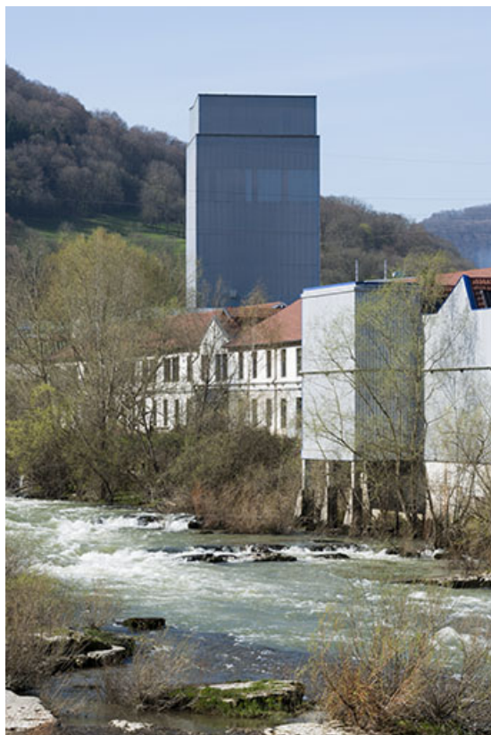
Ateliers de l'usine de laminage (rive gauche). 25, Pont-de-Roide rue de Saint-Hippolyte
