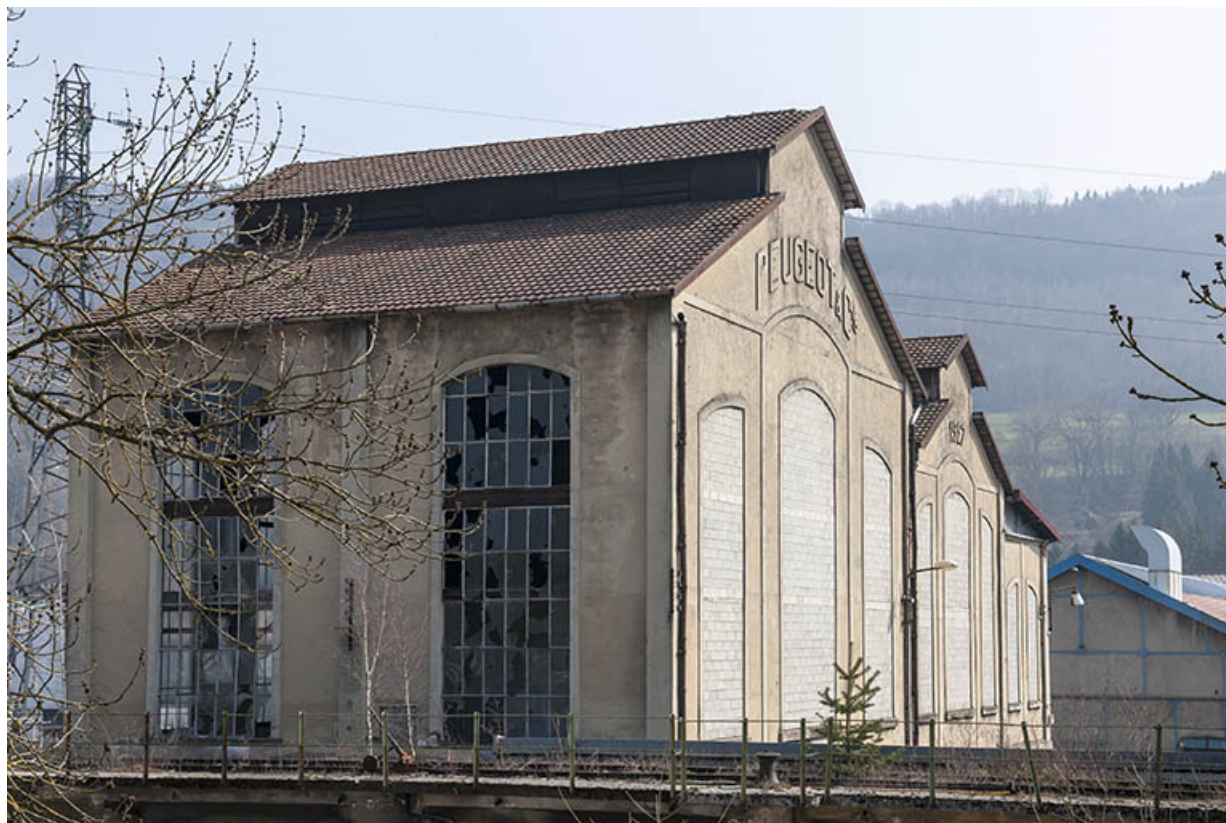
La centrale thermique vue de trois quarts arrière.
