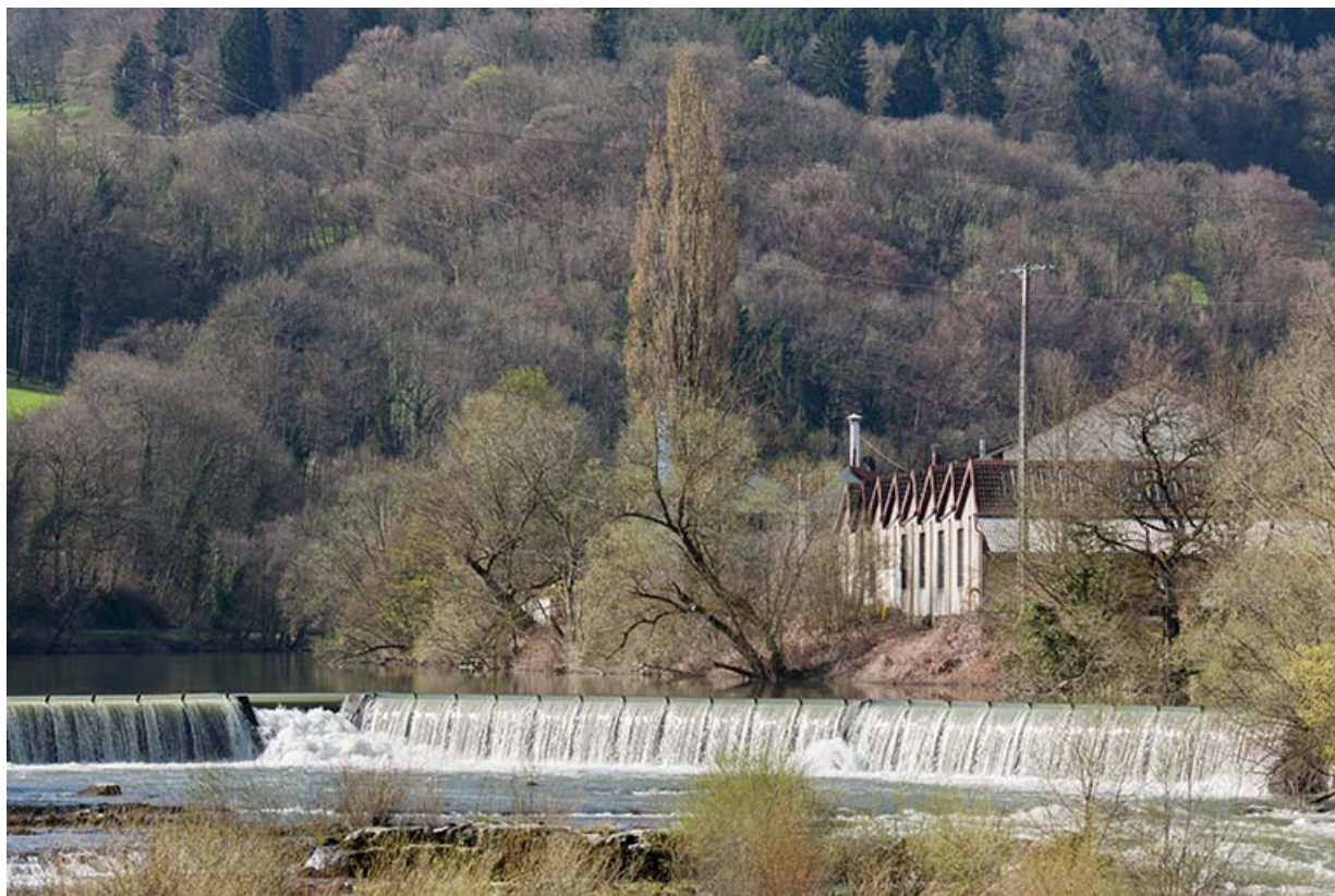
Le barrage et les ateliers de la rive gauche.
