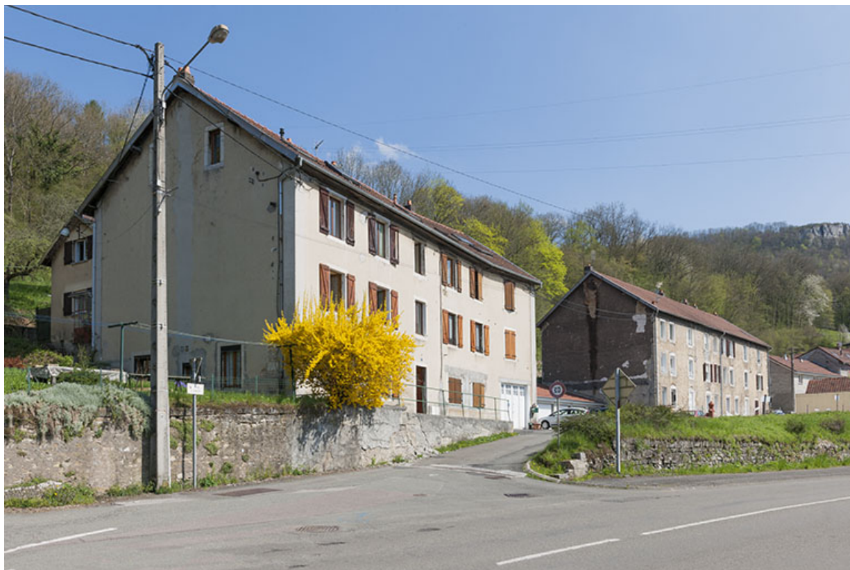
Logements ouvriers (route de Chatey). 25, Pont-de-Roide rue de Saint-Hippolyte
