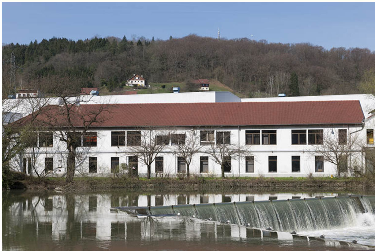
Bâtiment industriel de la rive gauche. 25, Pont-de-Roide rue de Saint-Hippolyte
