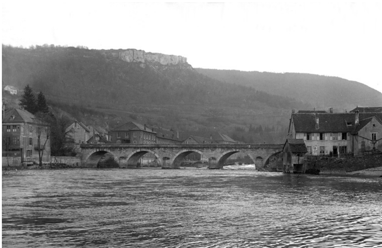
Vue d'ensemble depuis l'aval du pont, fotogr., vers 1930.
