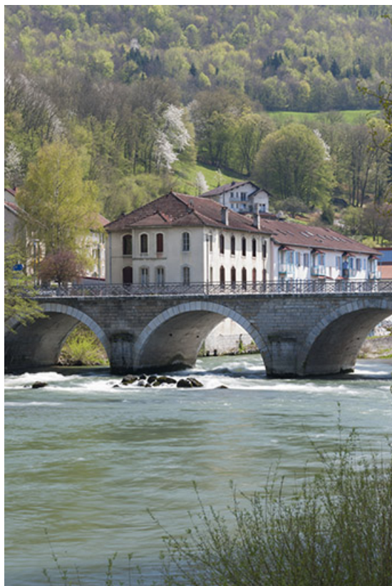
Bâtiments de la rive droite depuis l'aval du pont.
