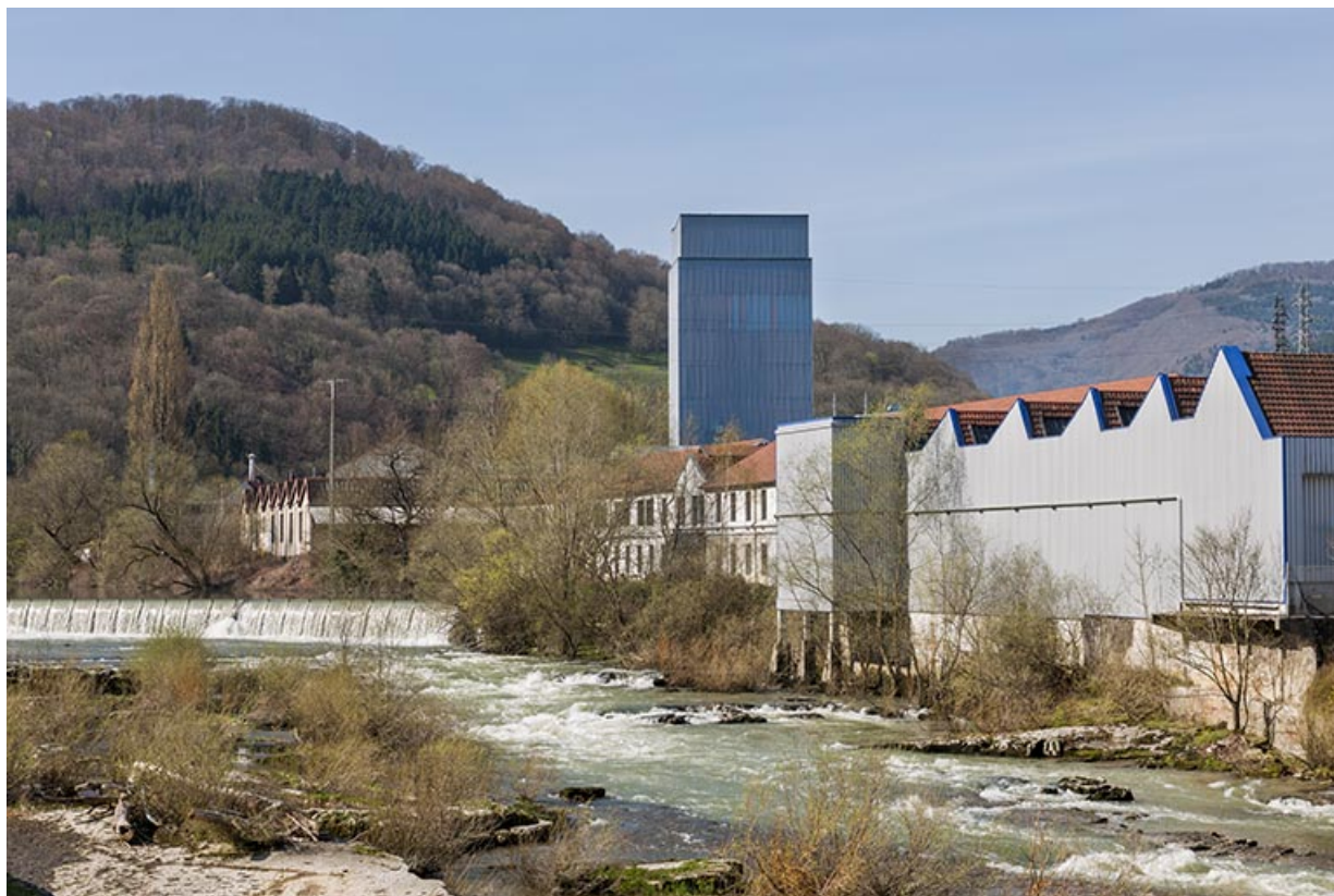
Usine rive gauche. Vue depuis le pont.
