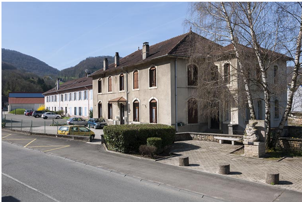
Bâtiments de bureaux (rive droite) depuis le nord-est. 25, Pont-de-Roide rue de Saint-Hippolyte
