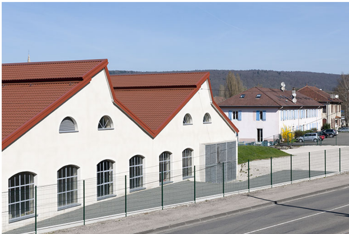
Pignons de la centrale hydroélectrique. 25, Pont-de-Roide rue de Saint-Hippolyte
