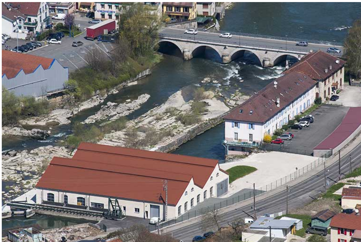
Bâtiments de bureaux en aval du site. 25, Pont-de-Roide rue de Saint-Hippolyte
