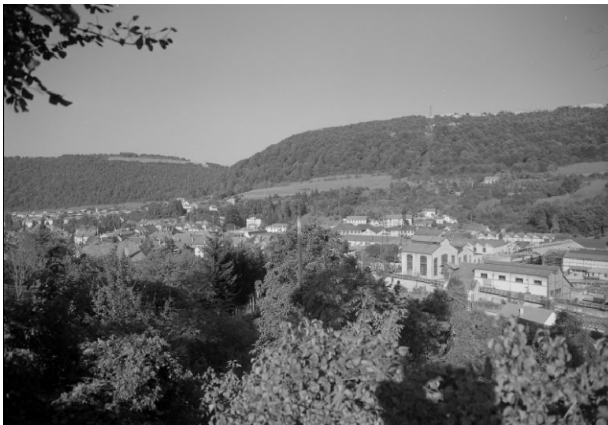
La centrale thermique [1re moitié 20e siècle]. 25, Pont-de-Roide rue de Saint-Hippolyte
