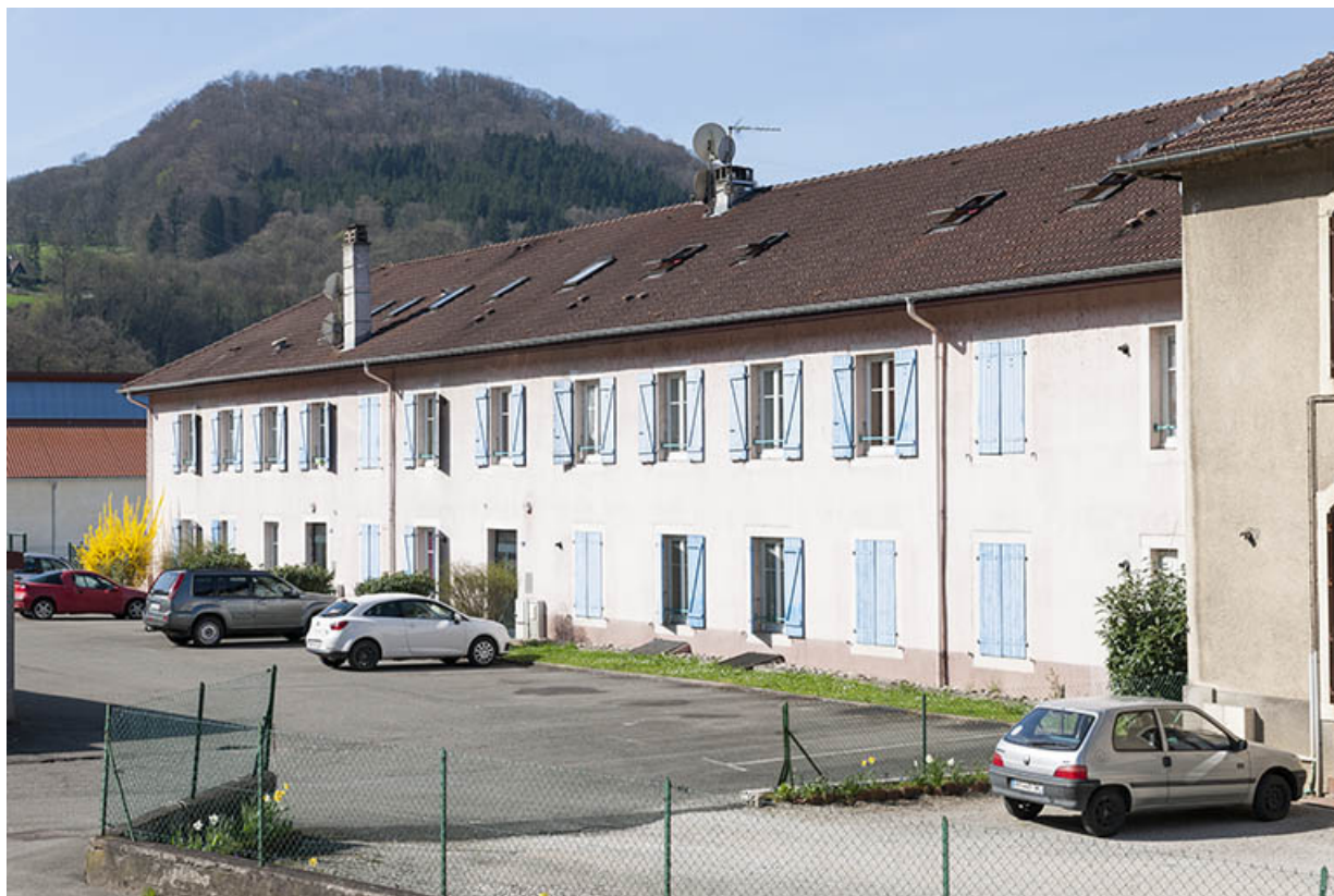
Bâtiment de bureaux (rive droite).
