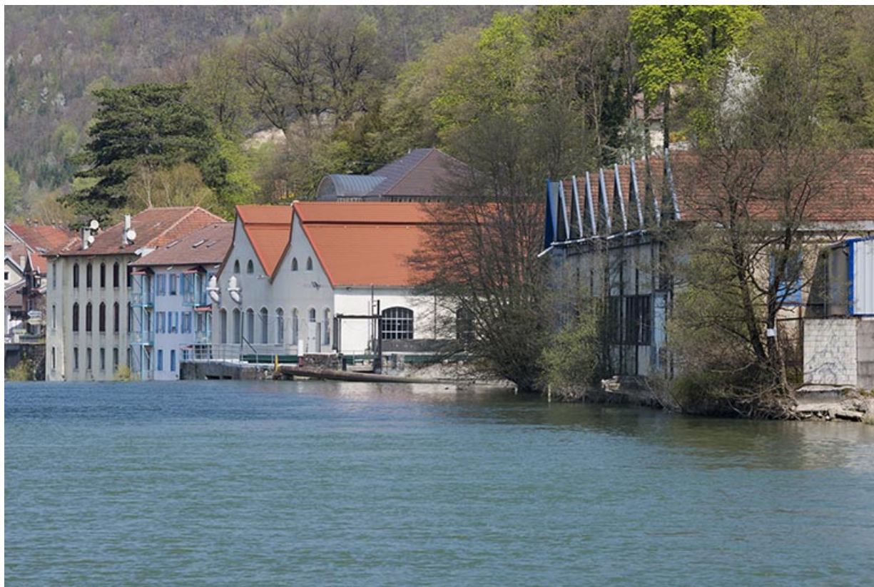
Vue de l'usine rive droite depuis l'amont.
