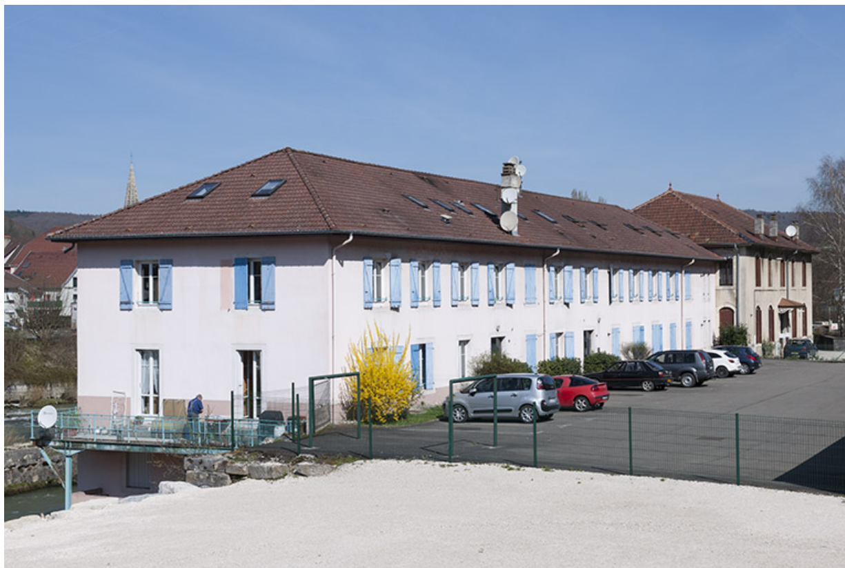
Bâtiments de bureaux vus de trois quarts gauche.
