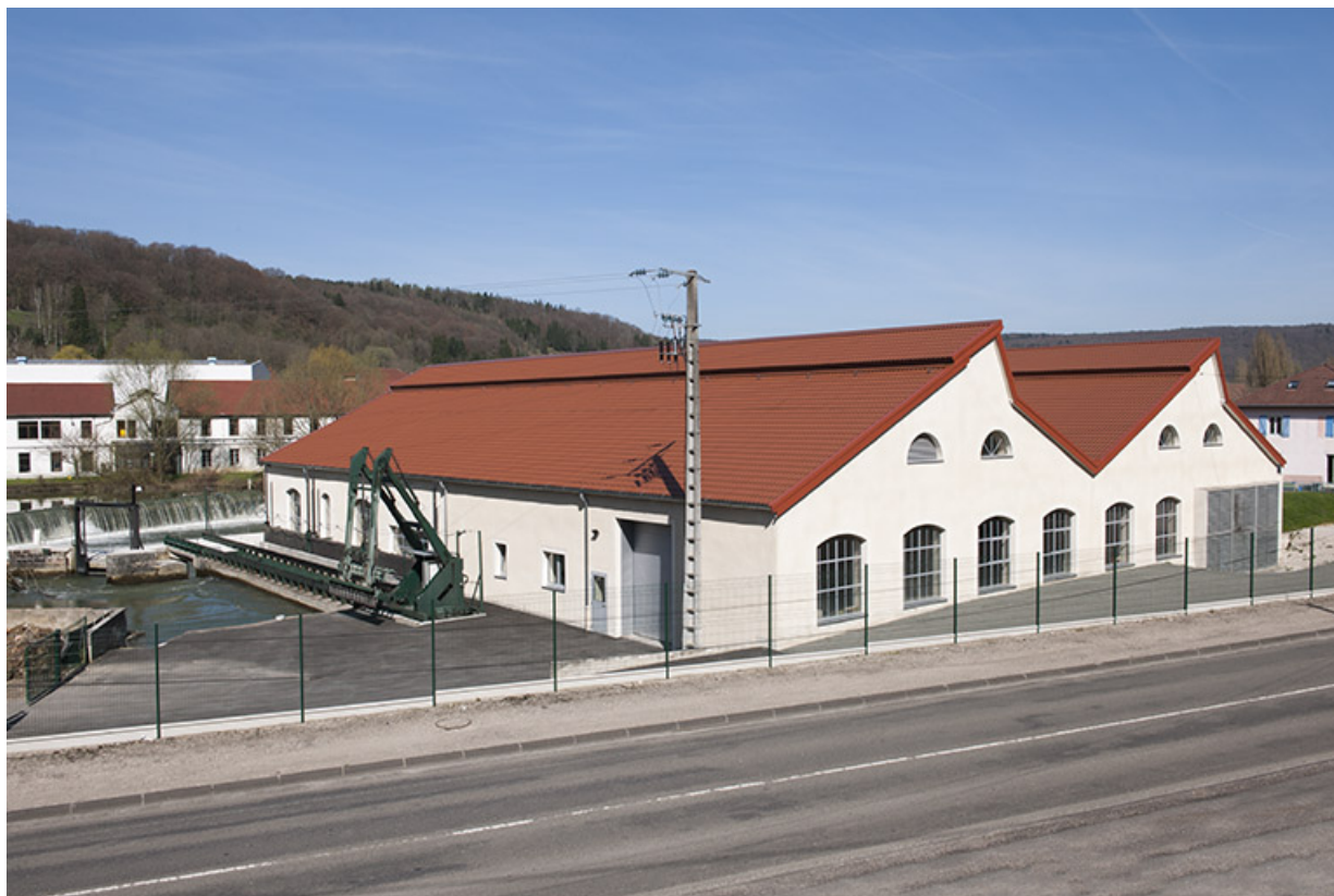
La centrale hydroélectrique vue de trois quarts.
