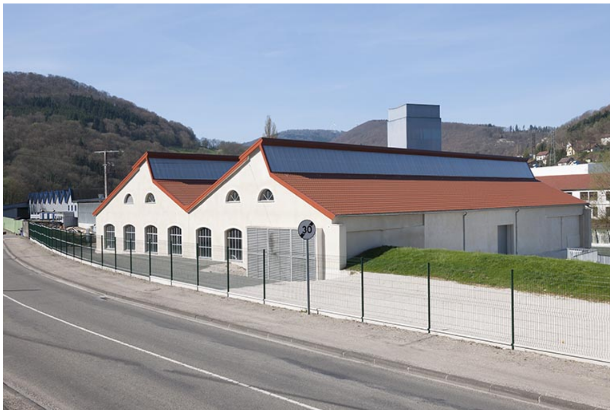
Centrale hydroélectrique (rive droite). 25, Pont-de-Roide rue de Saint-Hippolyte
