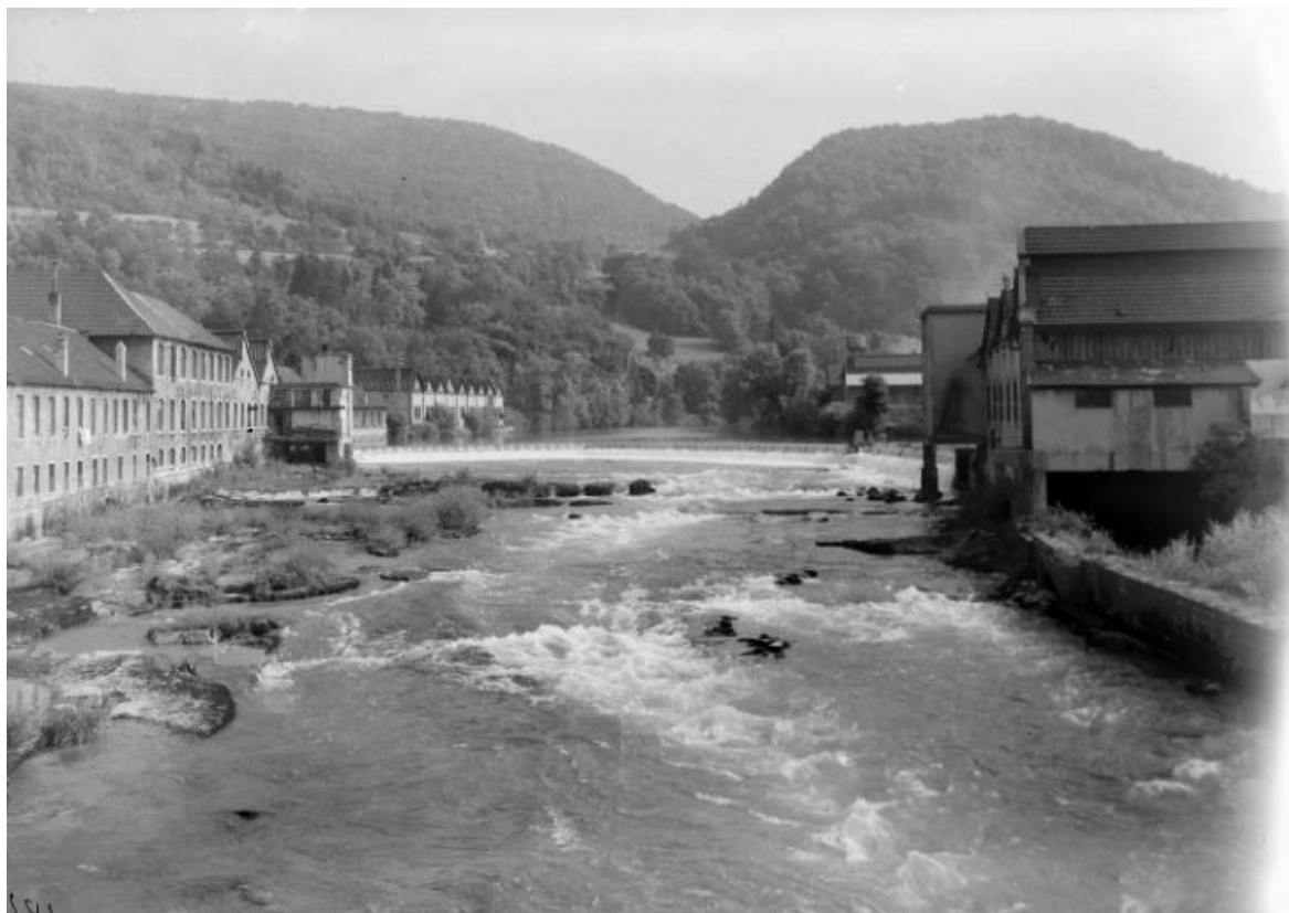
Façades sur le Doubs [1e moitié 20e siècle] 25, Pont-de-Roide rue de Saint-Hippolyte
