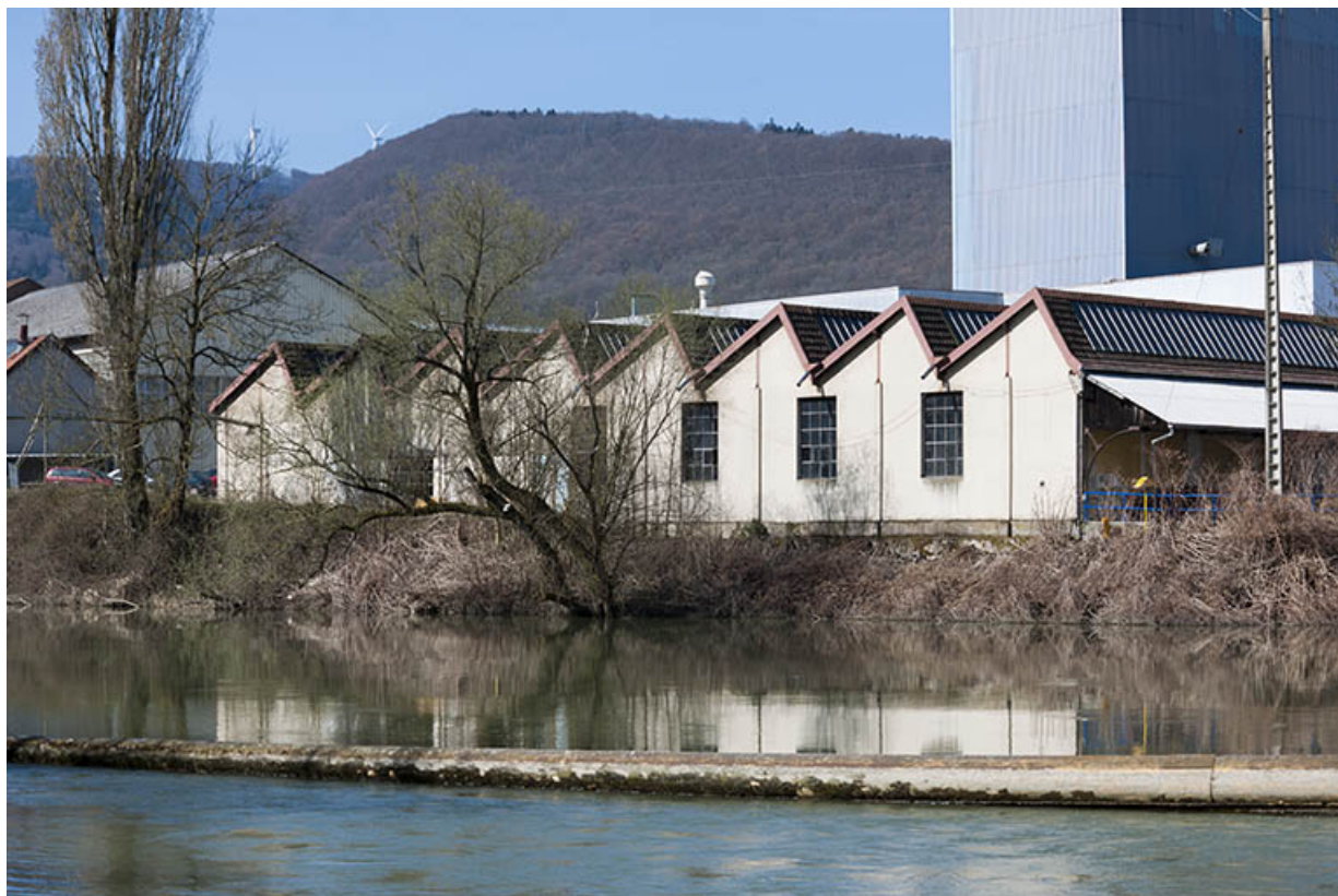
Ateliers de la rive gauche. Vue de trois quarts.
