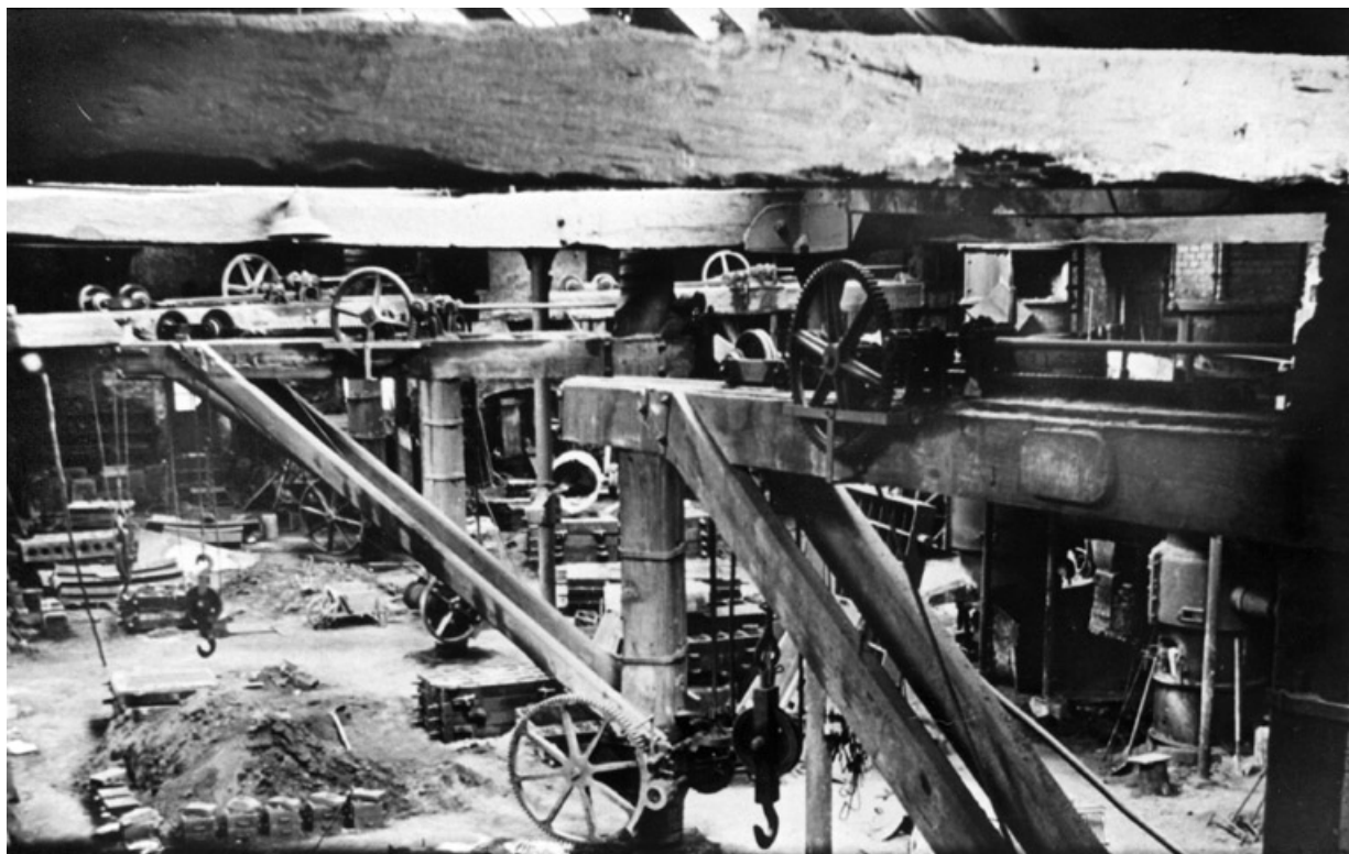
Vue intérieure de l'atelier de fonderie, fotogr., vers 1960.
