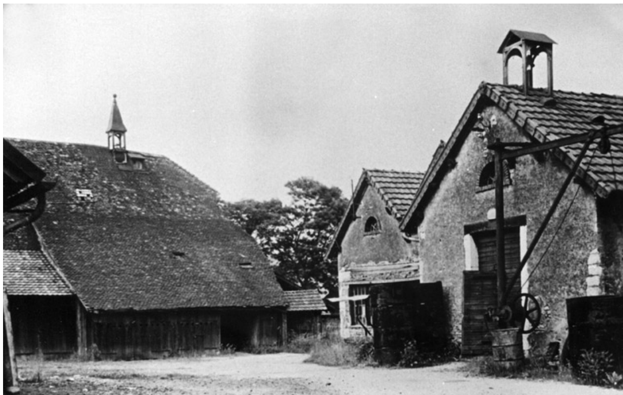
Vue des ateliers depuis la cour, fotogr., vers 1960. 25, Pont-de-Roide rue de Montbéliard
