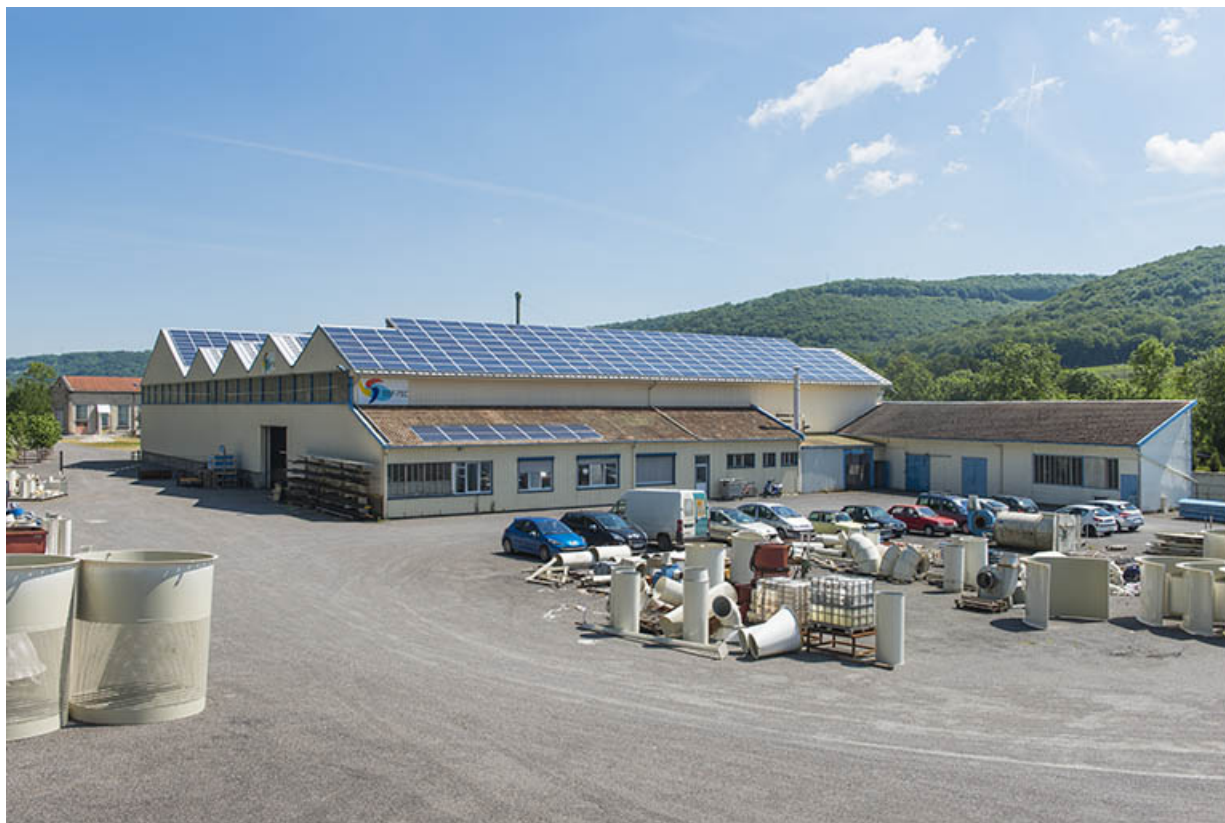
Atelier de laminage depuis l'ancienne entrée du site.
