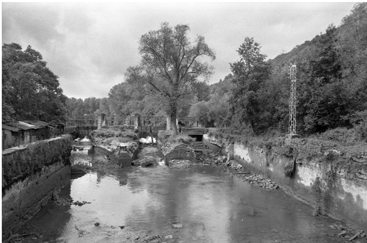
Le vannage et les coursiers en ruines en 1980.
