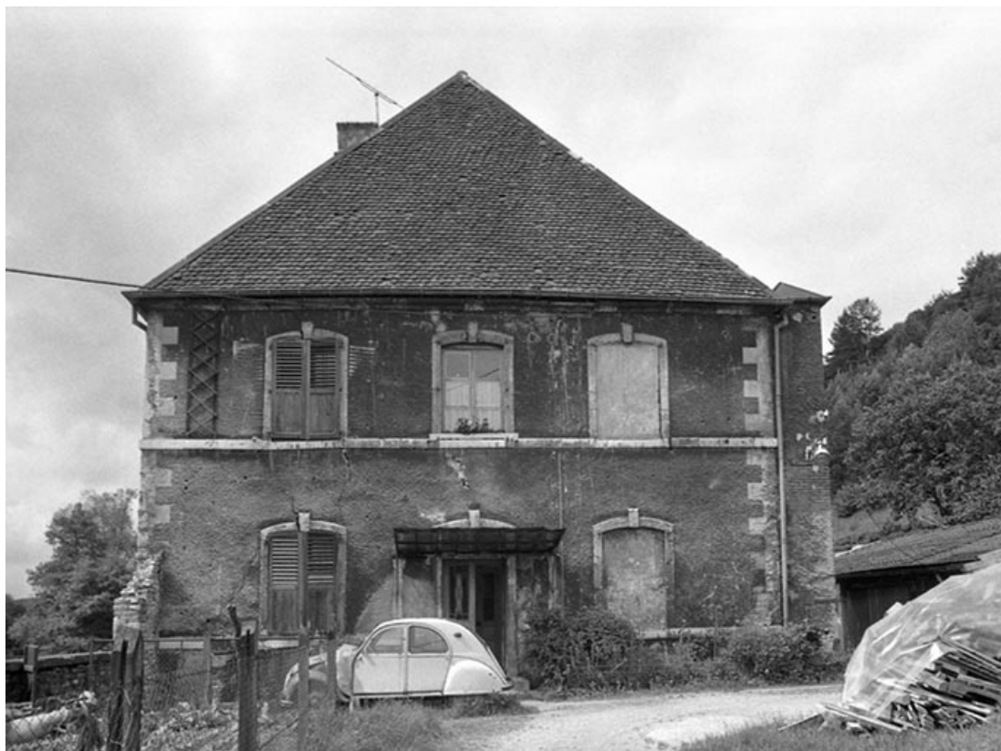
Façade nord du logement patronal en 1980.
