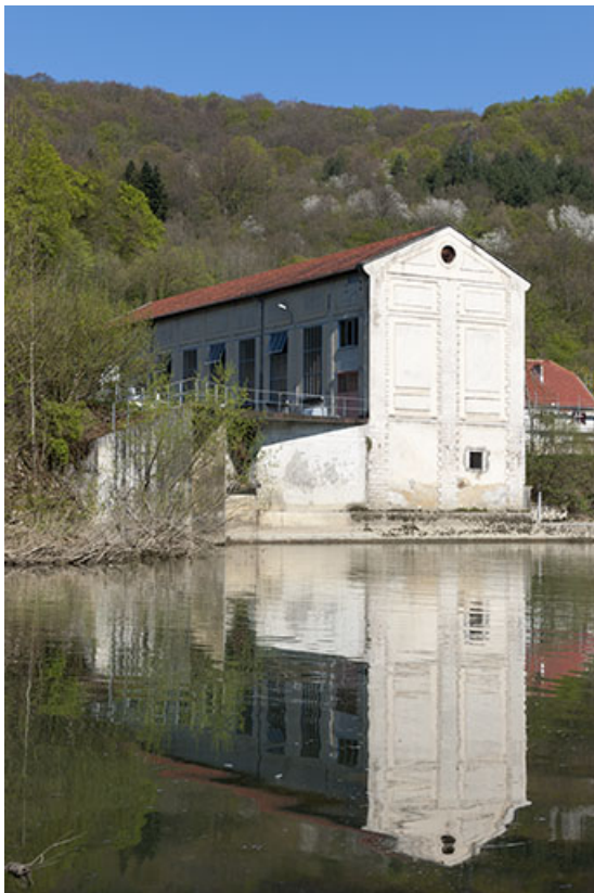
Vue de trois quarts de la centrale hydroélectrique.
