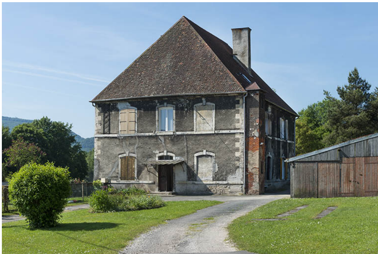
Façade nord du logement patronal.
