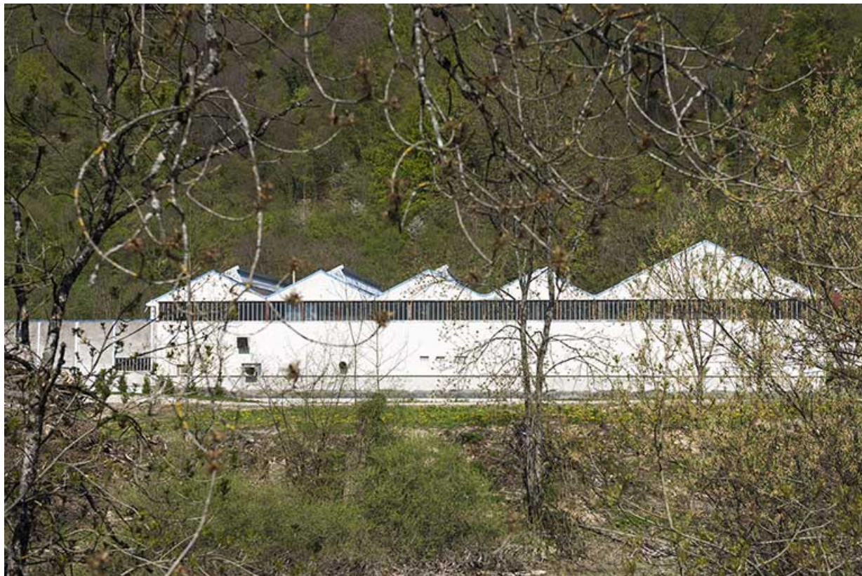
Façade est de l'atelier de laminage.
