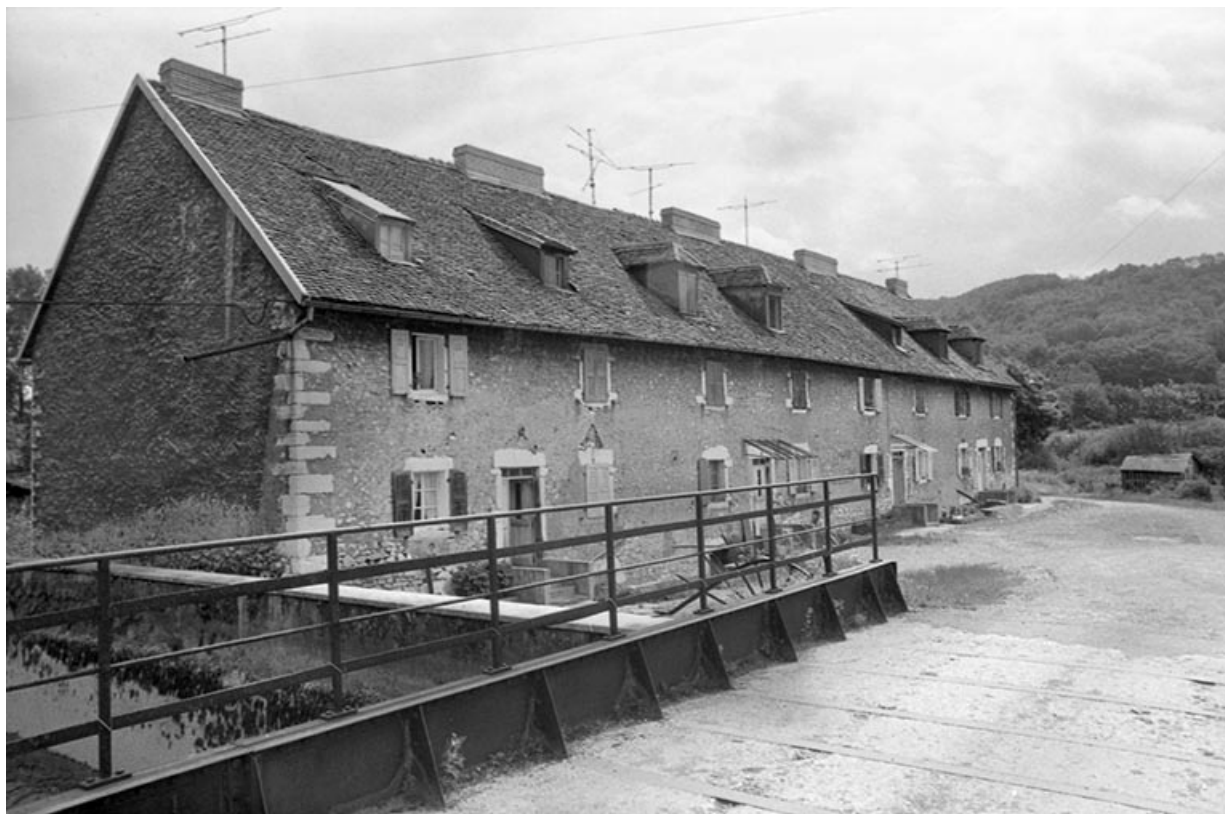
Logement d'ouvriers situé sur l'île, en 1980.
