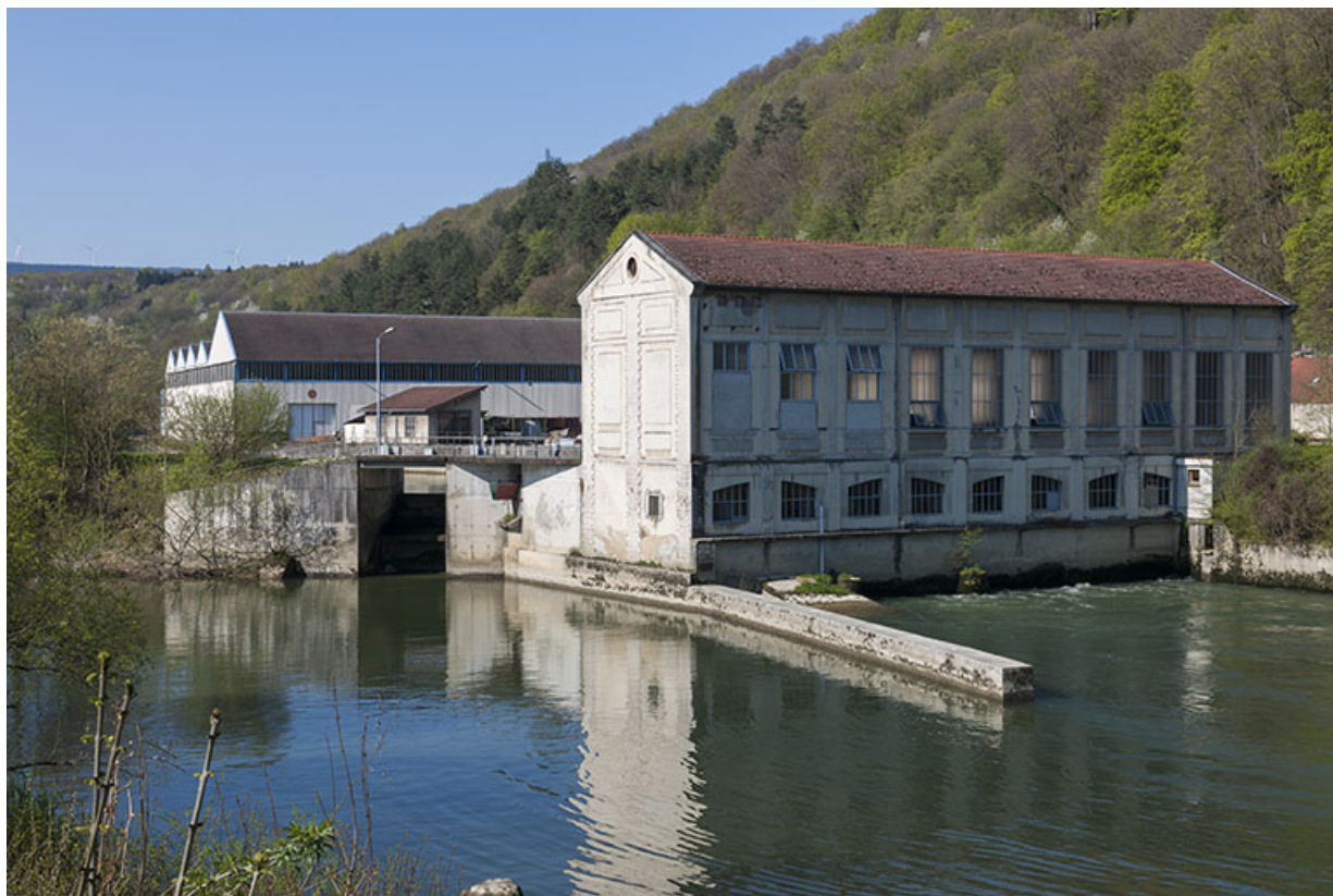
Vue d'ensemble du site depuis le nord-est.
