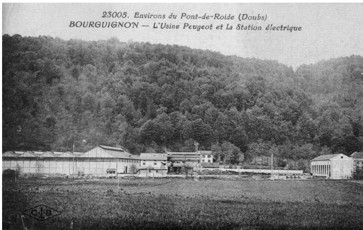
Environs du Pont-de-Roide. Bourguignon. L'usine Peugeot et la station électrique. 25, Bourguignon, lieudit : les Forges
