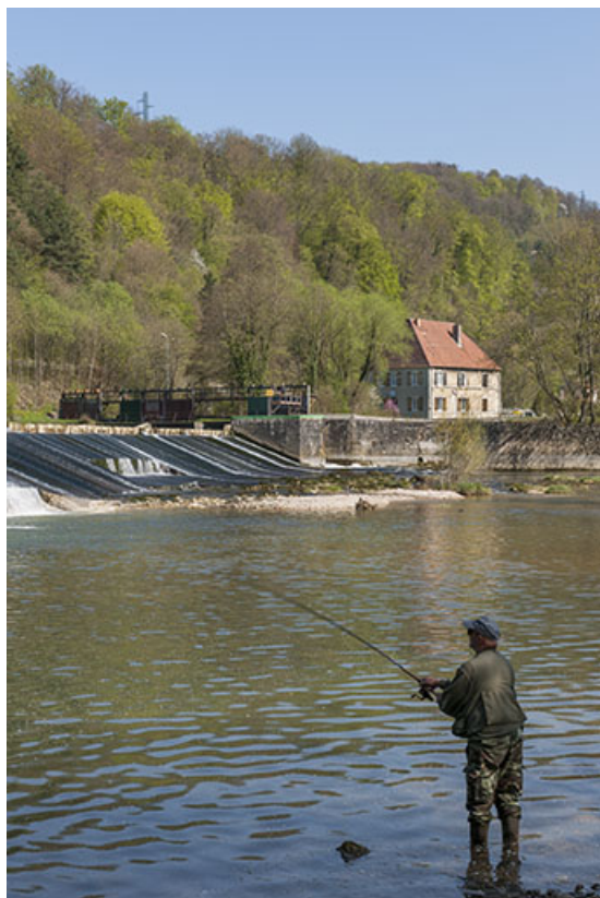
Le barrage et le logement patronal depuis la rive droite.
