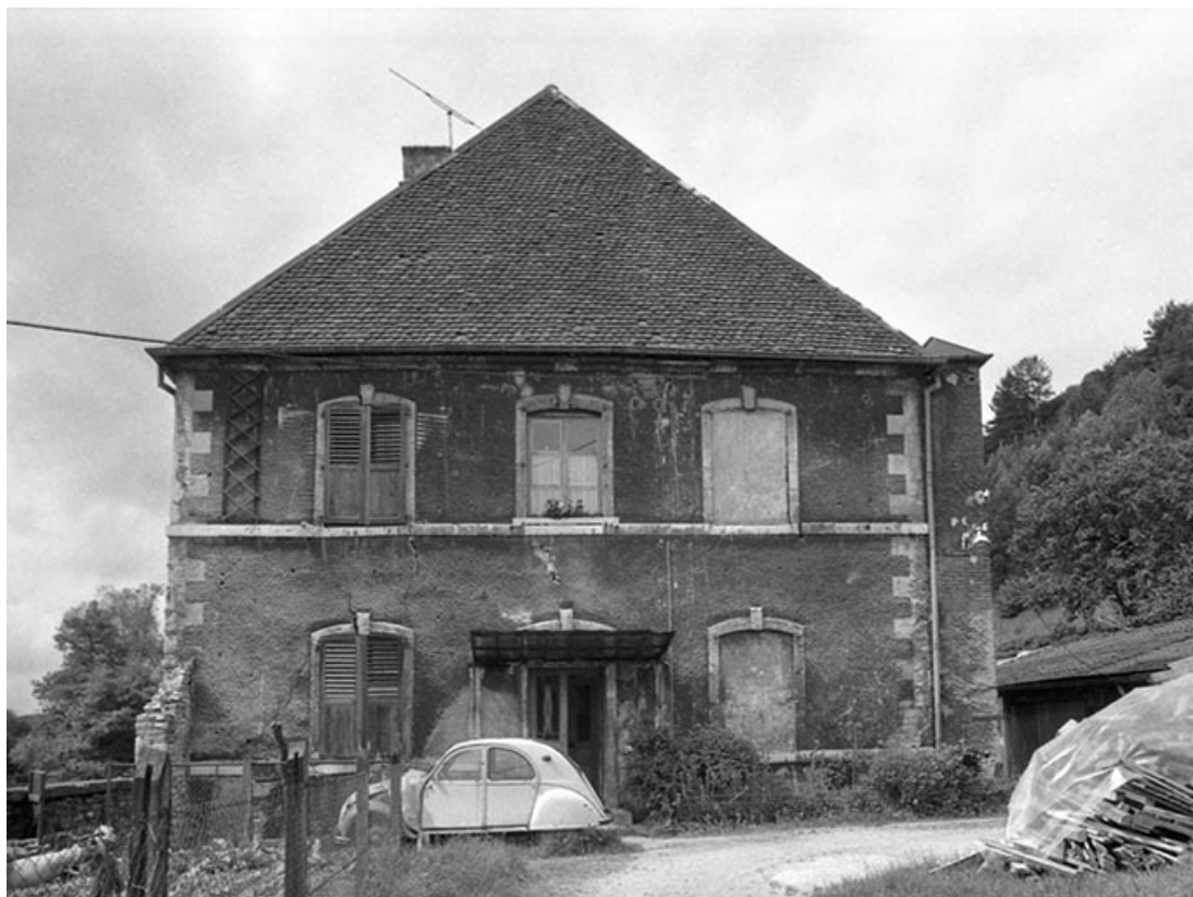
Façade nord du logement patronal en 1980.
