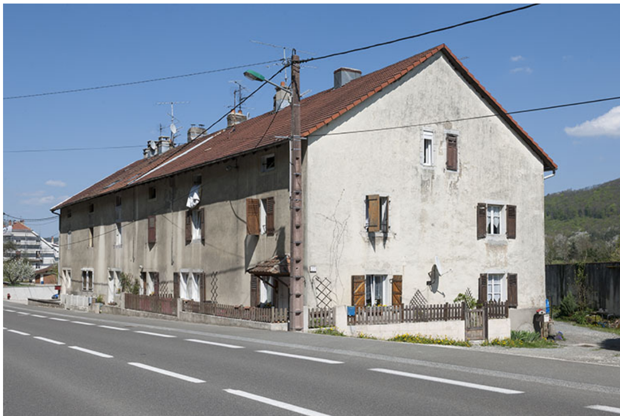
Logement d'ouvriers vu de trois quarts droite.
