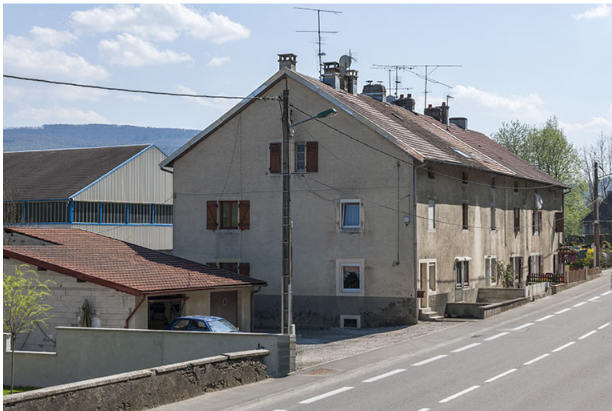
Logement d'ouvriers vu de trois quarts gauche.
