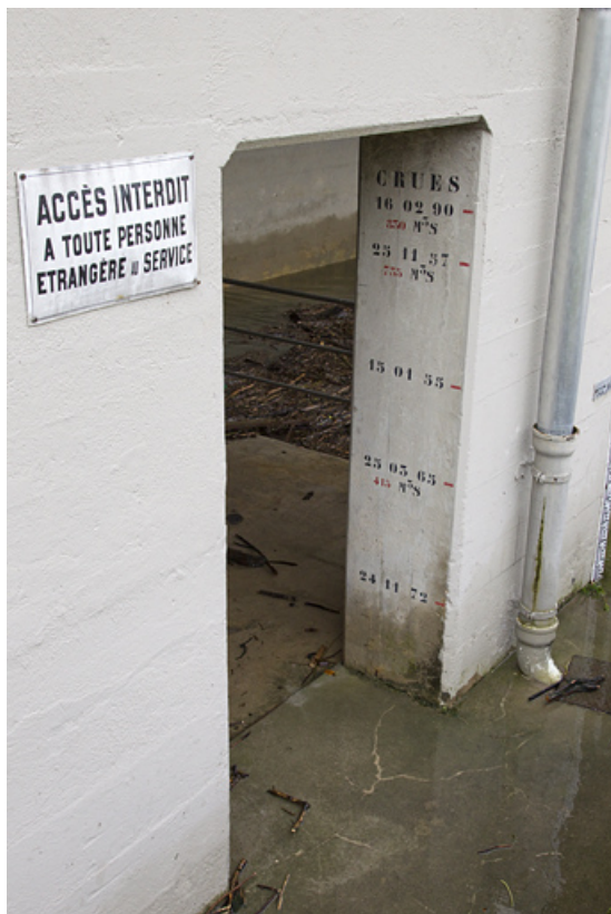
Partie inférieure de la salle des commandes. Marquage du niveau des crues. 25, Noirefontaine, lieudit : le Poset
