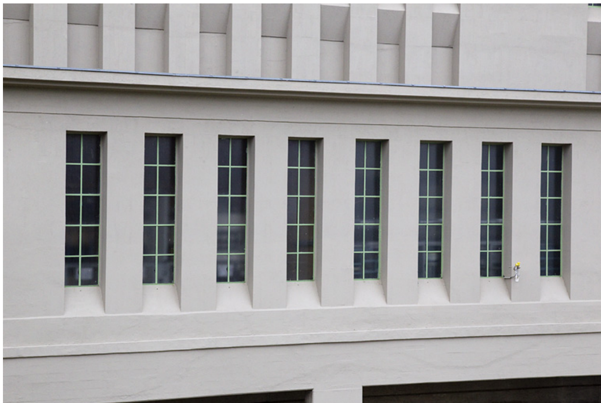
Façade nord. Détail des ouvertures de la salle des commandes.
