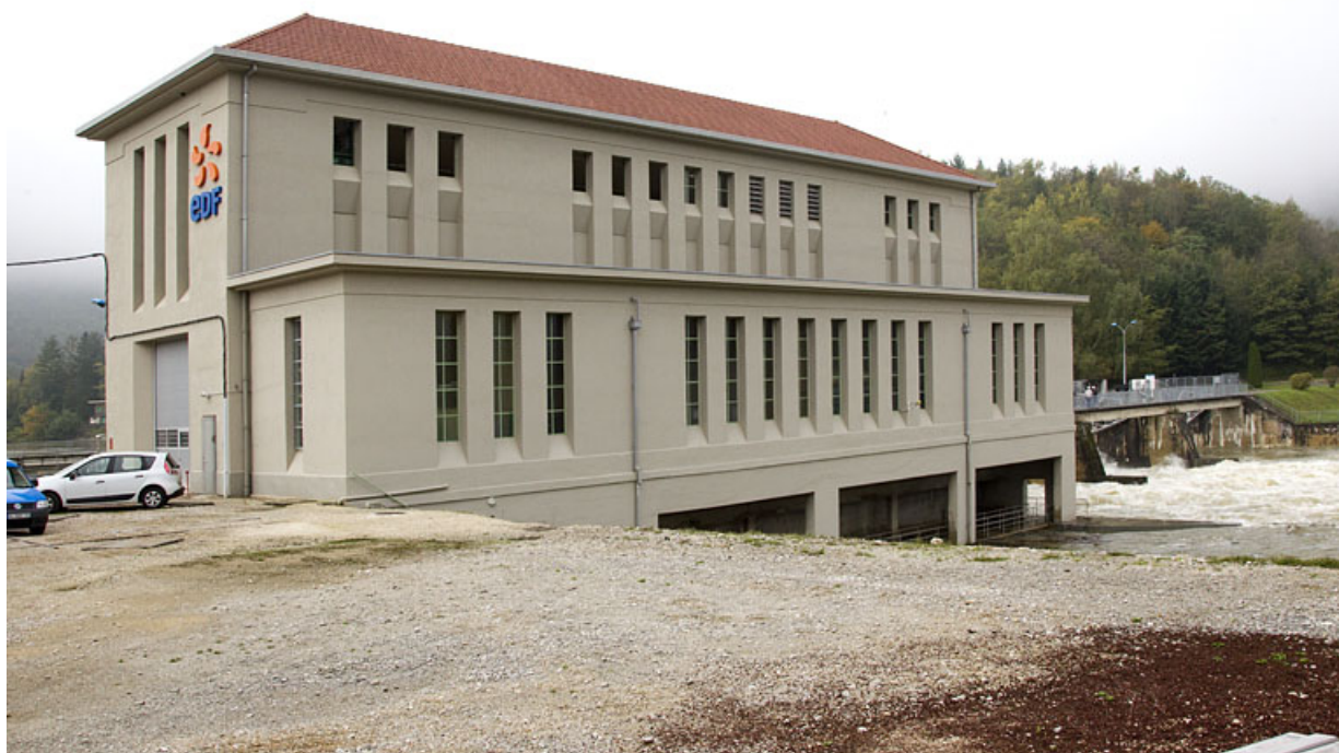
Bâtiment de la centrale vu de trois quarts.
