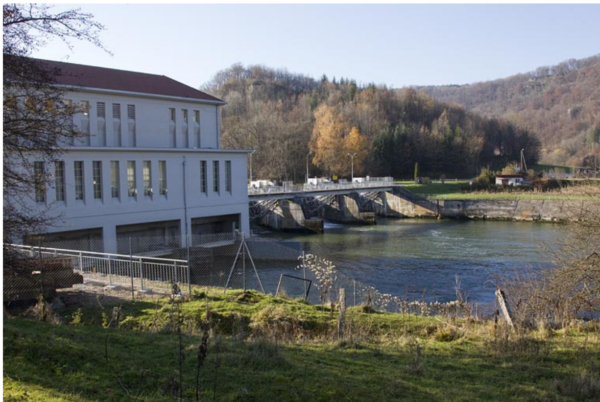
Façade nord de la centrale et barrage depuis le nord-est.
