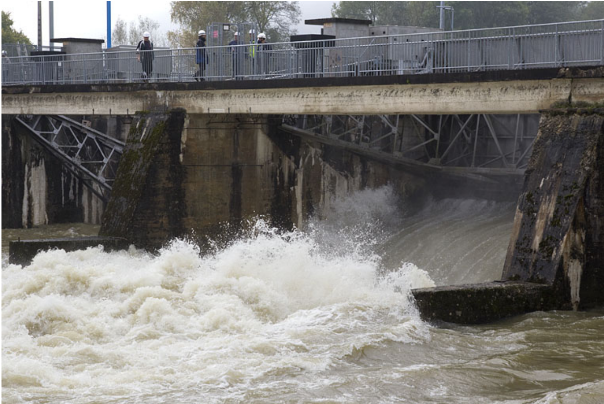
Délestage de la vanne segment centrale.
