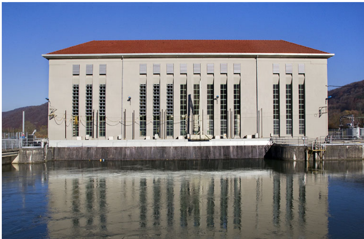
Façade sud de la salle des machines.
