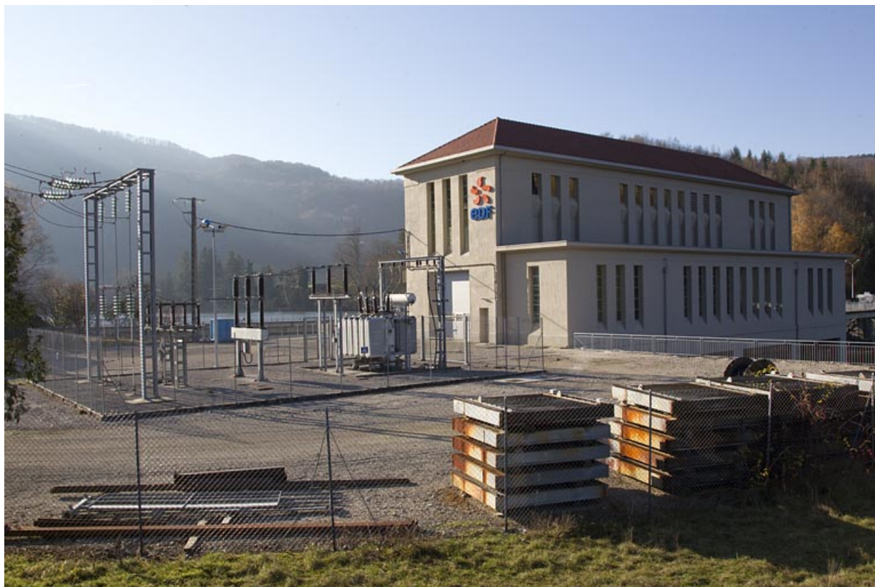
Poste de transformation électrique et centrale depuis le nord.
