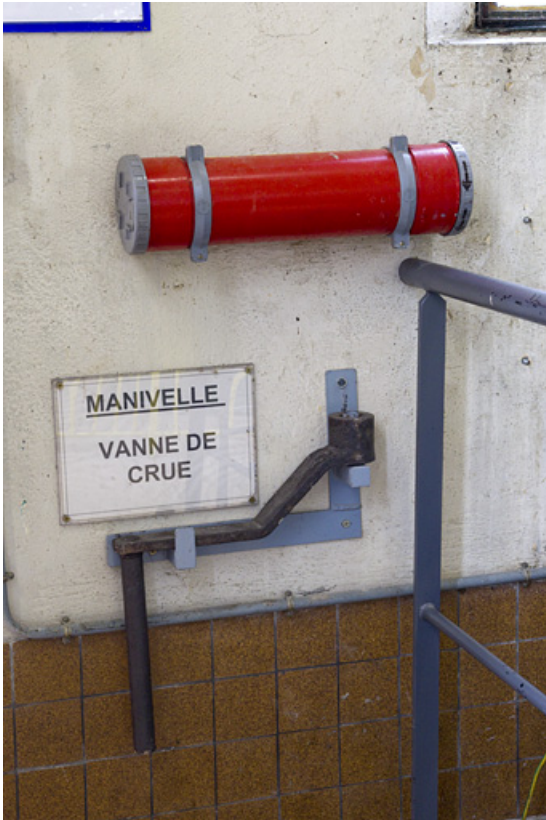
Manivelle de secours (commande du vannage).
