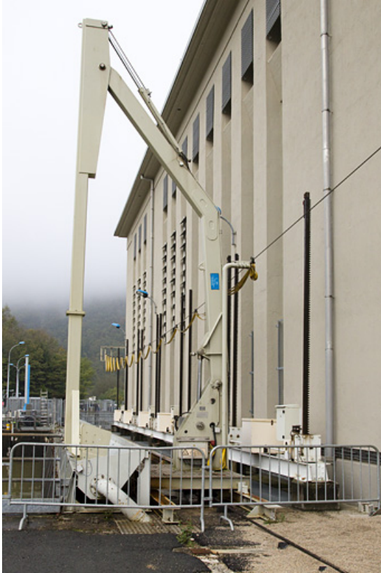
Dégrilleur et façade sud de la centrale.
