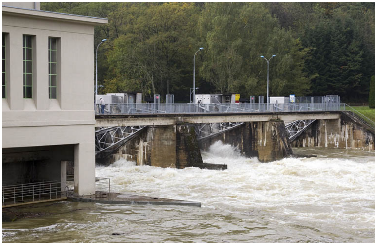
Vannes segments du barrage, depuis l'aval de la rive droite.
