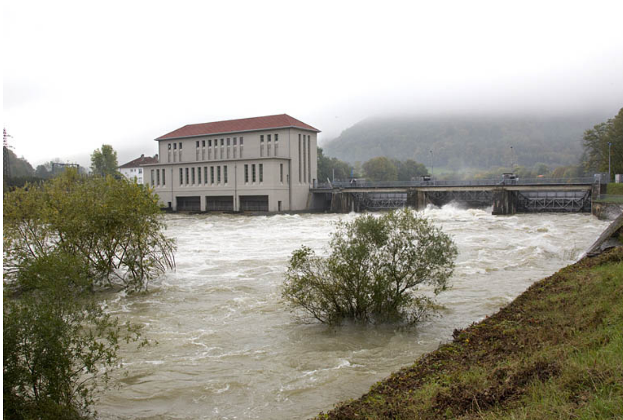
La centrale et le barrage depuis le nord-ouest.
