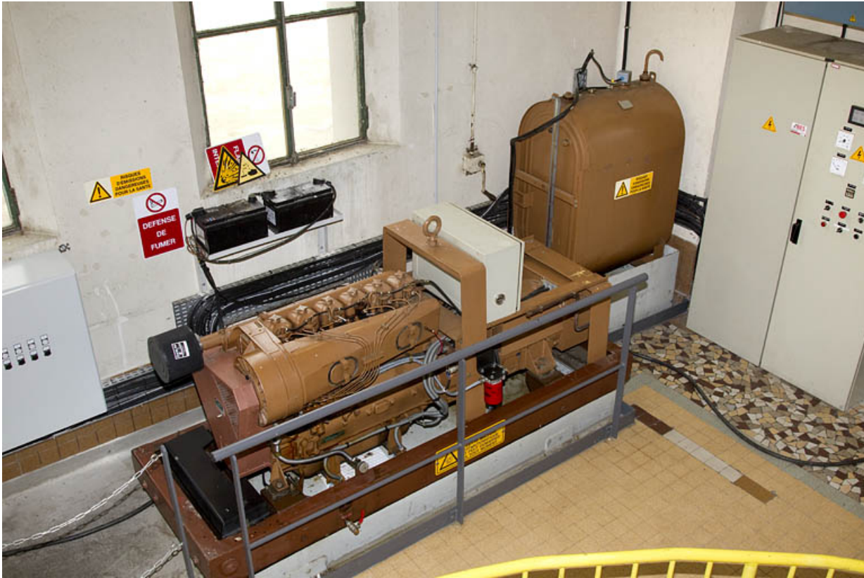
Groupe électrogène de secours (commande du vannage).
