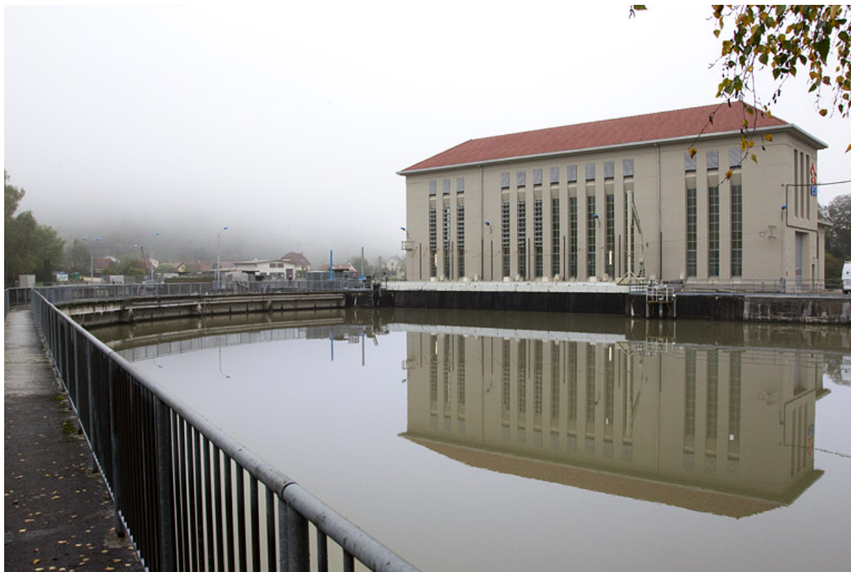
Salle des machines vue de trois quarts et le bassin de retenue.
