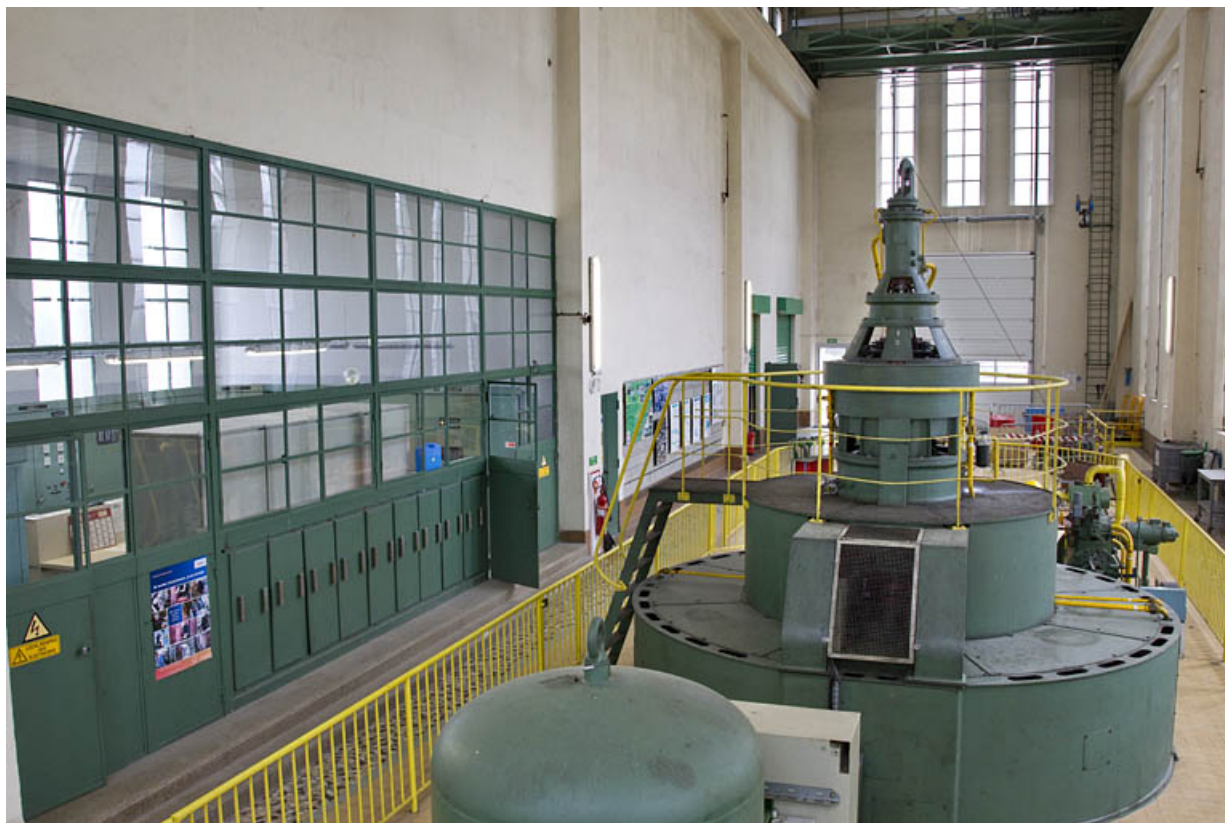
Salle des commandes et groupe turbo-alternateur n°2.
