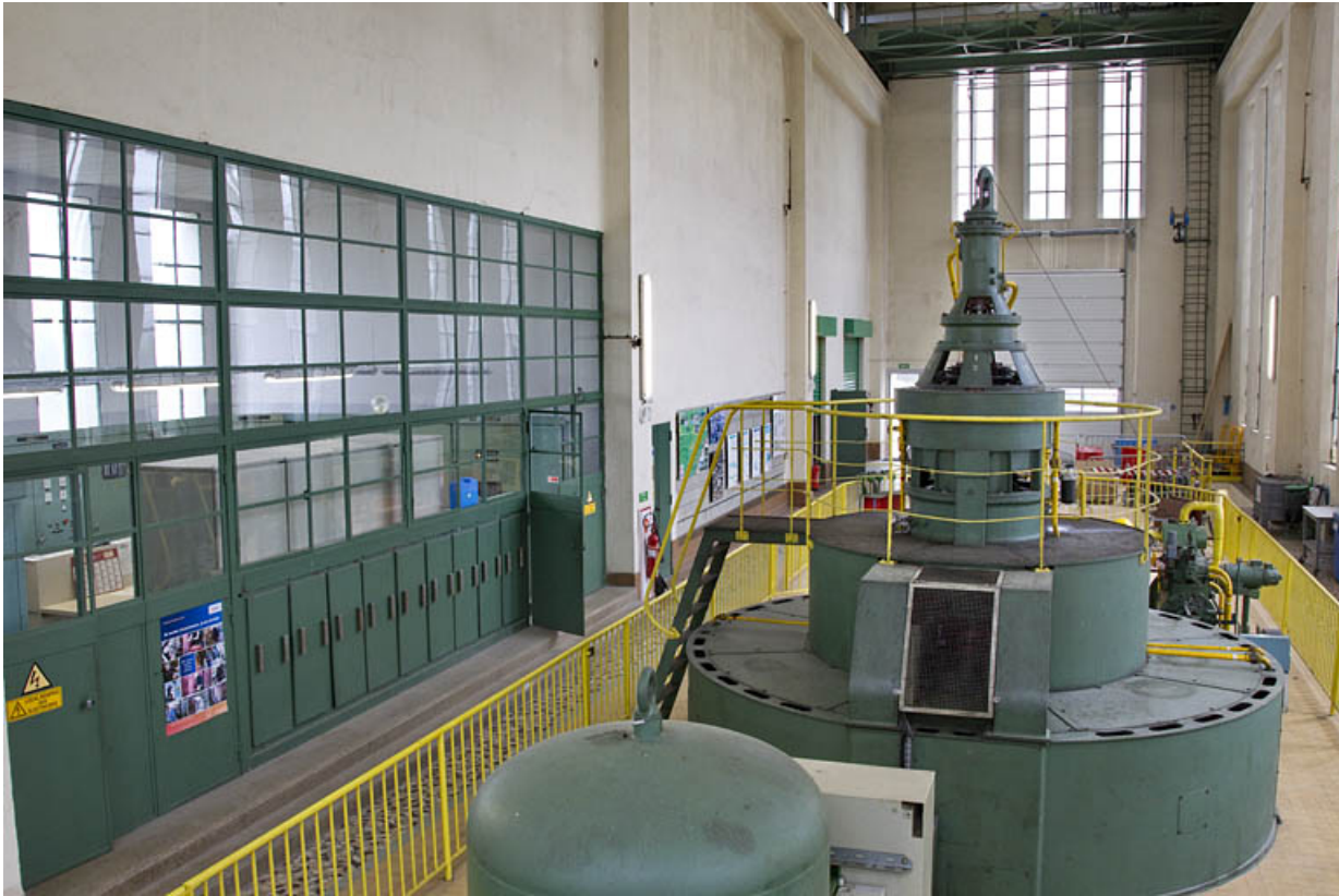
Salle des commandes et groupe turbo-alternateur n°2.
