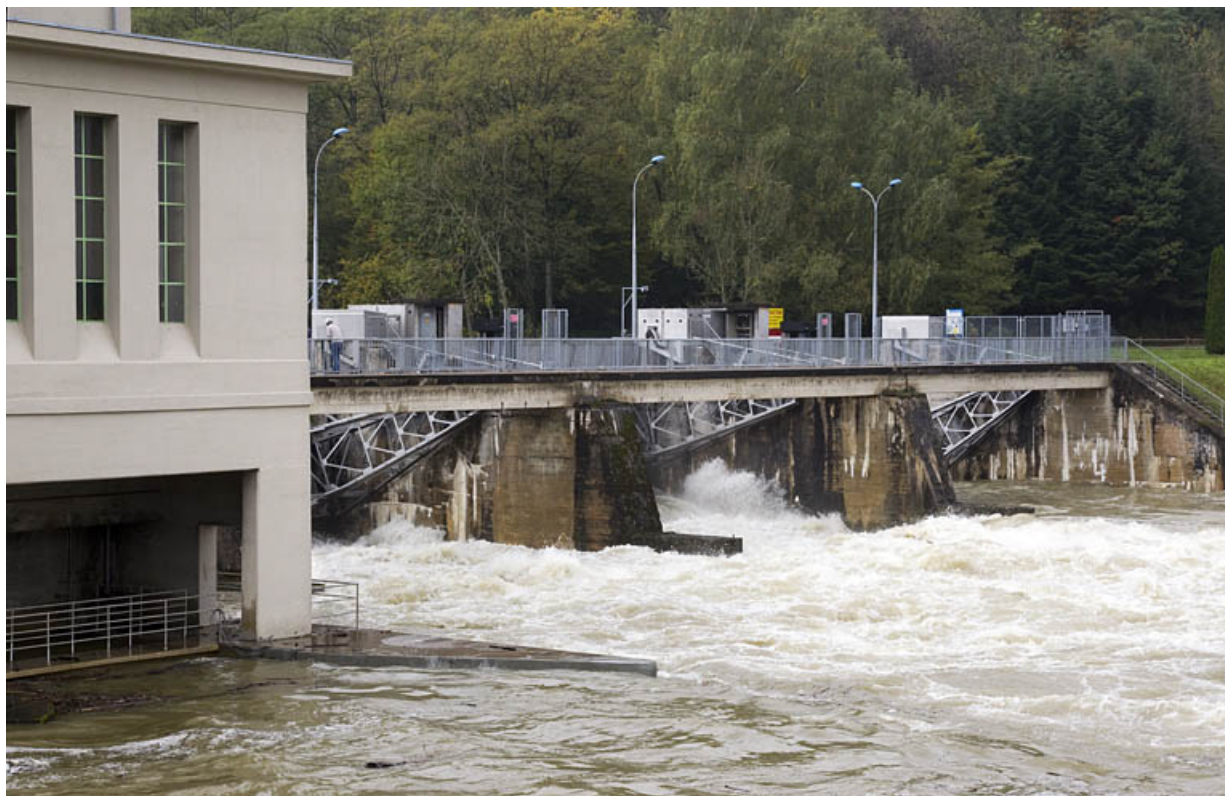
Vannes segments du barrage, depuis l'aval de la rive droite. 25, Noirefontaine, lieudit : le Poset
