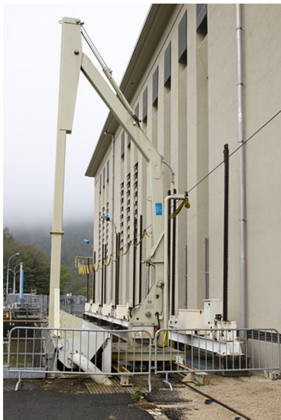
Dégrilleur et façade sud de la centrale.
