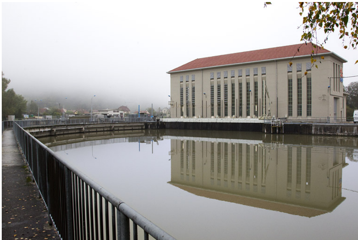
Salle des machines vue de trois quarts et le bassin de retenue.
