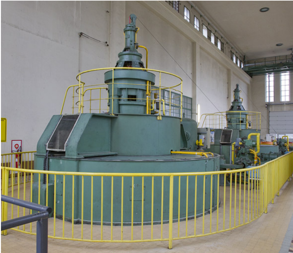
Groupes turbo-alternateurs. Vue rapprochée.
