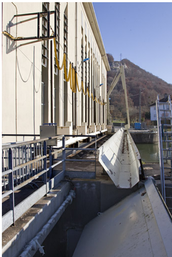
Façade sud et bac de réception du dégrilleur.
