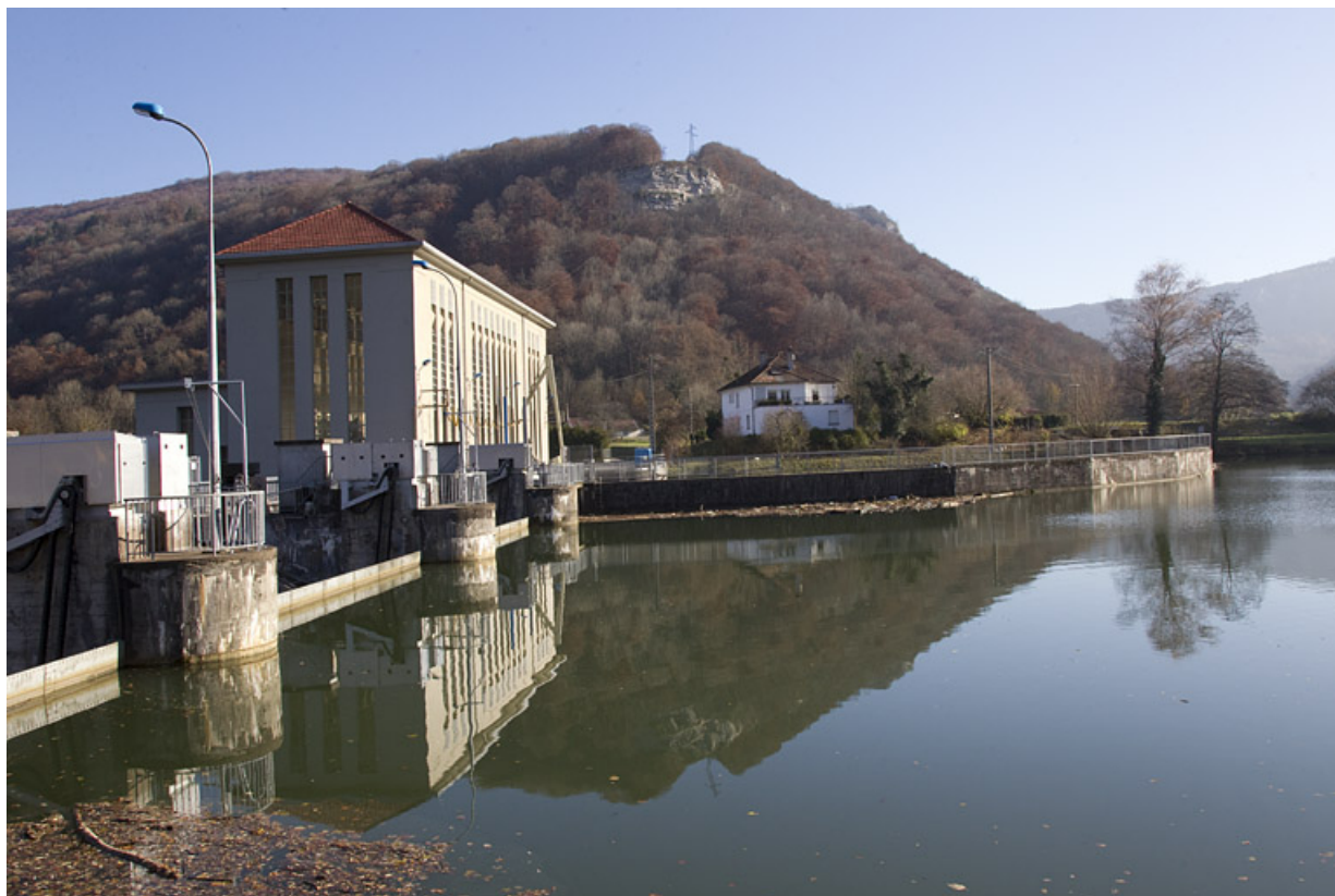
La centrale et le logement depuis la rive gauche.
