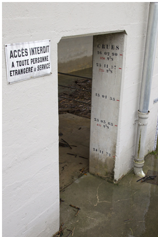
Partie inférieure de la salle des commandes. Marquage du niveau des crues. 25, Noirefontaine, lieudit : le Poset
