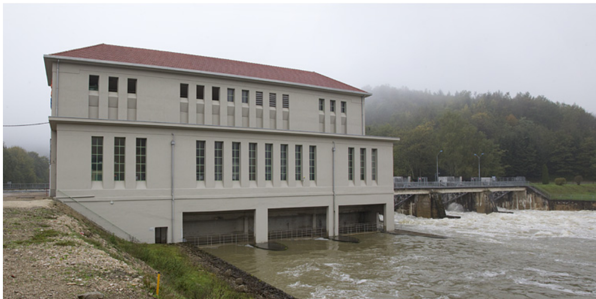
Façade aval depuis le nord.
