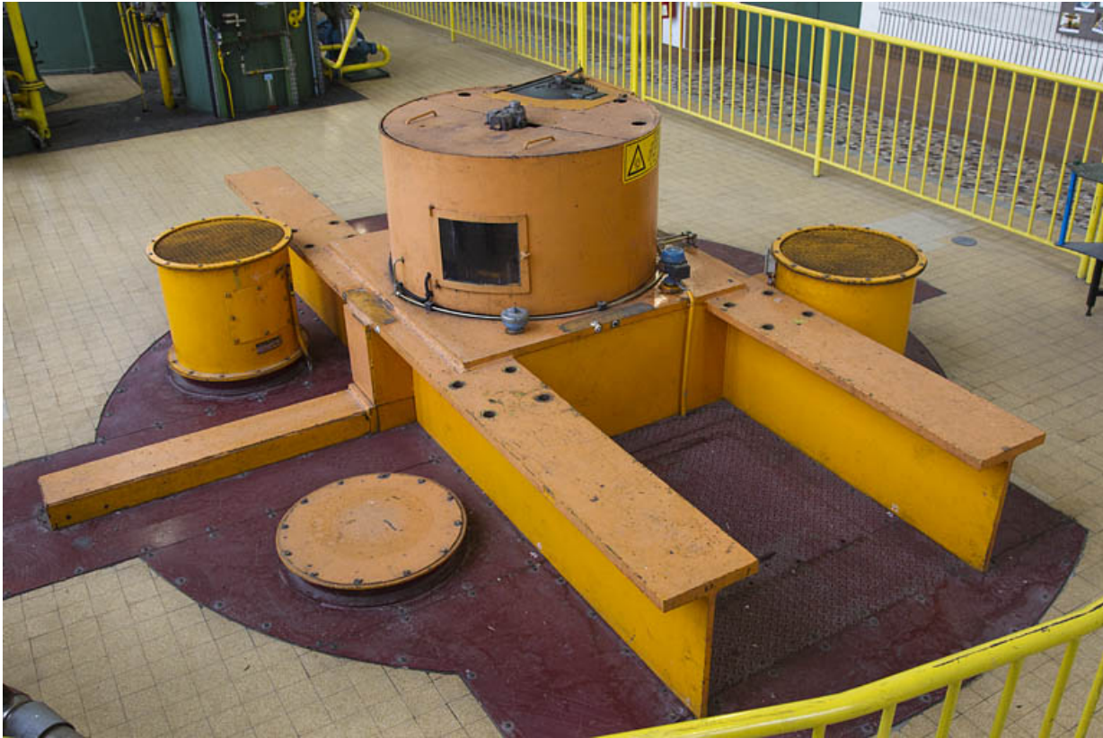
Partie supérieure de la turbine n°3.
