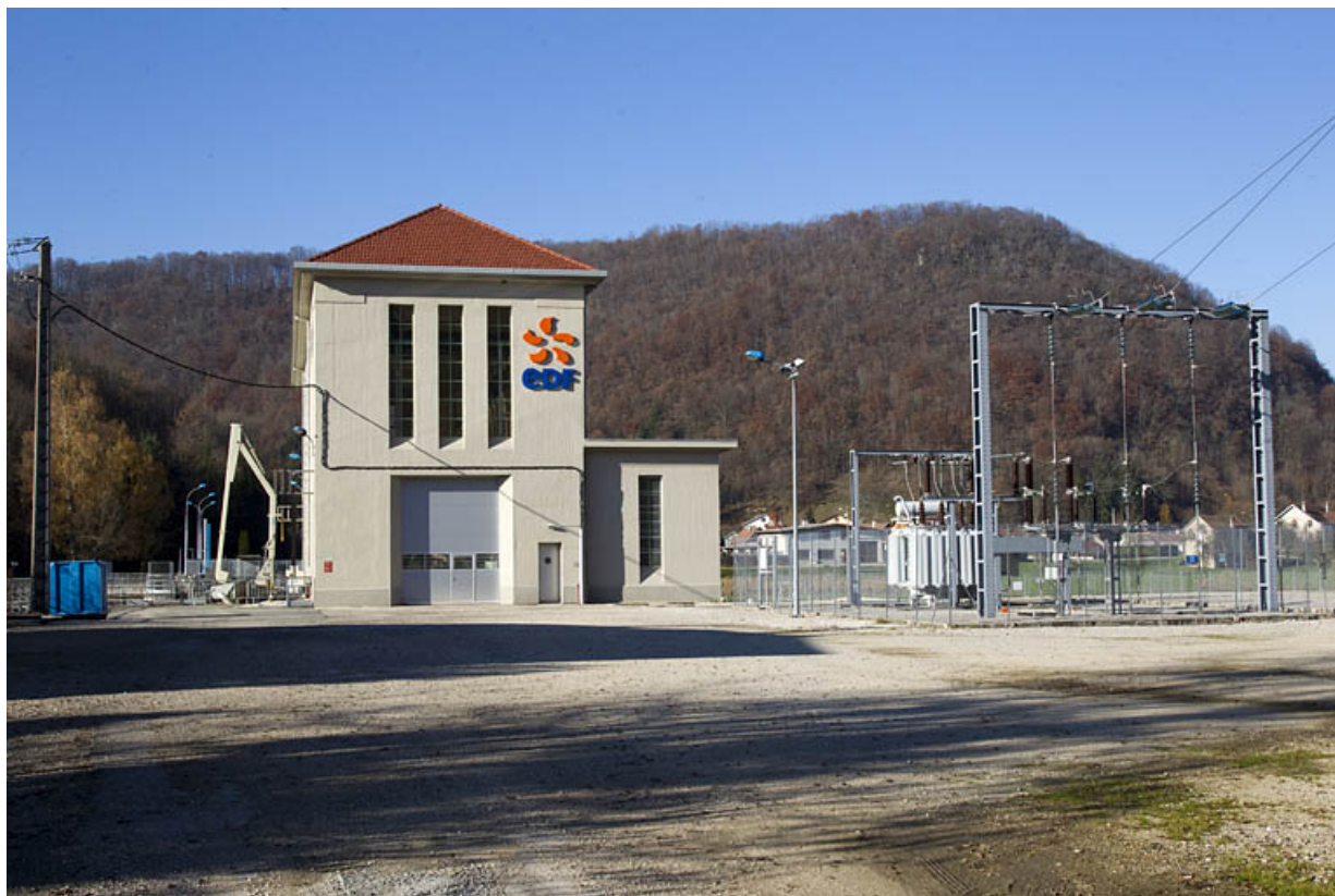
Pignon est de la centrale et poste de transformation.
