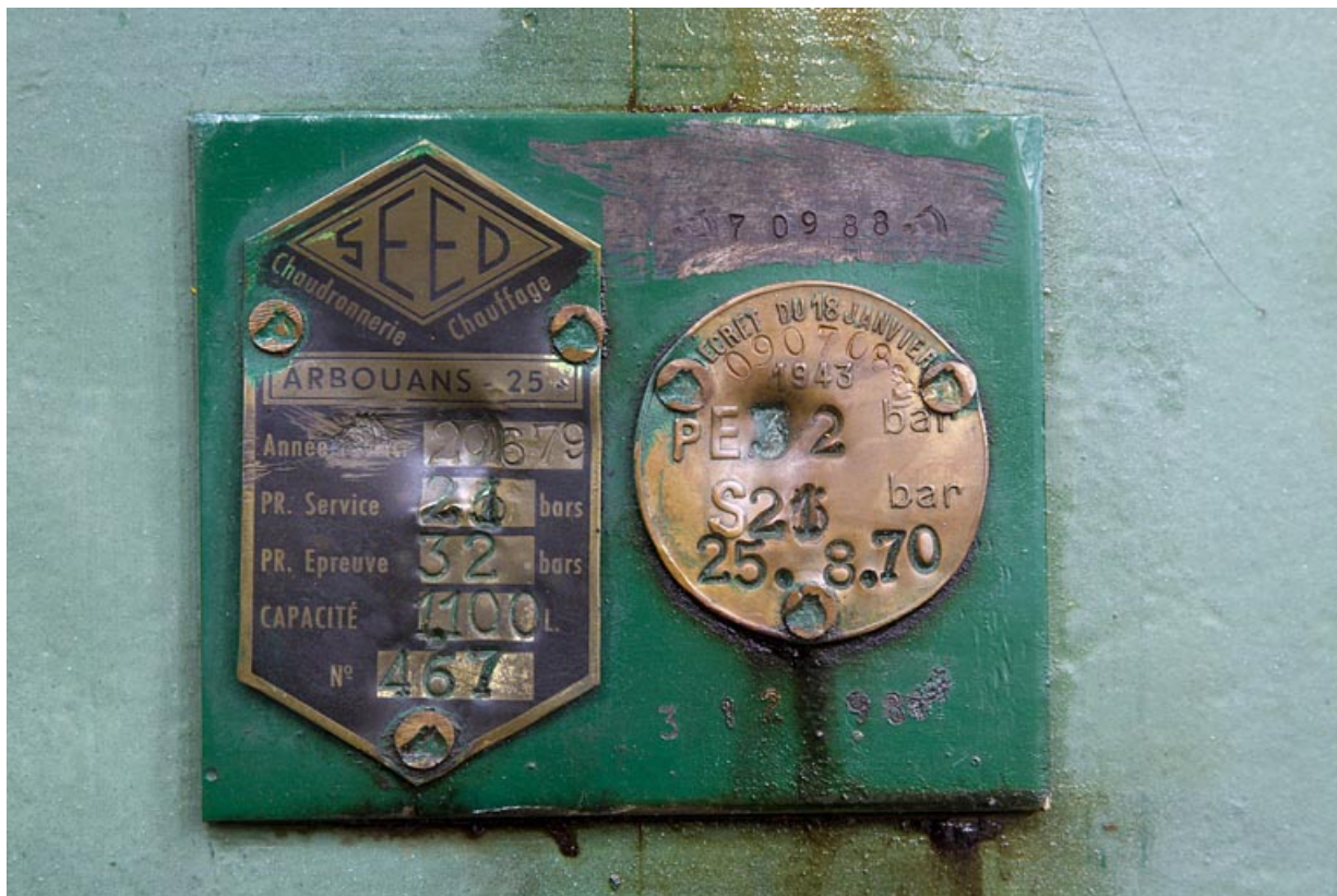
Réservoir d'air comprimé. Plaque d'épreuve.
