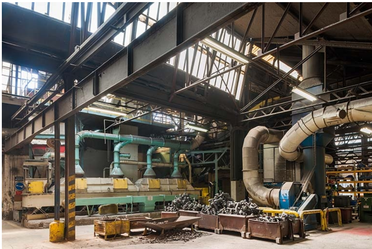
Vue d'ensemble. Ossature métallique.
