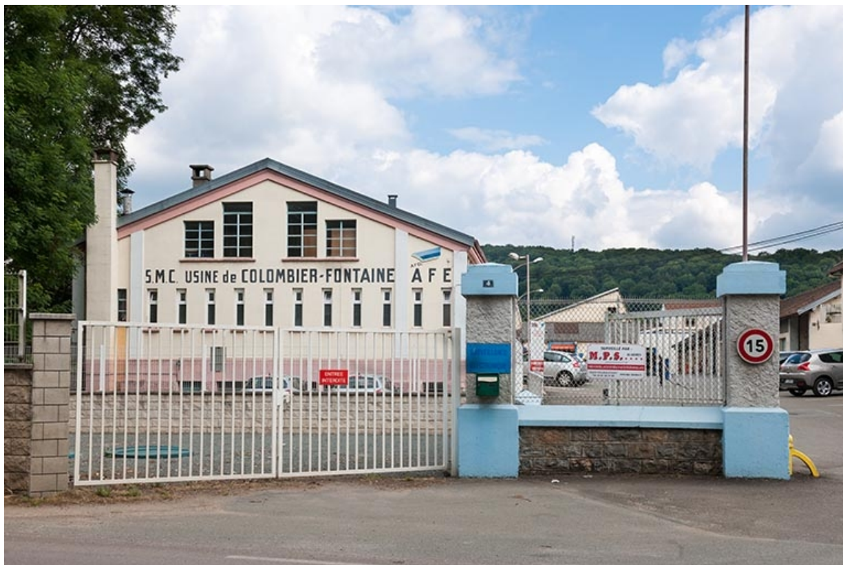
Atelier de modelage, vestiaires et bureaux. Vue depuis l'entrée.
