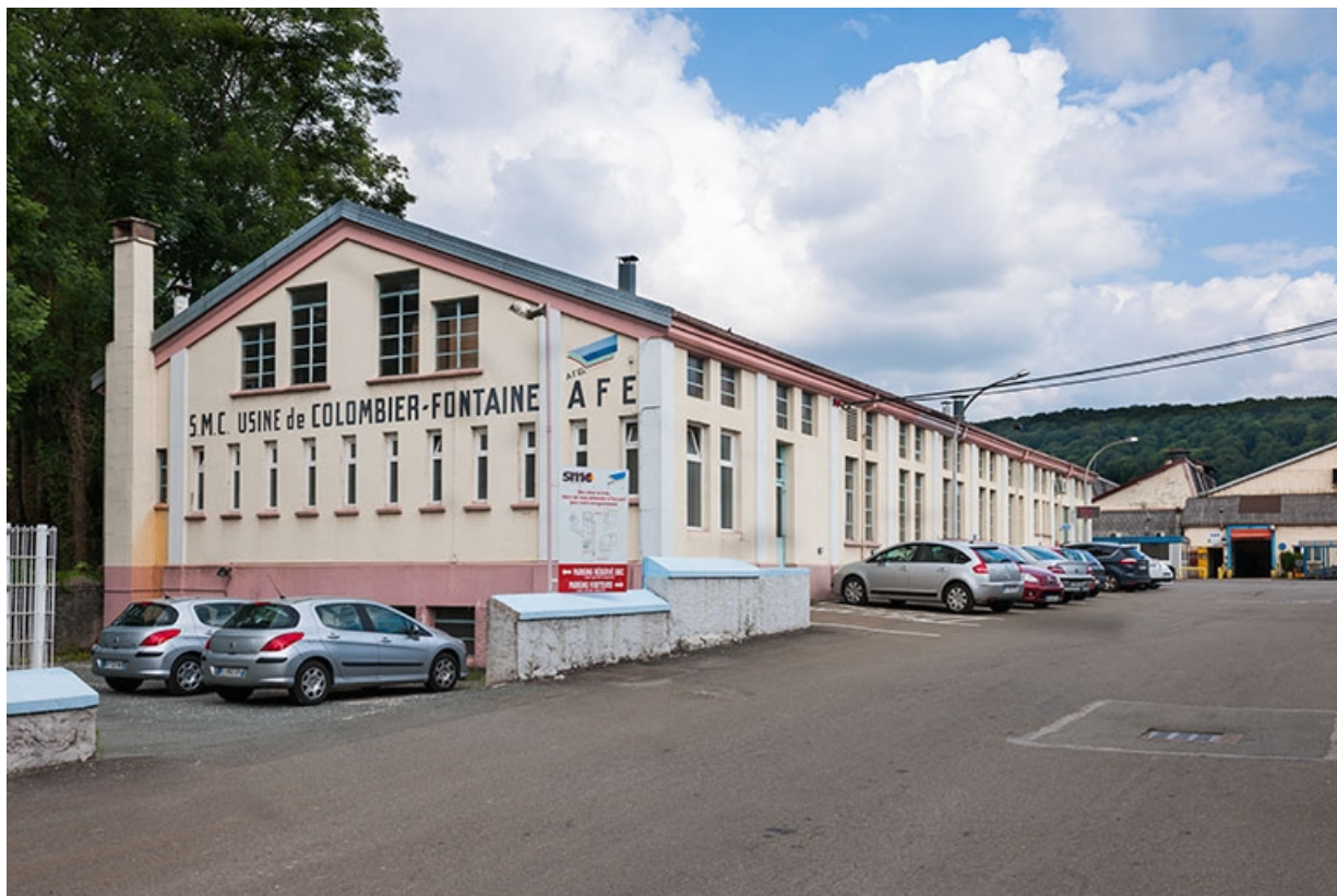
Atelier de modelage, vestiaires et bureaux. Vue depuis l'ouest.
