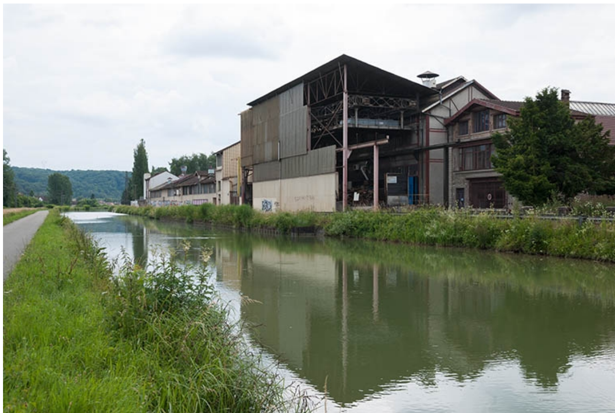
Vue d'ensemble depuis le canal.
