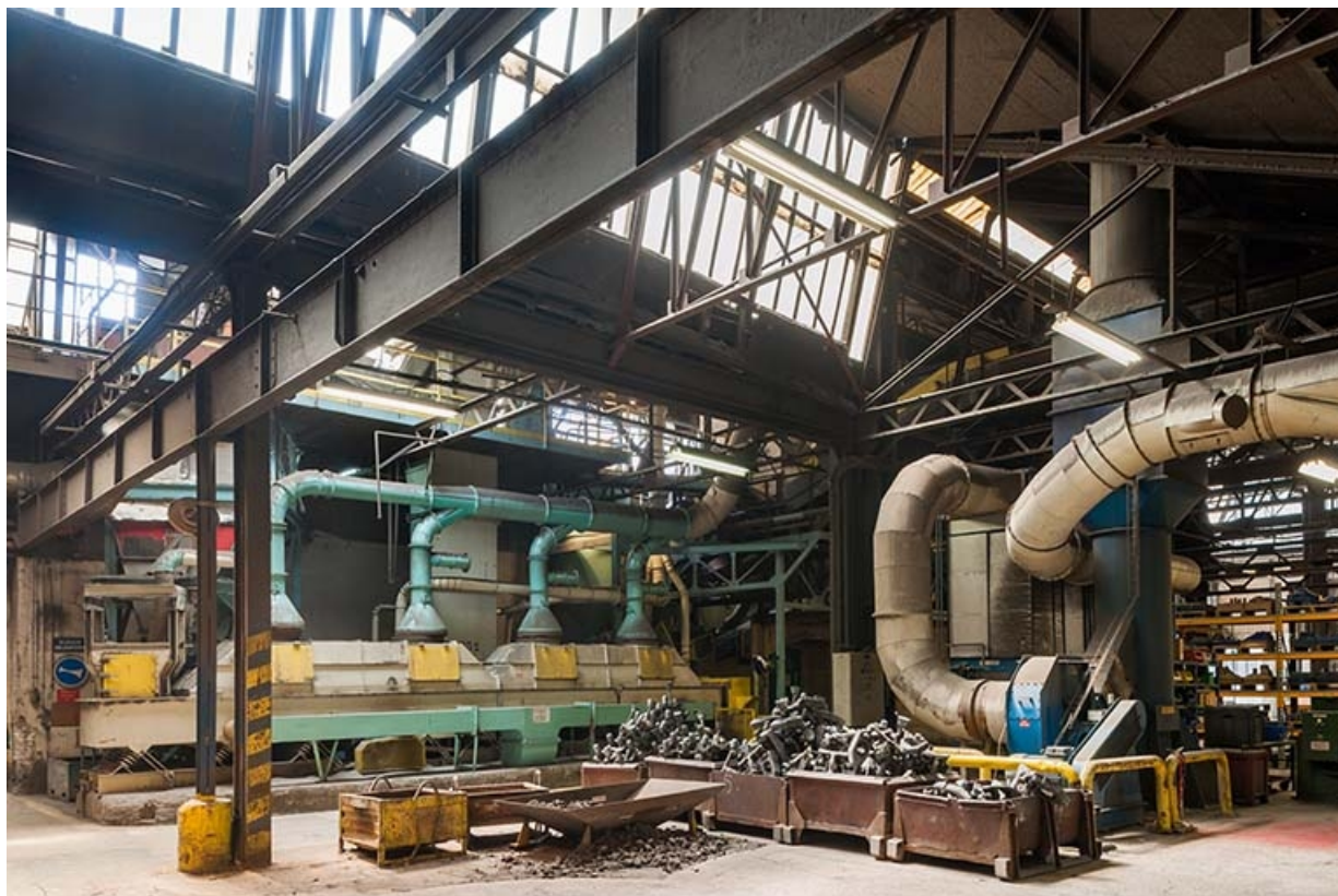
Vue d'ensemble. Ossature métallique.
