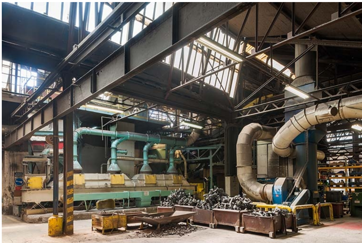
Vue d'ensemble. Ossature métallique.
