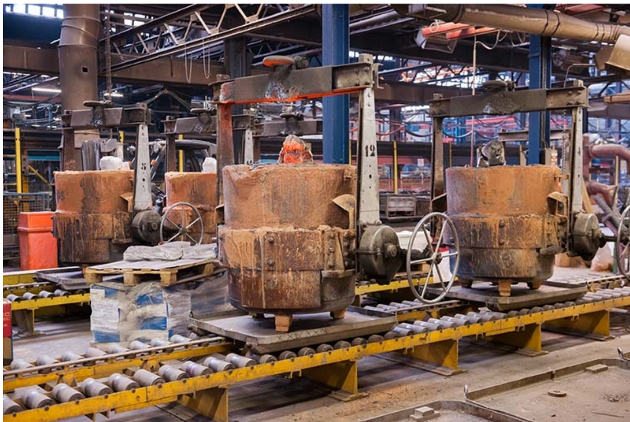
Poches de coulée avant réfection (2). 25, Colombier-Fontaine, 2 rue du Doubs
