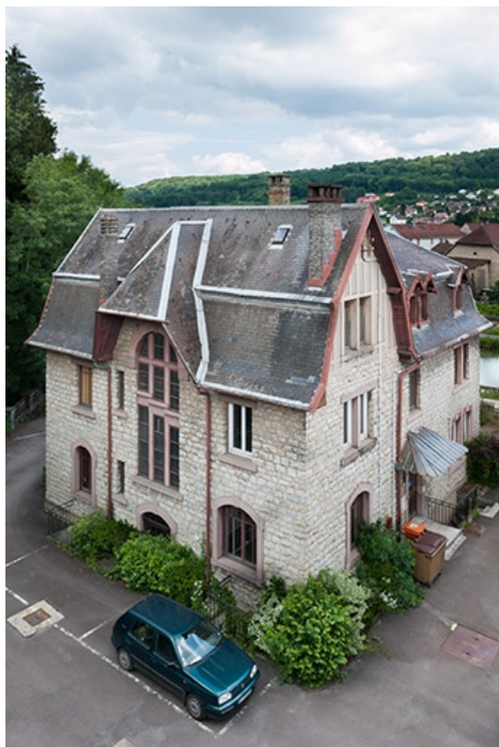
Bureaux (ancienne demeure patronale). 25, Colombier-Fontaine, 2 rue du Doubs
