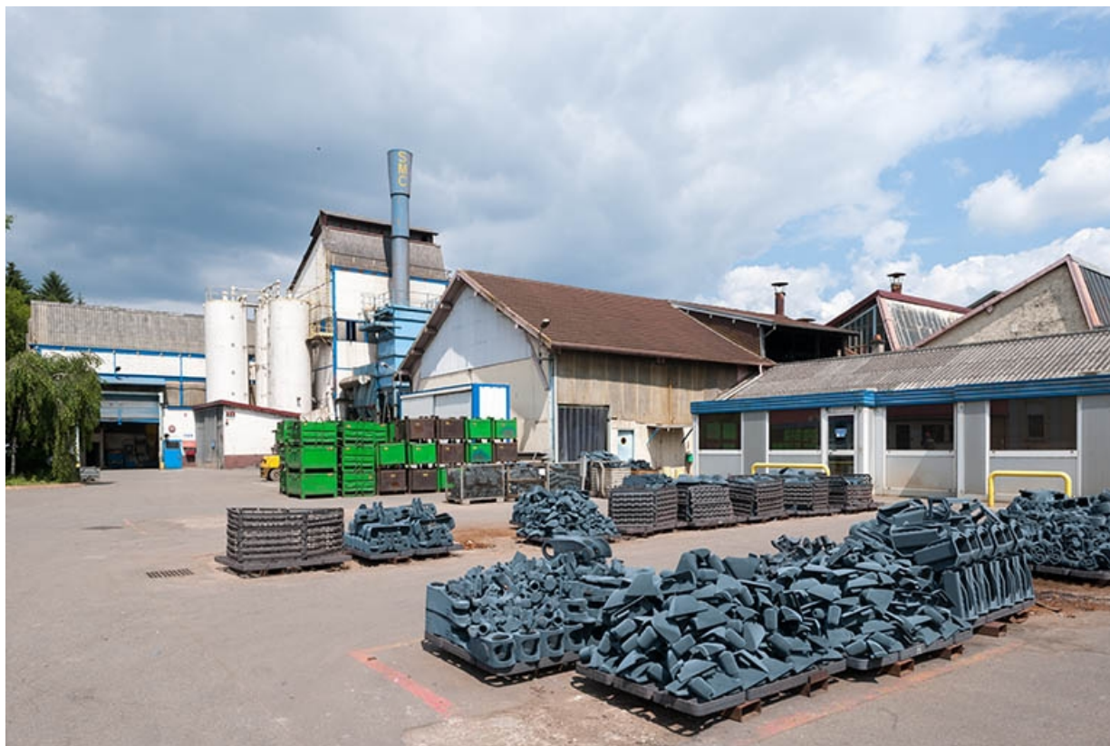
Vue de la cour depuis le sud-ouest.
