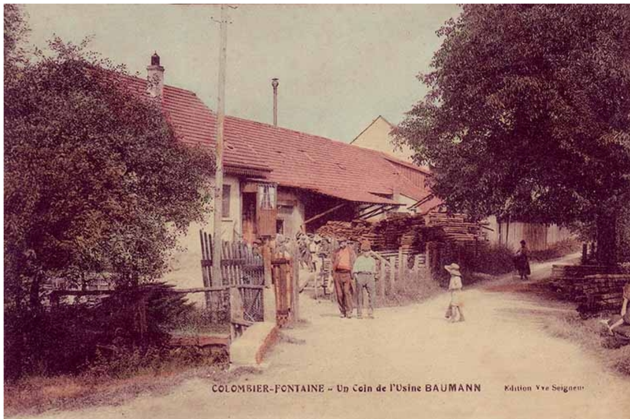
Colombier-Fontaine. Un coin de l'usine Baumann.
