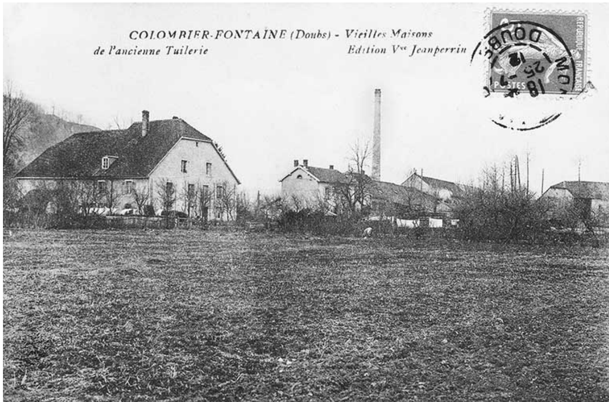
Colombier-Fontaine (Doubs). Vieilles maisons de l'ancienne tuilerie.
