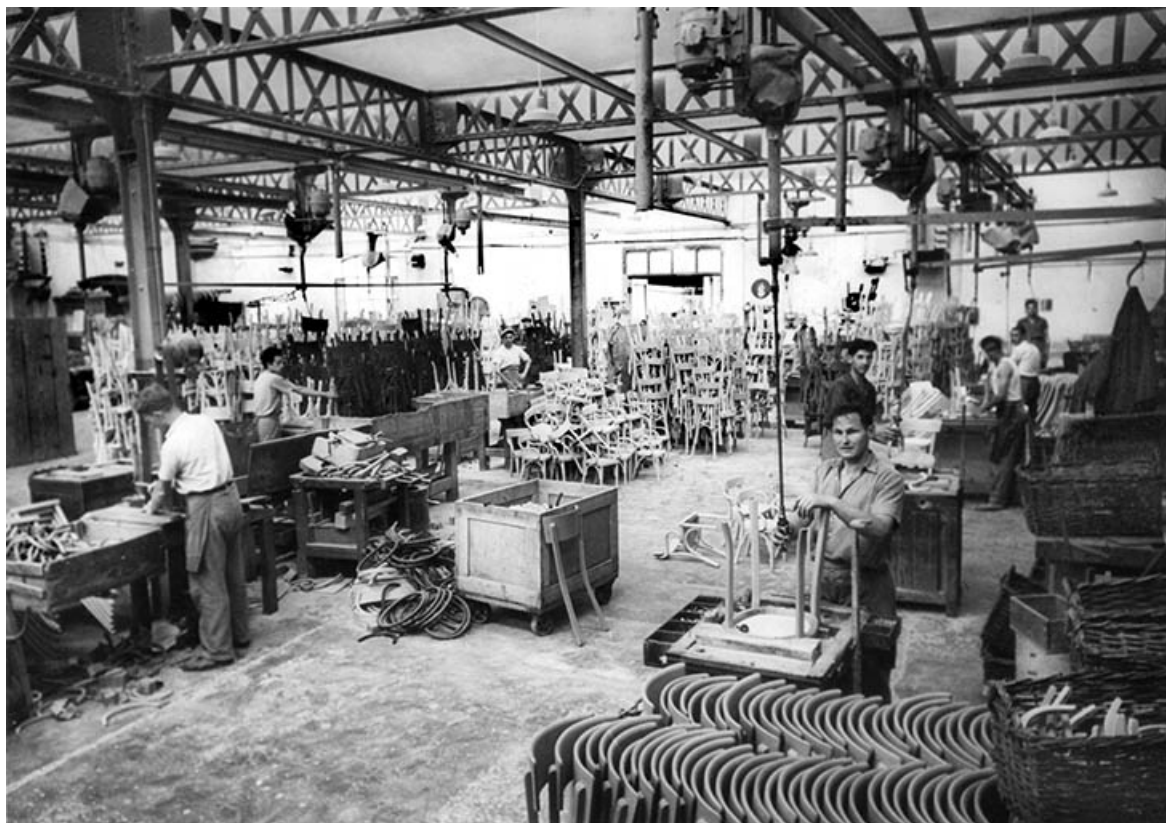
Atelier de montage des chaises en bois courbé. 25, Colombier-Fontaine rue de la Chaiserie
