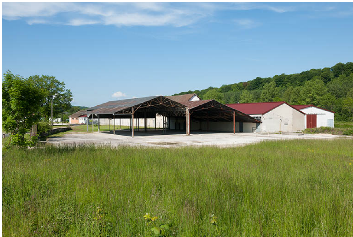
Entrepôt industriel et ateliers depuis l'est. 25, Colombier-Fontaine rue de la Chaiserie
