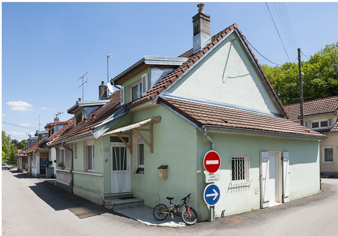
Vue d'ensemble de maisons jumelées au nord de la cité.
