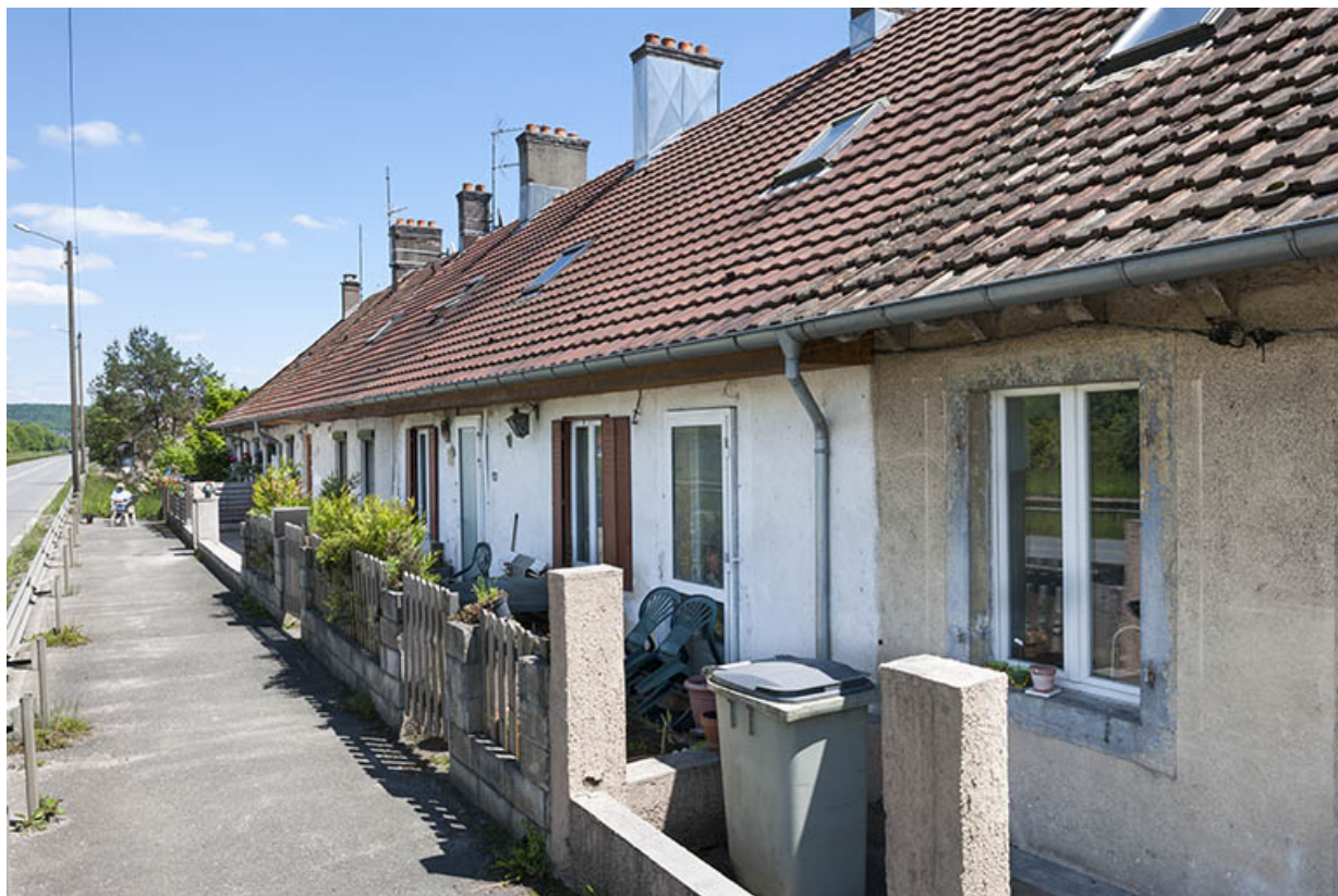
Façade nord d'une habitation de type caserne. 25, Étouvans, lieudit : la Raydans
