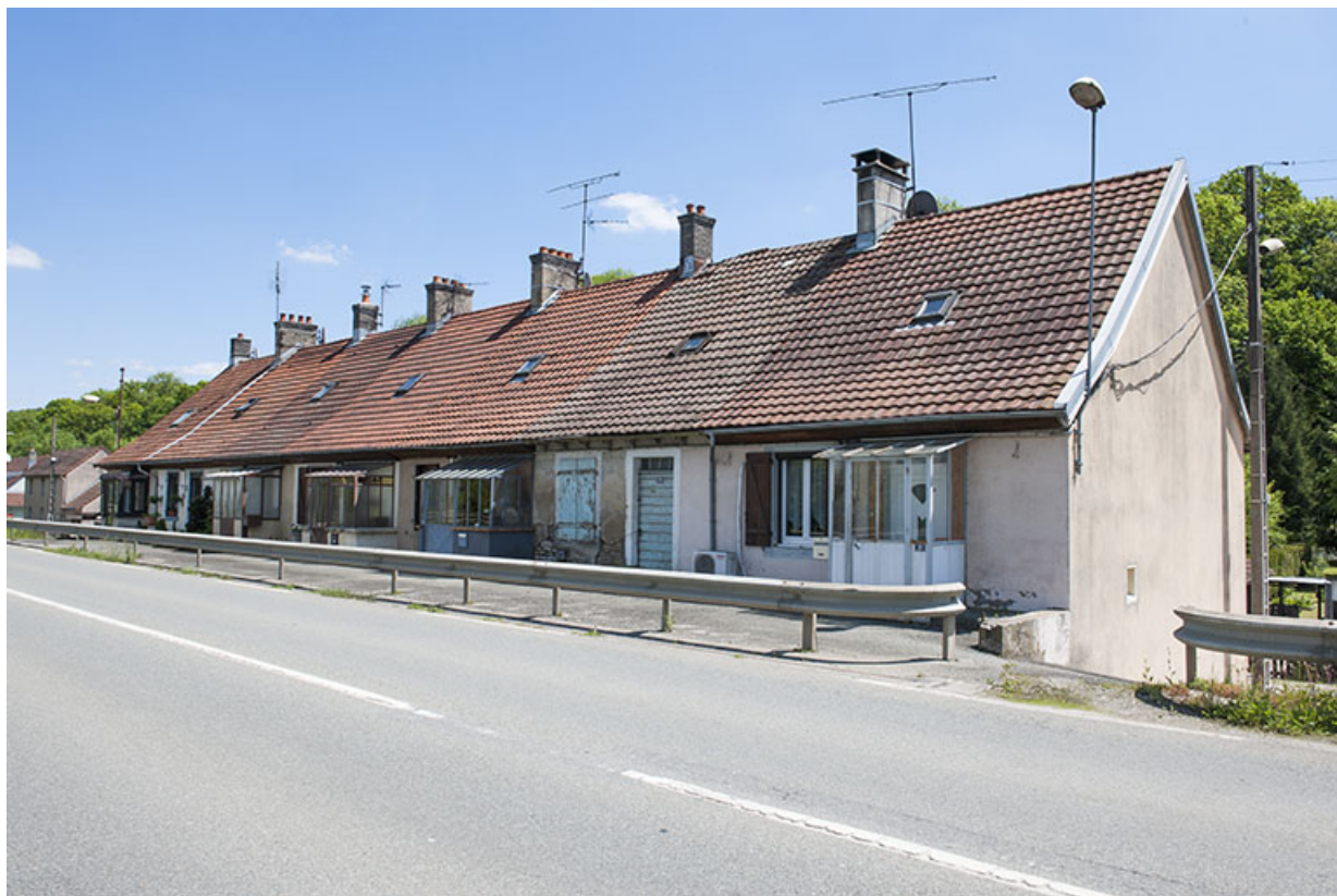
Habitation de type caserne. Vue depuis l'ouest.
