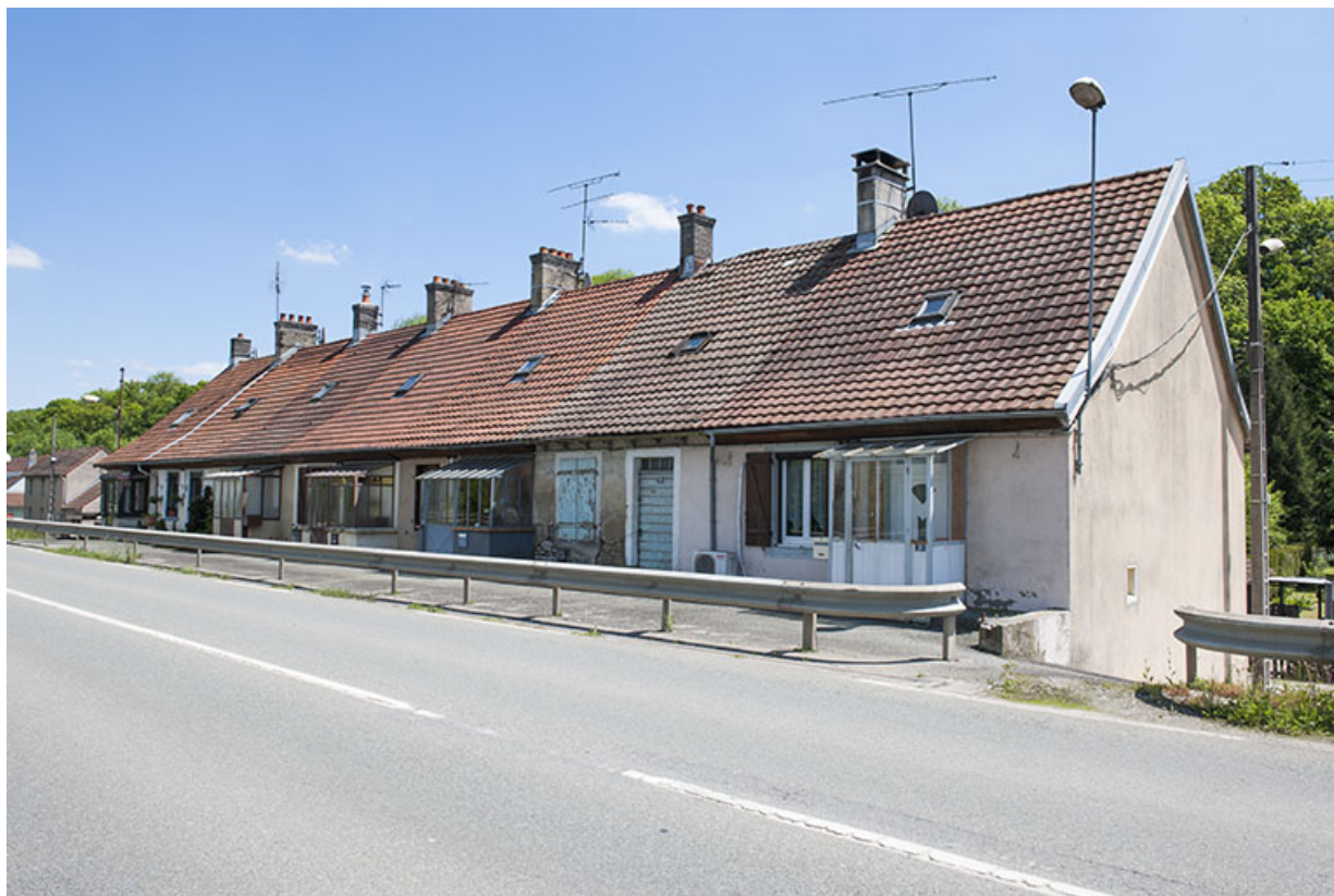
Habitation de type caserne. Vue depuis l'ouest.
