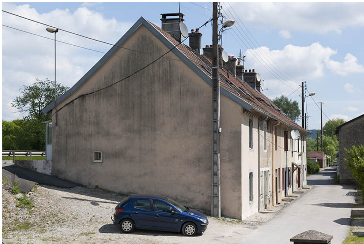
Habitation de type caserne. Vue depuis le sud.
