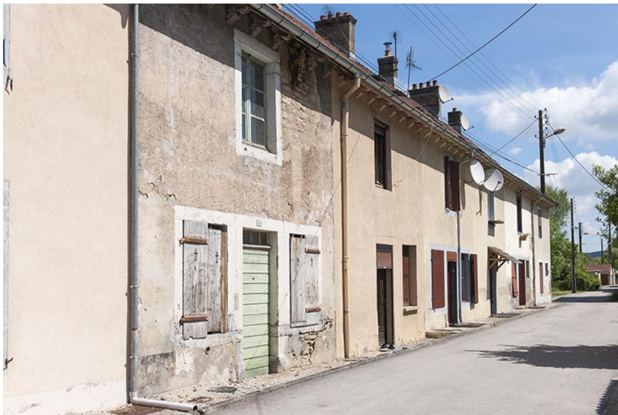
Façade sud d'un logement de type caserne. 25, Étouvans, lieudit : la Raydans
